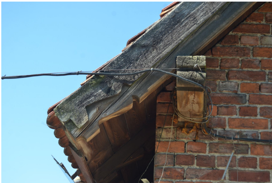
II. 5 Grążawy, Budynek mieszkalny nr 14 - widok na zakończenie snycerskie krokwi oraz wiatrownicy szczytowej
