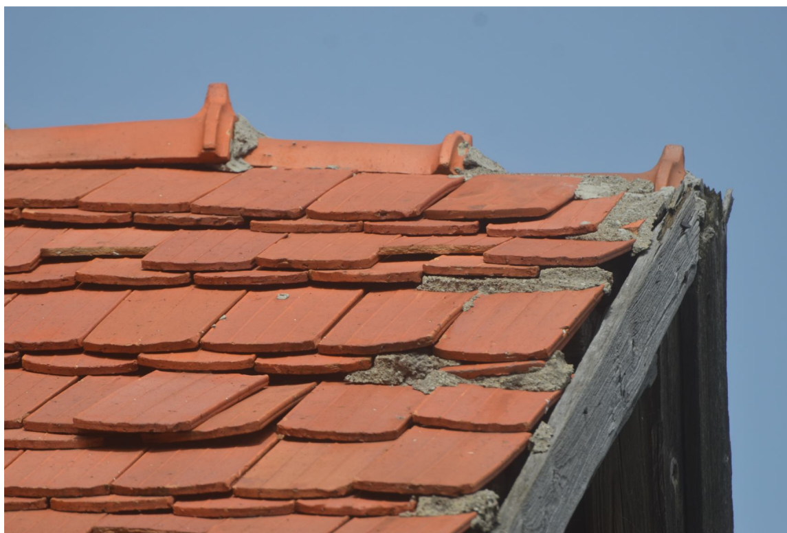
II. 10 Grażawy, Budynek mieszkalny nr 14 - widok na fragment pokrycia dachowego z dachówki karpiówki oraz ceramiczne gąsiory
