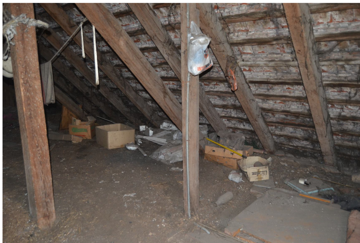
II. 18 Grążawy, Budynek mieszkalny nr 14 - widok na fragment konstrukcji, w tym ramy stolcowej
