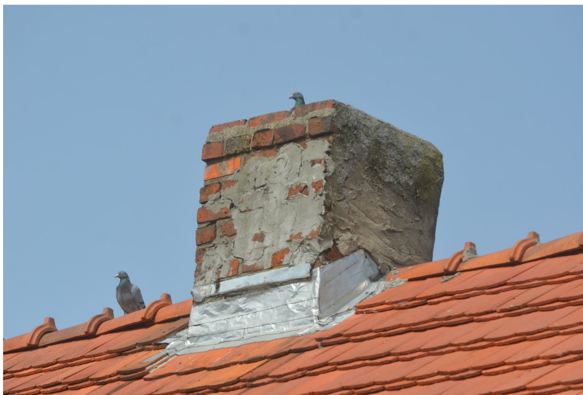
II. 8 Grążawy, Budynek mieszkalny nr 14 - widok na jeden z kominów, jego stan zachowania oraz opierzeń blaszanych
