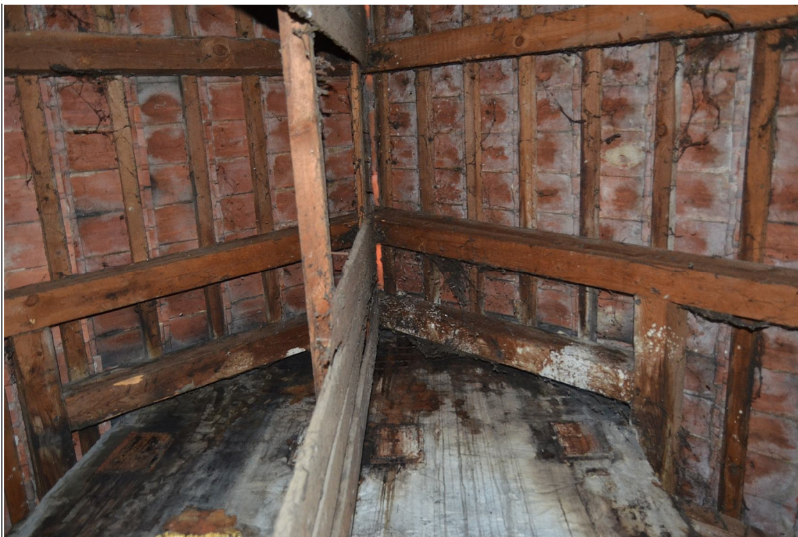
II. 13 Grążawy, Budynek mieszkalny nr 14 - widok na jeden z kominów i zawilgocenia elementów drewnianych konstrukcji
