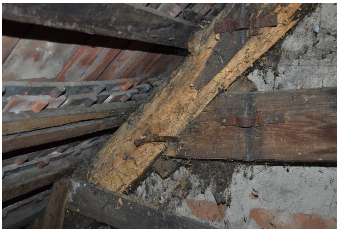
II. 14 Grążawy, Budynek mieszkalny nr 14 - widok na fragment zdegradowanej krokwi – wiąz 28
