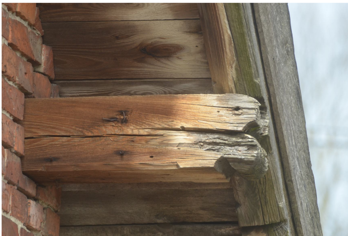
II. 6 Grążawy, Budynek mieszkalny nr 14 - widok na zakończenie snycerskie płatwi stopowej
