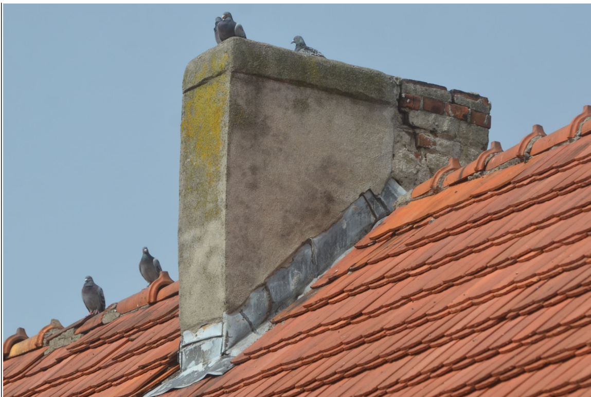
II. 7 Grążawy, Budynek mieszkalny nr 14 - widok na jeden z kominów, jego stan zachowania oraz opierzeń blaszanych
