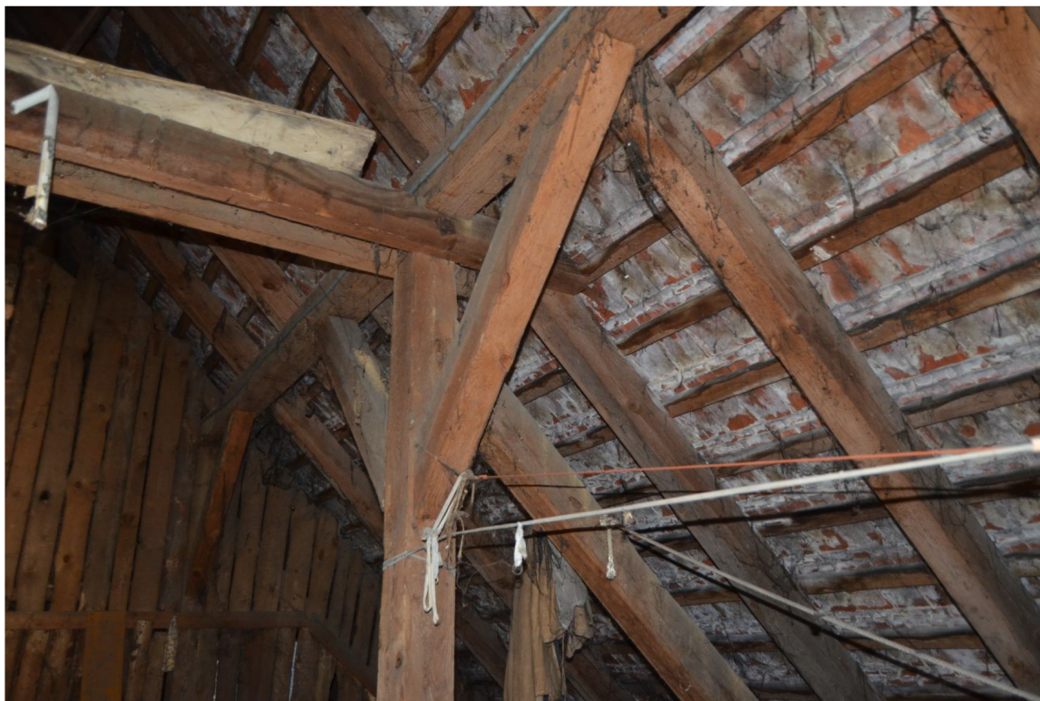
II. 17 Grążawy, Budynek mieszkalny nr 14 - widok na fragment konstrukcji, w tym ramy stolcowej
