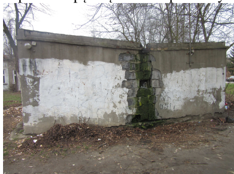
Foto nr 21 i 22. Stan techniczny ścian szczytowych. Widoczna erozja muru i silne porażenie glonami.
