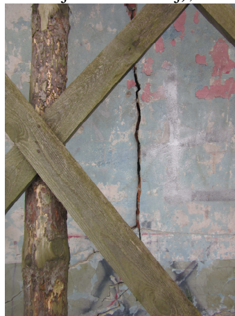
Foto nr 24. Pęknięcie ściany północnej.
