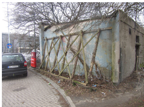
Foto nr 23. Elewacja północna budynku, zabezpieczona stemplowaniem.
