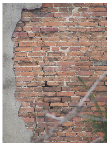
Foto nr 10 i 11. Ubytki tynku i zarysowania na powierzchni trzonów kominowych ścian szczytowych.
