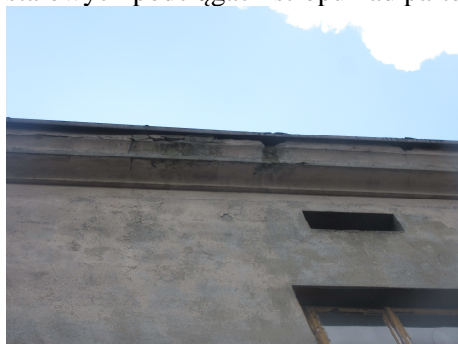
Foto nr 12. Odspojone i zagrożone odpadnięciem tynki gzymsu.
