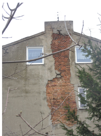
Foto nr 10 i 11. Ubytki tynku i zarysowania na powierzchni trzonów kominowych ścian szczytowych.
