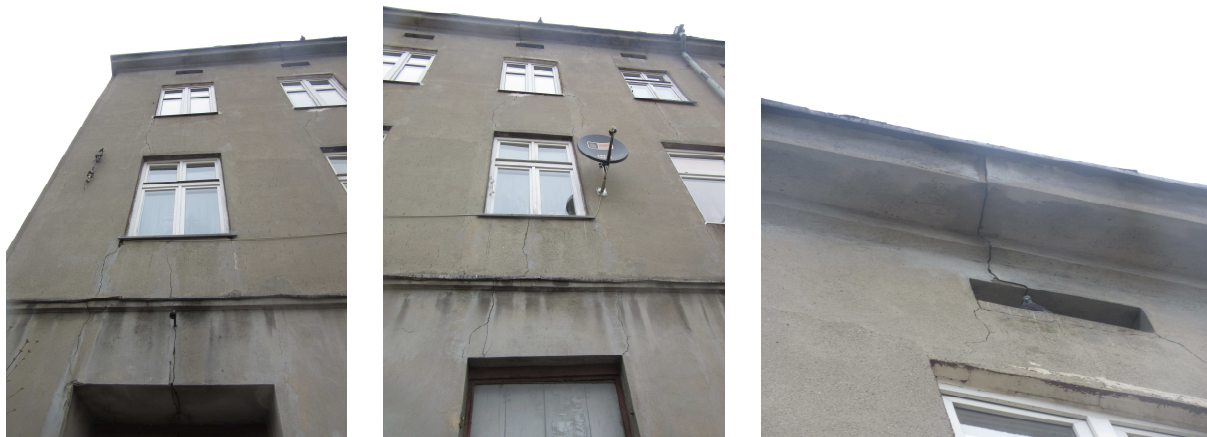
Foto nr 6, 7 i 8. Pęknięcia i zarysowania elewacji południowej w strefach nadprożowo-podokiennych.
