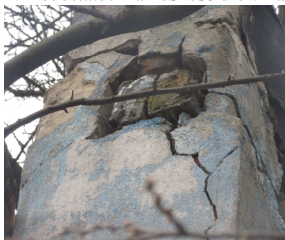
Foto nr 25, 26 i 27. Uszkodzenia muru pod dachem.
