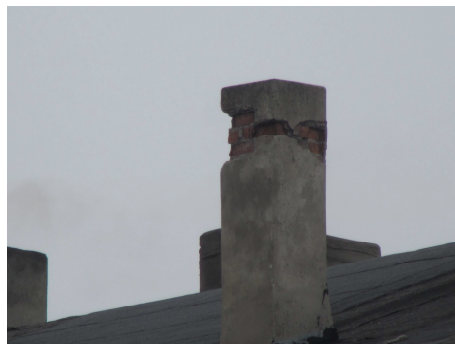
Foto nr 13. Komin północnej połaci dachu – do przemurowania.
