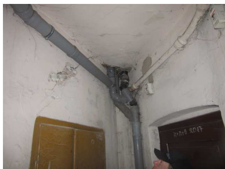
Foto nr 9. Ukośne zarysowanie ściany wewnętrznej podłużnej.
