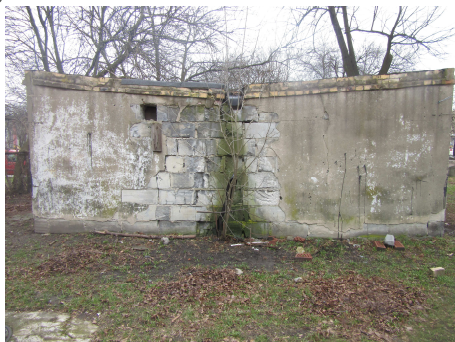
Foto nr 21 i 22. Stan techniczny ścian szczytowych. Widoczna erozja muru i silne porażenie glonami.
