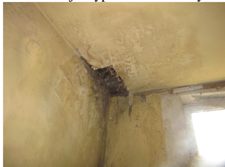
Foto nr 18. Zarwanie fragmentu drewnianego stropodachu w części południowo-wschodniej.
