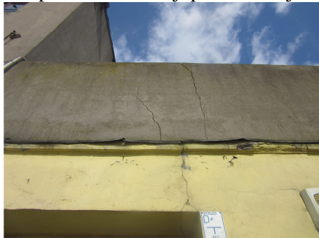
Foto nr 17. Pęknięcia ściany attykowej.
