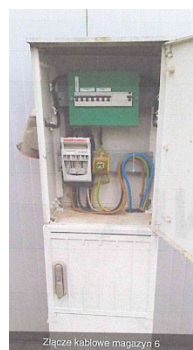
l) Budynek nr 6 – złącze kablowe, rozdzielnia główna
