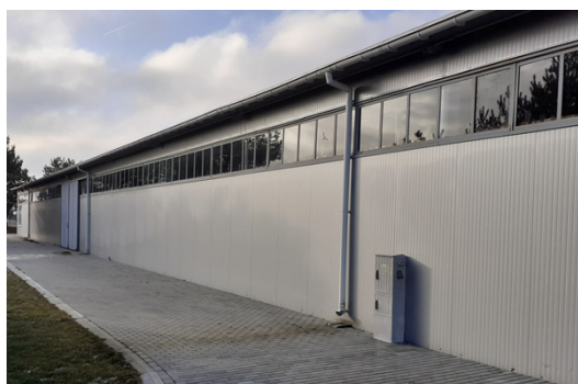
k) Budynek nr 6
