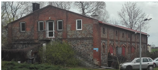
a) Budynek nr 3
