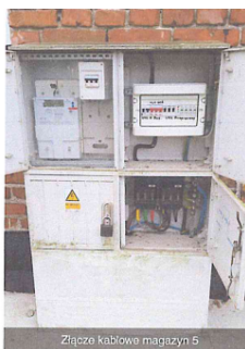
j) Budynek nr 5 – złącze kablowe, rozdzielnia główna
