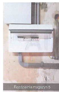
j) Budynek nr 5 – złącze kablowe, rozdzielnia główna
