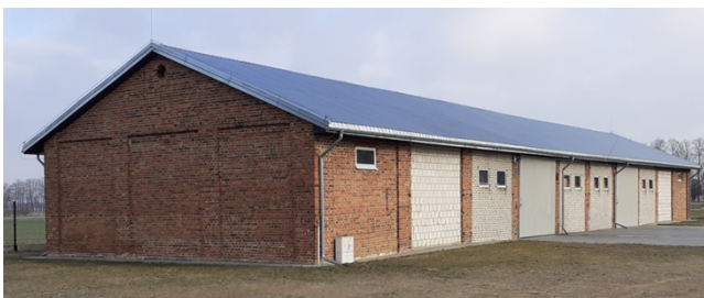
a) Budynek nr 1
