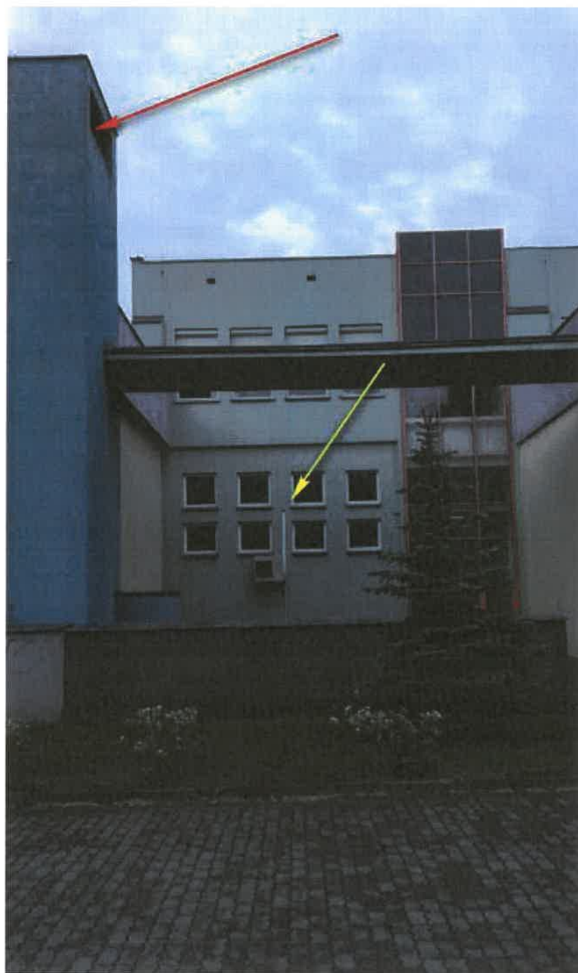
Zdjęcie 8 Stwierdzone miejsca gniazdowania szpaka i wróbla domowego (czerwona strzałka) oraz wróbla domowego (żółta strzałka). Wróbel oznaczony żółtą strzałką gnieździ się w pęknięciu osłony przewodów od klimatyzatora. Szczegółowa lokalizacja na zdjęciu poniżej. Budynek Wydziału Humanistycznego.
