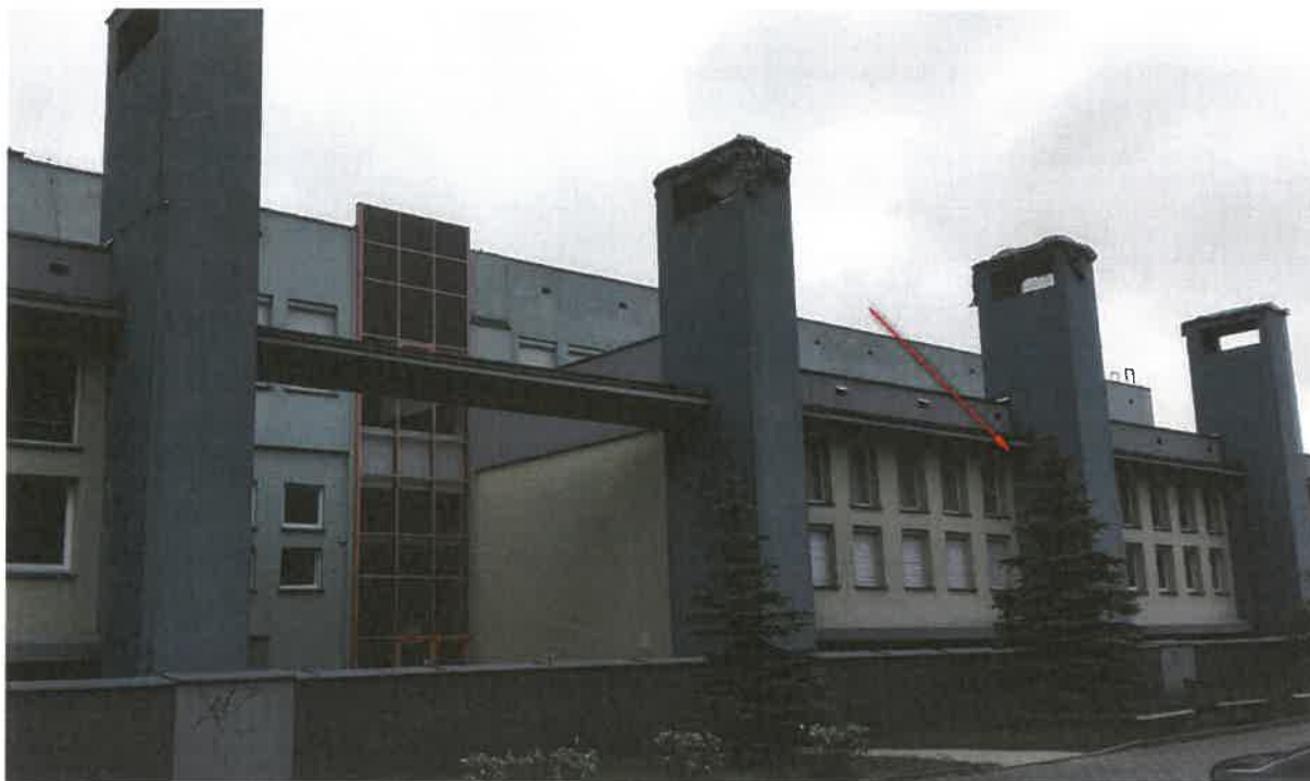
Zdjęcie 10 Miejsce gniazdowania wróbla domowego. Budynek Wydziału Humanistycznego.
