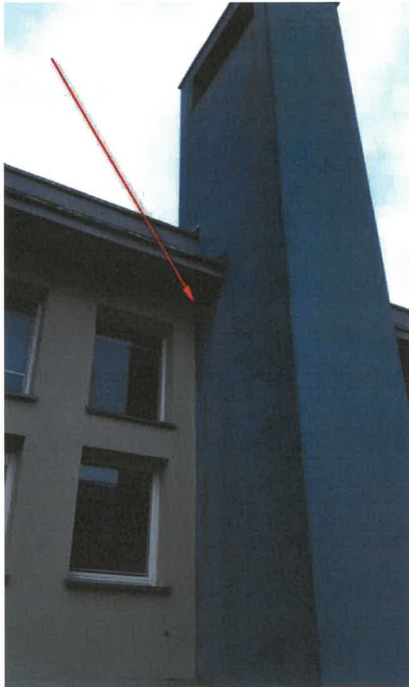
Zdjęcie 7 Widok na miejsce gniazdowania wróbla domowego. Również w tym miejscu zaobserwowano wlatującego i siedzącego jerzyka. Budynek Wydziału Humanistycznego
