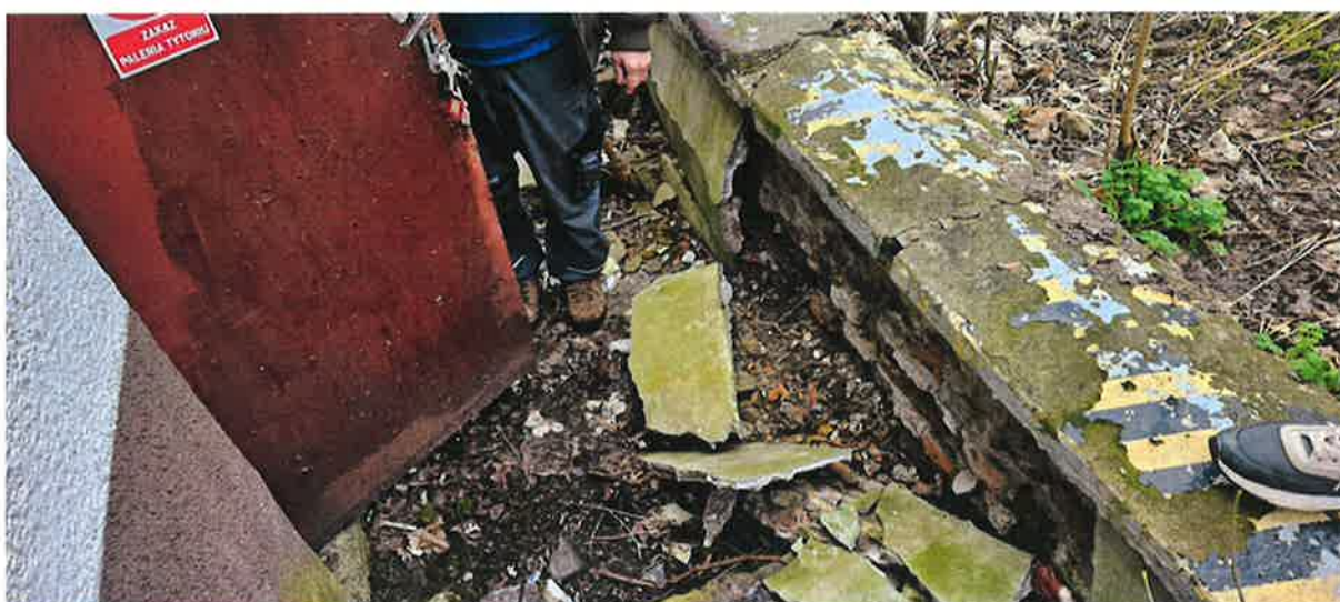
Fot. nr 11 – Wejście do kotłowni
