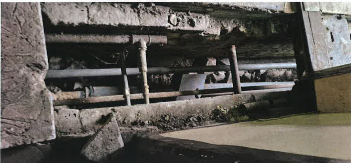
Fot. nr 26 – Kanał techniczny w posadzce
