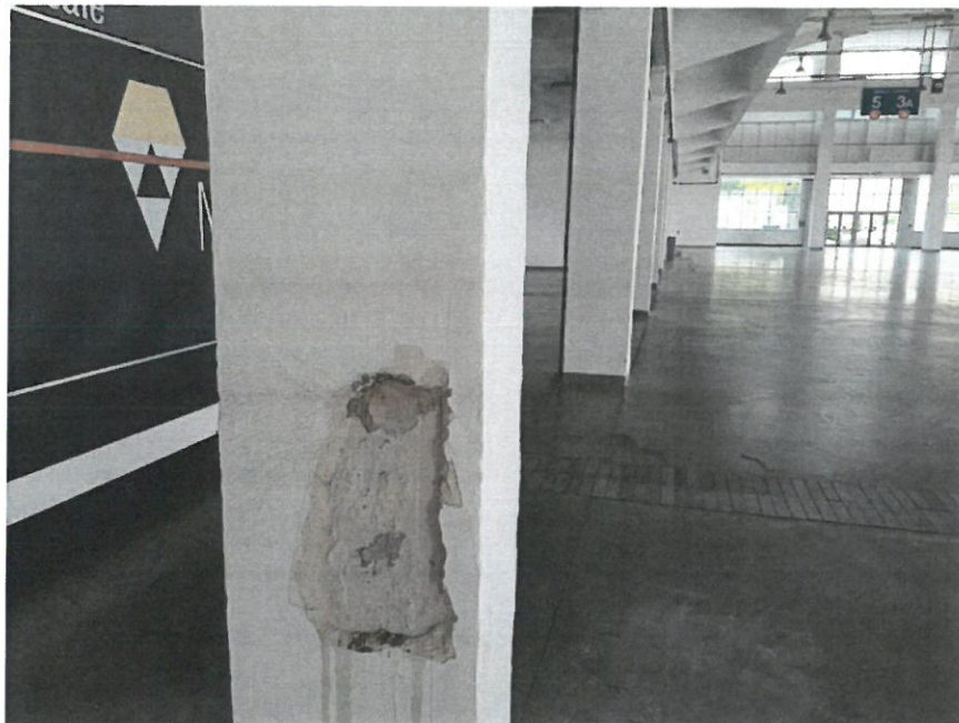
Fot. 8.20 Lokalizacja odwiertu rdzeniowego – słup nr 2
