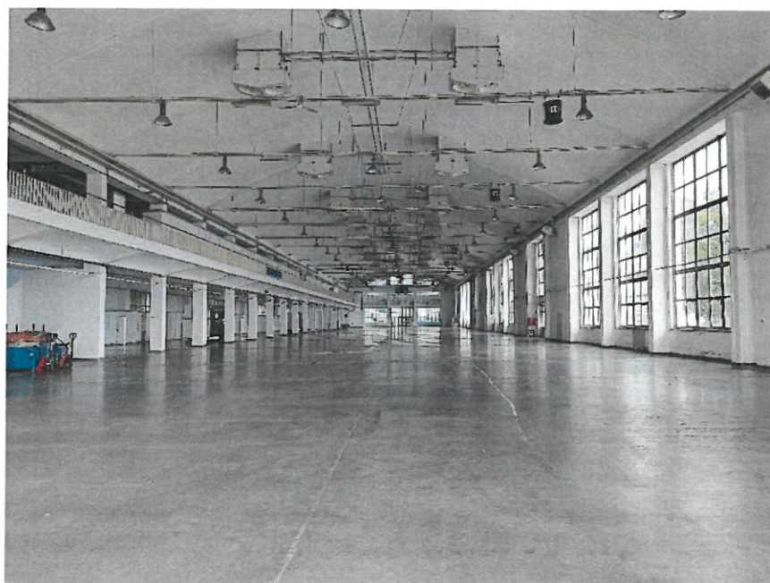
Fot. 5.3 Widok ogólny wnętrza pawilonu
