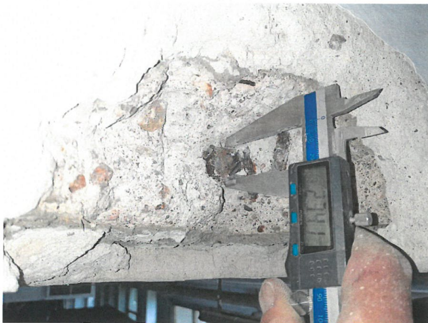
Fot. 8.13 Odkrywka zbrojenia – strop płaski – podciąg poprzeczny - pręt 24 mm
