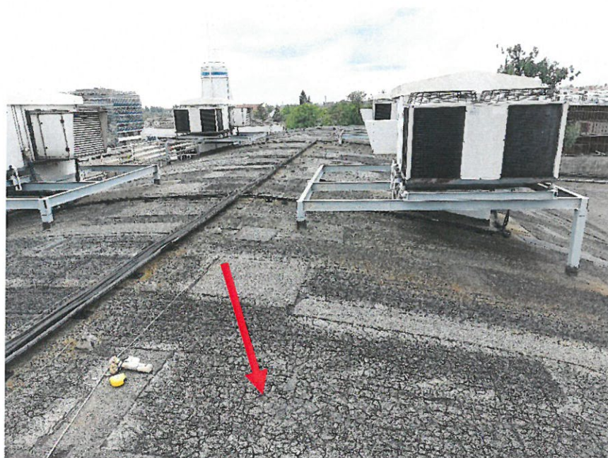
Fot. 8.7 Lokalizacja odwiertu nr 4 – dach łukowy
