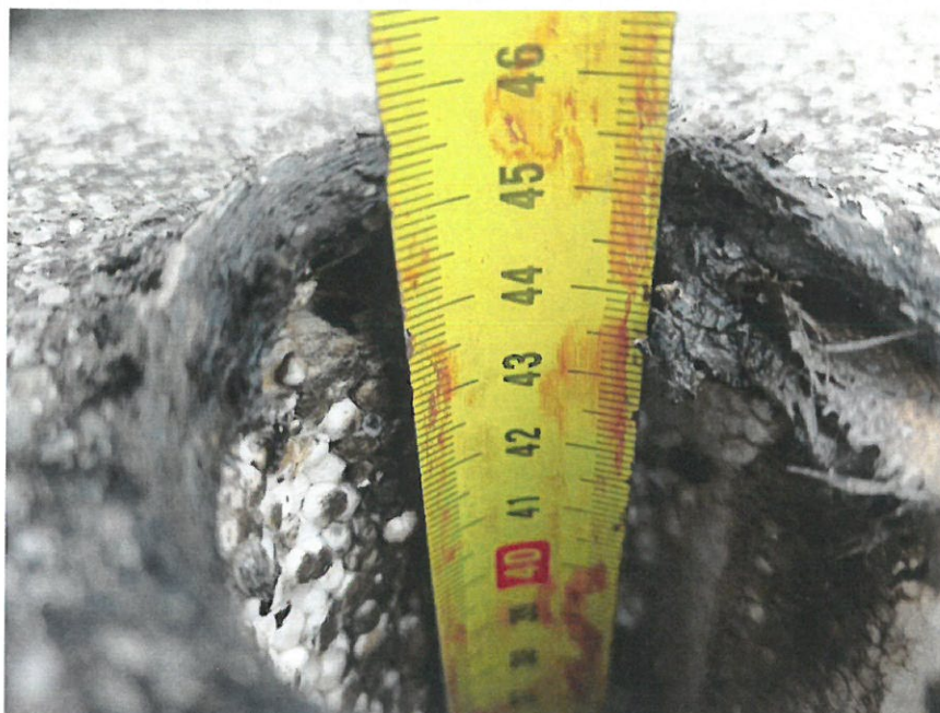
Fot. 8.6 Pomiar grubości warstw w miejscu odwiertu – odwiert rdzeniowy nr 3
