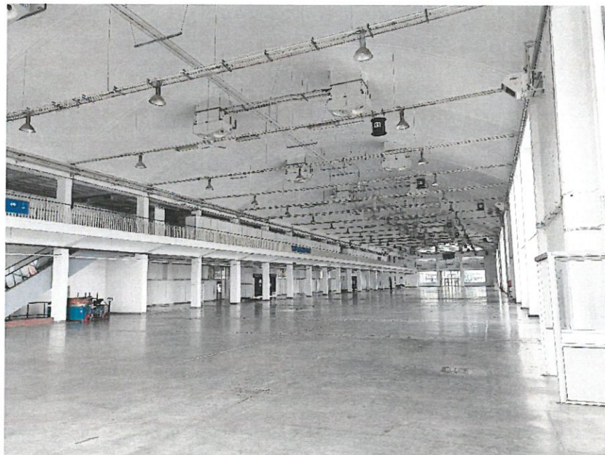
Fot. 7.27 Stan wnętrza hali – widok ogólny
