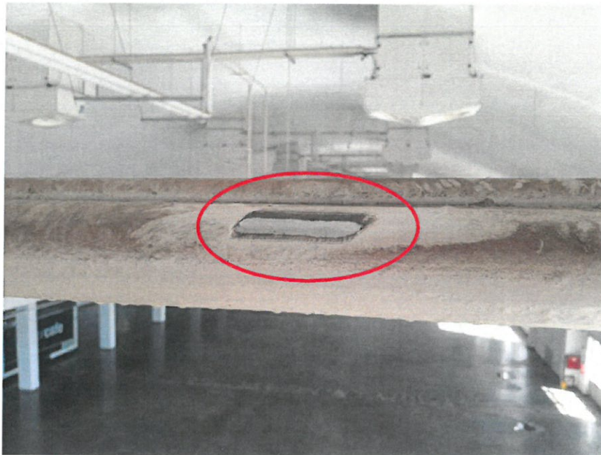
Fot. 8.16 Lokalizacja badania twardości stali metodą Leeb'a – ściąg nr 4
