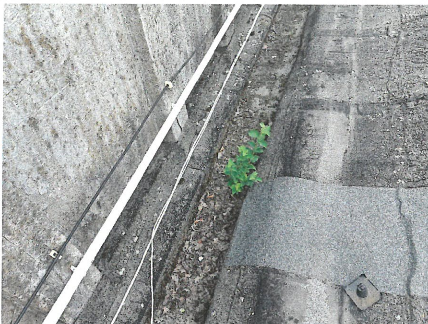
Fot. 7.18 Wegetacja roślinności na dachu budynku
