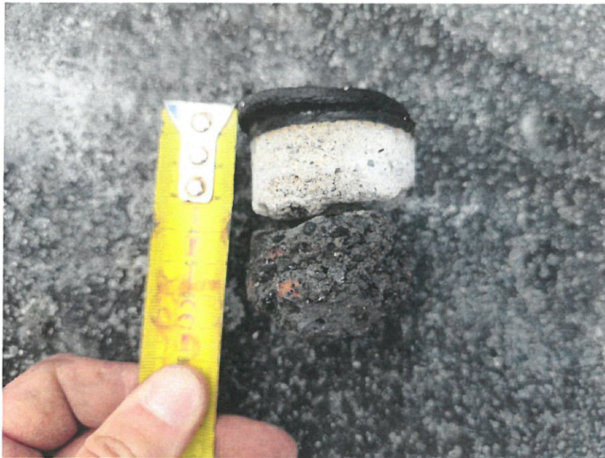
Fot. 8.2 Grubości górnych warstw (do pustki powietrznej) – próbka nr 1
