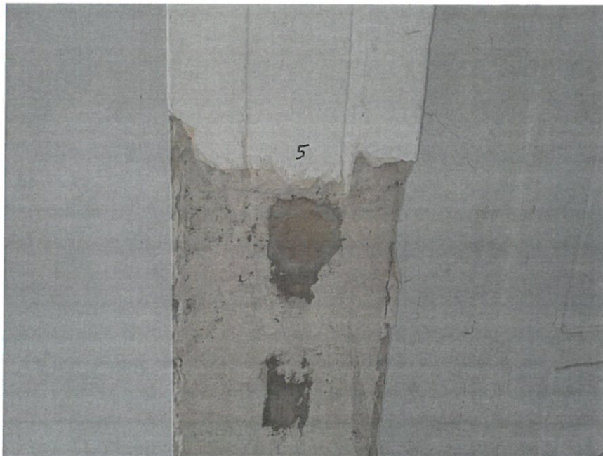
Fot. 8.23 Lokalizacja odwiertu rdzeniowego – słup nr 5
