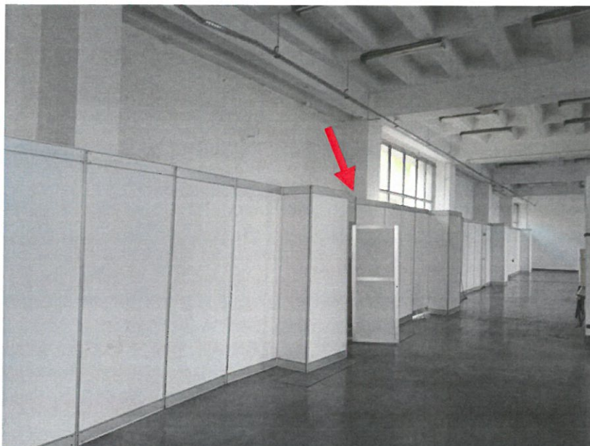
Fot. 8.21 Lokalizacja odwiertu rdzeniowego – słup nr 3
