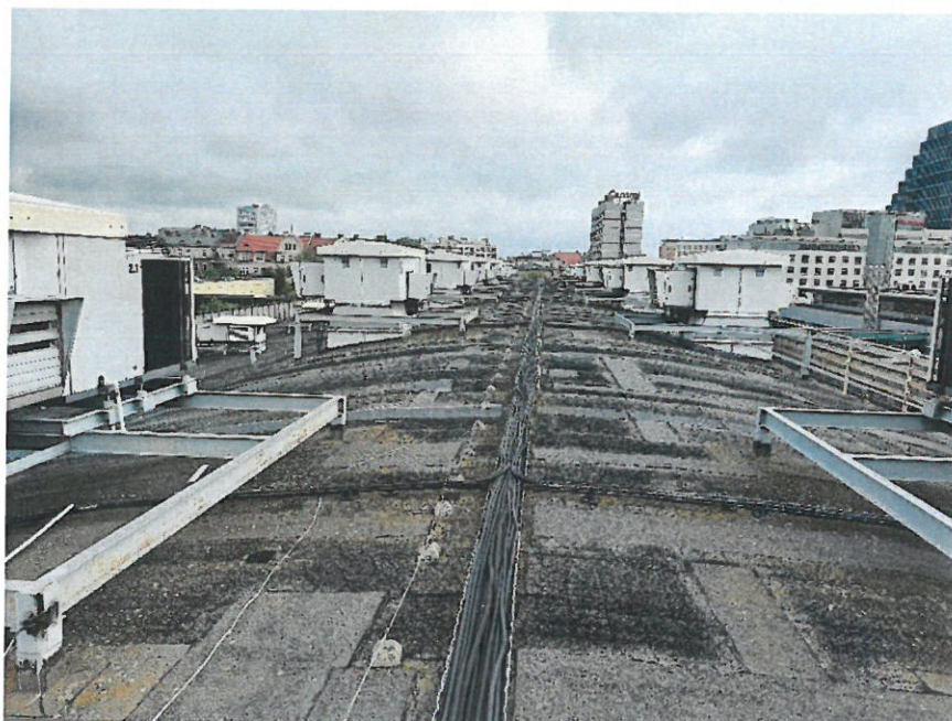
Fot. 7.8 Widok ogólny stanu pokrycia dachowego – sklepienie łukowe
