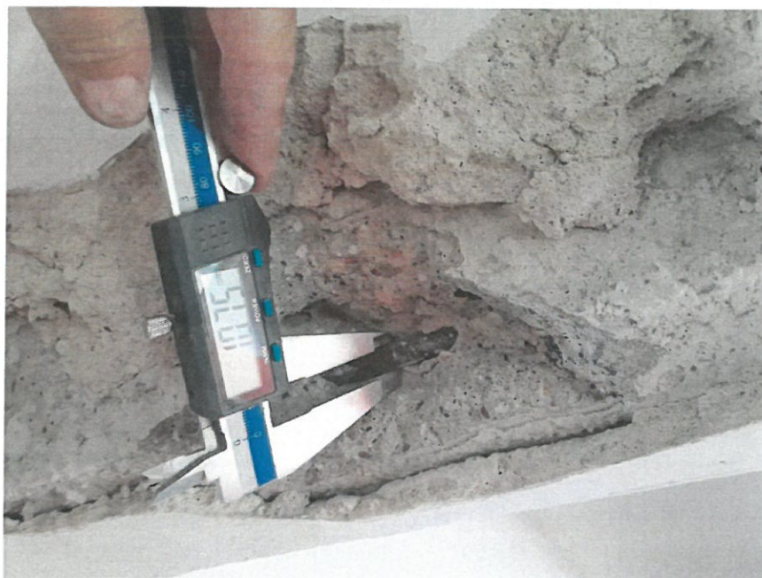
Fot. 8.10 Odkrywka zbrojenia – strop płaski – żebro pkt 2 – pręt \varnothing 10\text{mm}
