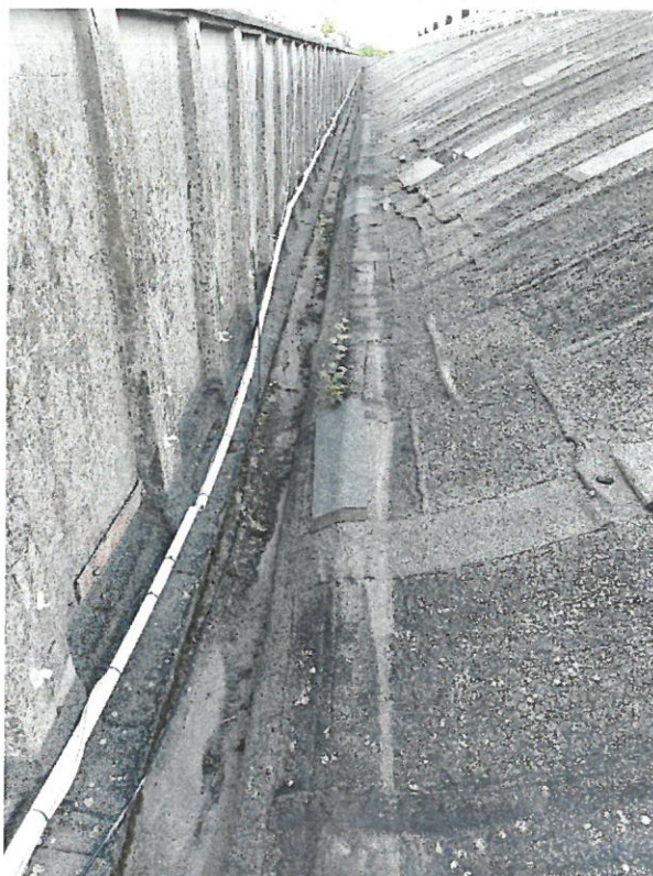
Fot. 7.20 Stan ściany attykowej – widok ogólny
