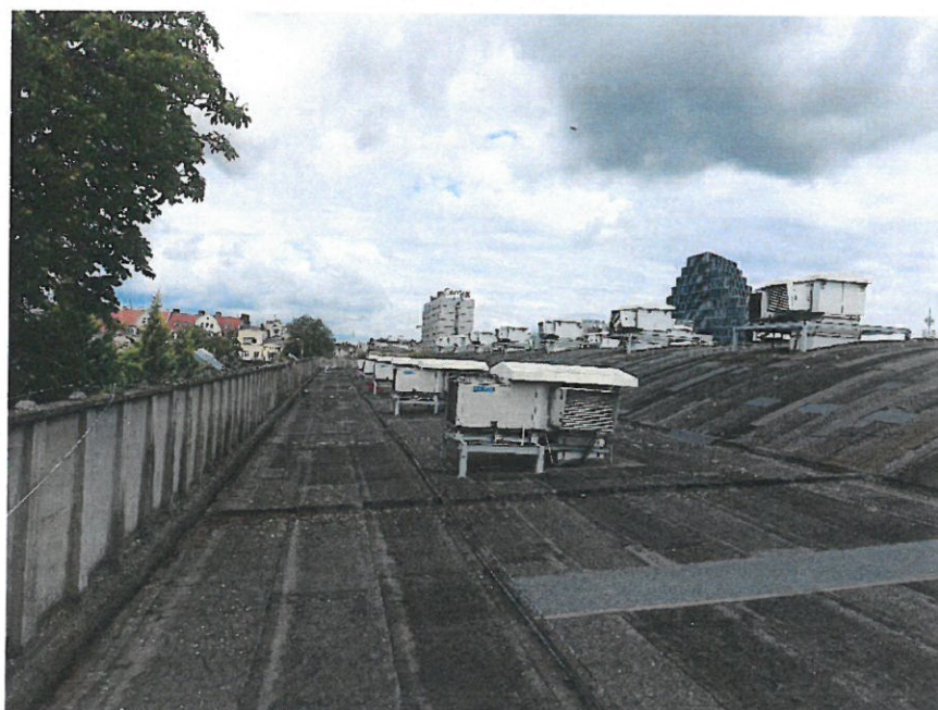
Fot. 7.9 Widok ogólny stanu pokrycia dachowego – dach płaski
