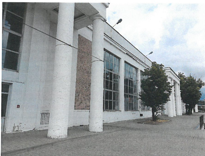
Fot. 7.1 Widok ogólny stanu elewacji zewnętrznej
