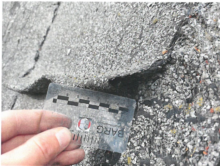
Fot. 7.15 Ruchy reologiczne materiału pokrycia – wysokość powstałych zagięć
