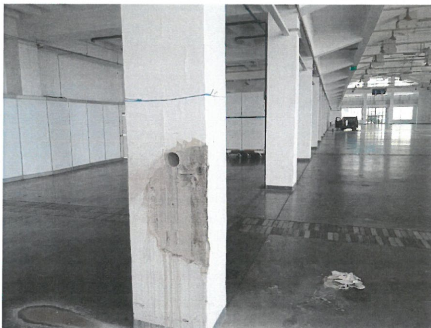
Fot. 8.19 Lokalizacja odwiertu rdzeniowego – słup nr 1
