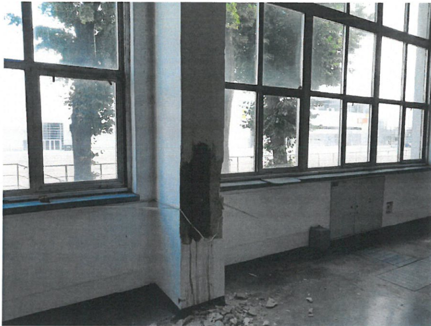
Fot. 8.22 Lokalizacja odwiertu rdzeniowego – słup nr 4
