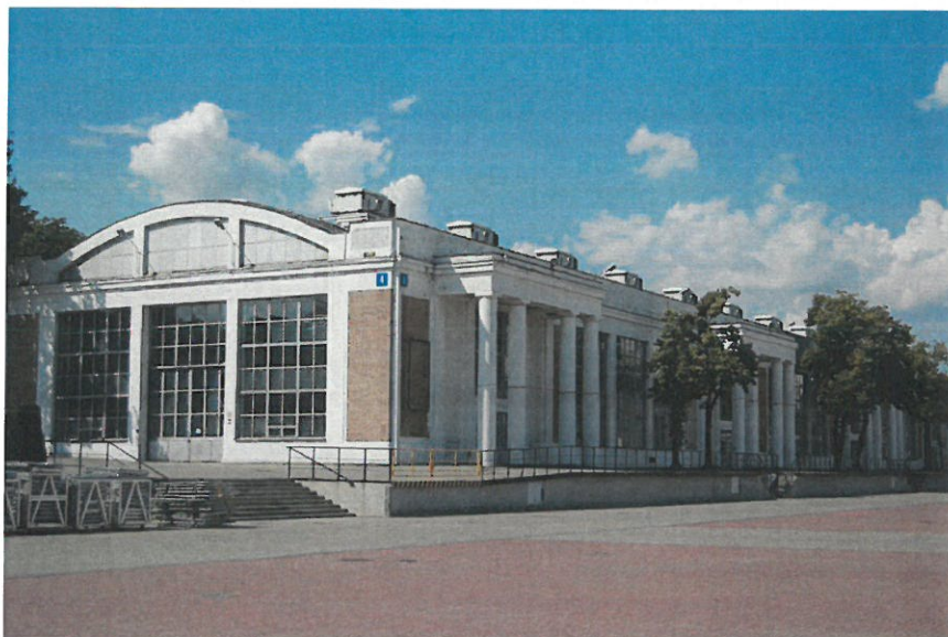
Fot. 5.2 Widok ogólny przedmiotowej hali
