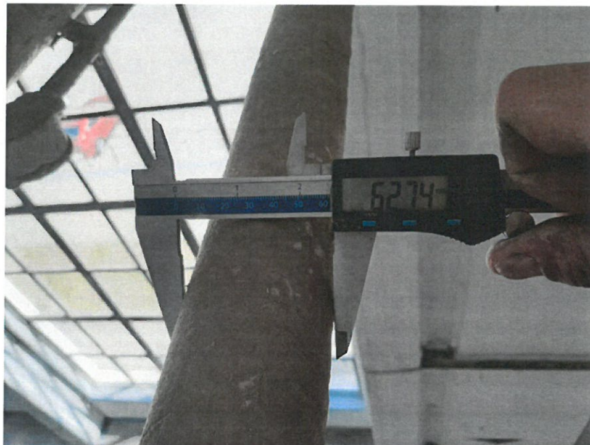
Fot. 8.17 Pomiar średnicy – ściąg nr 6 w kierunku południowym
