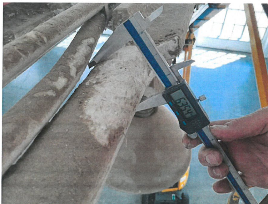
Fot. 8.15 Pomiar średnicy – ściąg nr 4 w kierunku północnym
