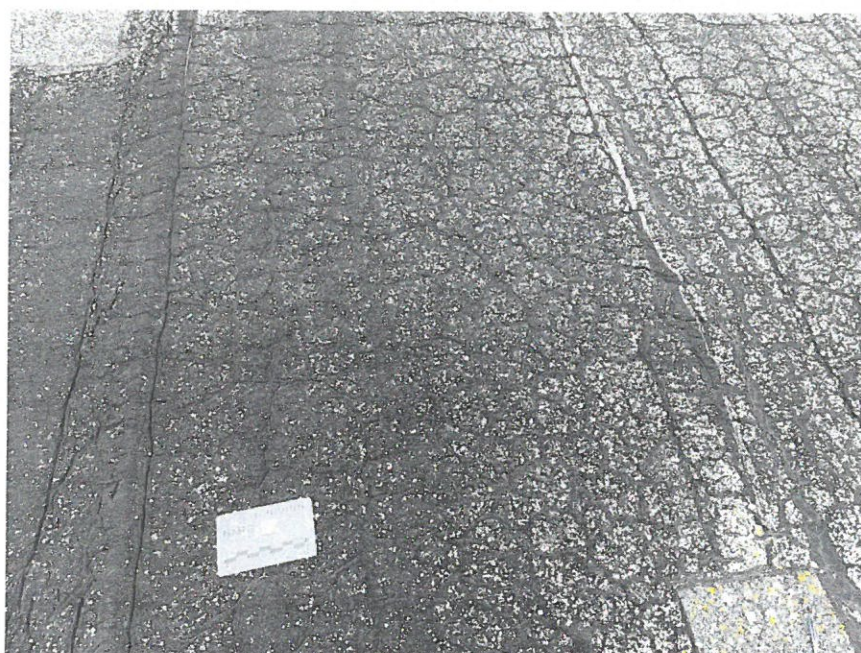
Fot. 7.13 Spękanie papy w wyniku starzenia się materiału
