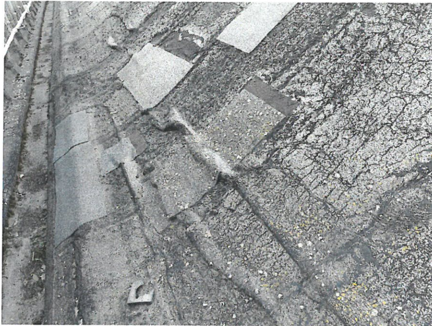
Fot. 7.14 Ruchy reologiczne materiału pokrycia
