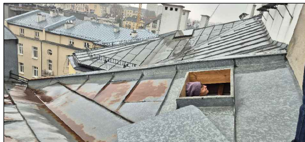
Wymienić istniejący wyłaz na dach na wyłaz o wymiarach 80x80 cm, EI 60.
