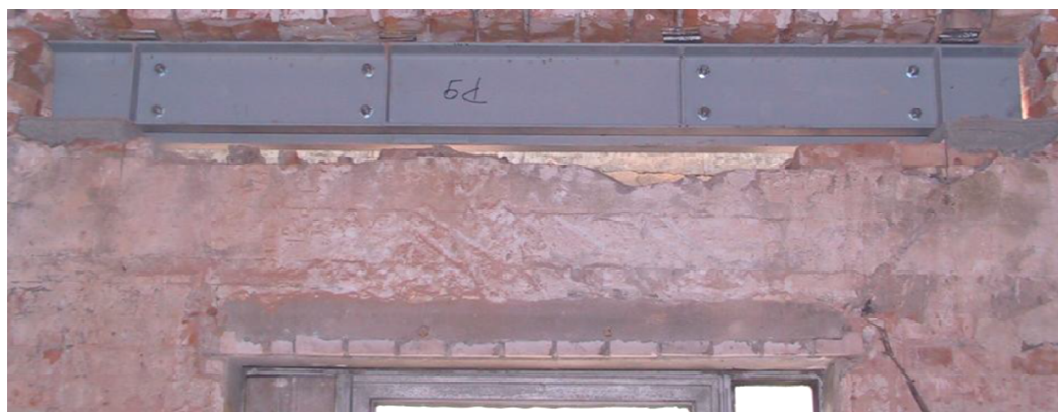
Fot. nr 1 Przykładowo wykonany podciąg stalowy
