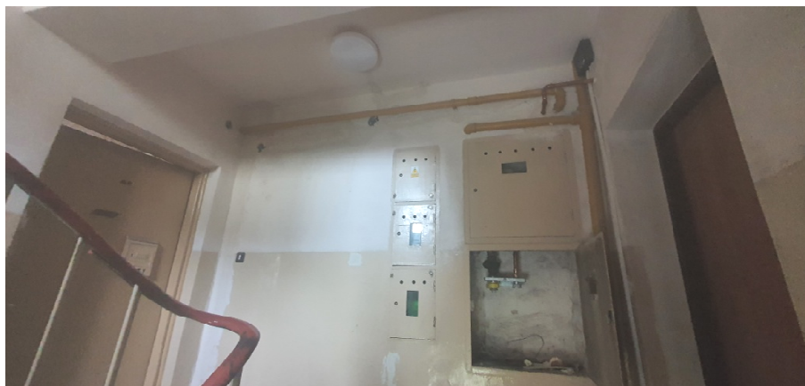
Fot. nr 1 Wejście do lokalu nr 1, wspólna klatka schodowa
