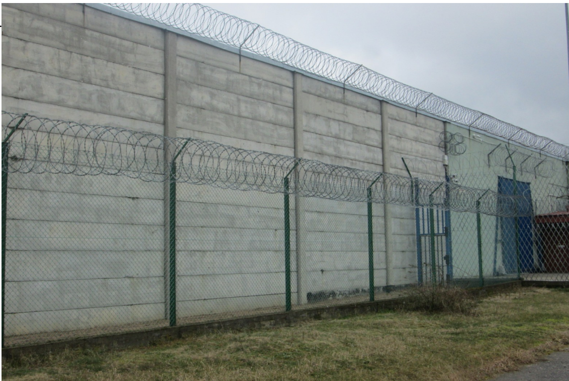
Istniejąca linia ogrodzenia wewnętrznego do przebudowy - strona wschodnia
