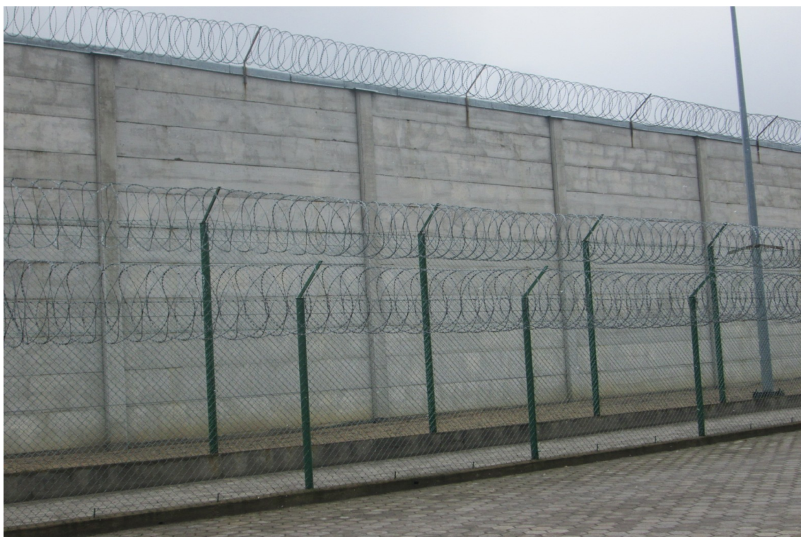
Istniejąca linia ogrodzenia wewnętrznego do przebudowy - strona południowa
