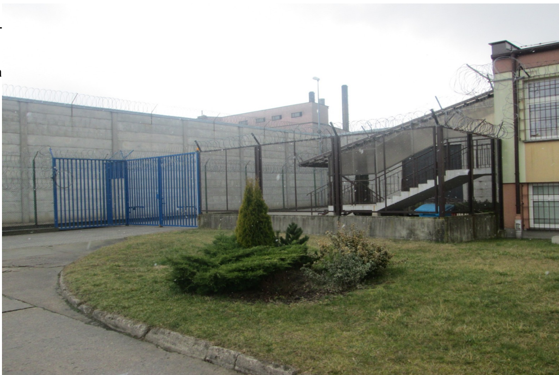
ogrodzeniu wewnętrznym do przebudowy (wydłużenie śluzy przy budynku nr 11)
