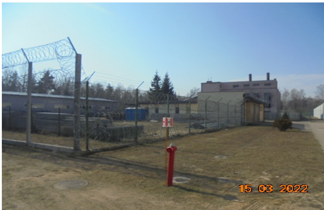
Fot. nr 3 - Istniejące ogrodzenie – strona południowa
