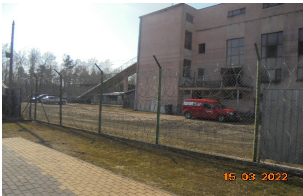
Fot. nr 4 - Istniejące ogrodzenie – strona zachodnia
