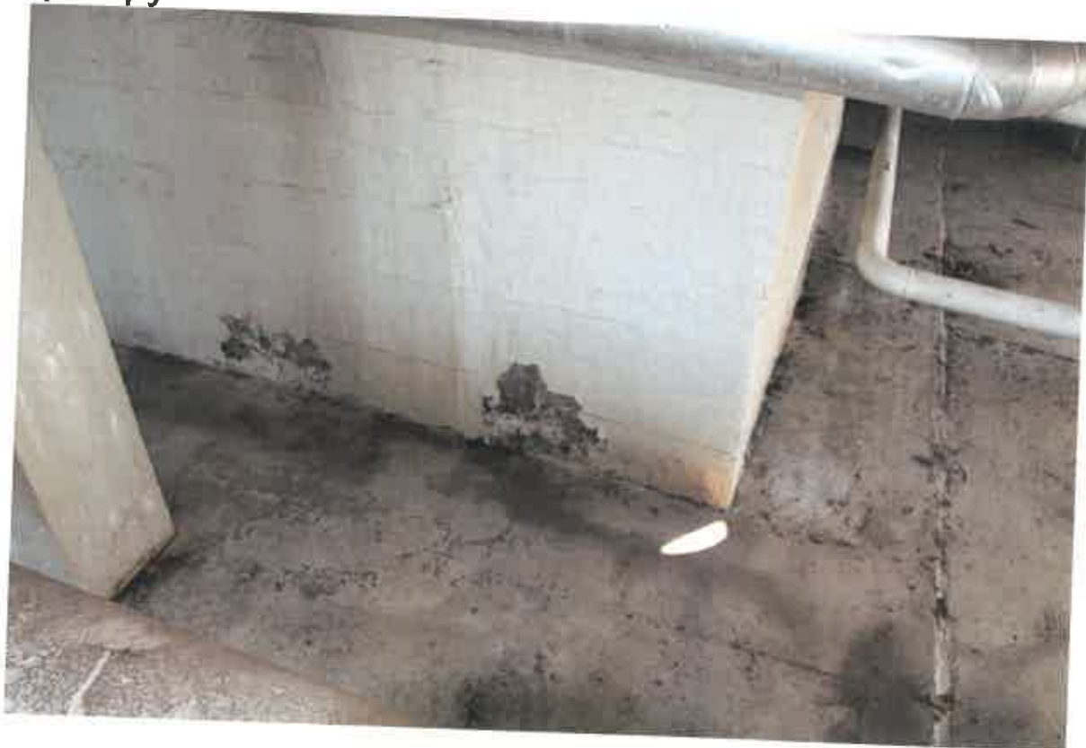
Widoczne zbrojenie stropu
