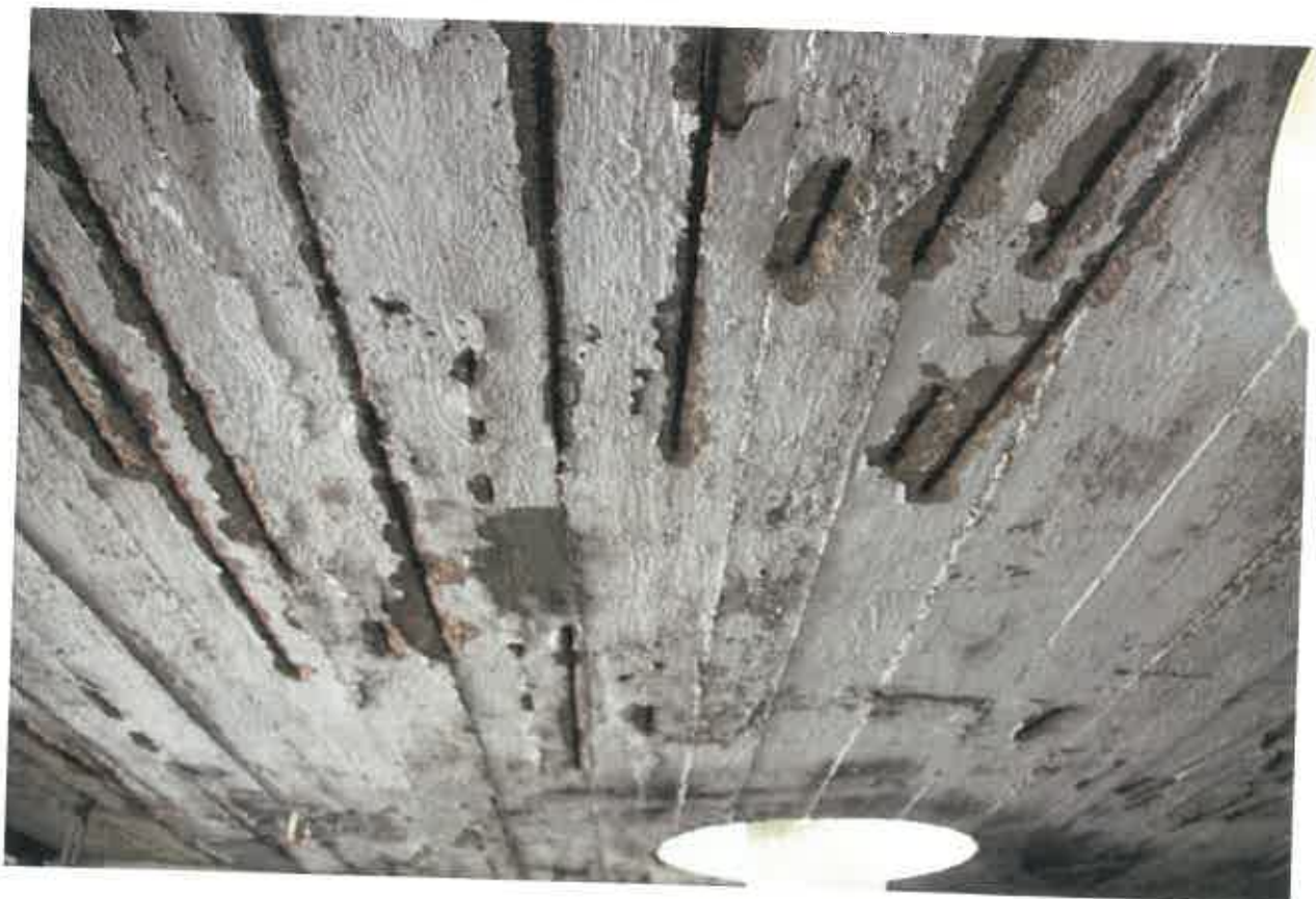
Widoczne zbrojenie płyty zaawansowana korozja betonu
