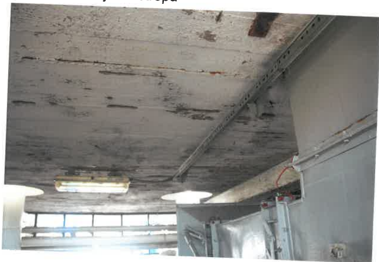
Widoczne zbrojenie stropu
