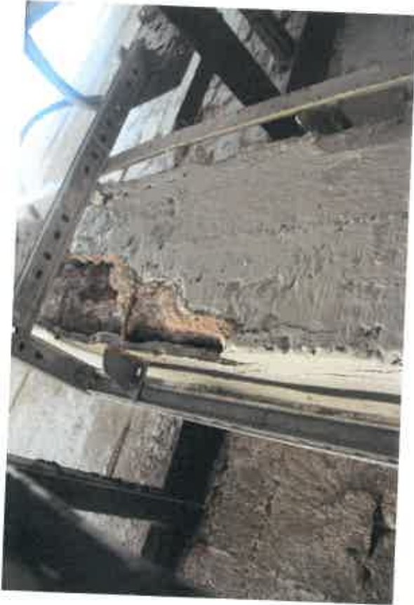
Widoczne pręty zbrojenia płyty
