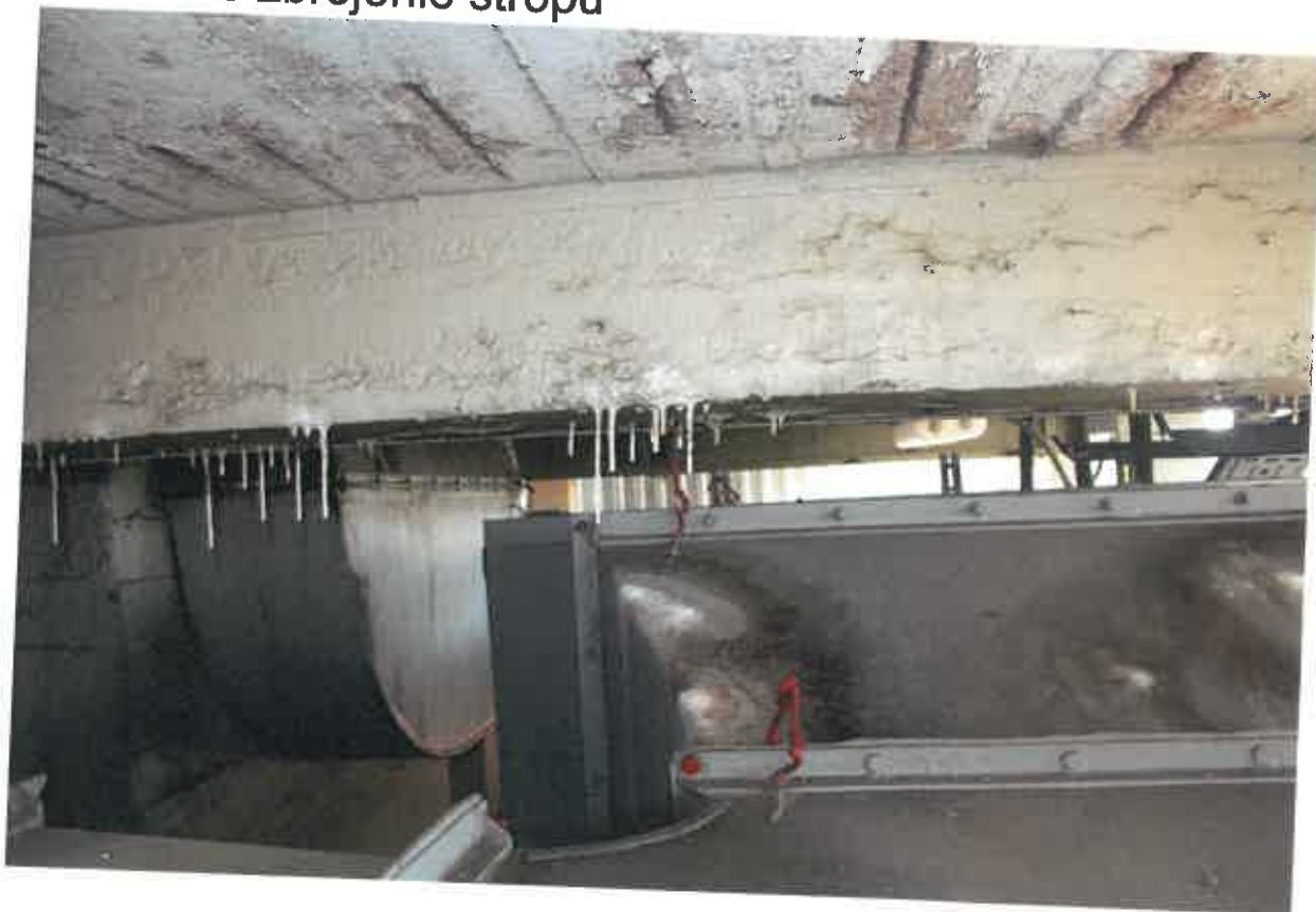
Widoczne zbrojenie stropu
