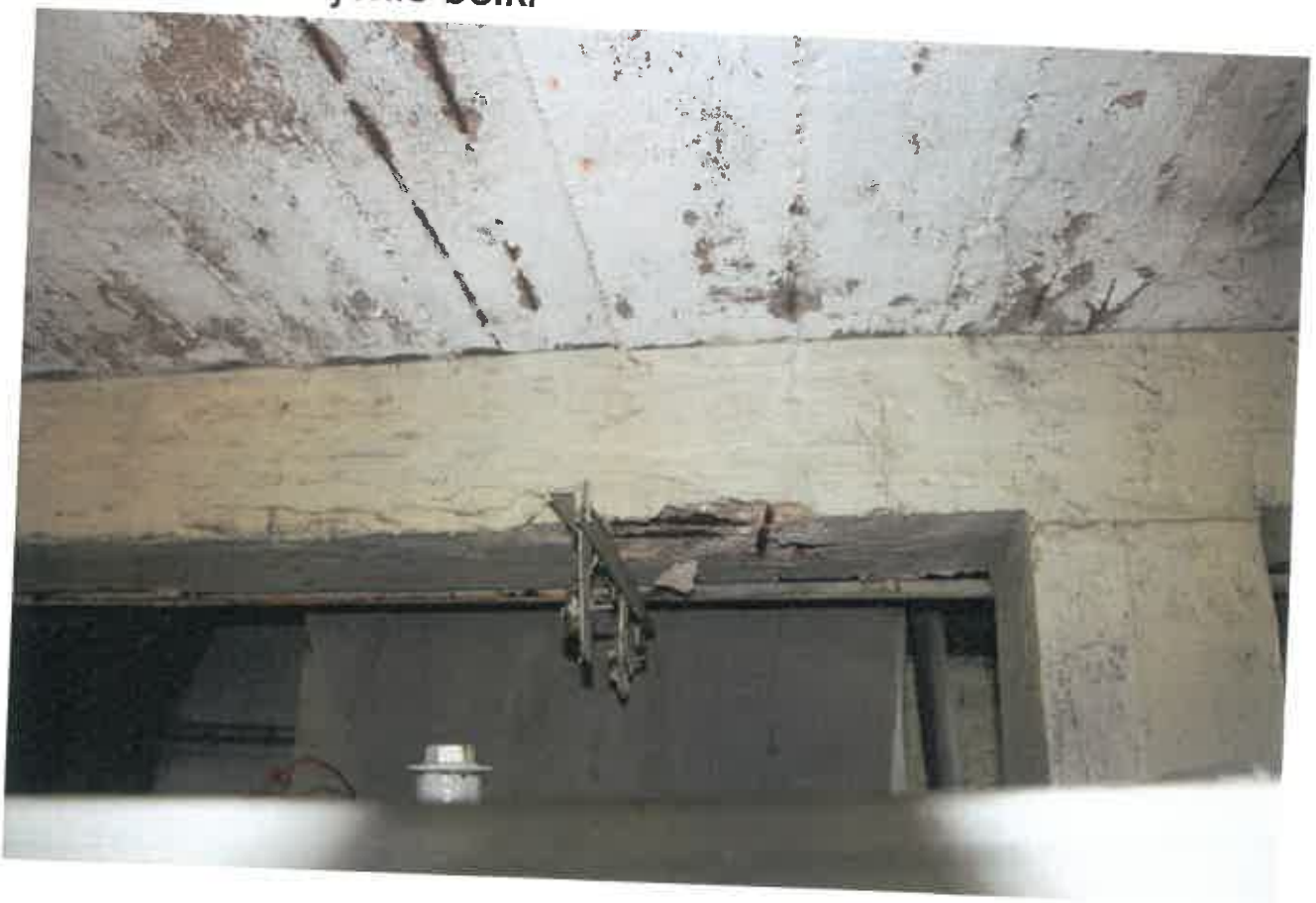
Widoczne zbrojenie belki
