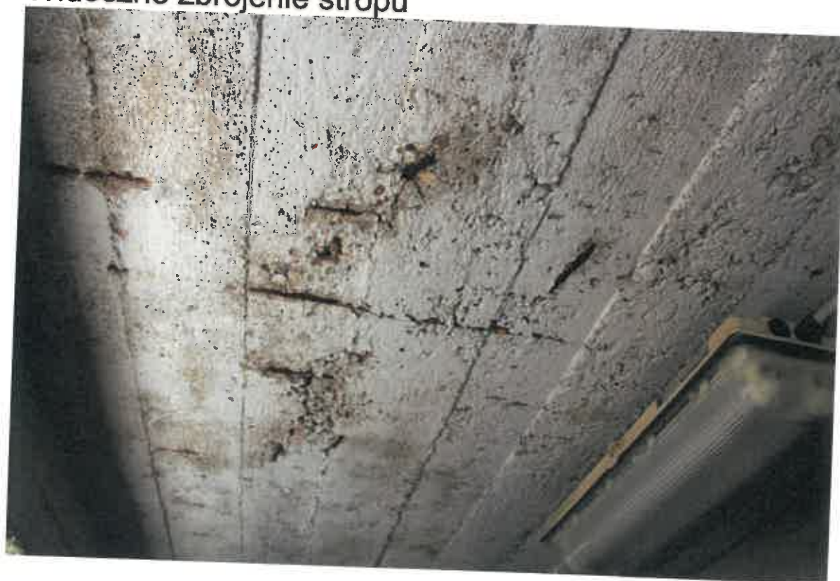
Widoczne zbrojenie stropu
