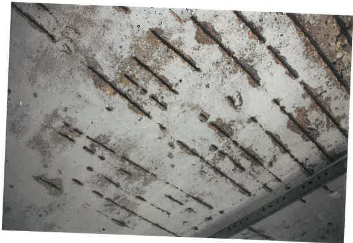
Widoczne pręty zbrojenia płyty
