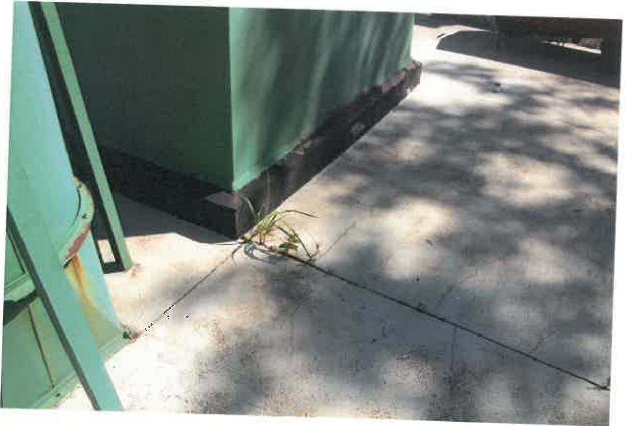
Uszkodzenie dylatacji
