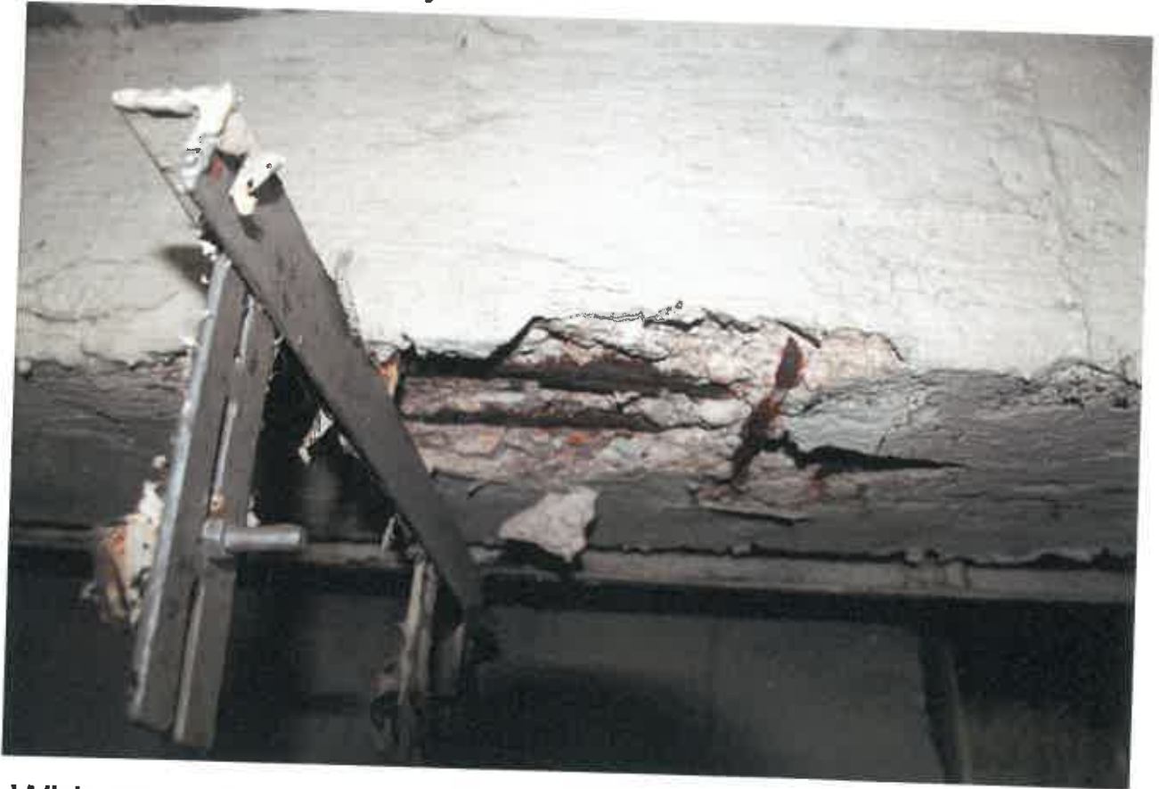
Widoczne zbrojenie płyty zaawansowana korozja betonu
