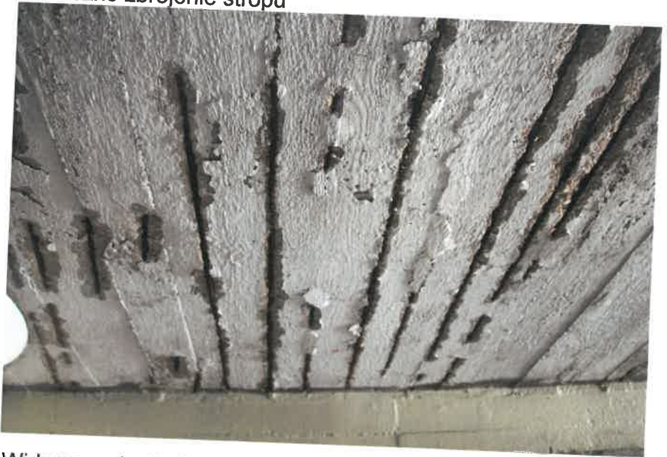
Widoczne zbrojenie belki
