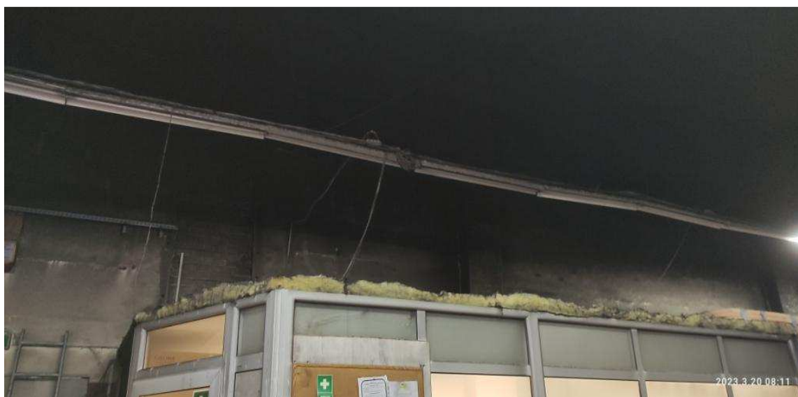
Uszkodzona (nadpalona) wełna mineralna ułożona na kontenerze wewnętrznym
