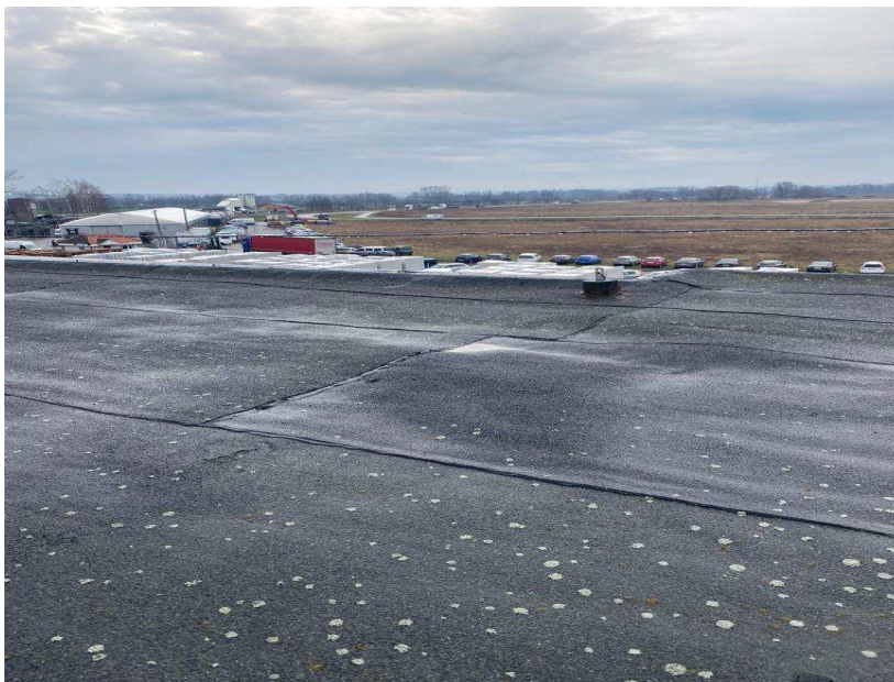
Uszkodzone pokrycie dachowe
