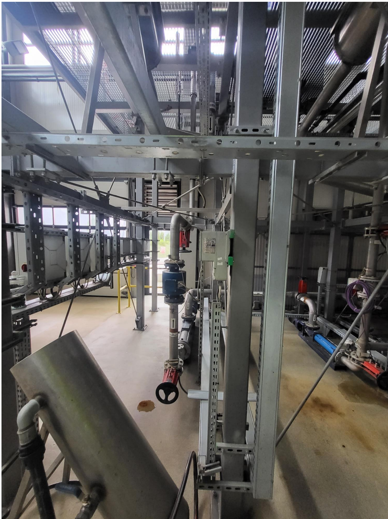
Zdj. 6, 7 – Pompa nadawcy osadu i przepływomierza osadu wymagająca wymiany
