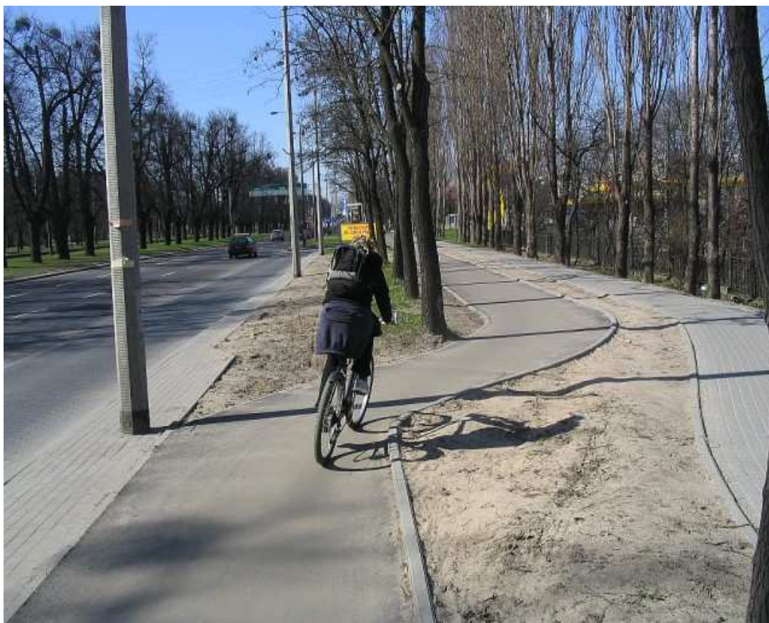
Rysunek 8 Zbyt małe promienie łuków, brak poszerzeń, odległość słupa i drzewa mniejsza od wymaganej 0,5 m
