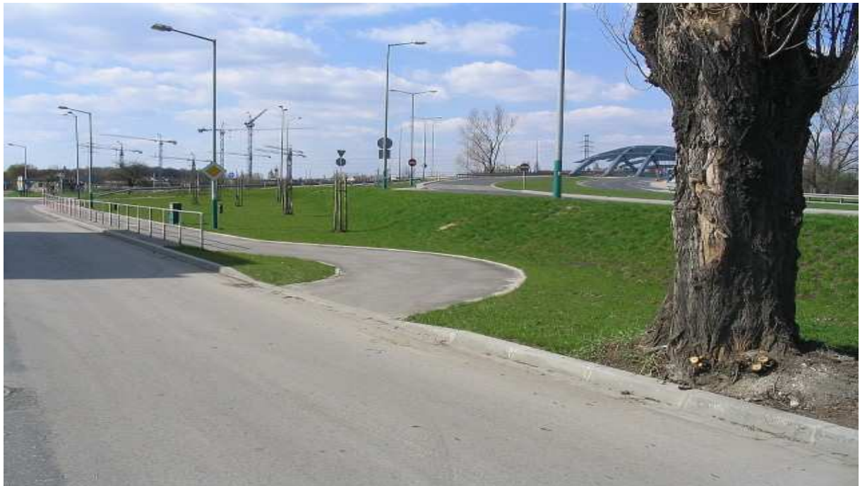
Rysunek 14 Nieprawidłowo zaprojektowany wjazd na drogę rowerową
