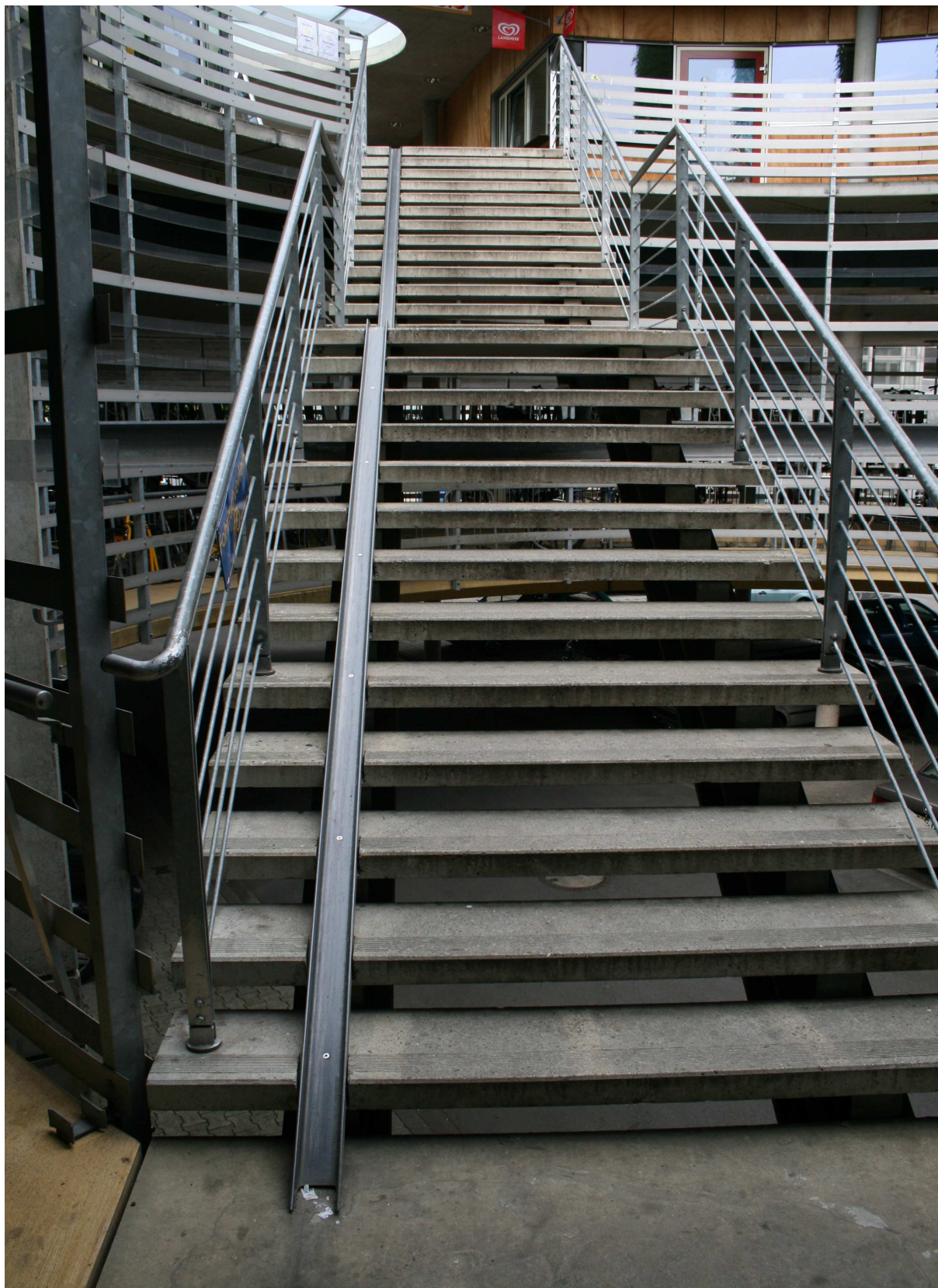
Rysunek 22 Rampa rowerowa na schodach
