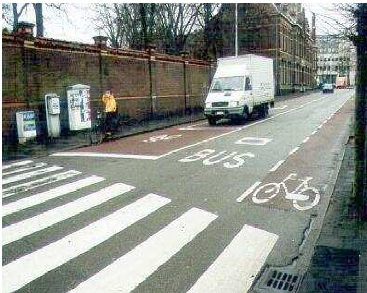
Rysunek 17 Przykład śluzy dla rowerów – przypadek 1 (niewłaściwie wbudowana kratka ściekowa)
