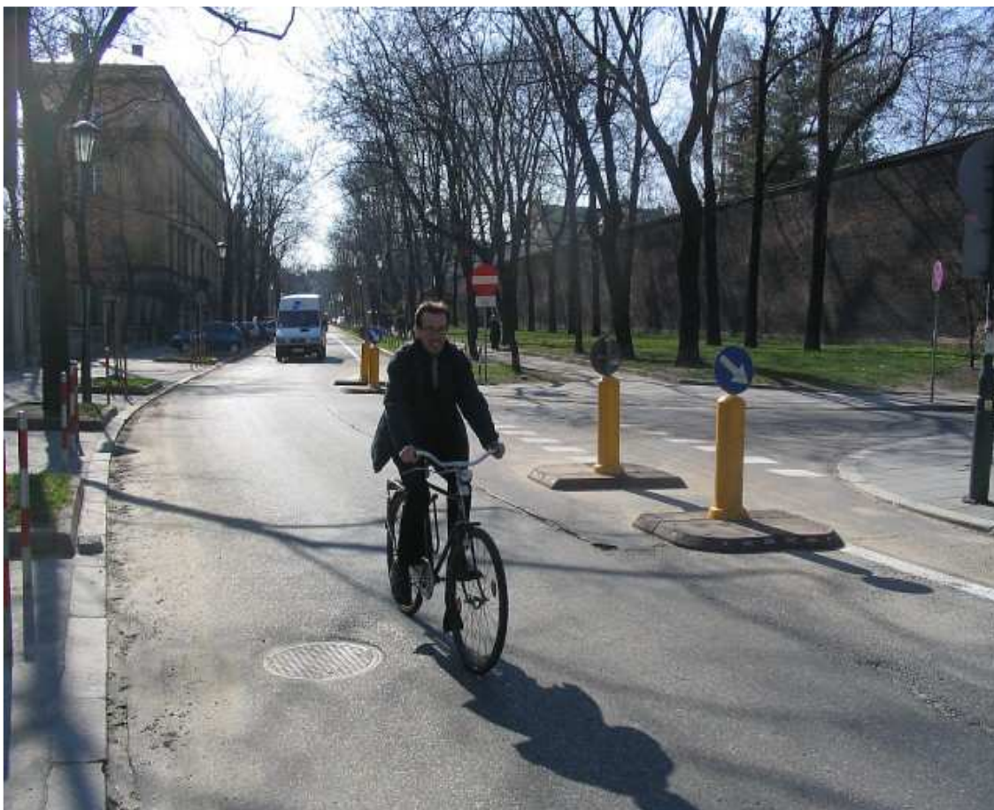
Rysunek 3 Kontrapas rowerowy w rejonie skrzyżowania z wszystkimi istotnymi elementami: wyspy, azyle, pylony, oznakowanie pionowe i poziome
