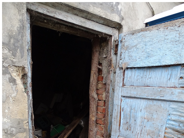
Fot 10 Parter pom. nr 01-podparte nadproże
