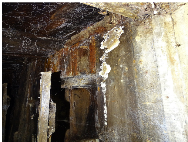
Fot 14 Parter pom. 04 – intensywne zagrzybienie
