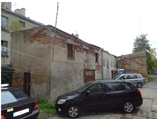
Fot 1 Elewacja północna – narożnik północno-wschodni
