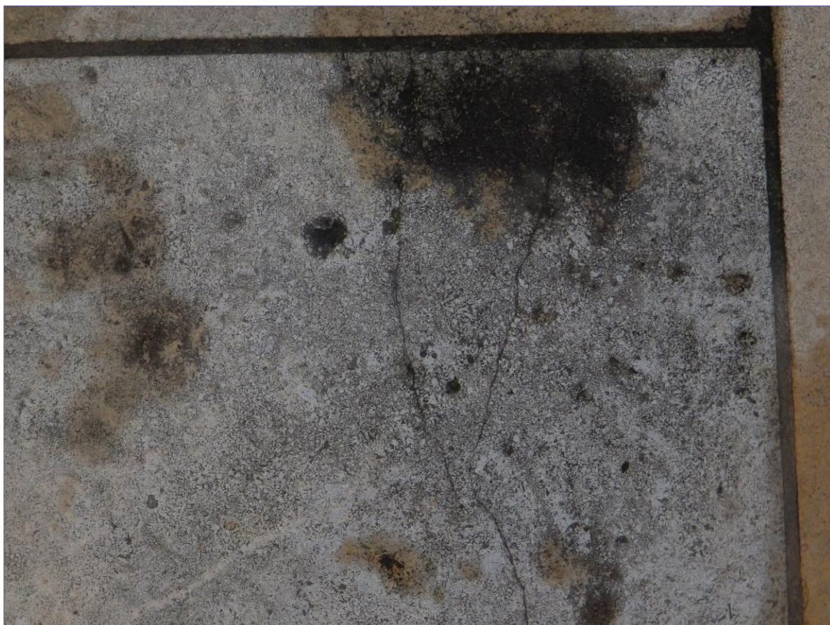
brak hydrofobizacji - zawilgocenie i korozja biologiczna; drobne niteczkowe spękania płyt kumulacja brudu w partiach zawilgoconych; uszkodzenia spoin – braki, wykruszenia,
