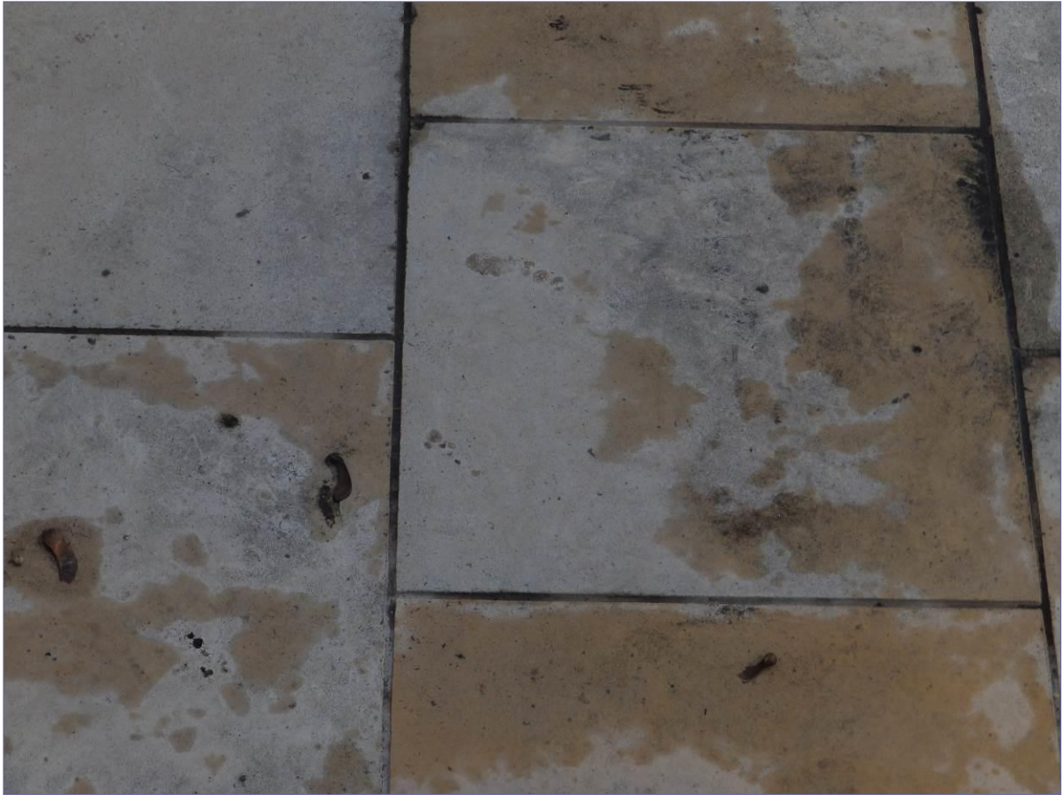
uszkodzenia spoin - spękania, wykruszenia, brak hydrofobizacji- zawilgocenie i korozja biologiczna; drobne niteczkowate spękania płyt
