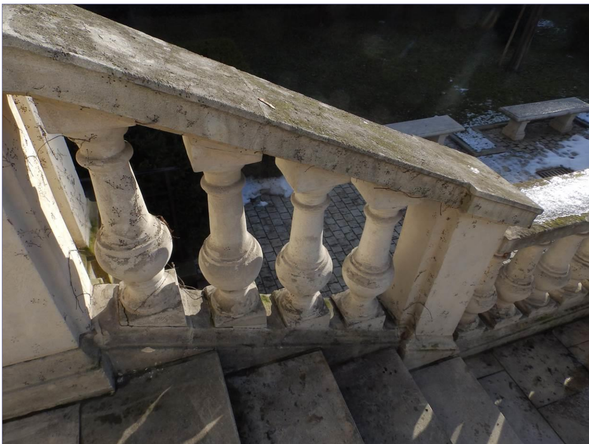
korozja biologiczna na elementach płaskich - głębokie wżery na powierzchni lica parapetów balustrad; niesprawne spoinowanie, spękania i ubytki; zabrudzenie różnice kolorystyczne kitów wykonanych podczas ostatniej konserwacji
