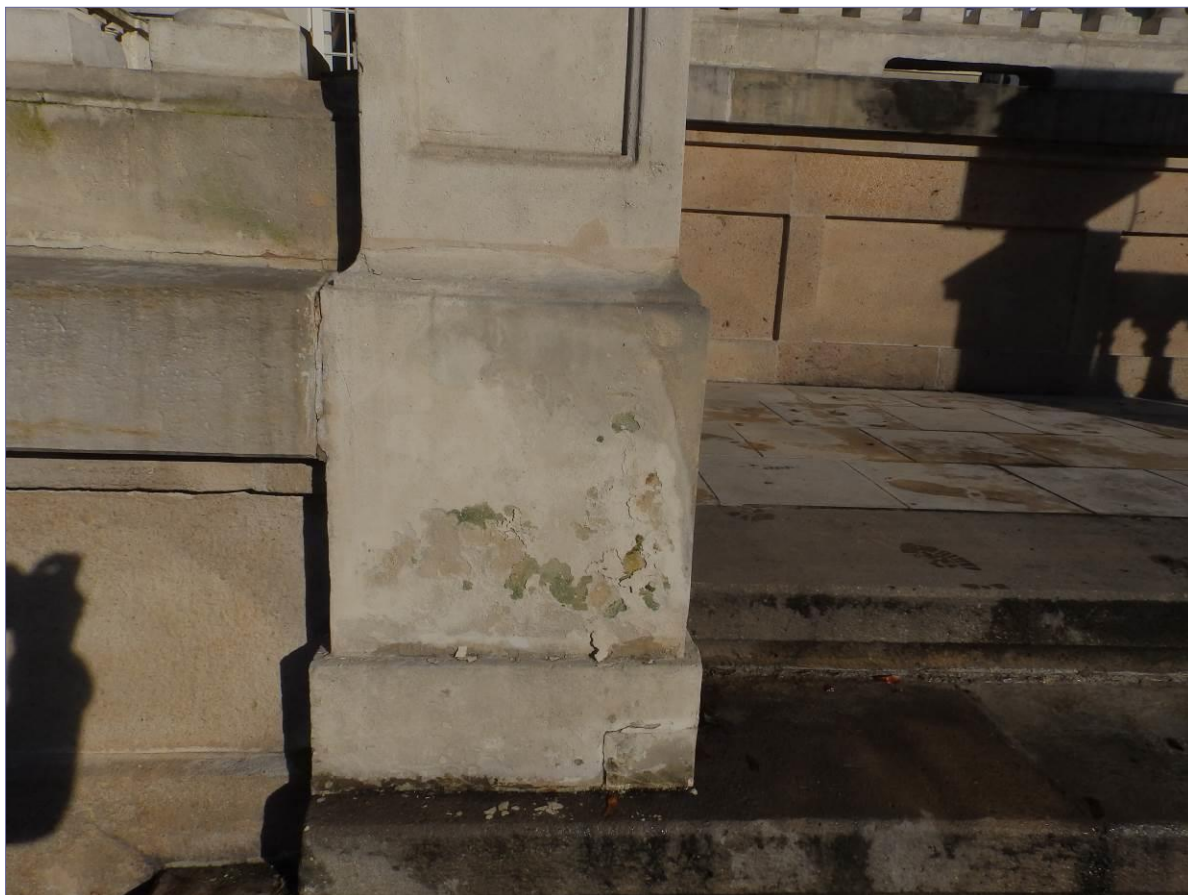
zawilgocenie i zasolenie postumentów, korozja biologiczna; widoczne spękania elementów kamiennych jak również liczne ubytki i wykruszenia spoinowania pomiędzy kamieniami
