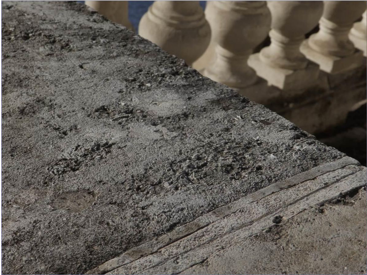
korozja biologiczna na elementach płaskich; głębokie wżery od strony lica parapetów balustrad; niesprawne spoinowanie; spękania i ubytki; zabrudzenie; uszkodzenia formy - krawędzi
