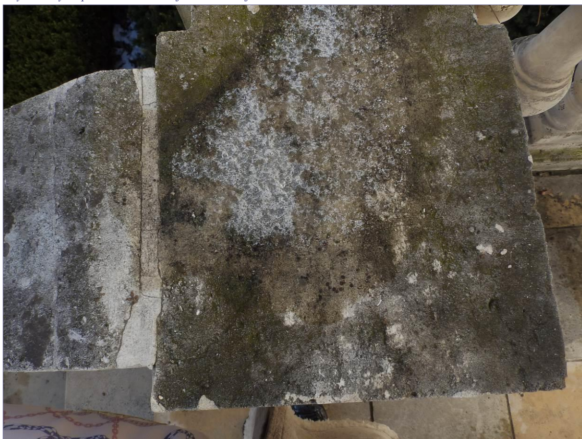
korozja biologiczna na elementach płaskich - głębokie wżery na powierzchni lica parapetów balustrad; niesprawne spoinowanie, spękania i ubytki; zabrudzenie różnice kolorystyczne kitów wykonanych podczas ostatniej konserwacji
