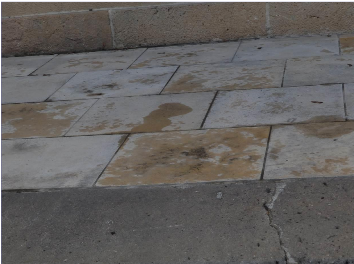
szerokie schody wejściowe – pęknięcia stopni z szarawego piaskowca wypełnione kitem, rozwarstwienie kitu od kamienia, podobnie jak – spoin – braki, wykruszenia, brak hydrofobizacji- zawilgocenie i korozja biologiczna
