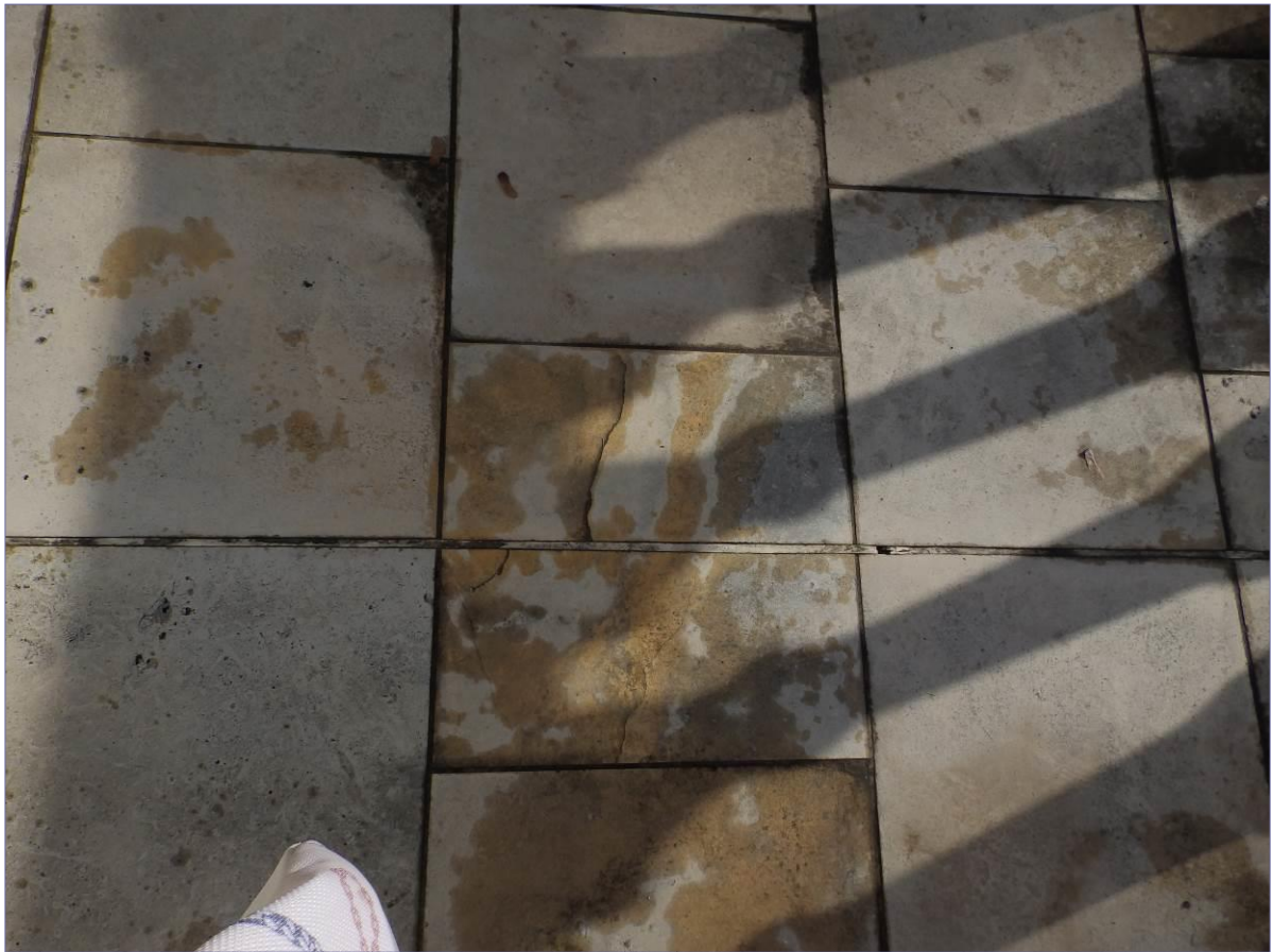
brak hydrofobizacji- zawilgocenie i korozja biologiczna, uszkodzenia spoin – braki i wykruszenia; drobne niteczkowate spękania płyt; drobne ubytki i rozwarstwiania przy powierzchniowej warstwy
