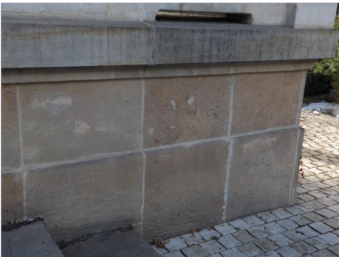
okładzina kamienna elewacji tarasu składająca się z płyt z opracowanym groszkowaniem; mocno zaznaczone jasne spoiny, częściowo wykruszone z ubytkami jak również zasolone; lokalnie widoczne złuszczenia kitów jako jasne plamy i zabrudzenia górnej części postaci zacieków czarnych lokalnie od strony zachodniej
