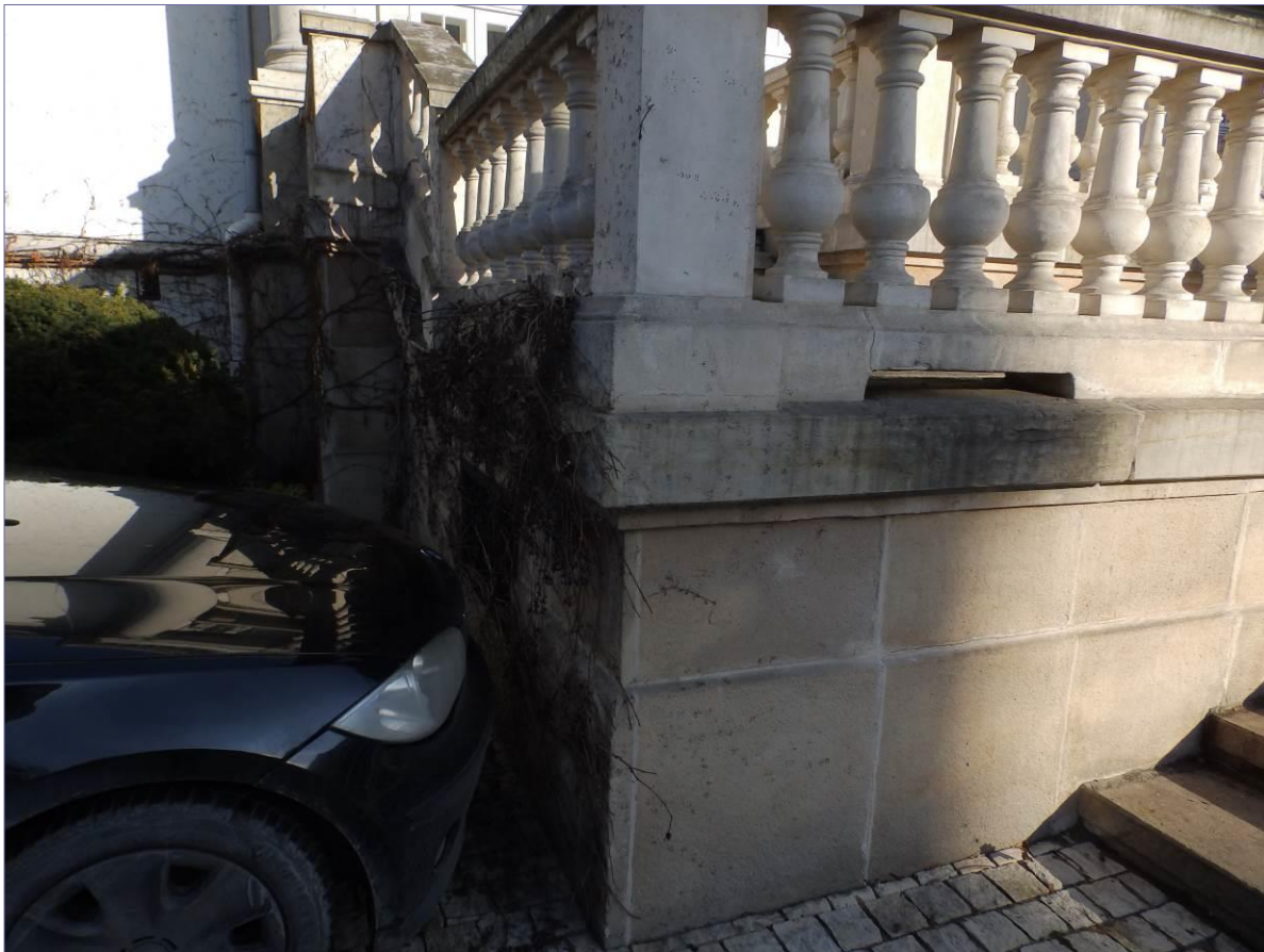
okładzina kamienna elewacji tarasu składająca się z płyt z opracowanym groszkowaniem; mocno zaznaczone jasne spoiny, częściowo wykruszone z ubytkami jak również zasolone; lokalnie widoczne złuszczenia kitów jako jasne plamy i zabrudzenia górnej części postaci zacieków czarnych lokalnie od strony zachodniej
