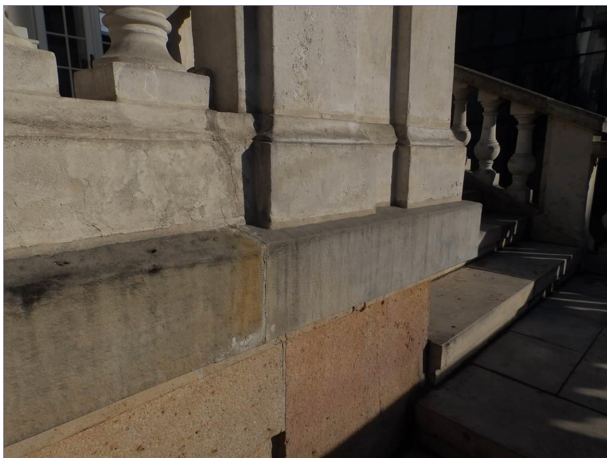
zawilgocenie i zasolenie postumentów, korozja biologiczna; widoczne spękania elementów kamiennych jak również liczne ubytki i wykruszenia spoinowania pomiędzy kamieniami
