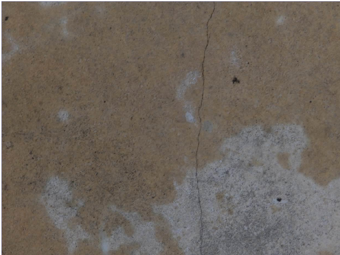
brak hydrofobizacji - zawilgocenie i korozja biologiczna; drobne niteczkowe spękania płyt kumulacja brudu w partiach zawilgoconych; uszkodzenia spoin – braki, wykruszenia,
