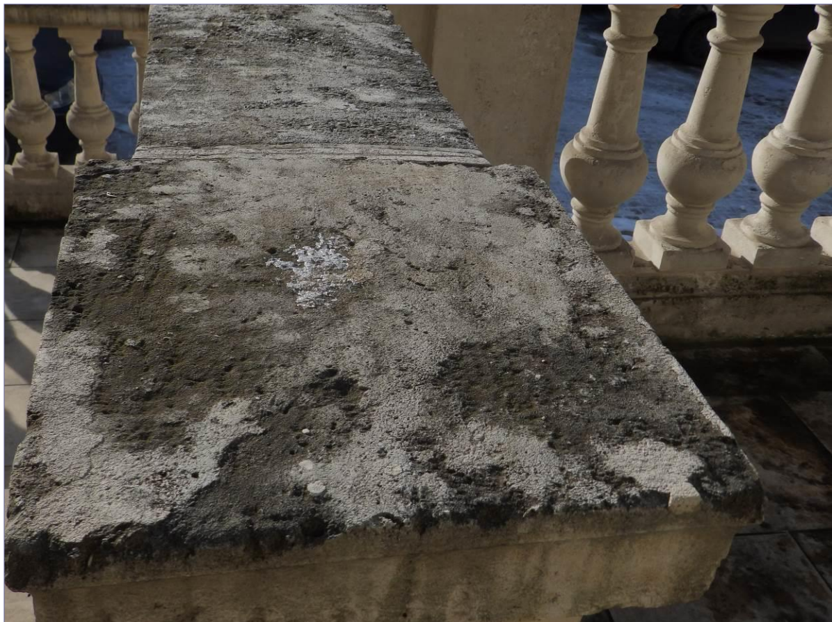
korozja biologiczna na elementach płaskich; głębokie wżery od strony lica parapetów balustrad; niesprawne spoinowanie; spękania i ubytki; zabrudzenie; uszkodzenia formy - krawędzi
