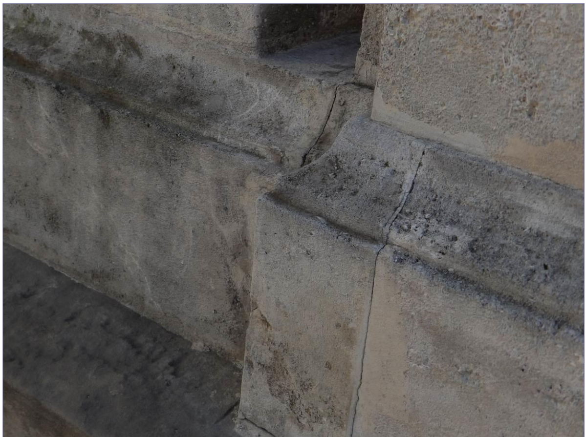
brak hydrofobizacji- zawilgocenie i korozja biologiczna, uszkodzenia spoin – braki i wykruszenia; drobne niteczkowate spękania płyt; drobne ubytki i rozwarstwiania przy powierzchniowej warstwy
