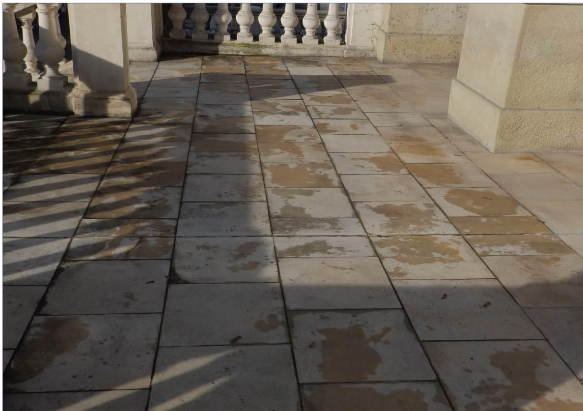
posadzka tarasu z kwadratowych płyt ze spoinowaniem mineralnym - widok w kierunku zachodnim
