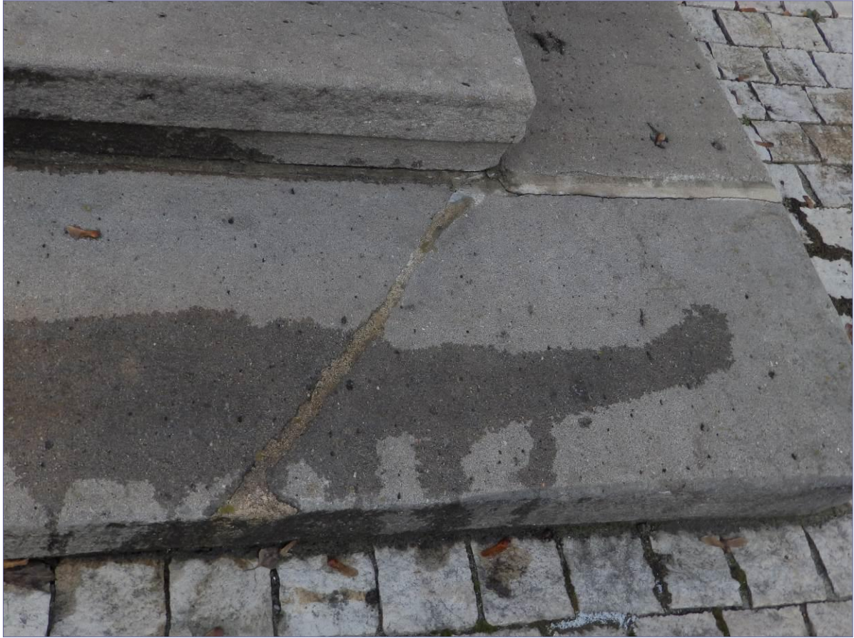
szerokie schody wejściowe – pęknięcia stopni z szarawego piaskowca wypełnione kitem, rozwarstwienie kitu od kamienia, podobnie jak – spoin – braki, wykruszenia, brak hydrofobizacji- zawilgocenie i korozja biologiczna
