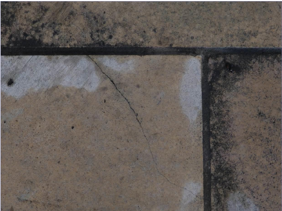
uszkodzenia spoin - spękania, wykruszenia, brak hydrofobizacji- zawilgocenie i korozja biologiczna; drobne niteczkowate spękania płyt
