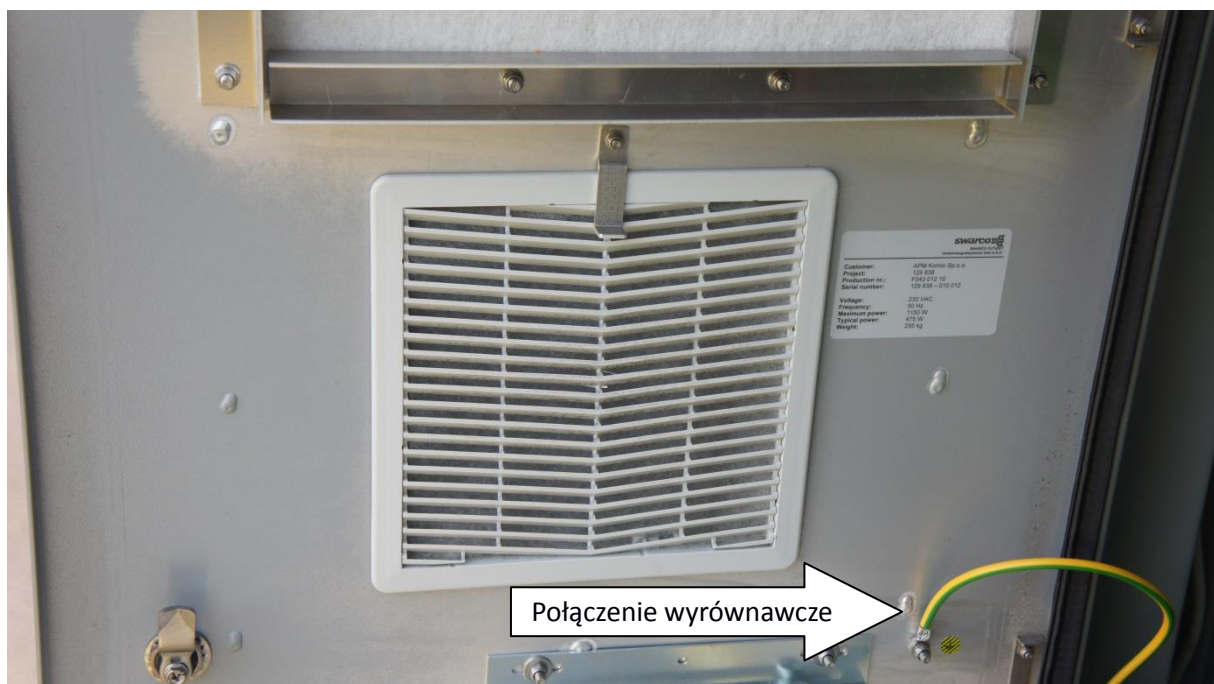
Rys. Umieszczenie połączenia wyrównawczego.
