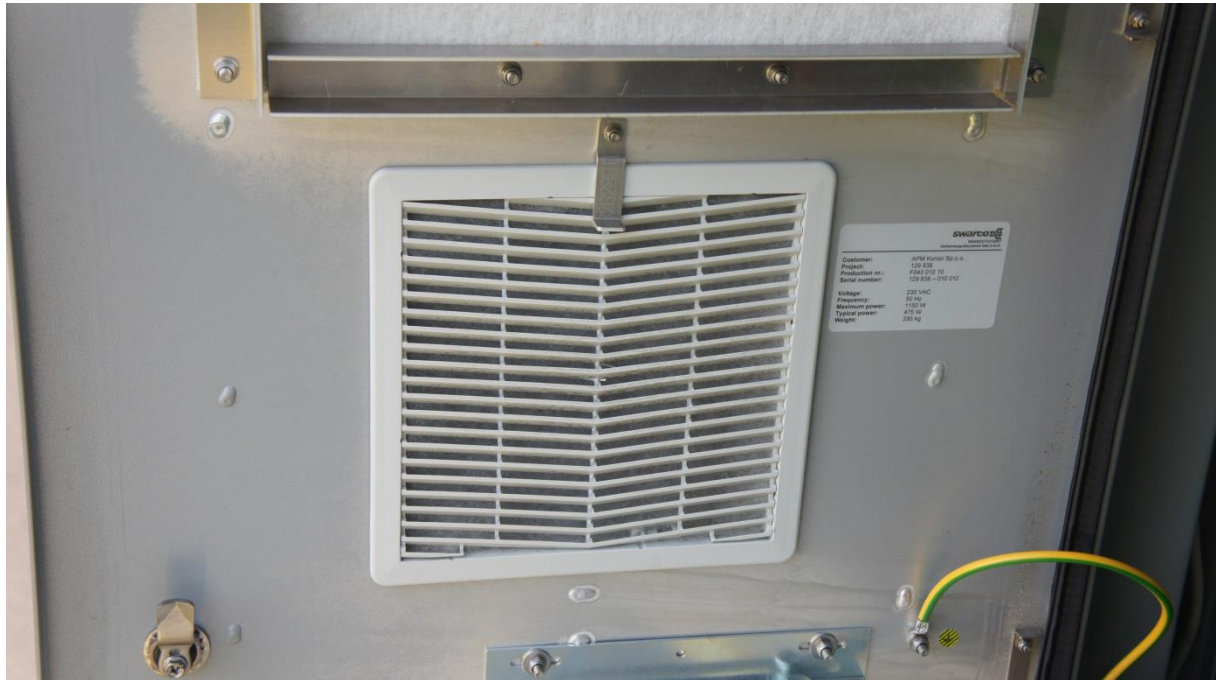
Rys. Umieszczenie filtra wentylacji na dole drzwi
