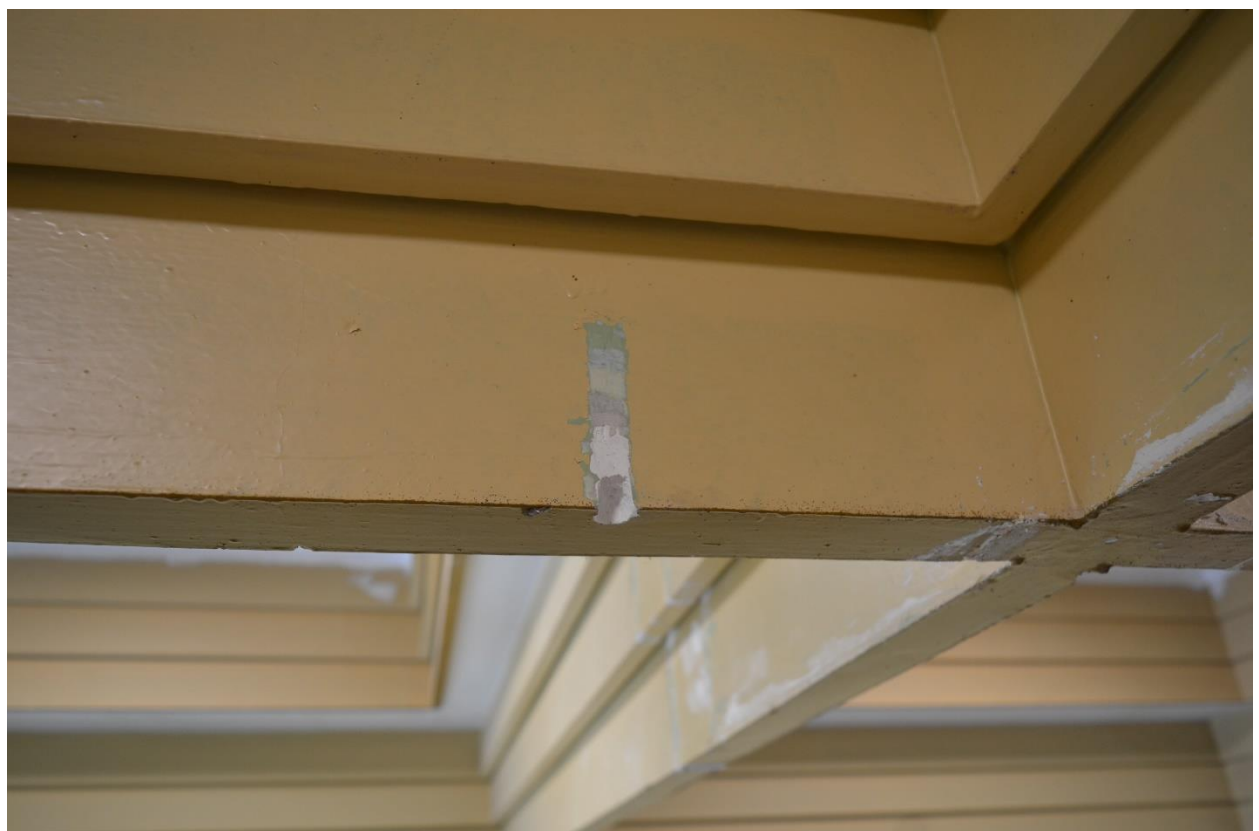
Fot. 12 Kasetonowy sufit z wykonaną odkrywką sondażową z widocznymi wtórnymi warstwami malarskimi oraz grubością gipsowej zaprawy. (fot. K.J.)
