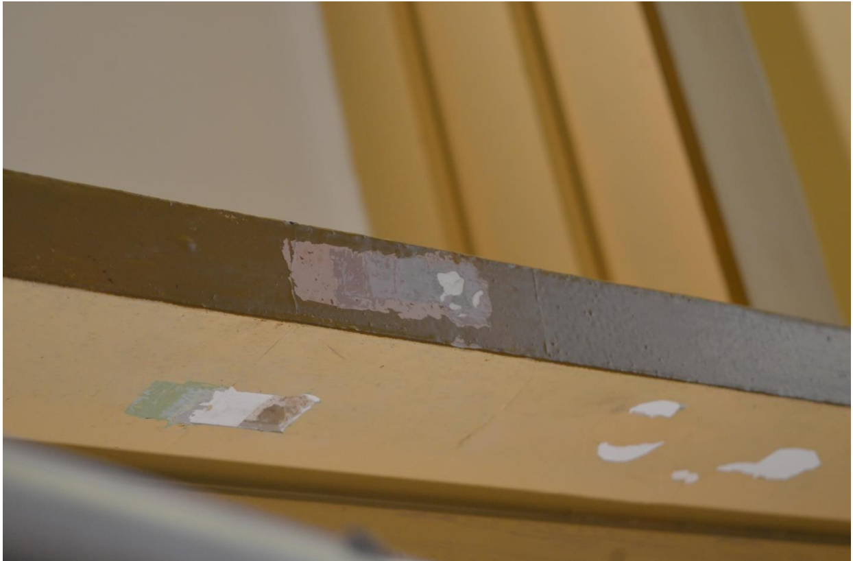
Fot. 13 Kasetonowy sufit z widocznymi warstwami stratygraficznymi. (fot. K.J.)
