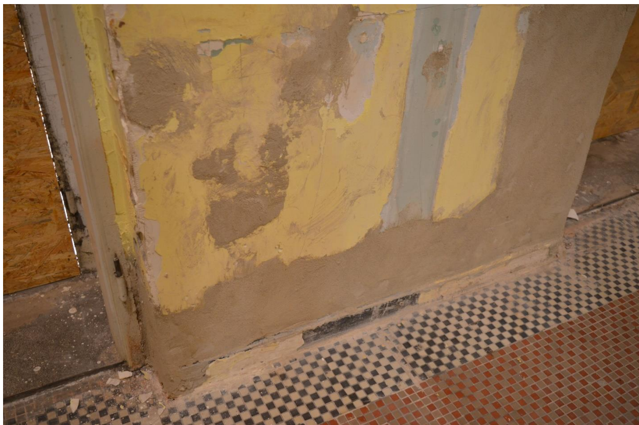
Fot. 20 Zbliżenie na listwę podlogową, a także wtórne, nieestetycznie nałożone zaprawy oraz uniesiony fragment posadzki. (fot. K.J.)
