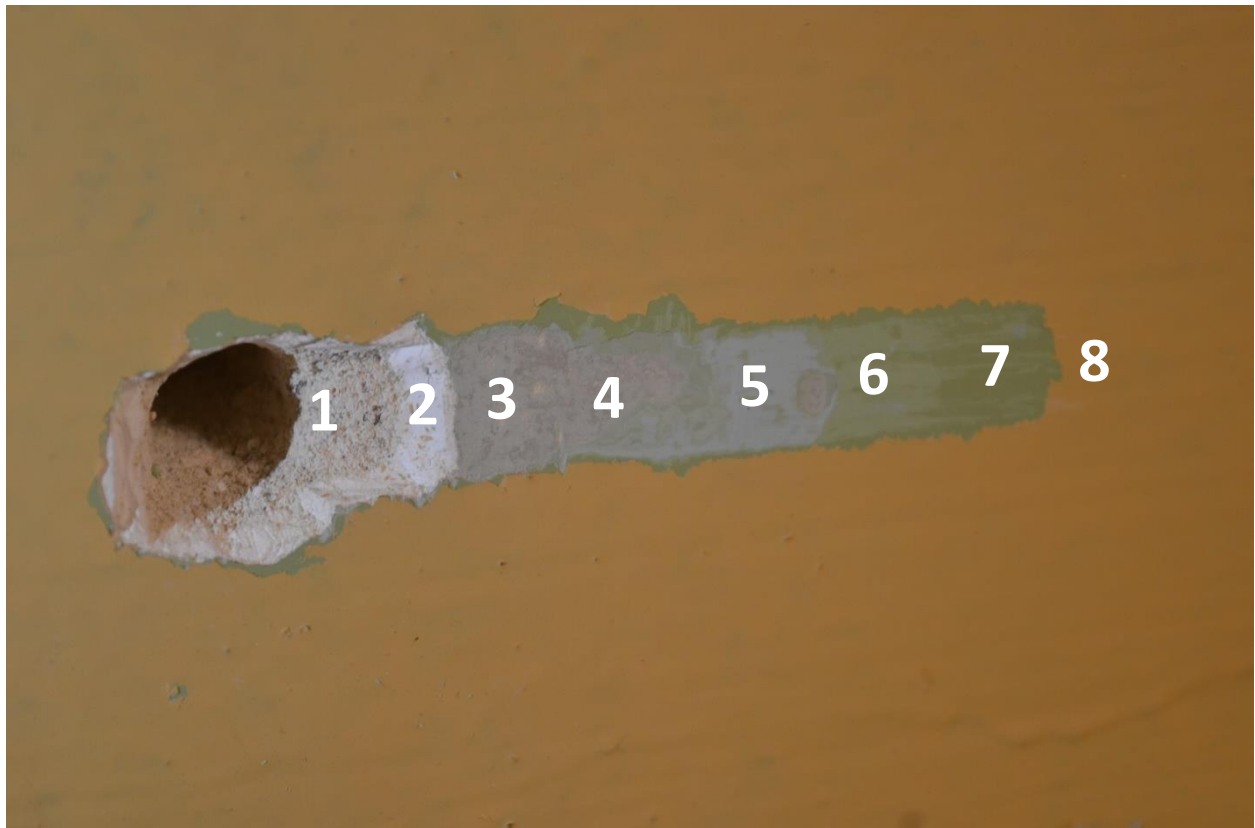
Fot. 51 Odkrywka schodkowa na powierzchni kasetonu : 1 – podłoże mineralne, zaprawa wapienno-piaskowa z dodatkiem cementu?, 2 – zaprawa gipsowa, 3 – ciemnoszara w. malarska, 4- jasnoszara w. malarska, 5 – jasnoblękitna w. malarska, 6 – jasnozielona w. malarska, 7 – ciemnozielona w. malarska, 8 – ugrowa w. mal.
