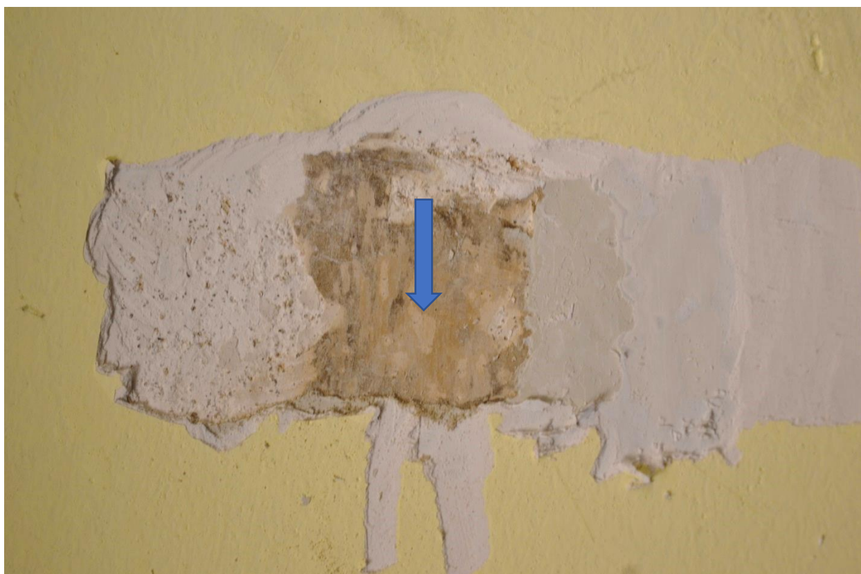
Fot. 71 Schodkowa odkrywka sondażowa w ościeżu okiennym: widoczna pierwotna, beżowa warstwa malarska. (fot. K.J.)
