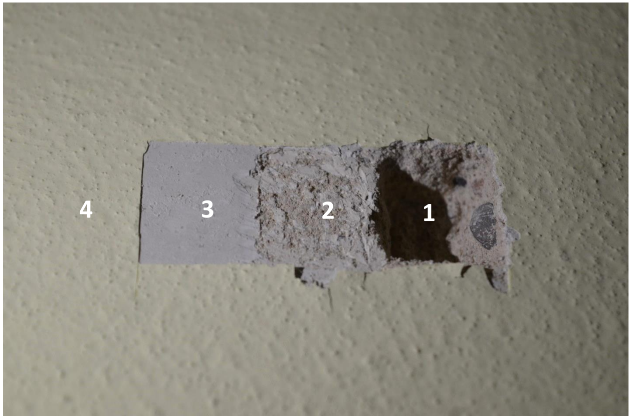
Fot. 72 Schodkowa odkrywka sondażowa na suficie sali wypoczynkowej: 1 – podłoże – zaprawa mineralna, 2 – pobiałka wapienna?, 3 – szara, wtórna warstwa malarska, 4 – żółta warstwa malarska
