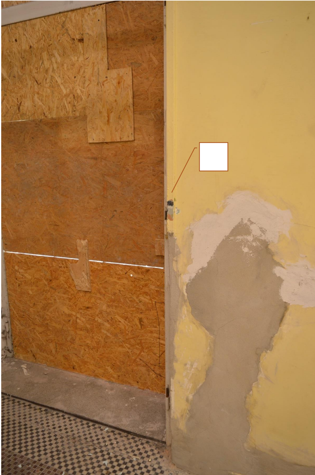
Fot. 59 Miejsce wykonania odkrywki schodkowej – metalowe obramienie jednego otworów drzwiowych ściany wychodzącej na wirydarz. (K.J.)
