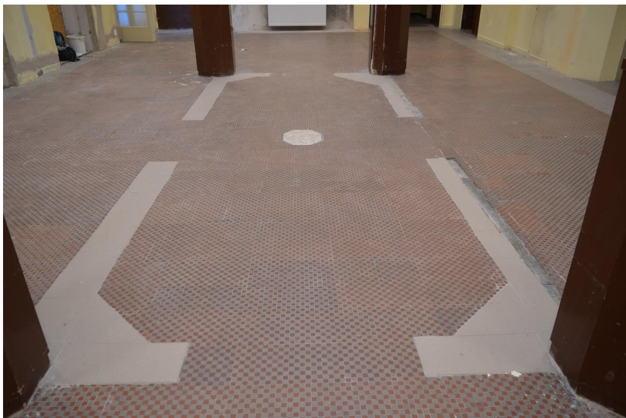
Fot. 15 Widok na centralną część pomieszczenia ze śladami po ławkach i fontannie w postaci szarych płytek. Pomiędzy nimi widoczne łączenia mozaikowych arkuszy. (fot. K.J.)
