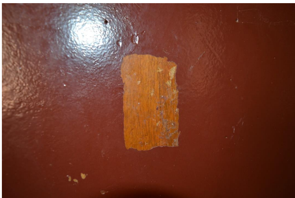
Fot. 25 Odkrywka na drzwiach do dawnego refektarza. Widoczne drewno dębu pokryte lakierem. (fot. K.J.)
