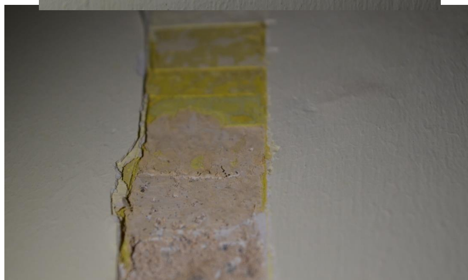
Fot. 65 a i b Odkrywka schodkowa na ścianie pomieszczenia głównego: 1 – zaprawa wapienno-piaskowa, 2 – pobiałka wapienna, 3 – pierwotna, beżowa warstwa malarska, 4 – żółtobeżowa warstwa malarska, 5 – żółtozielona warstwa malarska, 6 – żółta warstwa malarska, 7 – szarozółta warstwa malarska, 8 – jasnożółta warstwa malarska, 9 – żółta warstwa malarska
