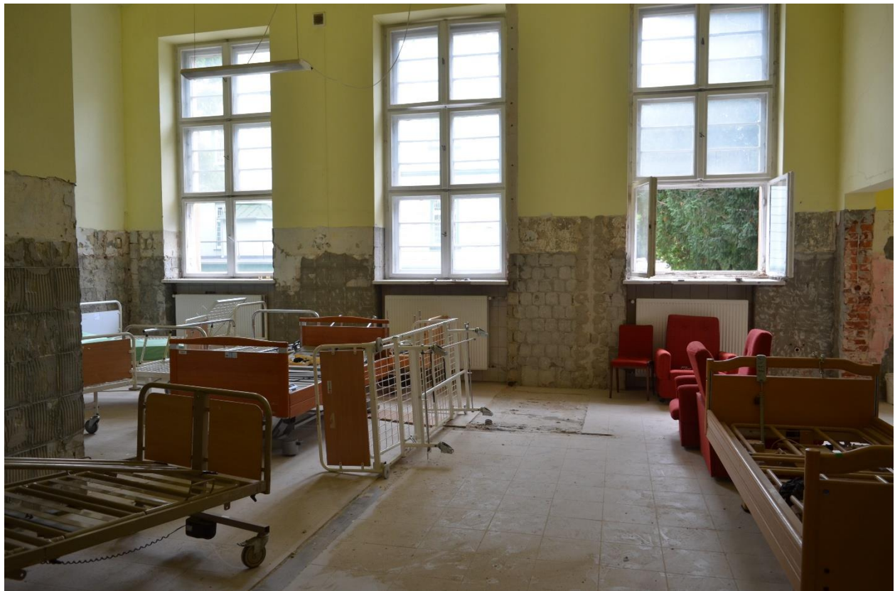
Fot. 31 Widok na ścianę ze stolarzkę okienną. (fot. K.J.)
