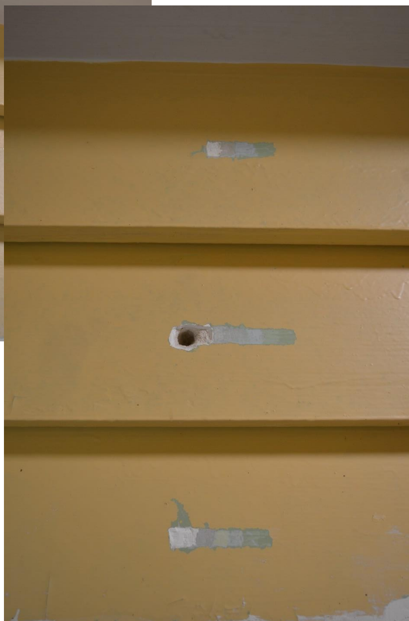
Fot. 50 a i b Seria odkrywek schodkowych na jednym z kasetonów. (fot. K.J.)
