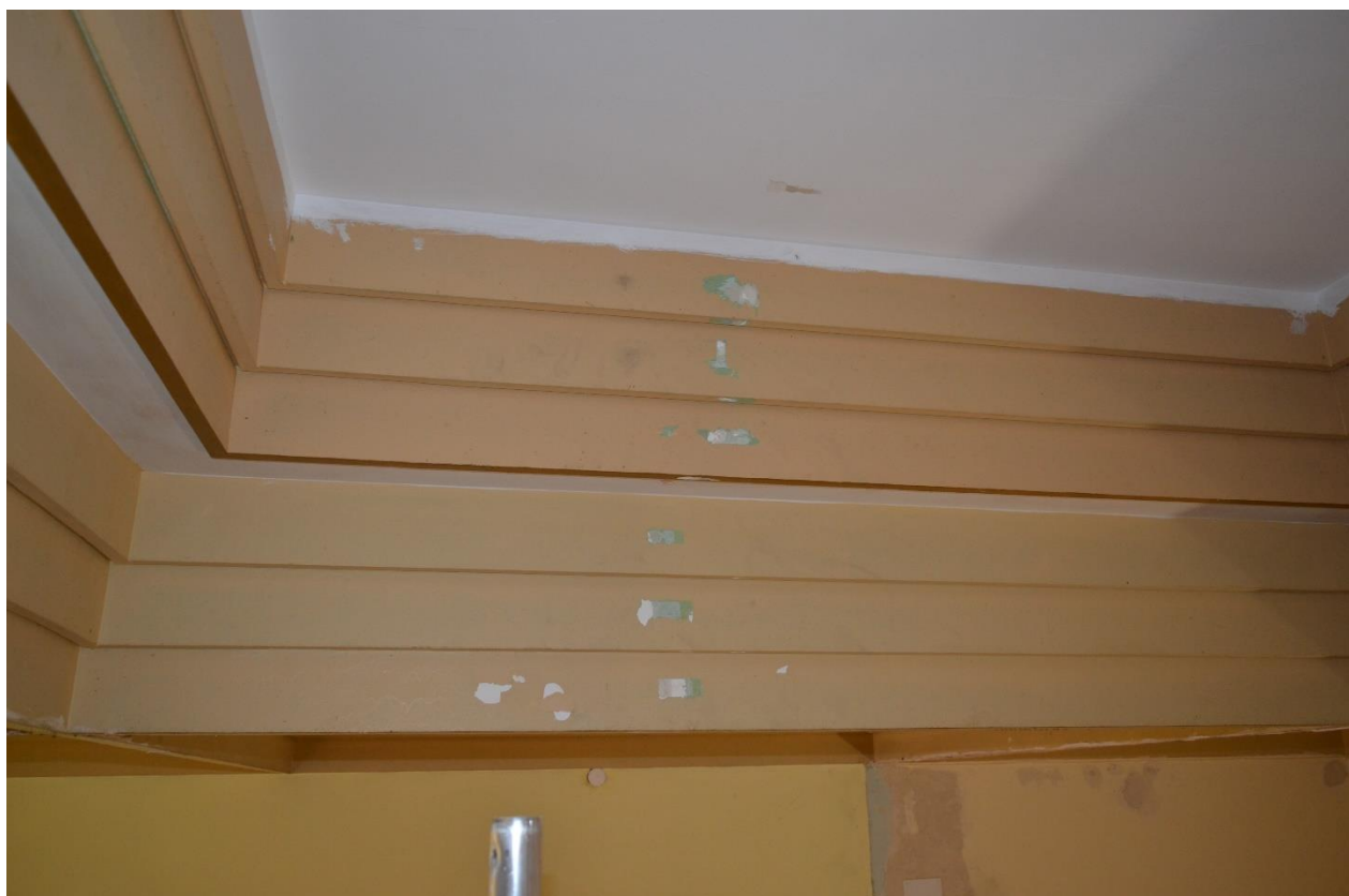
Fot. 11 Kasetonowy sufit z wykonanymi odkrywkami sondażowymi. (fot. K.J.)
