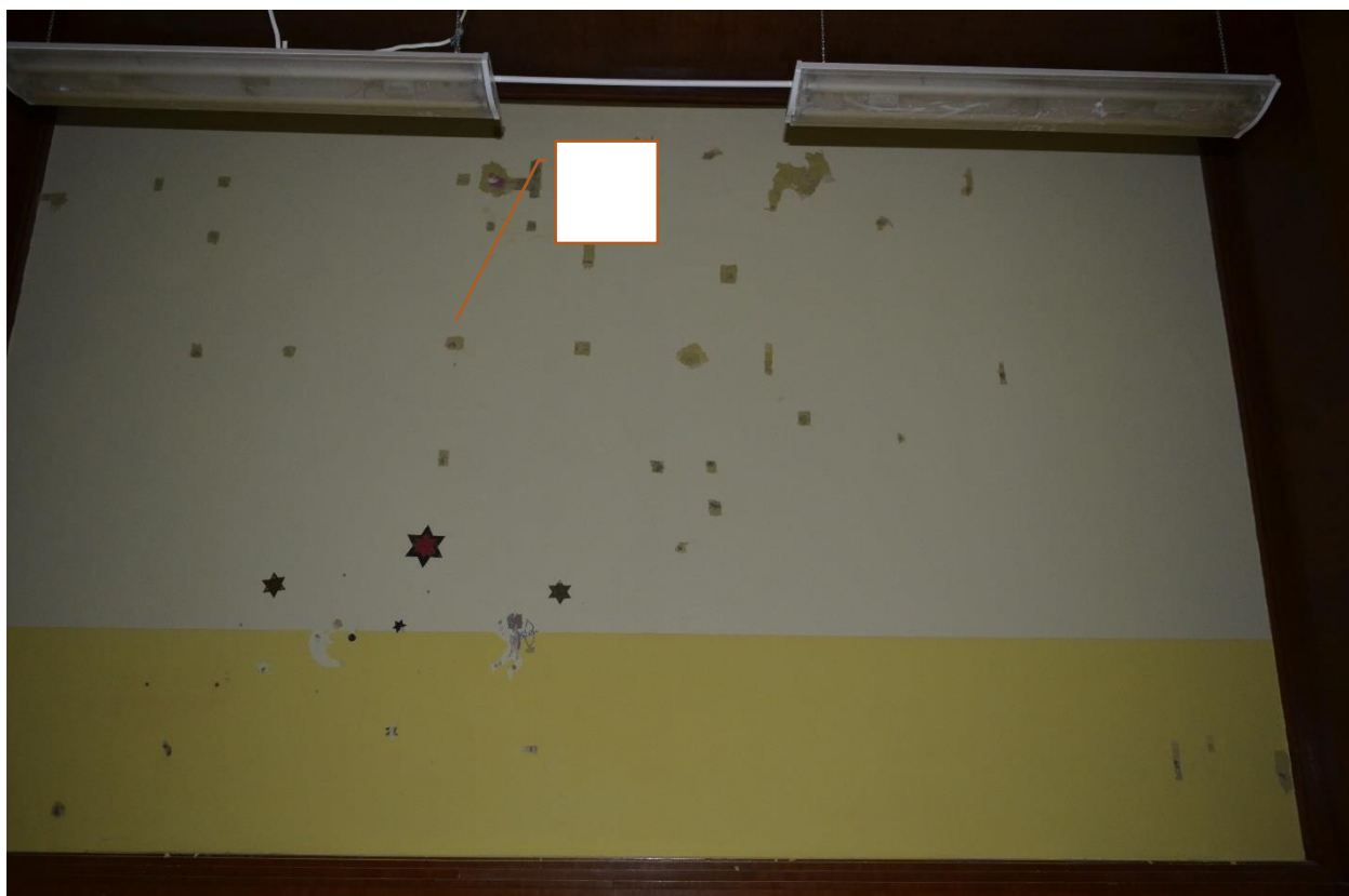
Fot. 68 Wskazanie miejsce pobrania próbki do badań i wykonania odkrywki sondażowej – ściana współdzielona z kaplicą, na której dawniej wisiał ogromny obraz o tematyce sakralnej widoczny na zdjęciu archiwalnym sali wypoczynkowej. (fot. K.J.)
