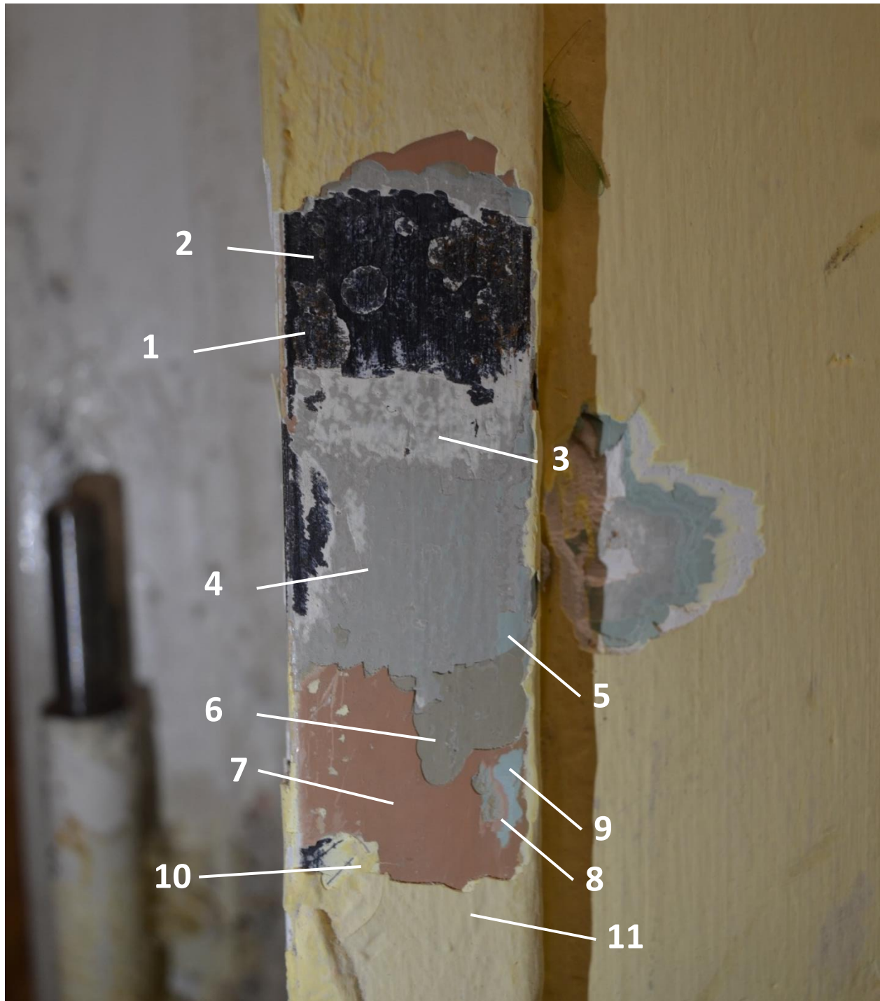
Fot. 60 Odkrywka sondażowa schodkowa na metalowej listwie okalającej jeden z otworów drzwiowych ściany wychodzącej na wirydarz: 1 – metalowe podłoże, 2 – czarna warstwa malarska, 3 – biała warstwa malarska, 4 – szara warstwa malarska, 5 – szarobłękitna warstwa malarska, 6 – beżowa warstwa malarska, 7 – ceglasta warstwa malarska, 8 – różowa warstwa malarska, 9 – błękitna warstwa malarska, 10 – żółta warstwa malarska, 11- jasnożółta warstwa malarska
