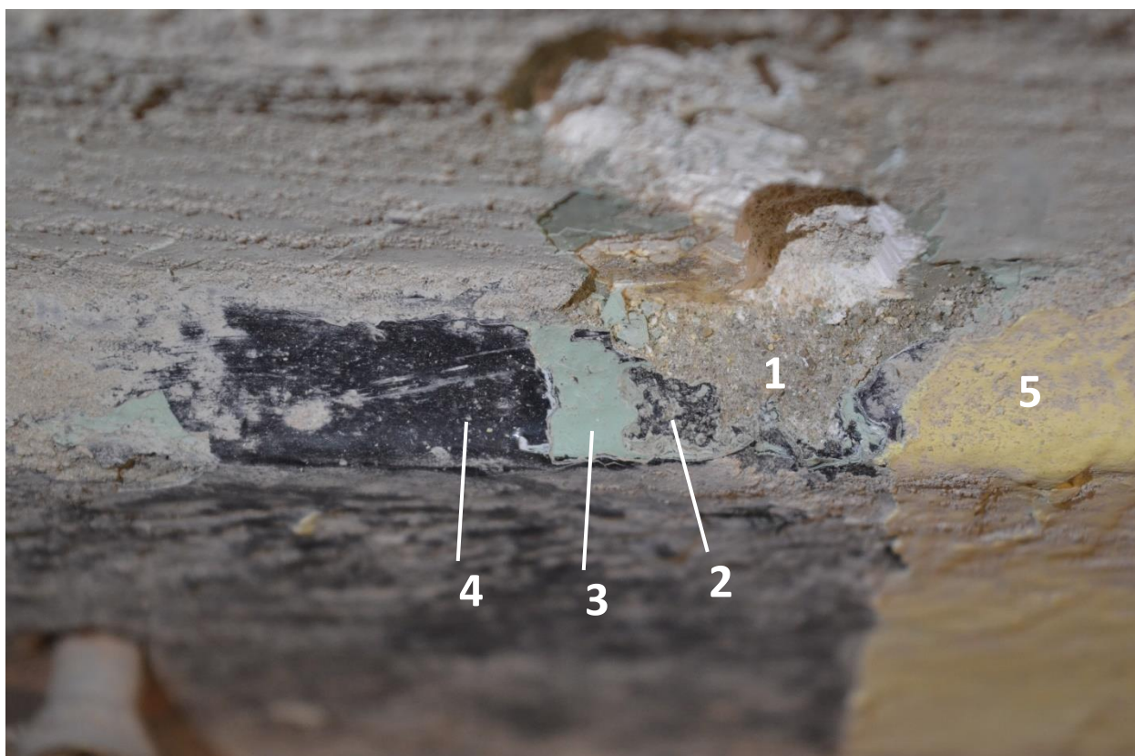
Fot. 62 Odkrywka na listwie przypodłogowej: 1 – podłoże z zaprawy mineralnej, 2 – pierwotna?, czarna warstwa malarska, 3 – jasnozielona warstwa malarska, 4 – czarna warstwa malarska.
