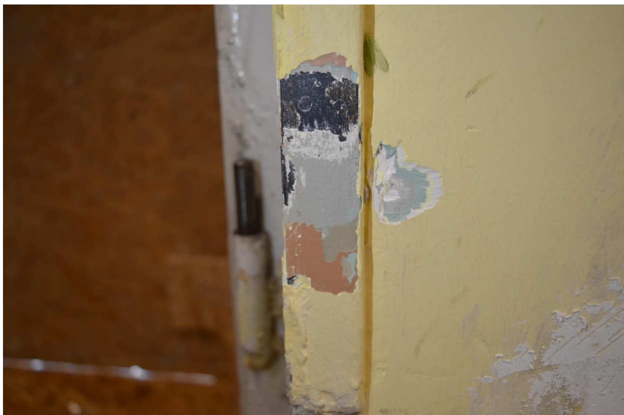
Fot. 21 Odkrywka na metalowej listwie okalającej jeden z otworów drzwiowych historycznej stolarki. Widoczne wielokrotne przemalowania. Pierwszą warstwę kolorystyczną stanowi prawdopodobnie czerń. (fot. K.J.).
