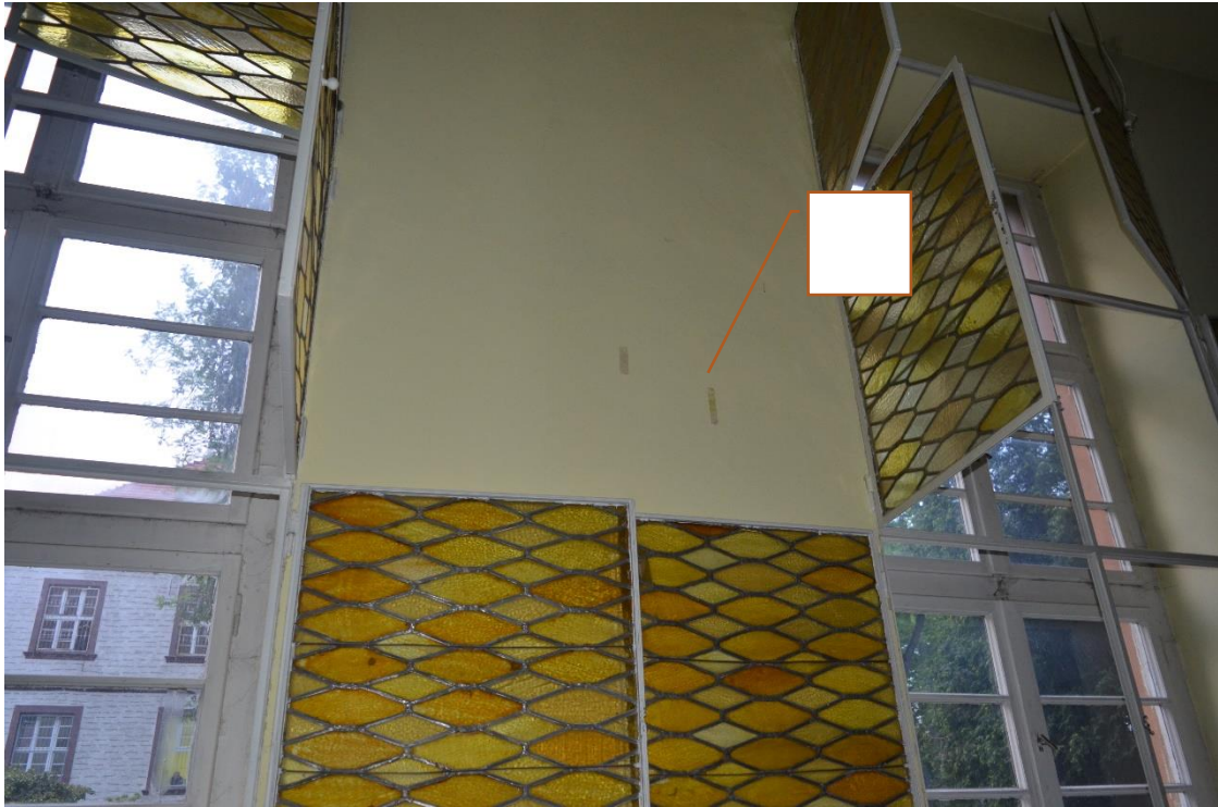
Fot. 66 Miejsce wykonania schodkowej odkrywki sondażowej na ścianie. (K.J.)
