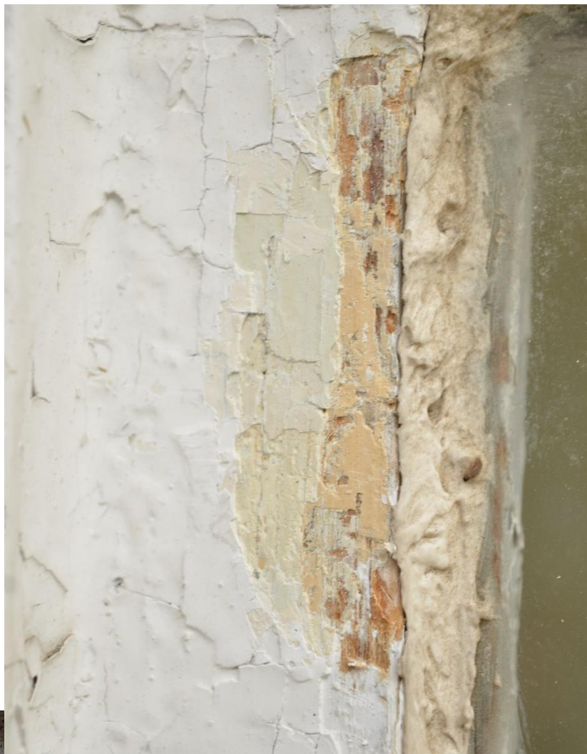
Fot. 74 Odkrywka sondażowa na ramie okiennej: widoczne wtórne warstwy malarskie, w tym oranżowa. (fot. K.J.)
