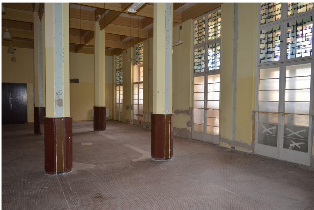
Fot. 4 Wnętrze holu po usunięciu wtórnych ścian działowych w 2021 r..
