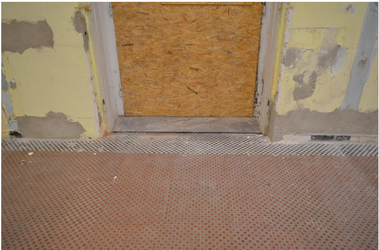
Fot. 14 Ściana wychodząca na wirydarz. Widoczne wtórne uzupełnienia zaprawy, a także częściowo zachowana czarna listwa przypodłogowa. (fot. K.J.)
