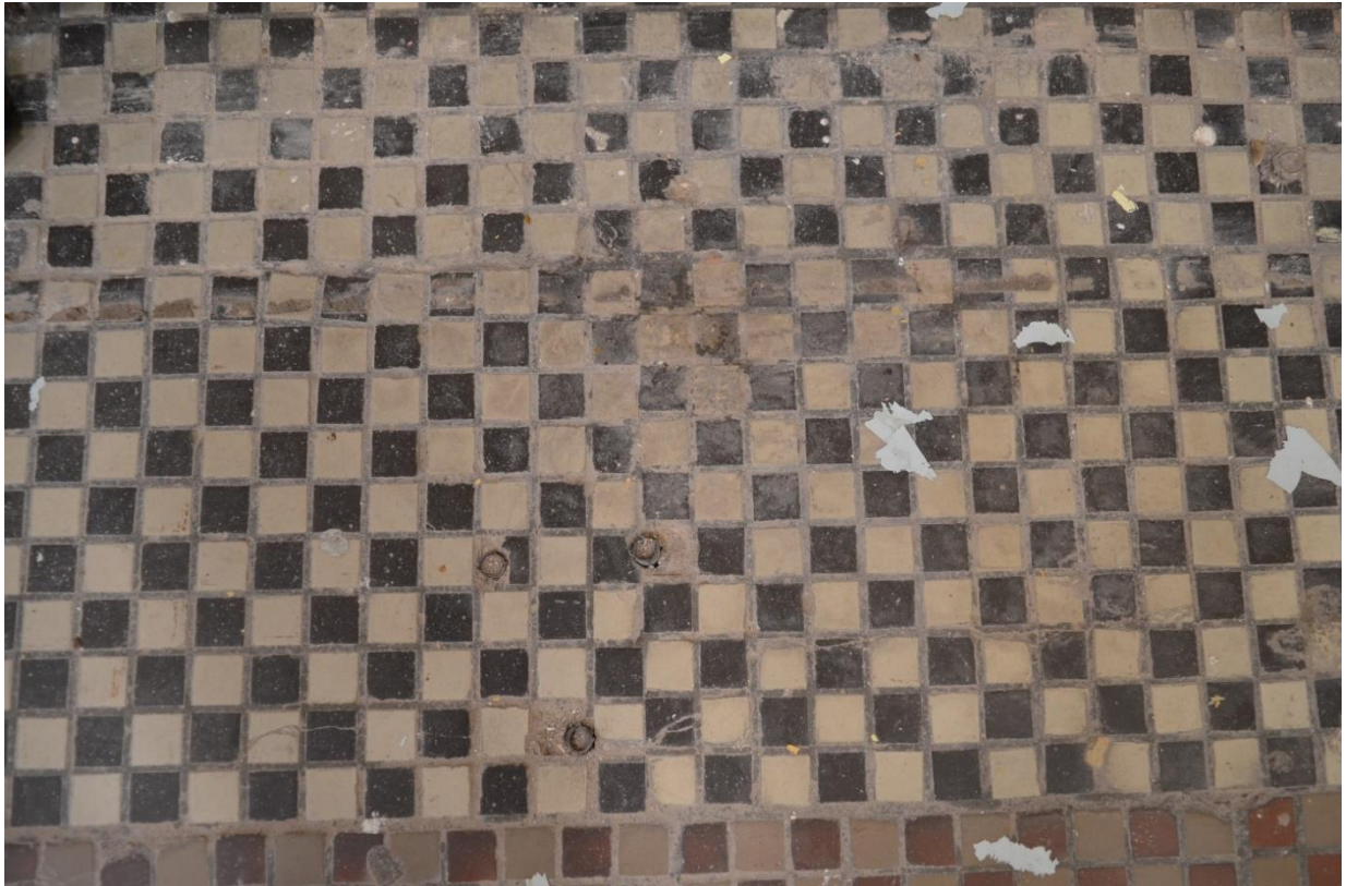
Fot. 57 Zbliżenie na kostki mozaikowej, ceramicznej posadzki. (fot. K.J.)
