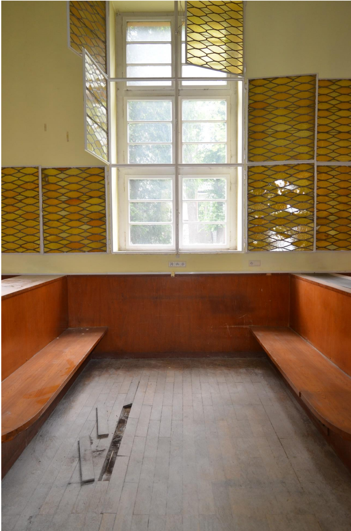
Fot. 35 Widok na odsłonięte geometryczne witraże z epoki w odcieniach żółci; także jeden z boksów z ławkami oraz dębowy parkiet. (fot. K.J.)
