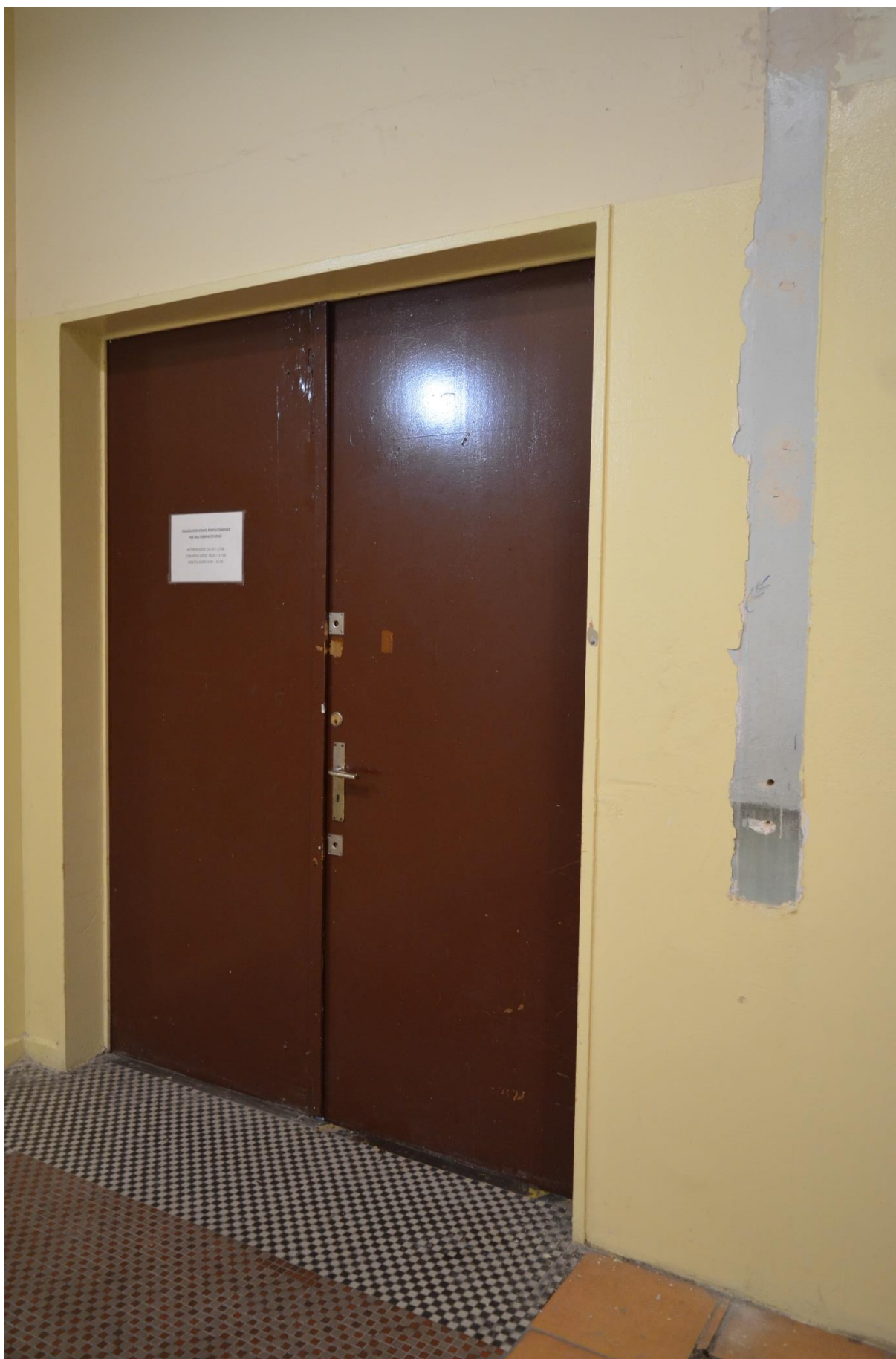
Fot. 23 Przemalowane dębowe, fornirowane drzwi do sali gimnastycznej (dawnego refektarza). (fot. K.J.)
