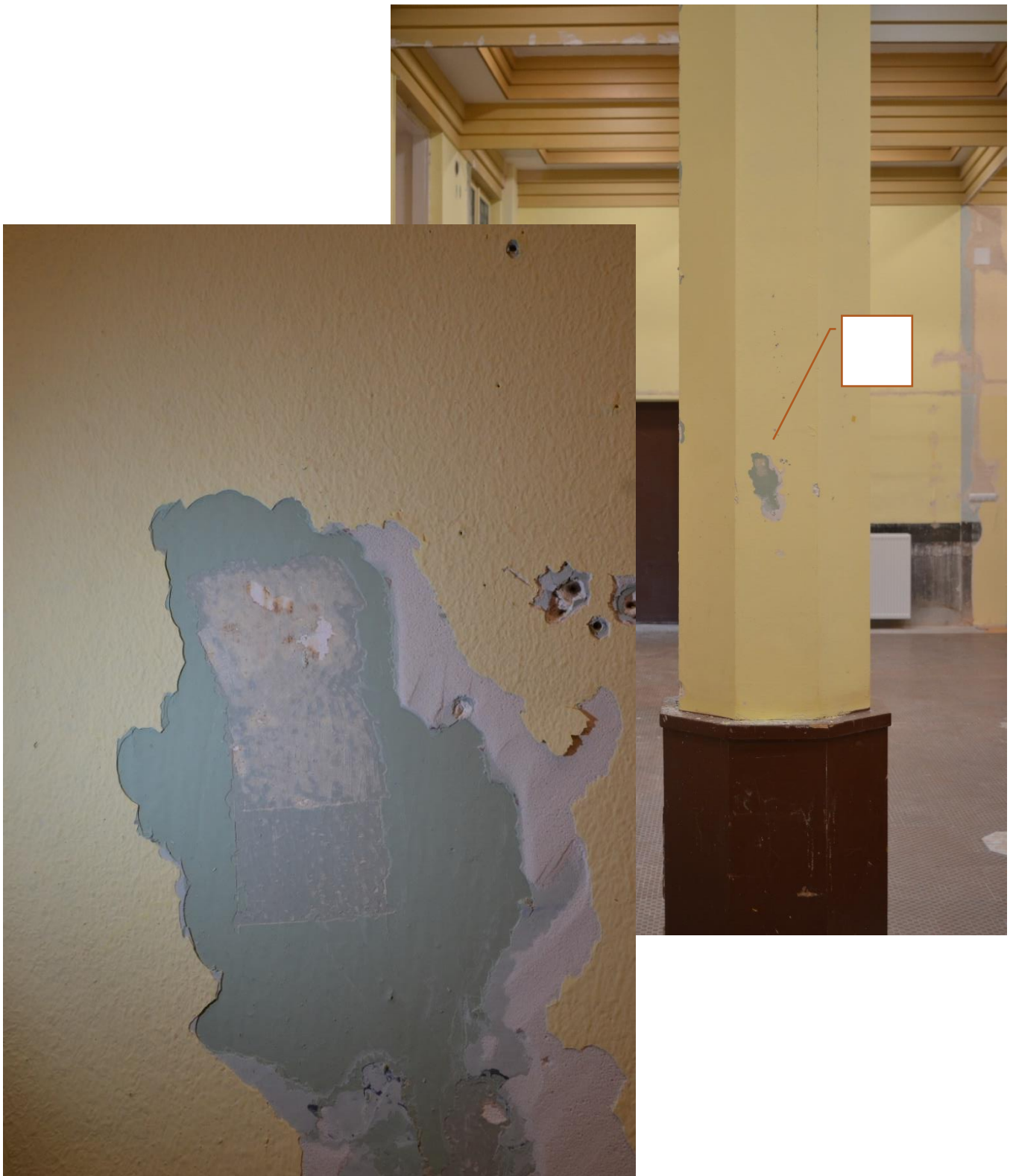
Fot. 55 a i b Odkrywka sondażowa na jednym z filarów. Widoczny fragment warstwy malarskiej w formie mazerunku (?). (fot. K.J.)
