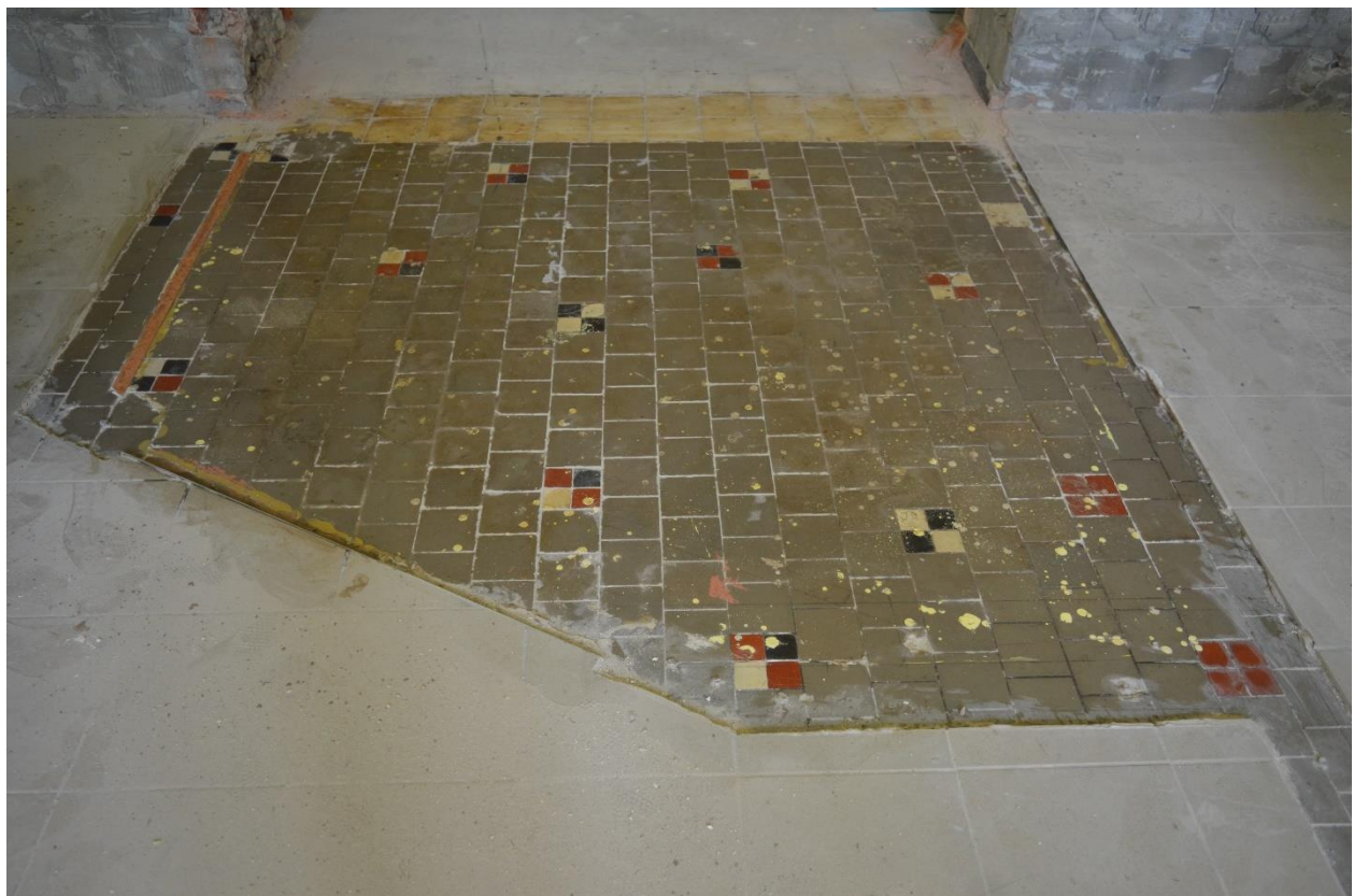
Fot. 32 Odkryta oryginalna, przedwojenna posadzka w dawnym pomieszczeniu małej kuchni. (fot. K.J.)
