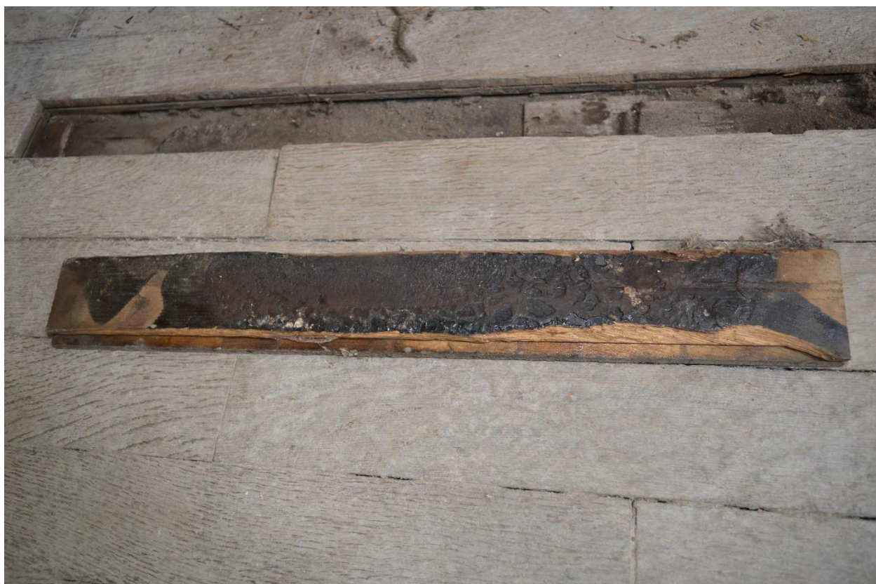
Fot. 45 Dębowy element parkietu ułożony na wylewce z białego cementu pokryty od spodu masą bitumiczną.
