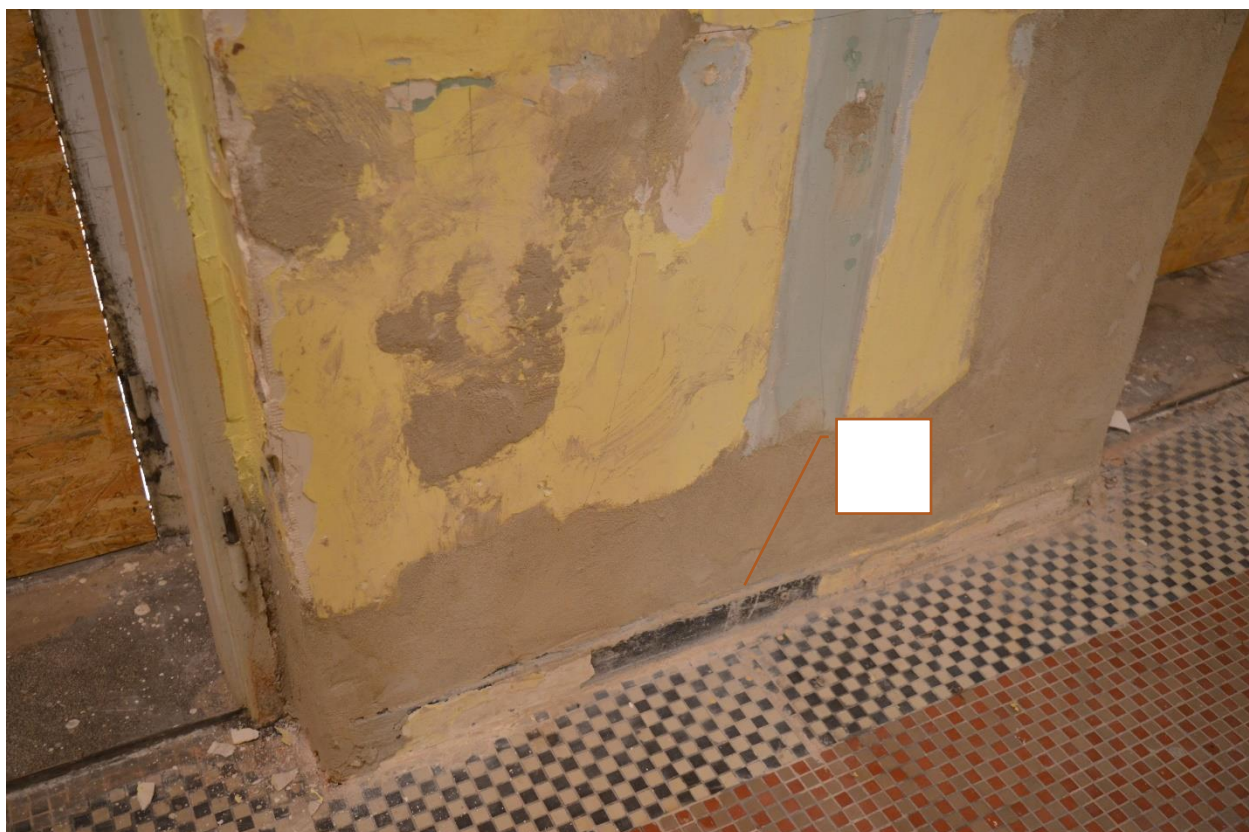
Fot. 61 Wskazane miejsce wykonania odkrywki schodkowej na listwie przypodłogowej. (fot. K.J.)
