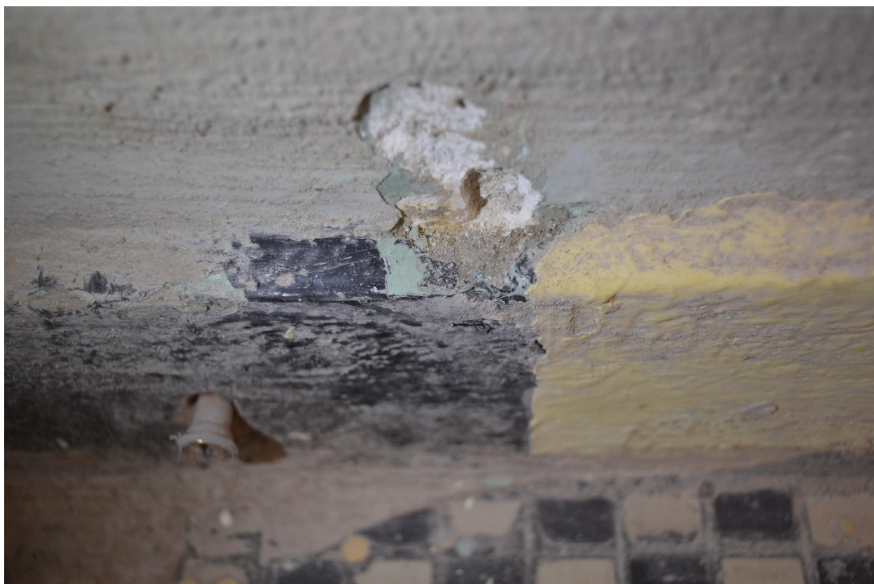
Fot. 22 Fragment uformowanej w zaprawie listwy przypodłogowej oraz posadzki. (fot. K.J.).
