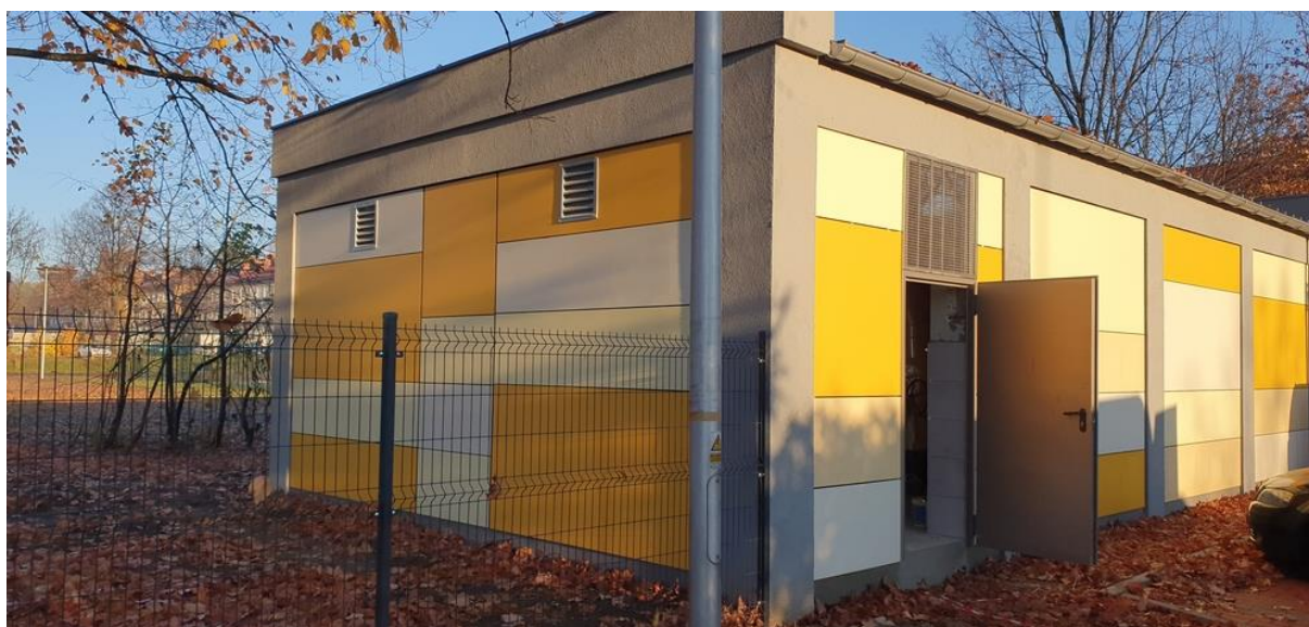
Zdj. Budynek Przepompowni
