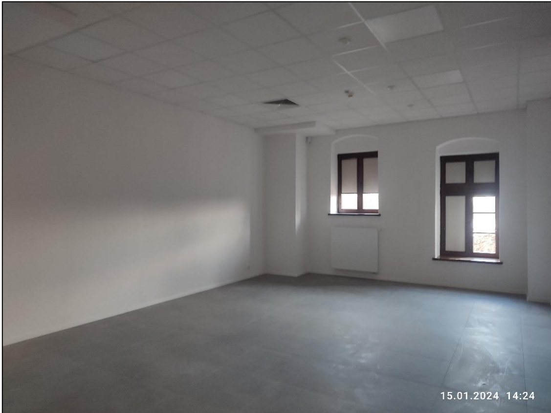
Widok wnętrza pomieszczenia D0.08 (Archiwum budowlane dokumentacji technicznej i naukowej)
