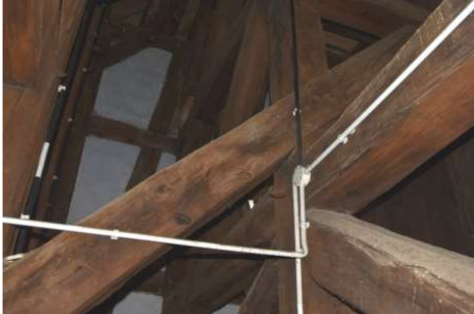
Fot. 129. Układ ramowy w osi 5-5: zastrzał o wymiarach 21x22 cm; na odcinku A-E z pęknięciami wzdłuż włókien; na powierzchni ciemne zacieki;
