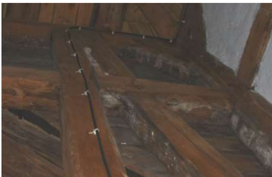
Fot. 68. Układ ściany w osi A-A: na odcinku 7-9 zacieki; korozja biologiczna drewna;
