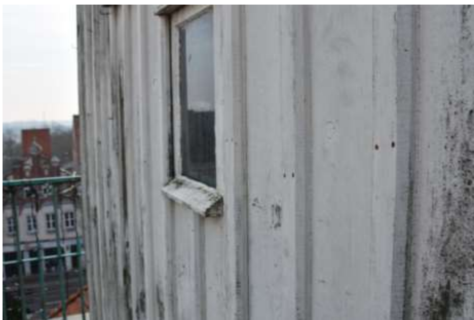
Fot. 289. Fragment elewacji: deski poszycia na pióro i wpust z listewkami na połączeniach; drewno malowane; skorodowane; złuszczenia warstw malarskich;
