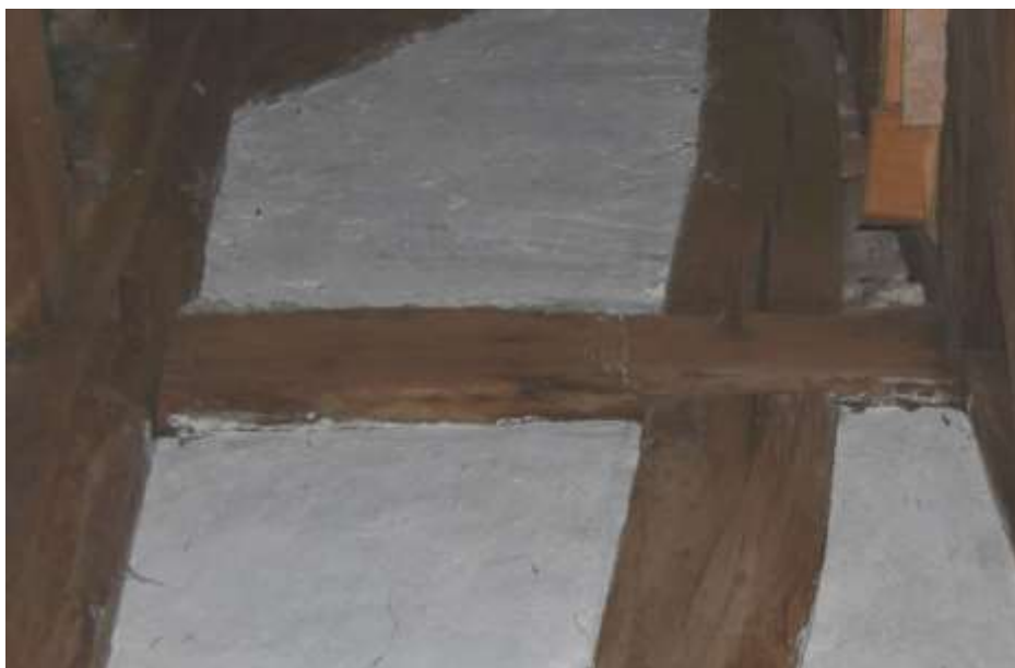
Fot. 80. Układ ściany w osi 9-9: rygle III poziomu o wymiarach 22x21cm; na powierzchni drewna zacieki;
