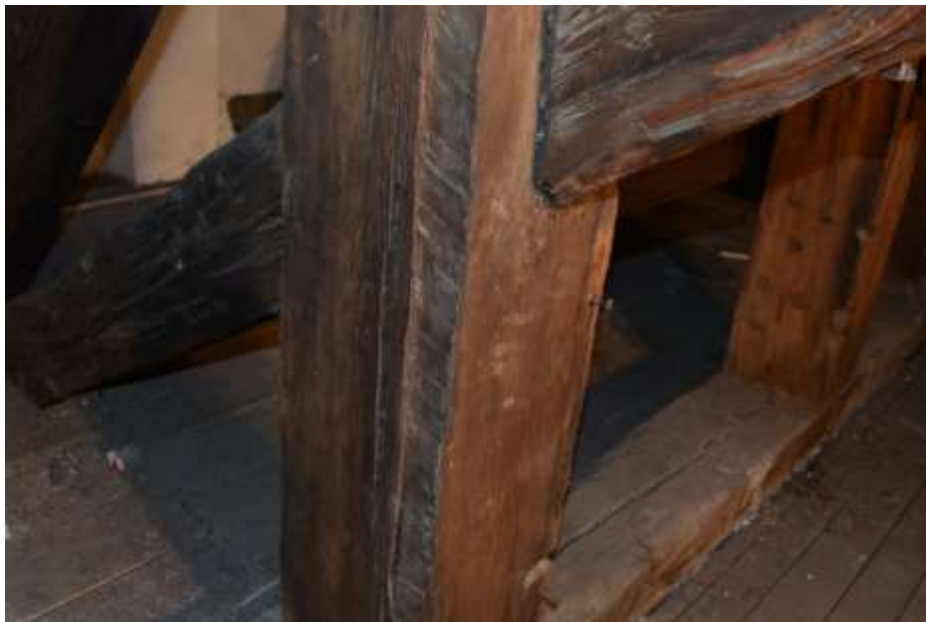
Fot. 5. Słup wieży: słup drewniany o wymiarach 25x23 cm; z pęknięciami wzdłuż włókien; ślady obróbki drewna toporem;
