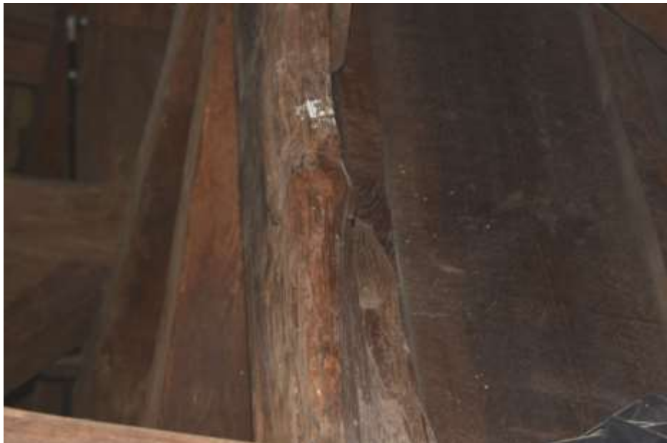
Fot. 36. Słup wieży: słup drewniany o wymiarach 22x22 cm; zachowany do wysokości II poziomy rygli; powyżej zachowany szczątkowo;
