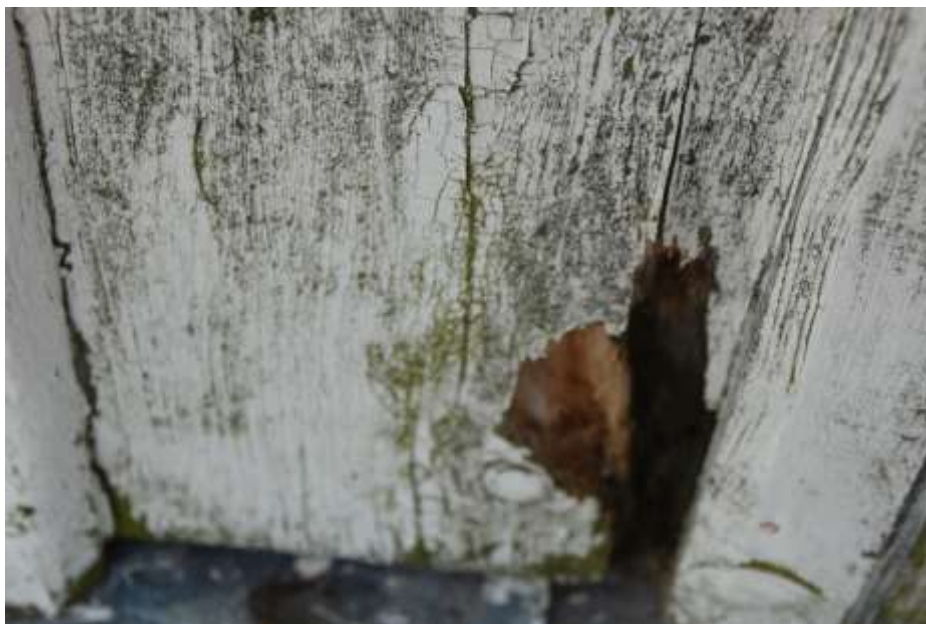
Fot. 291. Fragment elewacji: w narożniku wschodnim deska skorodowana; ubytek struktury w dolnej części;
