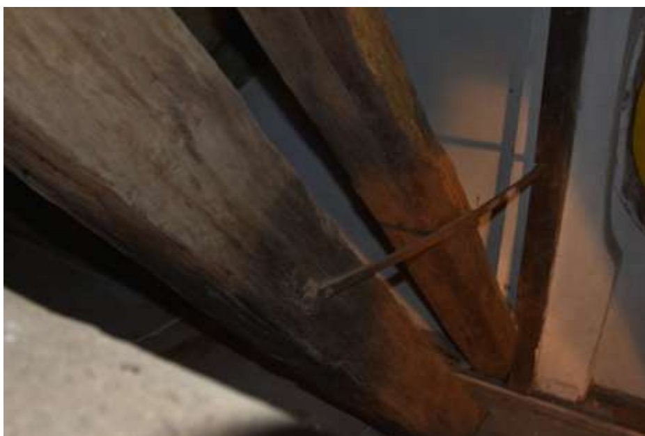
Fot. 102. Układ ramowy w osi G-G: zastrzały spięte ze słupkiem drewnianym przy ścianie frontowej budynku płaskownikami o wymiarach 25x10 mm;
