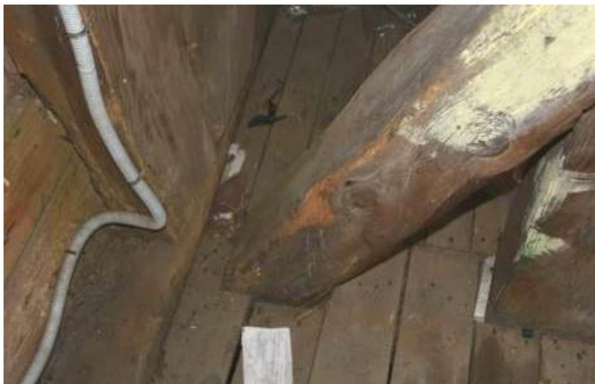
Fot. 53. Trzebiatów, ratusz, wieża zegarowa. Stan zachowania konstrukcji wieży jest zły. Występują liczne ogniska korozji biologicznej.
