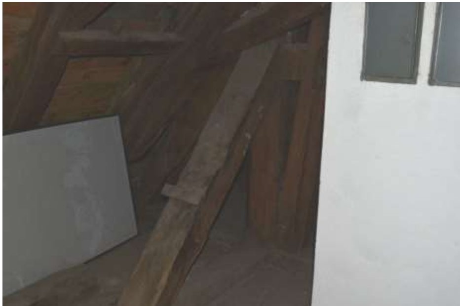
Fot. 72. Układ ściany w osi 9-9: przy słupie 9/A zastrzał o wymiarach 20x23 cm;
