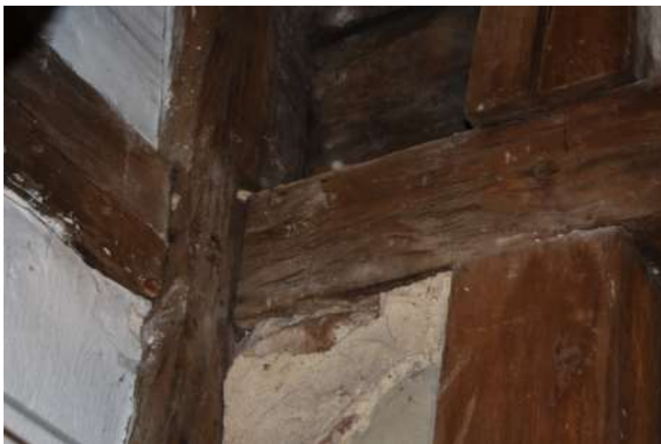
Fot. 64. Układ ściany w osi A-A: rygle II poziomu o wymiarach 22x21cm; na połączeniu ze słupem 1/A brak warstwy zewnętrznej drewna;
