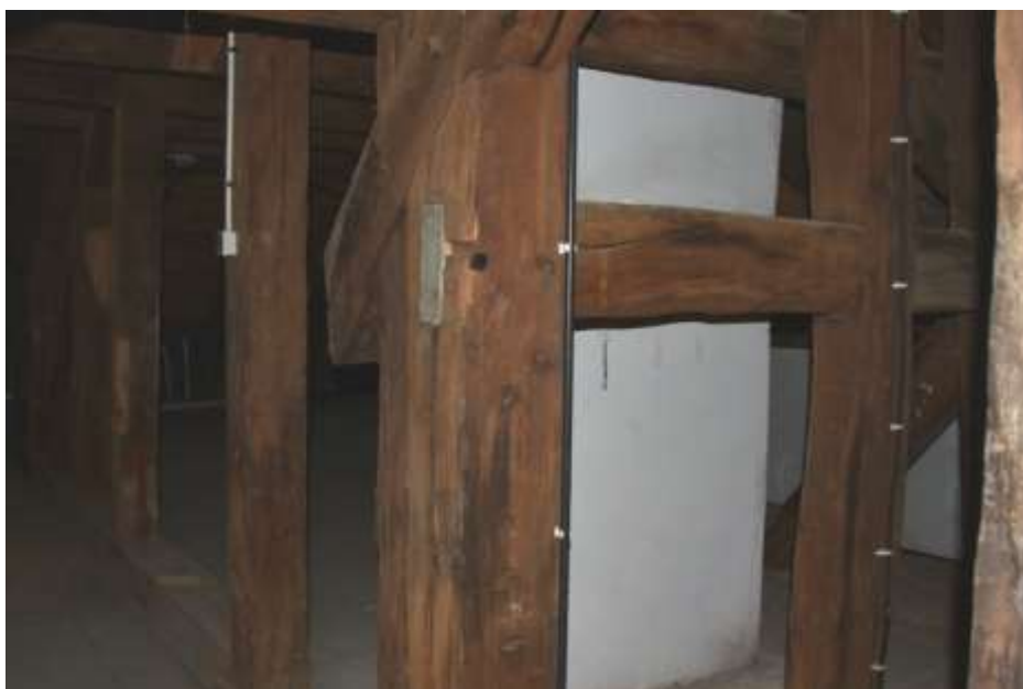
Fot. 15. Słup wieży: słup drewniany o wymiarach 24x24 cm; - słup w dolnej części rozłupany; szczelina do 3 cm;
