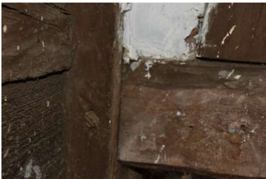
Fot. 51. Układ ściany w osi 1-1: połączenia ze słupami i zastrzałami na gniazdo i czop; kołkowane;
