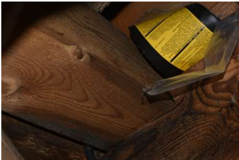
Fot. 271. Fragment stropu: belka przy osi D-D w kierunku środkowym o wymiarach 17x20; na powierzchni zacieki;
