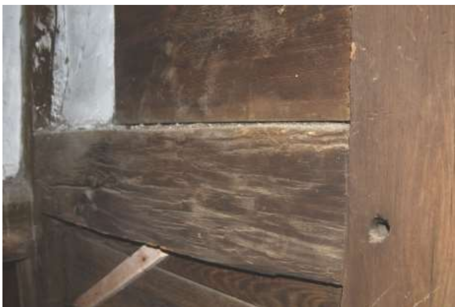
Fot. 96. Układ ściany w osi I-I: na odcinku 7-9 brak poziomu; rygiel ze spadkiem w kierunku słupa 9/I;
