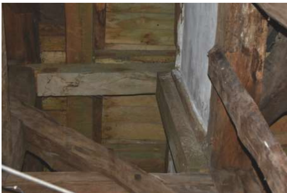
Fot. 253. Fragment stropu: belka w osi H-H na odcinku G-I w osi 5-5 belka podparta nowym rygłem;
