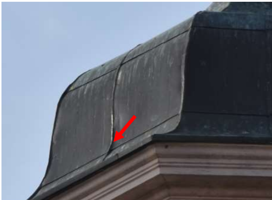
Fot. 300. Fragment elewacji: arkusze blachy poluzowane na połączeniach;
