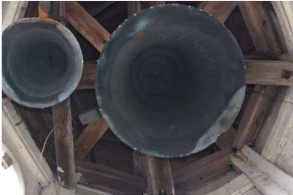
Fot. 239. Fragment latarni: w poziomie podstawy hełmu konstrukcja dzwonów; belki ułożone promieniście od słupów; drewno nie malowane;
