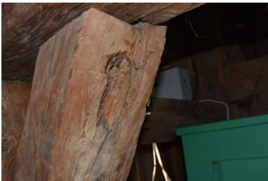
Fot. 179. Układ ramowy w osi D-D: drewno zastrzałów lokalnie skorodowane; ubytek struktury drewna;
