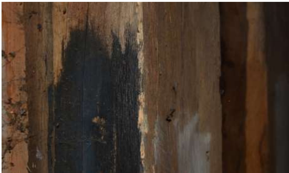
Fot. 146. Słup wieży: drewniany o wymiarach 25x17 cm; od strony deskowania nakładka grubości 3cm; silnie porażona biologicznie; na powierzchni słupa ciemne zabrudzenia;
