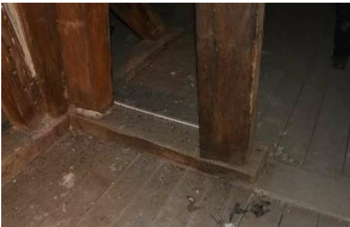
Fot. 45. Trzebiatów, ratusz, wieża zegarowa. Stan zachowania konstrukcji wieży jest zły. Występują liczne braki elementów konstrukcyjnych.
