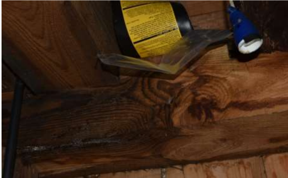
Fot. 169. Ściana w osi 8-8: oczep w poziomie VIII wymieniony sztuką nowego drewna; silnie zawilgocony; wysolenia na powierzchni;
