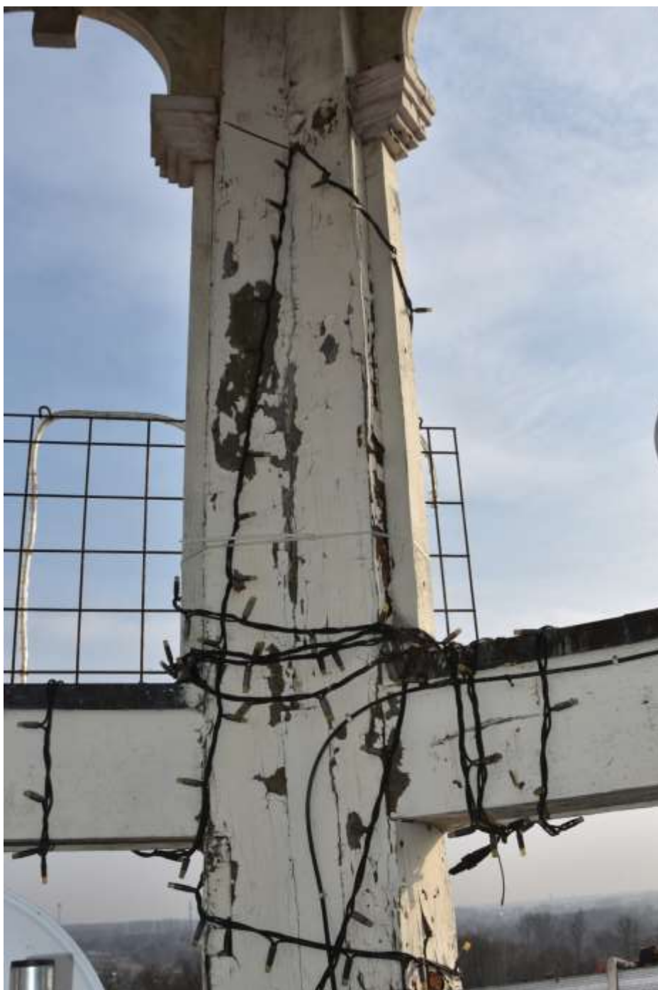
Fot. 228. Słup wieży: powyżej słup latarni malowany; złuszczenia warstw malarskich; na powierzchniach bocznych słupa warstwa ze sklejki gr. 2 mm;
