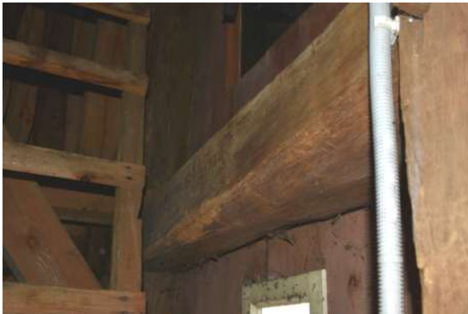
Fot. 171. Ściana w osi H-H: rygle w poziomie VI z zaciekami; od strony deskowania nakładka grubości 3 cm porażona biologicznie; silnie zawilgocony nad otworem okiennym;
