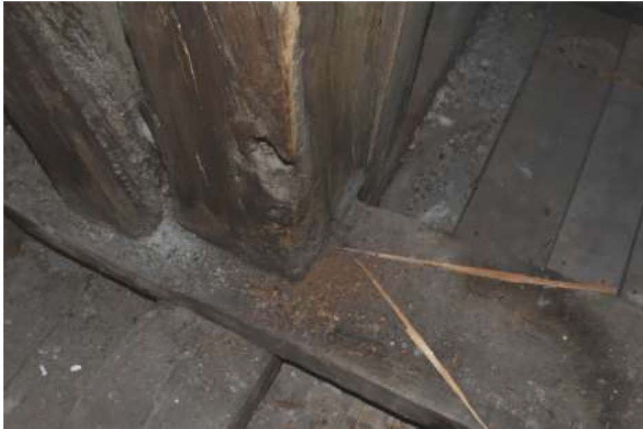
Fot. 27. Słup wieży: na połączeniu z podwaliną drewno skorodowane;
