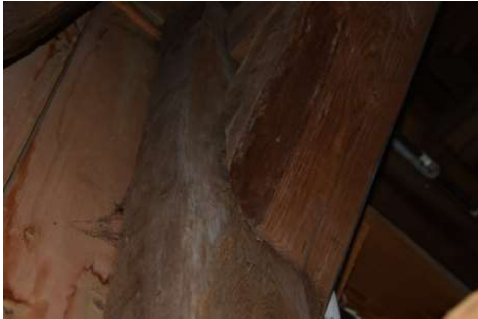
Fot. 147. Słup wieży: drewniany o wymiarach 25x17 cm; od strony deskowania nakładka grubości 3cm; silnie porażona biologicznie;
