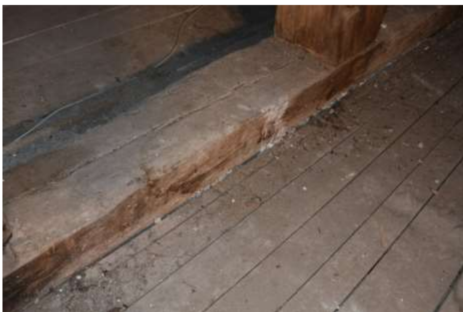
Fot. 42. Układ ściany w osi 1-1: drewno z zaciekami;
