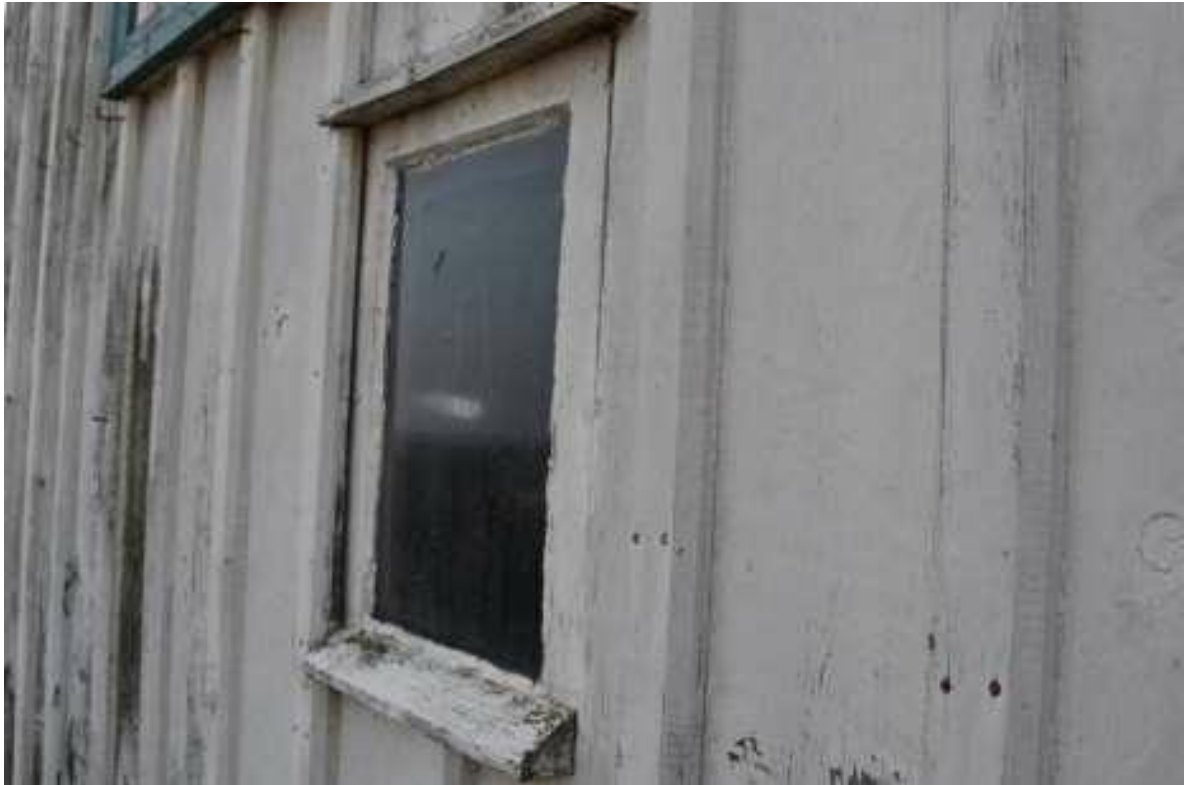
Fot. 40. Trzebiatów, ratusz, wieża zegarowa. Stolarka okienna zachowana jest pośledniej jakości zachowana w złym stanie.
