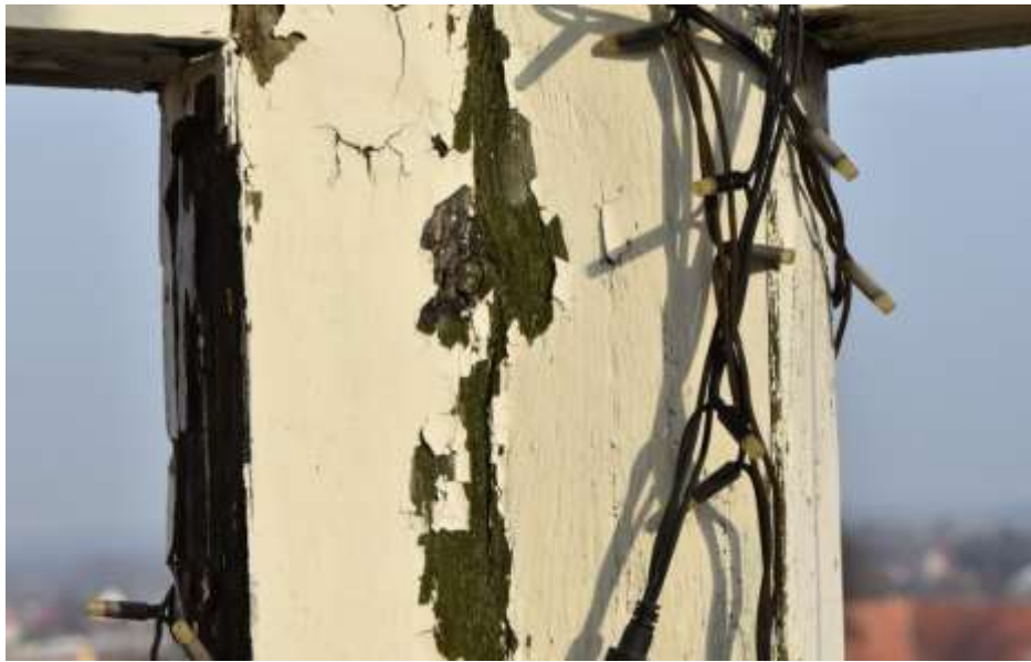
Fot. 221. Słup wieży: złuszczenia warstw malarskich; powierzchniowa korozja drewna; na powierzchni wegetacja glonów; korozja sklejki;
