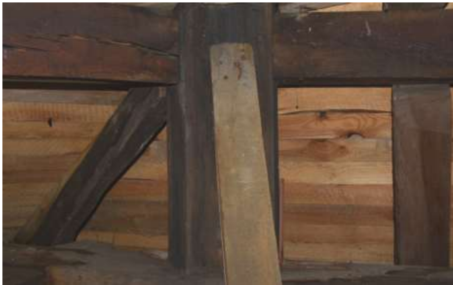
Fot. 216. Słup wieży: w przestrzeni pod zadaszeniem części zegarowej wieży słup zawilgocony; kotwiony do belki stropu dwoma kątownikami stalowymi; słup podparty nowym zastrzałem;
