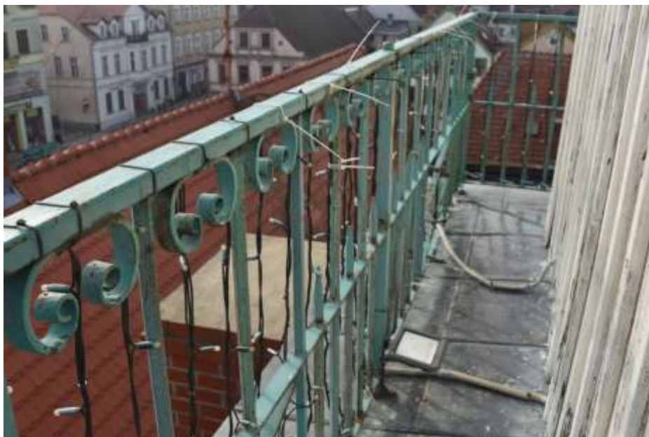
Fot. 305. Fragment elewacji: galeria zewnętrzna wieży zabezpieczona balustradą stalową;
