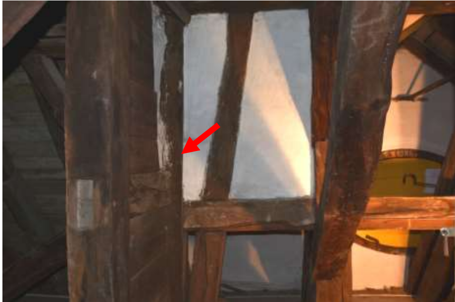
Fot. 1. Słup wieży: słup narożny; drewniany o wymiarach 26x27 cm; na powierzchni drewna ślady zacieków;
