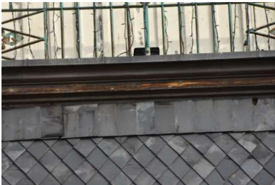
Fot. 318. Fragment elewacji: dolna część wieży zwieńczona profilowanym wysuniętym gzymsem drewnianym; drewno malowane; farby wypłukane;
