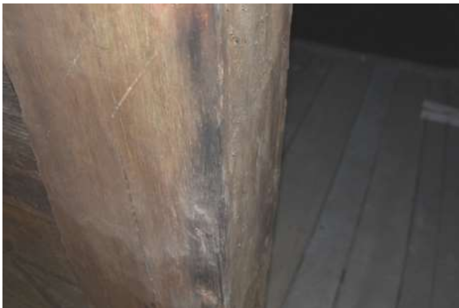
Fot. 30. Słup wieży: słup drewniany o wymiarach 25x22 cm; na powierzchni ciemne naloty;
