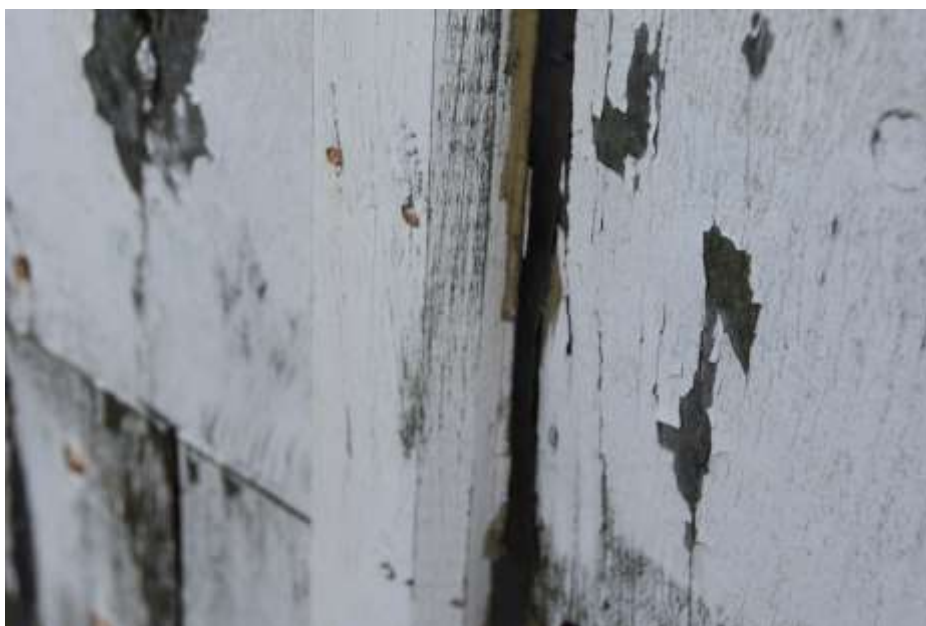
Fot. 345. Fragment elewacji: próby uszczelniania między listwą a deską poszycia;
