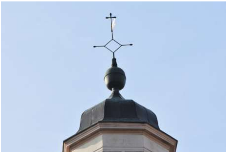
Fot. 299. Fragment elewacji: - gzyms wieńczący profilowany; drewniany; drewno malowane; latarnia przykryta ozdobnym hełmem; pokrycie z blachy miedzianej;
