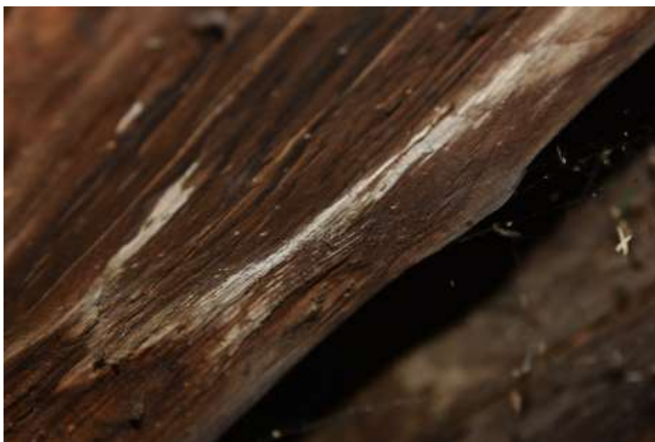
Fot. 245. Fragment stropu: drewno belki porażone biologicznie; warstwa zewnętrzna zbutwiała;
