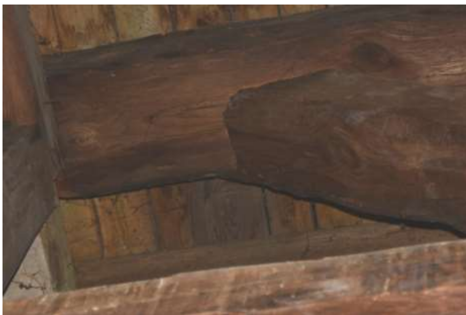
Fot. 251. Fragment stropu: belka w osi G-G z zaciekami; podparta zastrzałami;
