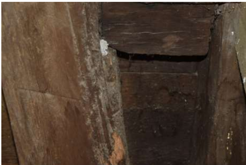
Fot. 89. Układ ściany w osi I-I: w dolnej części drewno skorodowane;
