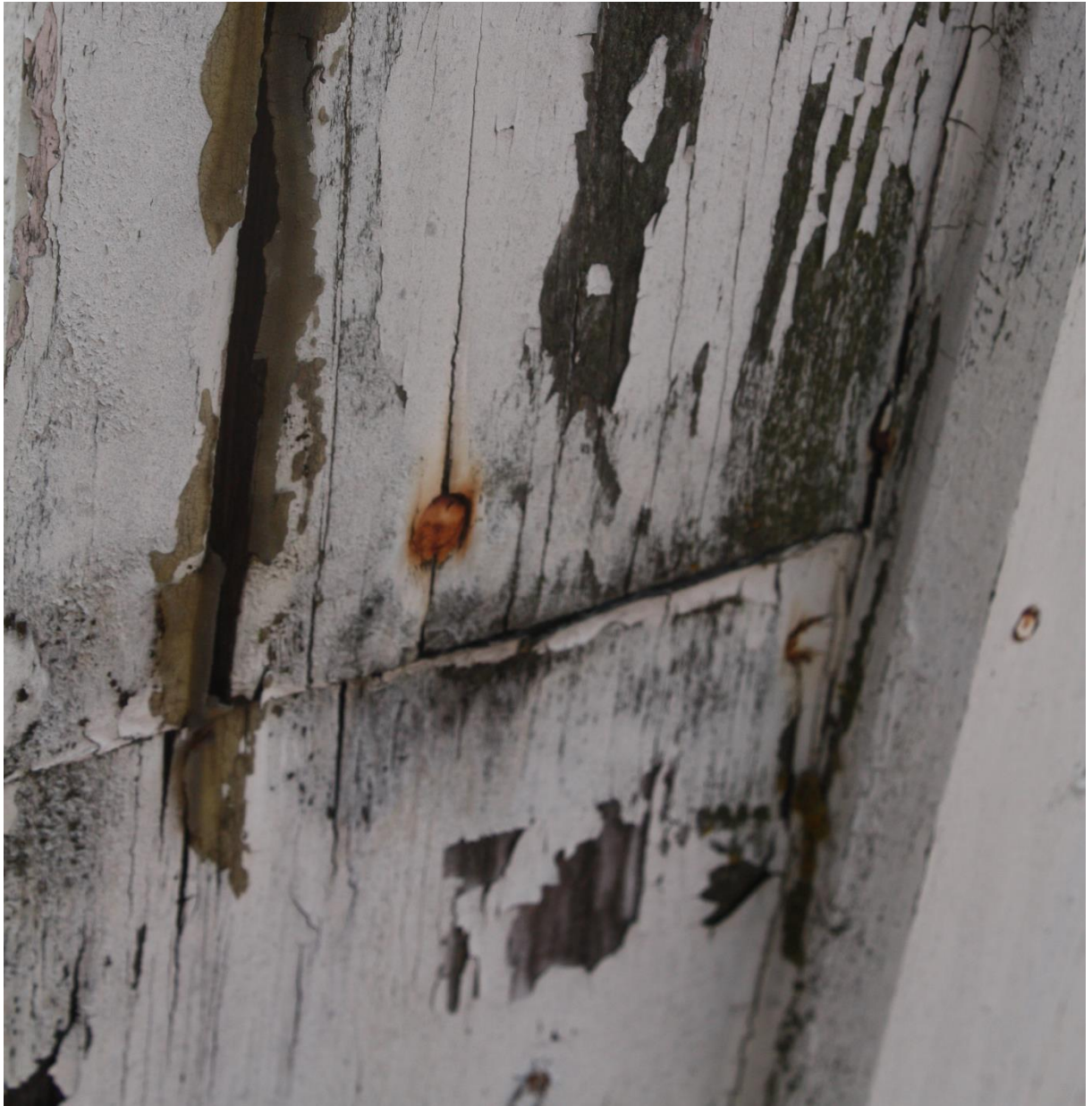
Fot. 33. Trzebiatów, ratusz, wieża zegarowa. Widok na latarnię wieży. Stan zachowania desekondygnacji środkowej. Farba się łuszczy, odsłonięte drewno jest pociemniałe w wyniku działania wilgoci. Powierzchnię elewacji pokrywają nawarstwienia organiczne.
