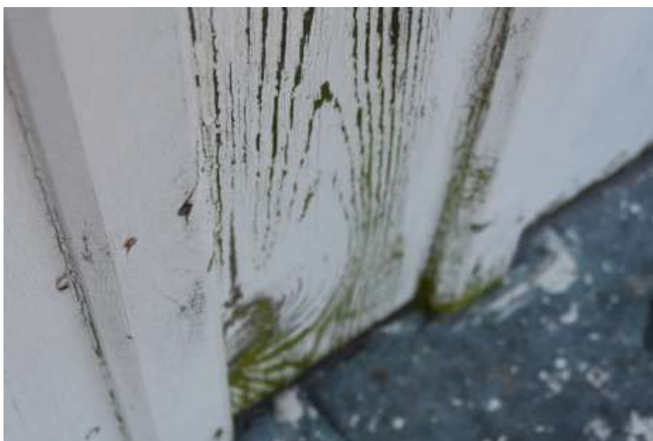
Fot. 290. Fragment elewacji: w dolnej części na poszyciu wegetacja glonów;
