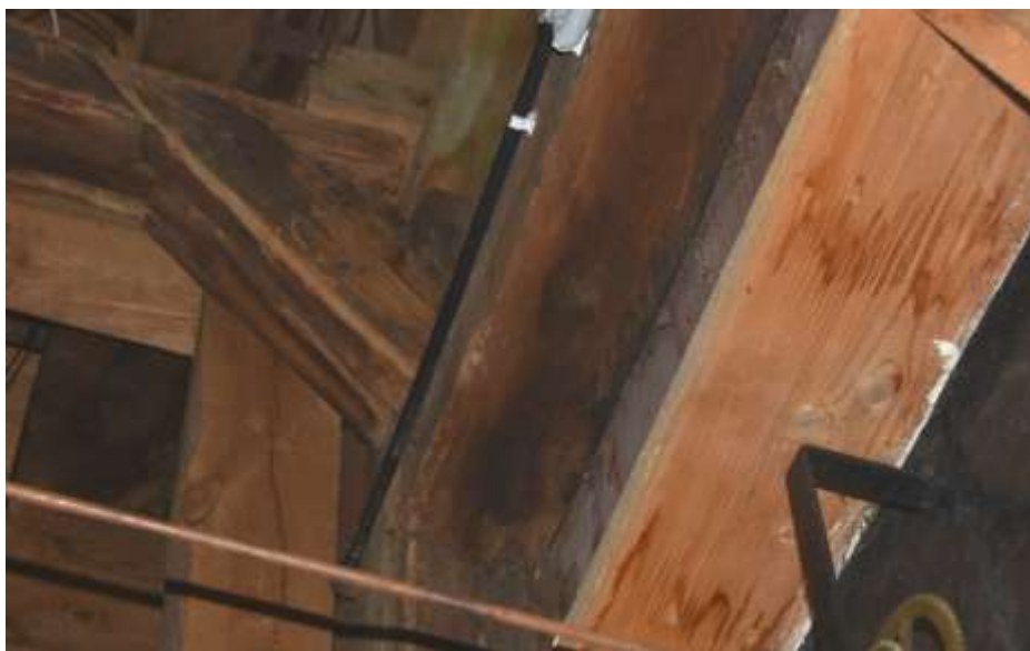
Fot. 172. Ściana w osi H-H: rygle w poziomie VII z zaciekami; od strony deskowania nakładka grubości 3 cm porażona biologicznie; na powierzchni drewna zacieki;
