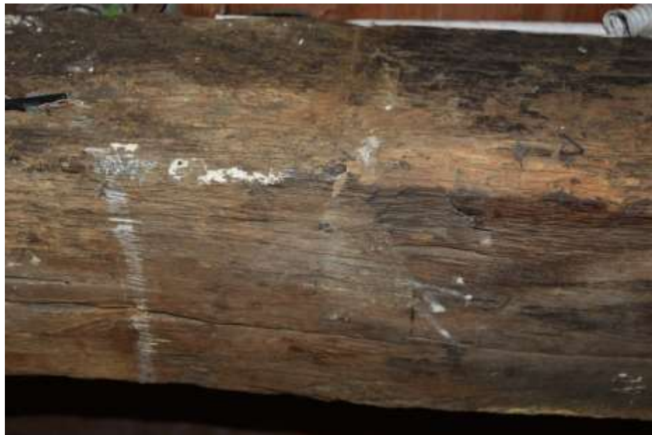
Fot. 162. Ściana w osi B-B: rygle w poziomie V o wymiarach 23x16 cm od strony deskowania nakładka grubości 3 cm porażona biologicznie; drewno zawilgocone;
