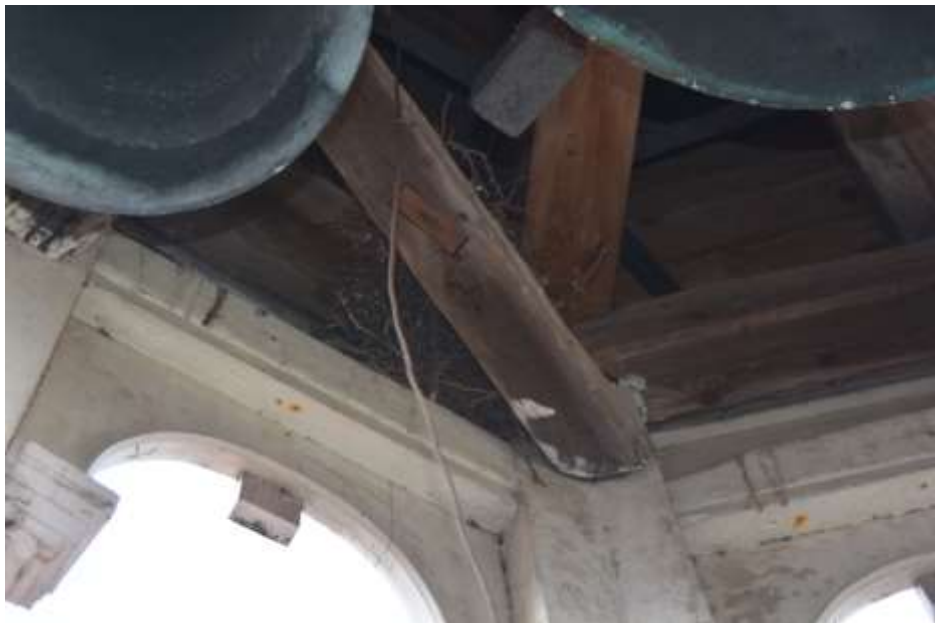
Fot. 240. Fragment latarni: na konstrukcji gniazdo ptaków;
