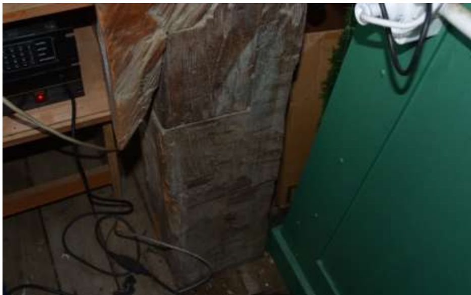
Fot. 154. Słup wieży: słup drewniany o wymiarach 18 x 19 cm; dolny fragment słupa wymieniony;
