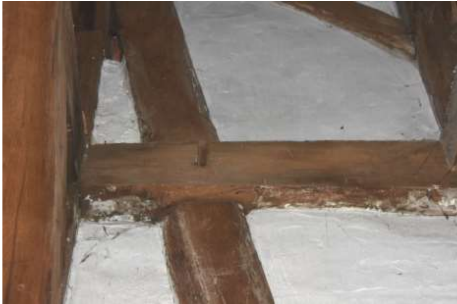
Fot. 55. Układ ściany w osi 1-1: rygle III poziomu o wymiarach 20x20cm; na powierzchni drewna zacieki;
