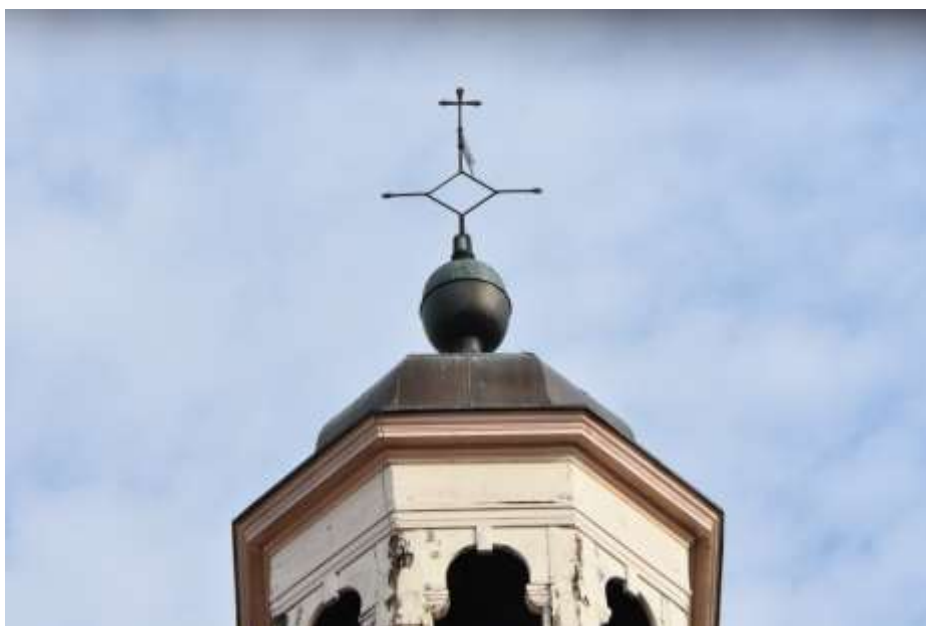
Fot. 337. Fragment elewacji: gzyms wieńczący profilowany; drewniany; drewno malowane; latarnia przykryta ozdobnym hełmem; pokrycie z blachy miedzianej;
