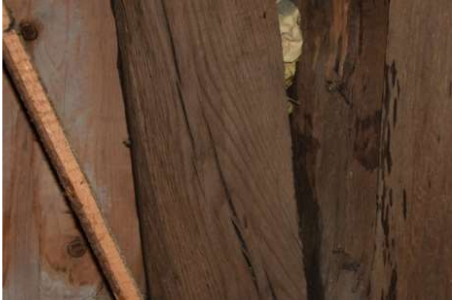
Fot. 157. Ściana w osi 2-2: zastrzał przy osi B-B o wymiarach 18x17 cm; od strony zewnętrznej porażony biologicznie; drewno z pęknięciami wzdłuż włókien;
