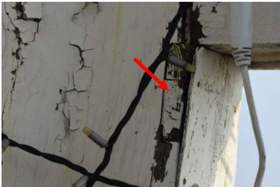
Fot. 225. Słup wieży: pod rygłem drewno słupa flekowane; sklejka odspojona;
