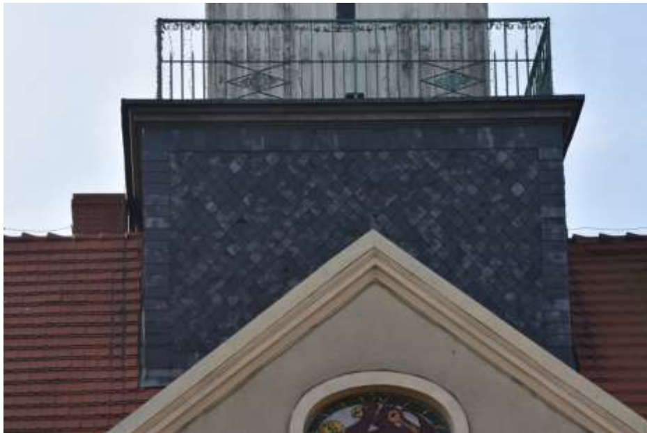
Fot. 283. Fragment elewacji: dolna część wieży z okładziną z łupka;
