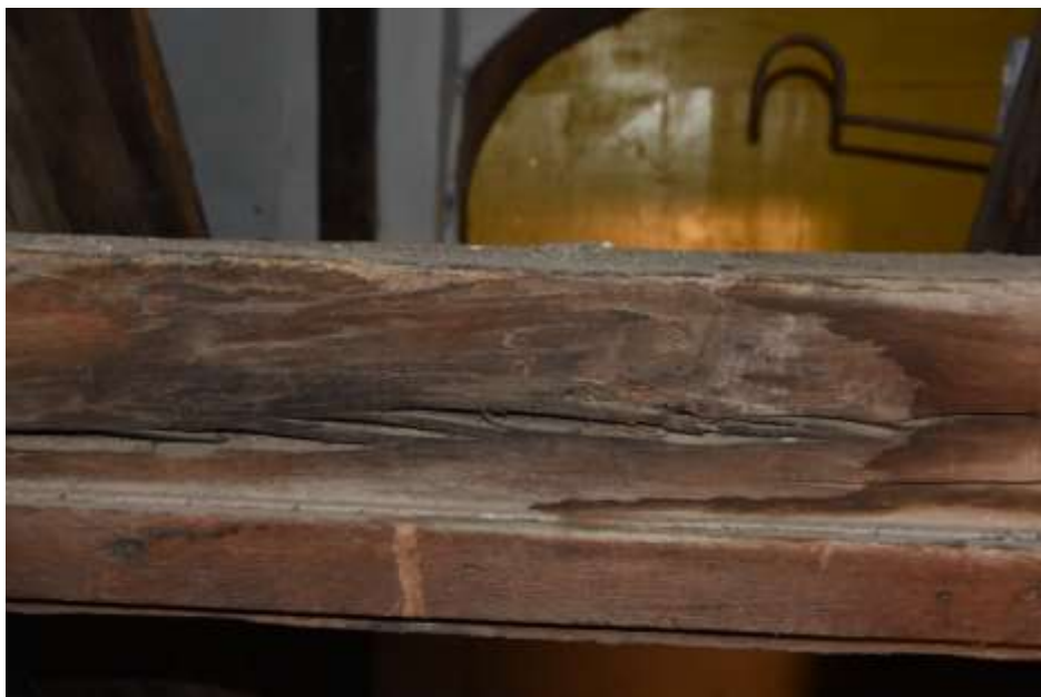
Fot. 50. Układ ściany w osi 1-1: drewno z pęknięciami wzdłuż włókien; - połączenia ze słupami i zastrzałami na gniazdo i czop; kołkowane;
