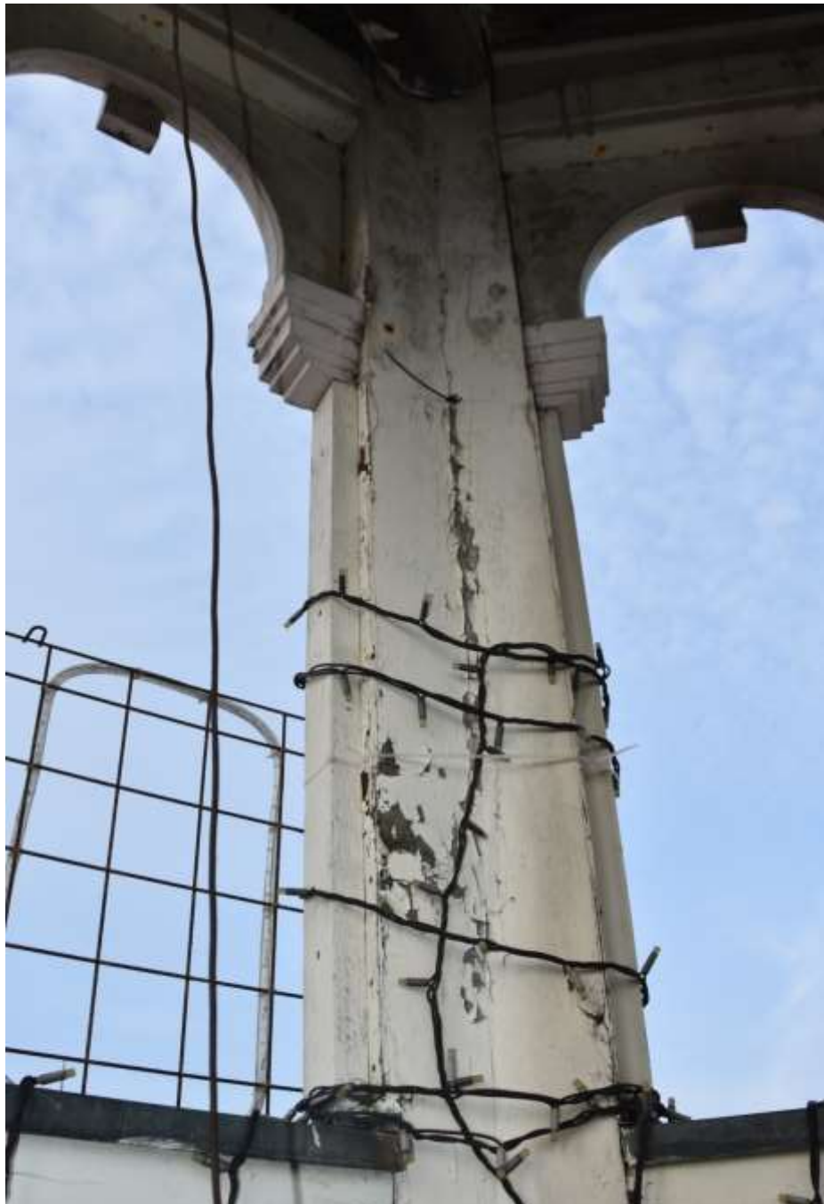
Fot. 214. Słup wieży: powyżej słup latarni malowany; złuszczenia warstw malarskich; na powierzchniach bocznych słupa warstwa ze sklejk gr. 2 mm;
