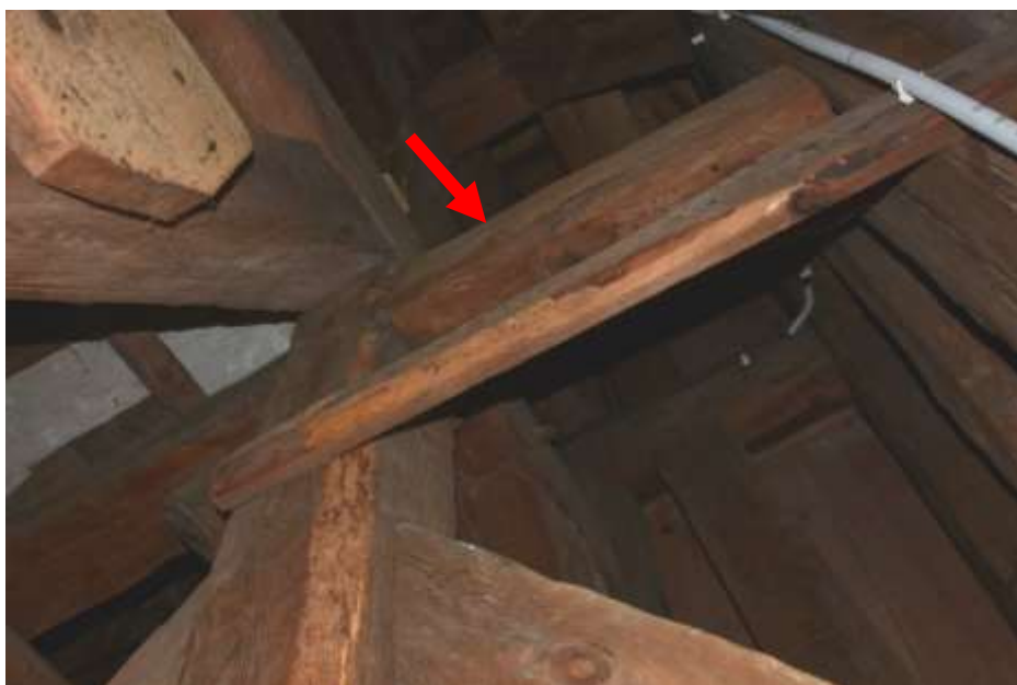
Fot. 202. Układ ramowy w osi 4-4: rygiel w poziomie VII porażony przez owady techniczne szkodniki drewna;
