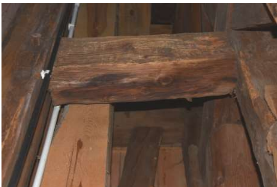
Fot. 191. Układ ramowy w osi 6-6: rygiel w poziomie VII zdeformowany na odcinku B-D;
