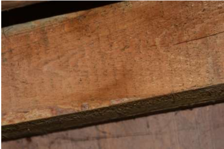
Fot. 173. Ściana w osi H-H: oczep na poziomie VIII wymieniony sztuką nowego drewna;
