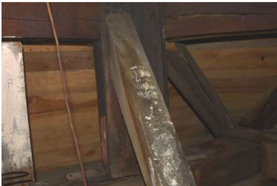
Fot. 213. Słup wieży: w przestrzeni pod zadaszeniem części zegarowej wieży słup zawilgocony; kotwiony do belki stropu dwoma kątownikami stalowymi; słup podparty zastrzałem; zastrzał porażony biologicznie;
