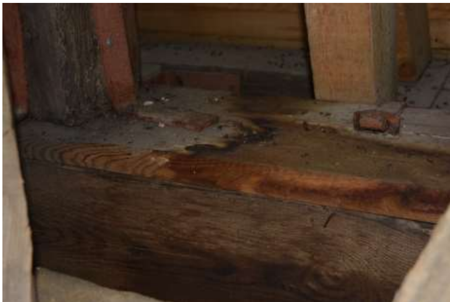
Fot. 265. Fragment stropu: nad belkę w osi C'-C' kolejna belka o wymiarach 27x24 cm; od góry nakładka grubości 4 cm; drewno silnie zawilgocone;
