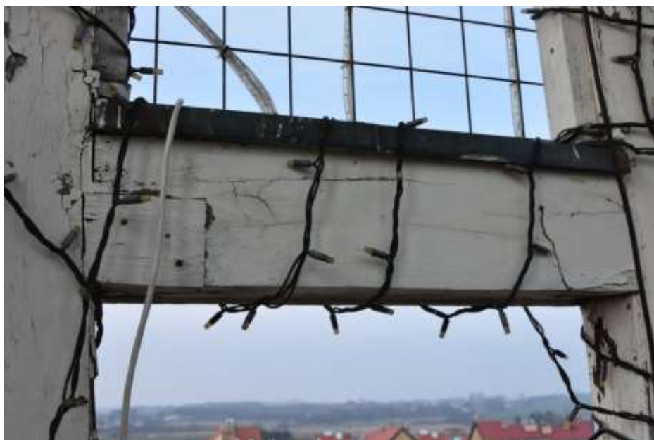
Fot. 237. Fragment latarni: w dolnej części rygle; drewno malowane; od góry obróbka z blachy miedzianej; lokalnie flekowane;
