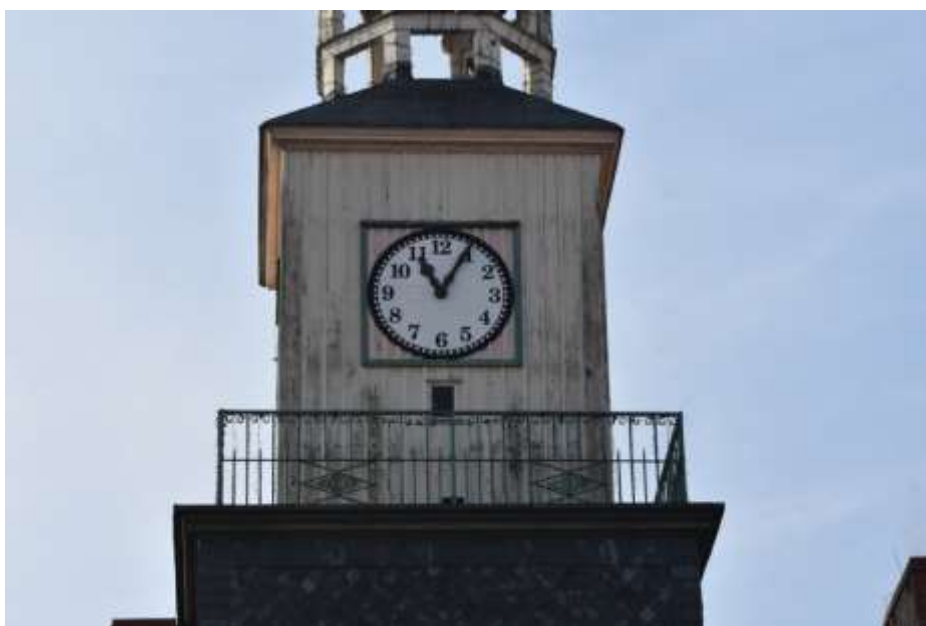
Fot. 286. Fragment elewacji: część środkowa wieży z poszyciem z desek; w osi ściany tarcza zegarowa;
