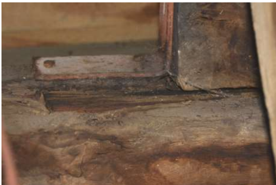
Fot. 262. Fragment stropu: nad belką F'-F' dodatkowa belka o wymiarach 26x16 cm; drewno silnie zawilgocone; w belce puste gniazdo;
