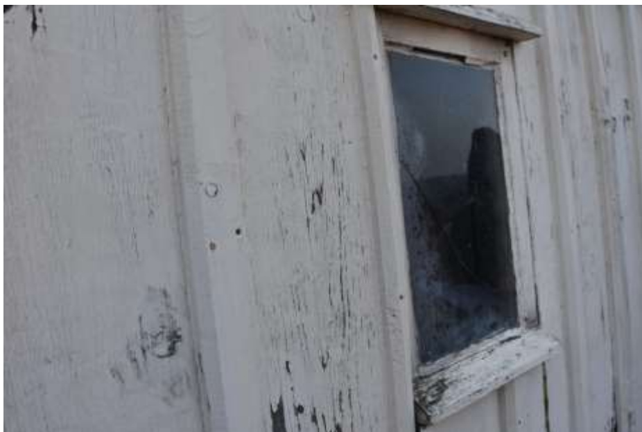
Fot. 347. Fragment elewacji: w ścianie niewielki otwór okienny; szklenie pojedyncze; szyba pęknięta; parapet porażony biologicznie; powłoki malarskie złuszczone;
