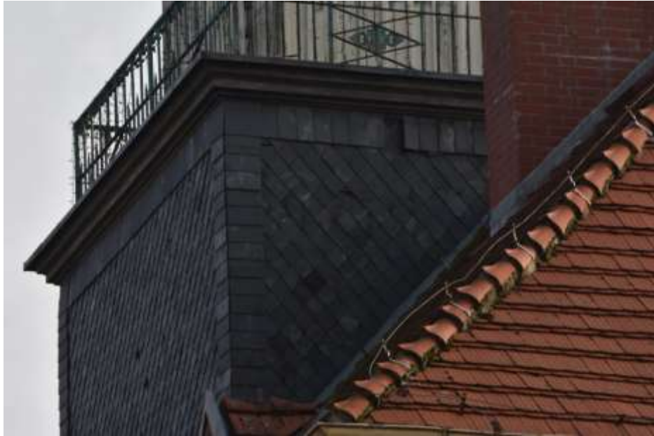
Fot. 339. Fragment elewacji: dolna część wieży z okładziną z łupka;
