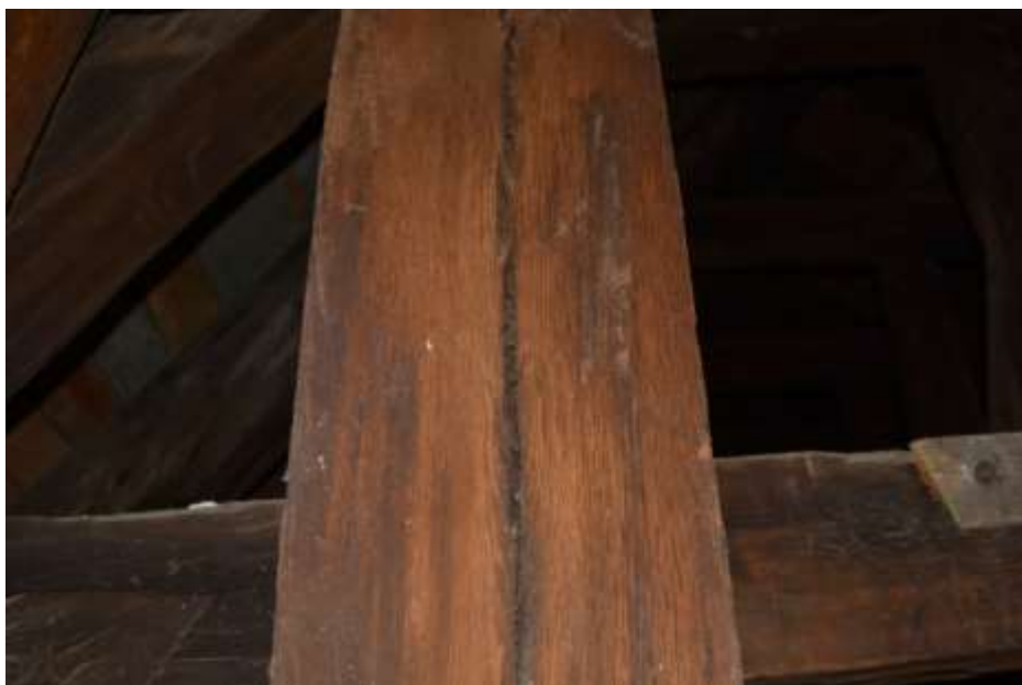
Fot. 12. Słup wieży: słup z pęknięciami wzdłuż włókien;
