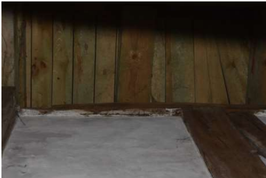
Fot. 100. Układ ściany w osi I-I: oczep w poziomie IV o wymiarach 22x20 cm; na powierzchni drewna zacieki;
