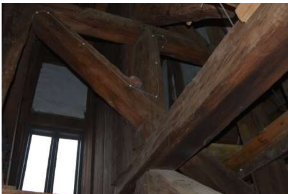
Fot. 132. Układ ramowy w osi 5-5: zastrzał dolny na odcinku E-I z pęknięciami wzdłuż włókien; na powierzchni ciemne zacieki;
