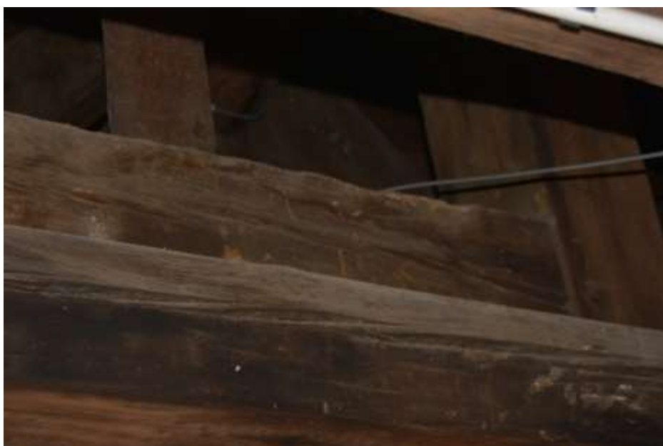
Fot. 98. Układ ściany w osi I-I: rygle II poziomu o wymiarach 23x20 cm; drewno z pęknięciami wzdłuż włókien;
