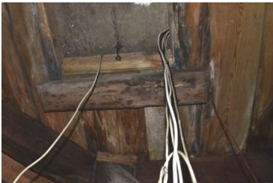
Fot. 274. Fragment stropu: przy wyłazie zacieki; drewno porażone biologicznie;
