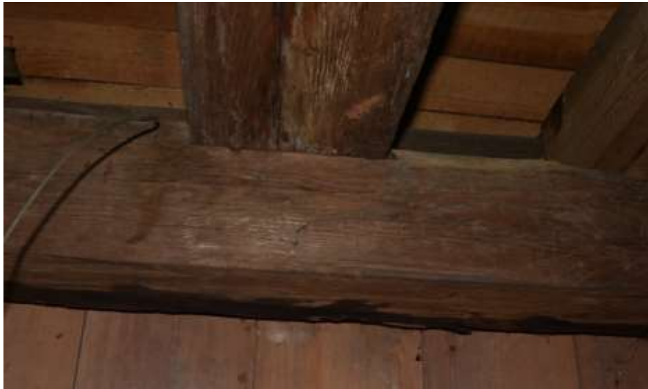
Fot. 161. Ściana w osi 2-2: oczep na poziomie VIII silnie zawilgocony od strony zewnętrznej;
