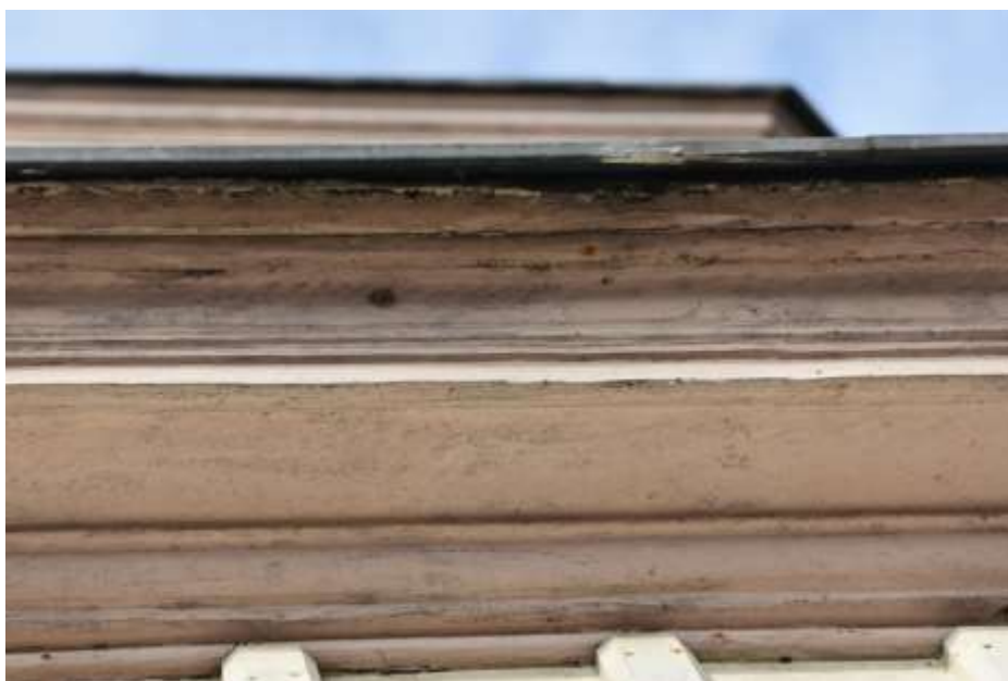
Fot. 312. Fragment elewacji: ściana zwieńczona wysuniętym profilowanym gzymsem drewnianym; na powierzchni ciemne naloty;
