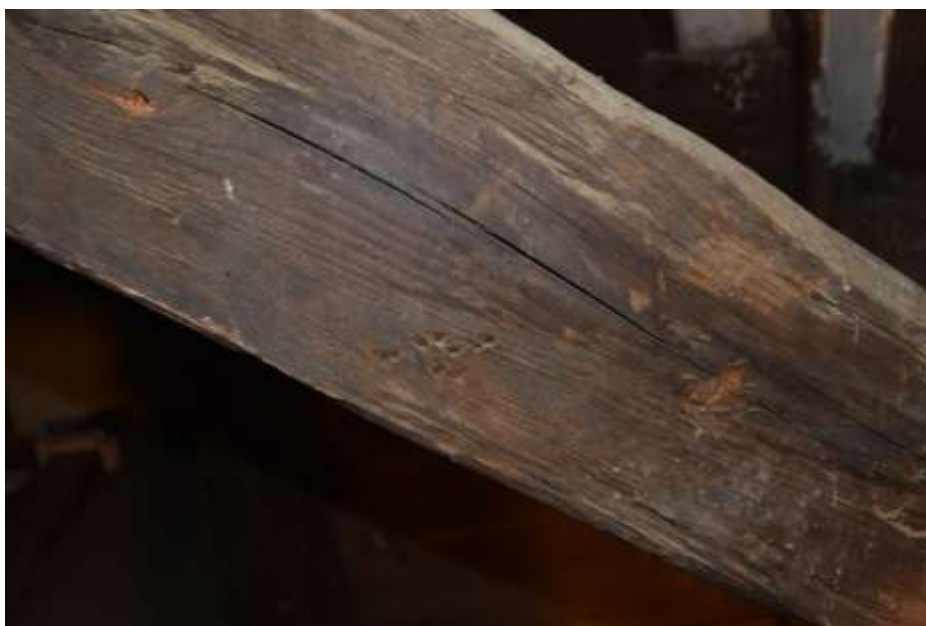
Fot. 104. Układ ramowy w osi G-G: powierzchniowa korozja drewna;
