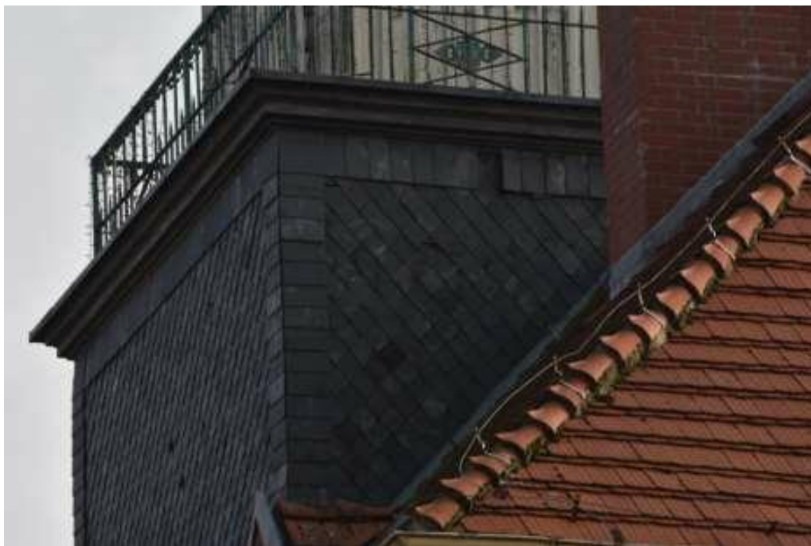
Fot. 36. Trzebiatów, ratusz, wieża zegarowa. Kondygnacja najniższa, kryta łupkiem posiada liczne uszkodzenia i ubytki pokrycia.
