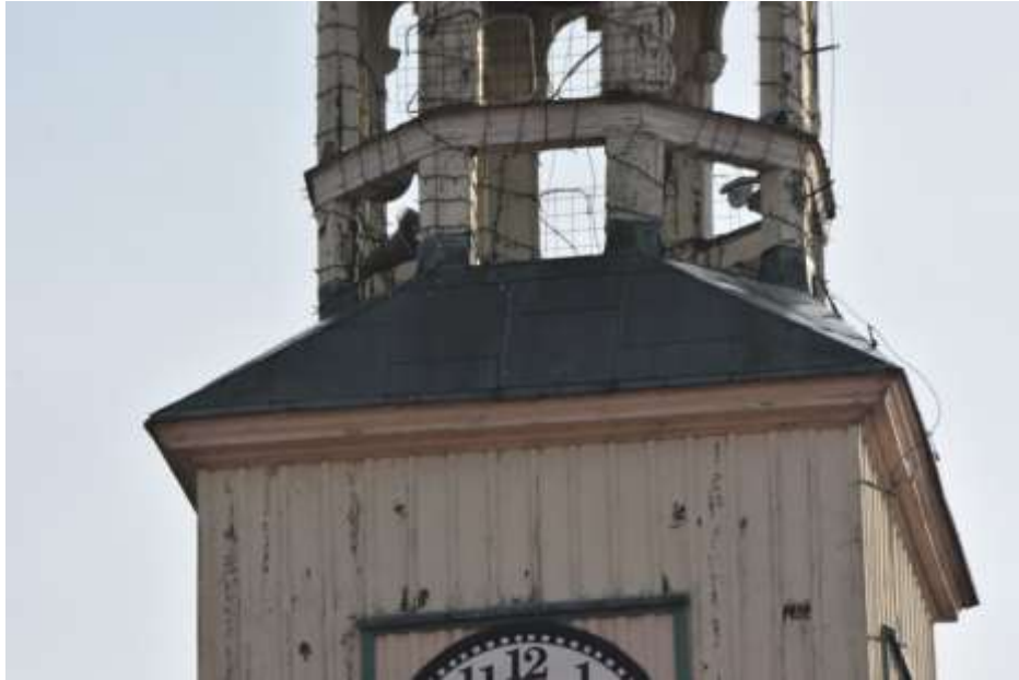
Fot. 351. Fragment elewacji: ściana zwieńczona wysuniętym profilowanym gzymsem drewnianym; powyżej daszek pokryty blachą miedzianą; blacha wywinięta na dolne odcinki słupów latarni;
