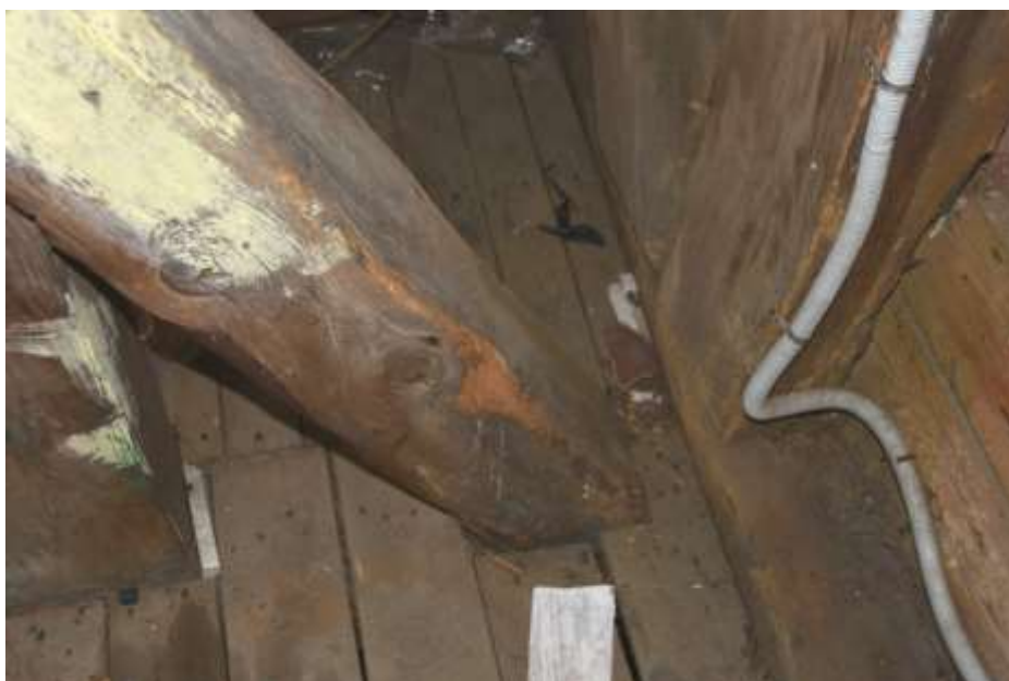
Fot. 188. Układ ramowy w osi F-F: zastrzał pomiędzy osiami 2-2 i 4-4 w dolnej części silnie skorodowany;
