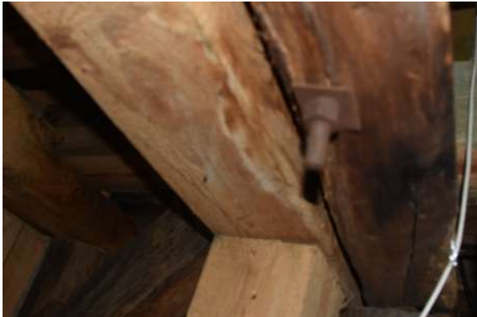
Fot. 196. Układ ramowy w osi 6-6: górny rygiel w poziomie VIII o wymiarach 17x20 cm;
