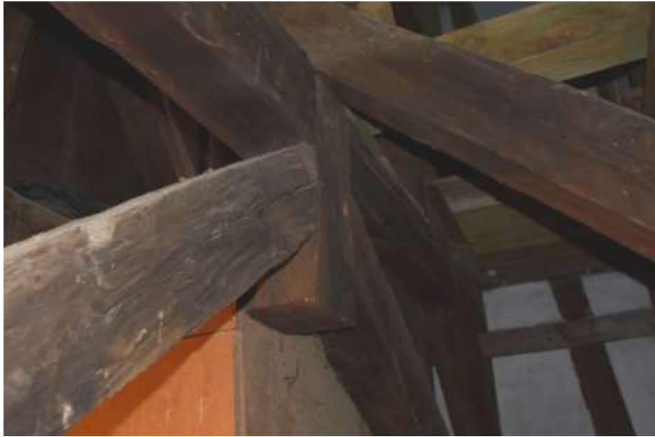
Fot. 35. Słup wieży: słup drewniany o wymiarach 23x21 cm; słup wycięty do poziomu zastrzałów;
