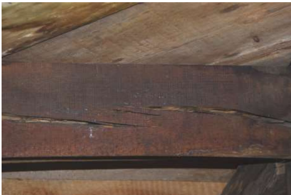
Fot. 272. Fragment stropu: strop oparty na słupach i belkach na planie ośmioboku; drewno belek z pęknięciami wzdłuż włókien
