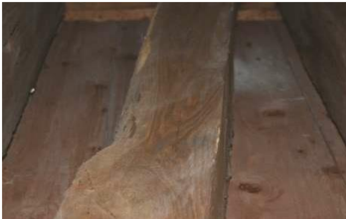
Fot. 50. Trzebiatów, ratusz, wieża zegarowa. Stan zachowania konstrukcji wieży jest zły. Występują liczne ogniska korozji biologicznej.
