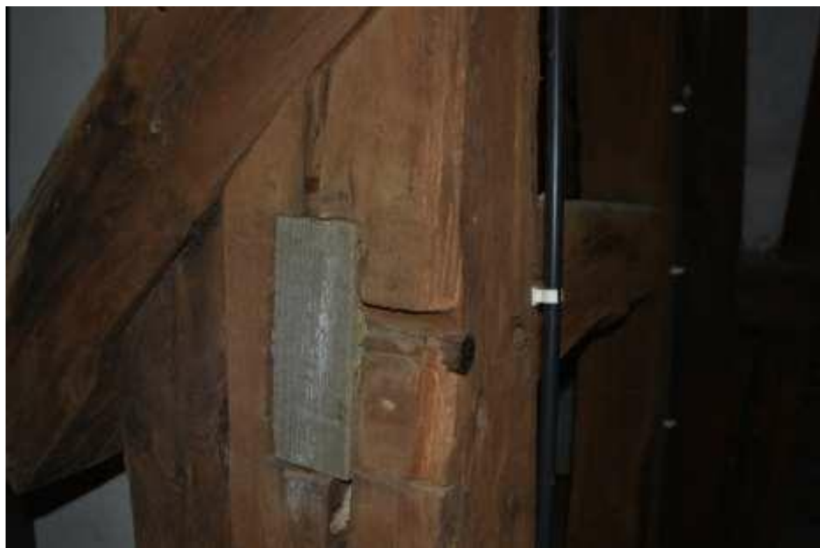
Fot. 43. Trzebiatów, ratusz, wieża zegarowa. Stan zachowania konstrukcji wieży jest zły. Występują liczne braki elementów konstrukcyjnych.
