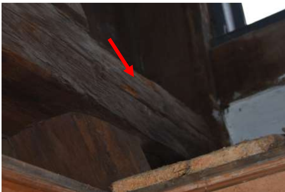
Fot. 120. Układ ramowy w osi E-E: przy osi 9-9 rygiel skorodowany;
