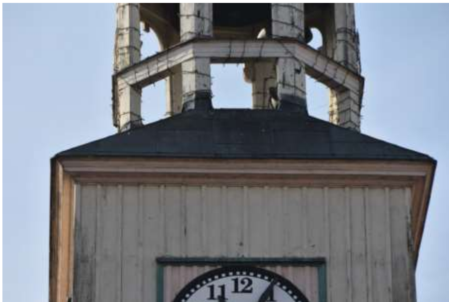
Fot. 297. Fragment elewacji: ściana zwieńczona wysuniętym profilowanym gzymsem drewnianym; powyżej daszek pokryty blachą miedzianą; blacha wywinięta na dolne odcinki słupów latarni;
