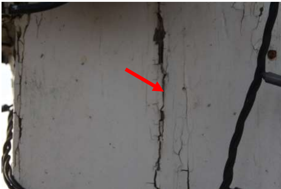
Fot. 235. Słup wieży: drewno słupa z pęknięciem w środkowej części przekroju;
