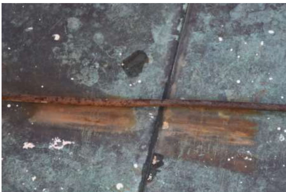
Fot. 258. Fragment stropu: pod instalacją odgromową rdzawe zacieki;
