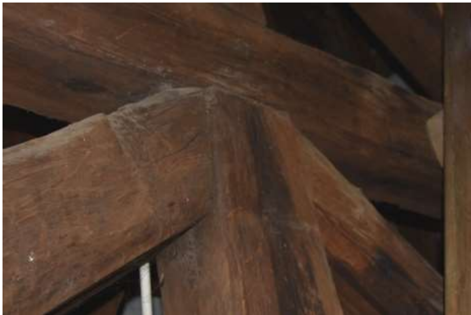
Fot. 38. Słup wieży: połączenia słupa z zastrzałami na gniazdo i wpust;
