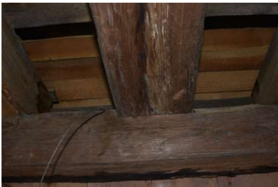
Fot. 269. Fragment stropu: przy osi E-E na odcinku 2-4 belka o wymiarach 25x21 cm; końcówka przy ścianie z zaciekami;
