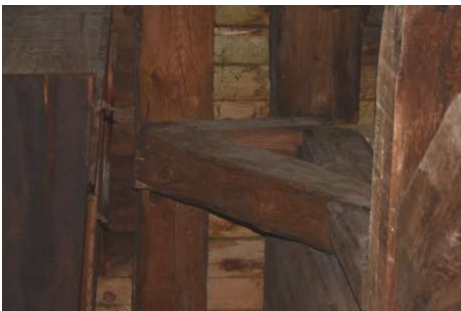
Fot. 250. Fragment stropu: belka podparta w osi 5-5 zastrzałem;
