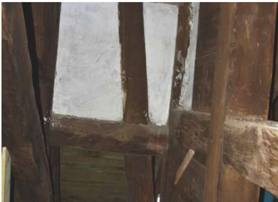
Fot. 74. Układ ściany w osi 9-9: zastrzał pomiędzy osiami I-G o przebiegu od podstawy słupa 9/I w kierunku 9/G; wypełnienie pól pomiędzy elementami drewnianymi tynkowane i malowane;
