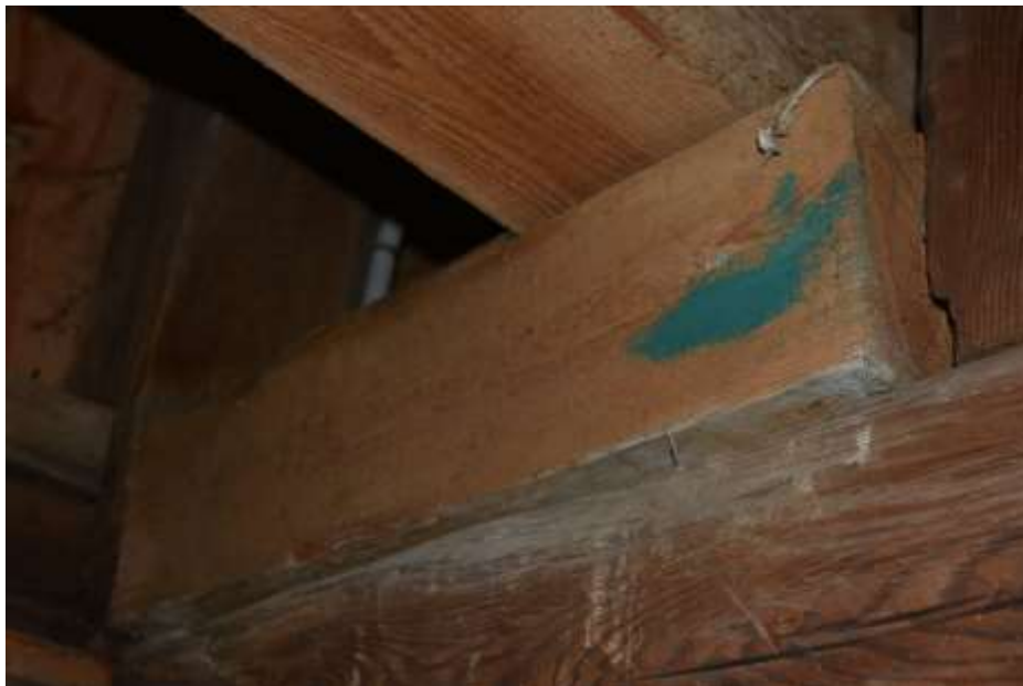
Fot. 175. Układ ramowy w osi D-D: na ryglu pomiędzy osiami 6-8 nakładka o wymiarach 17x17 cm;
