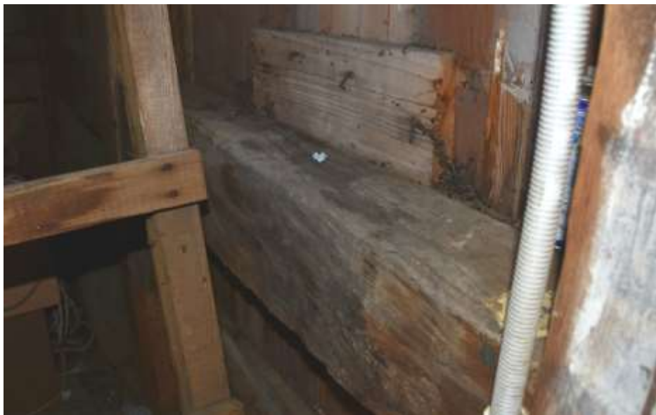
Fot. 170. Ściana w osi H-H: rygle w poziomie V o wymiarach 17x27 cm; zawilgocony; od strony deskowania nakładka grubości 3 cm porażona biologicznie;
