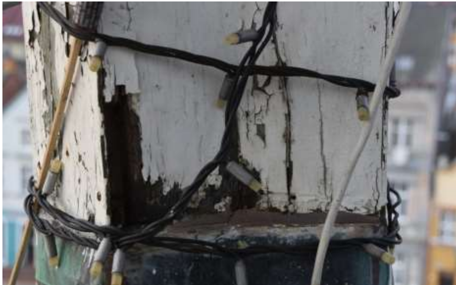
Fot. 215. Słup wieży: drewno zawilgocone; skorodowane; ubytki struktury; korozja sklejki;
