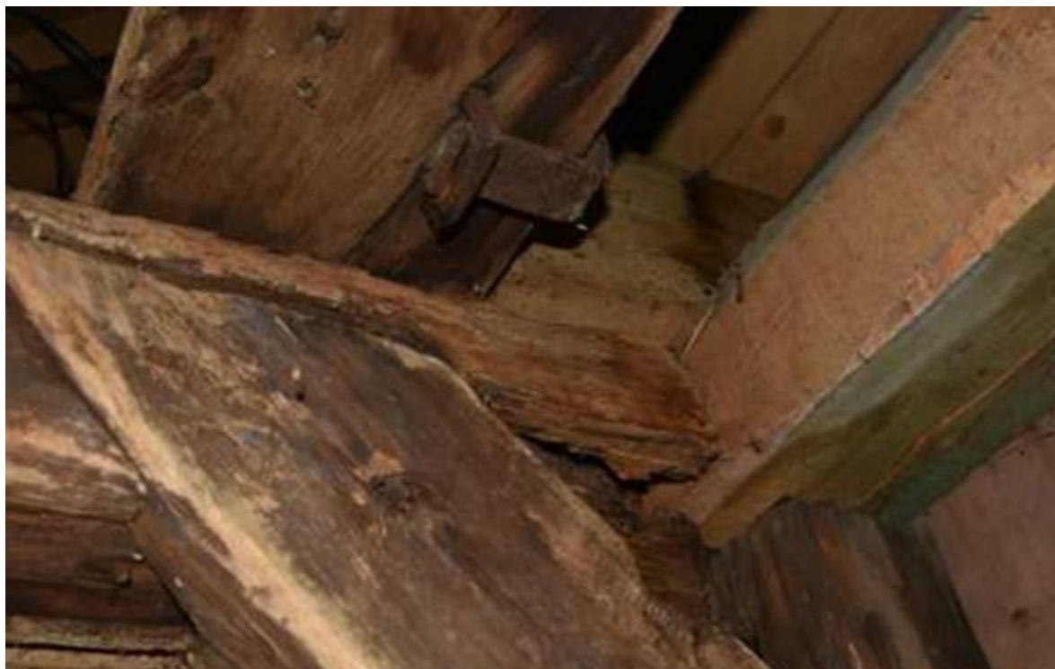
Fot. 54. Trzebiatów, ratusz, wieża zegarowa. Stan zachowania konstrukcji wieży jest zły. Występują liczne ogniska korozji biologicznej.
