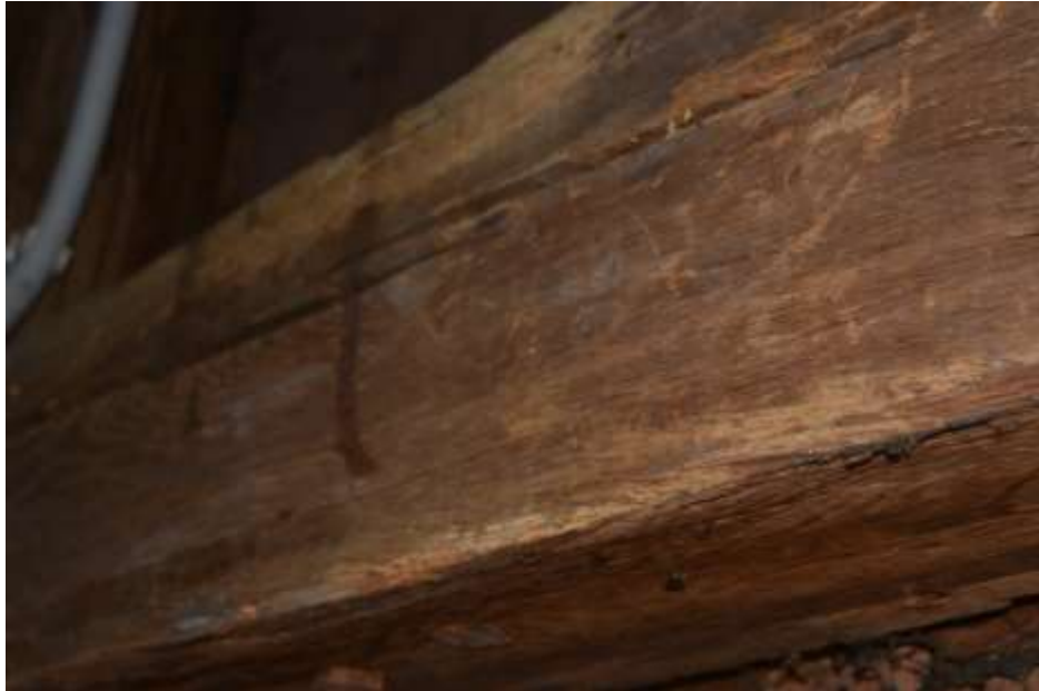
Fot. 163. Ściana w osi B-B: rygle w poziomie VI z zaciekami; od strony deskowania nakładka grubości 3 cm porażona biologicznie; na powierzchni drewna ciemne zabrudzenia;
