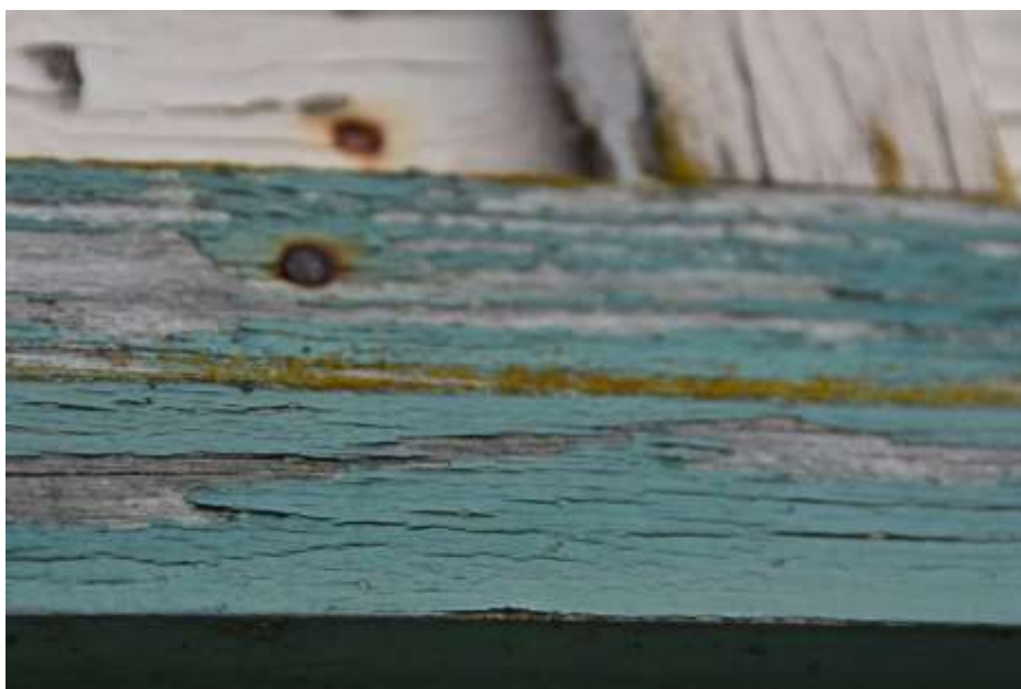
Fot. 332. Fragment elewacji: na powierzchni drewna wegetacja porostów;
