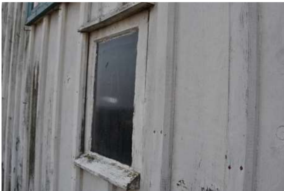
Fot. 293. Fragment elewacji: w ścianie niewielki otwór okienny; szklenie pojedyncze; nad otworem okiennym listwa drewniana; złuszczenia warstw malarskich;
