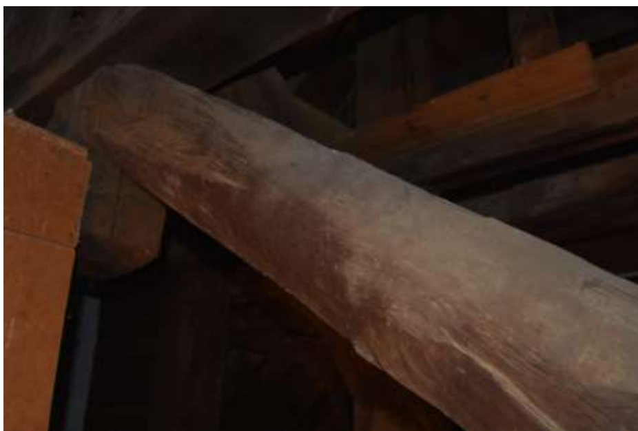
Fot. 101. Układ ramowy w osi G-G: zastrzały dolne o wymiarach 21x20 cm; o nieregularnym przekroju;
