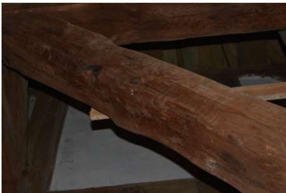
Fot. 106. Układ ramowy w osi G-G: zastrzał środkowy pomiędzy słupem 9/G i ryglem z zaciekami;
