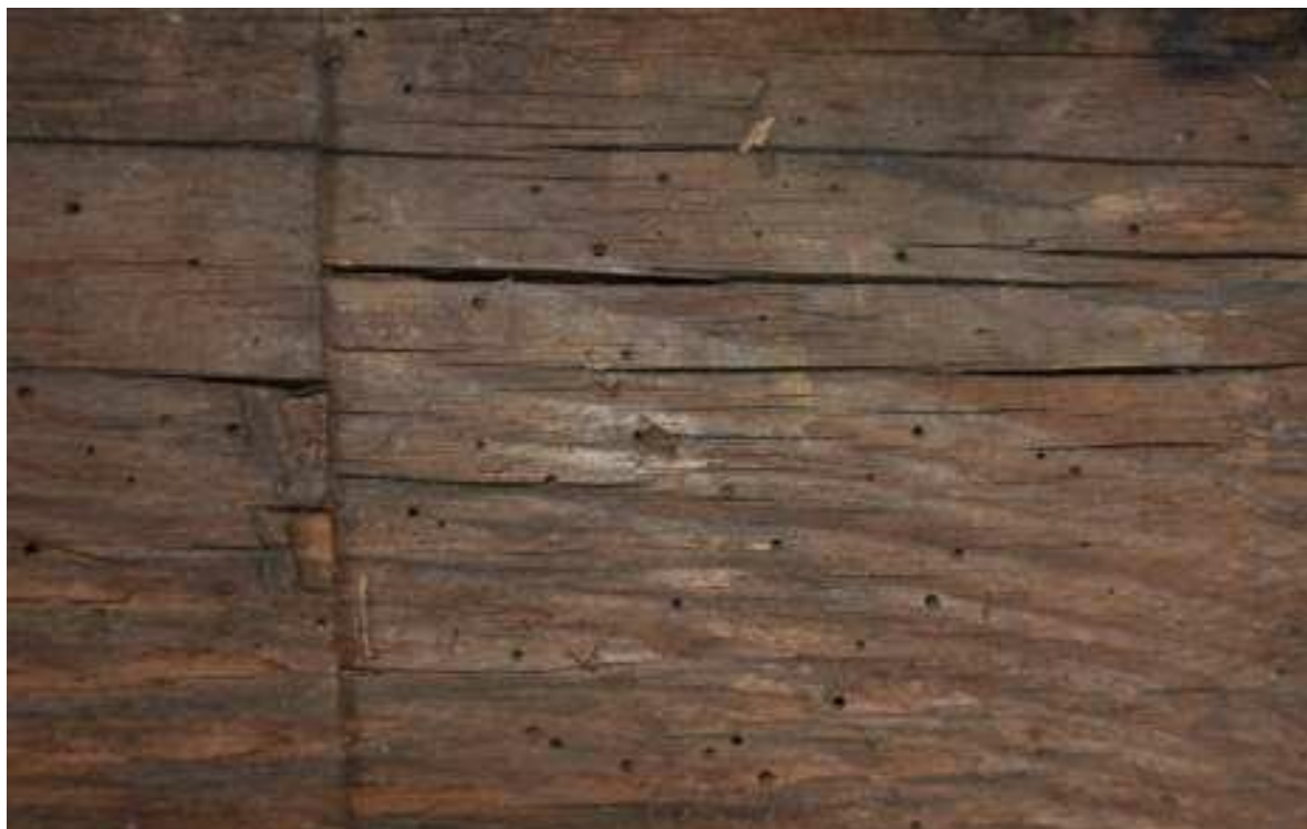
Fot. 52. Trzebiatów, ratusz, wieża zegarowa. Stan zachowania konstrukcji wieży jest zły. Występują liczne ogniska korozji biologicznej.
