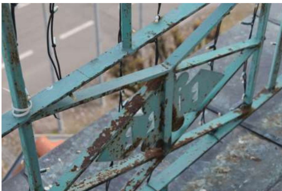
Fot. 288. Fragment elewacji: balustrada malowana; złuszczenia warstw malarskich; powierzchniowa korozja stali;
