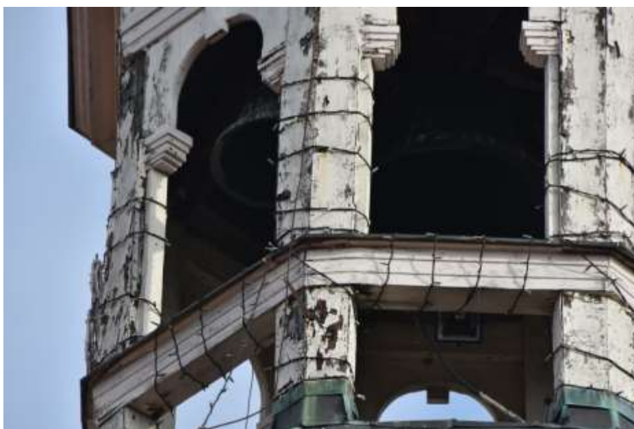
Fot. 336. Fragment elewacji: drewno malowane; złuszczenia warstw malarskich; nadbitki na słupach silnie skorodowane;
