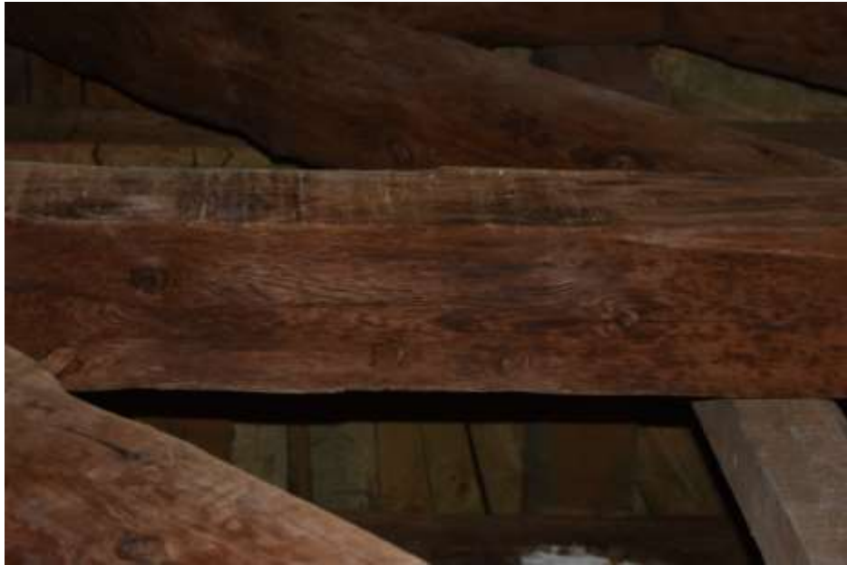
Fot. 109. Układ ramowy w osi G-G: rygle w poziomie III o wymiarach 22 x 16 cm; drewno ze śladami zacieków;
