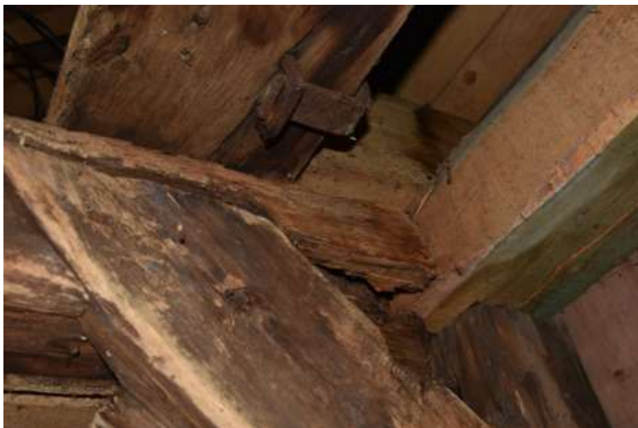
Fot. 198. Układ ramowy w osi 6-6: końcówka rygla przy osi H-H silnie skorodowana; ubytki struktury drewna;
