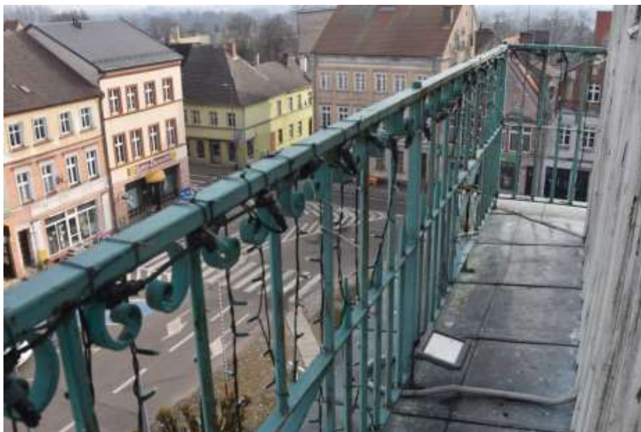
Fot. 287. Fragment elewacji: galeria zewnętrzna wieży zabezpieczona balustradą stalową;
