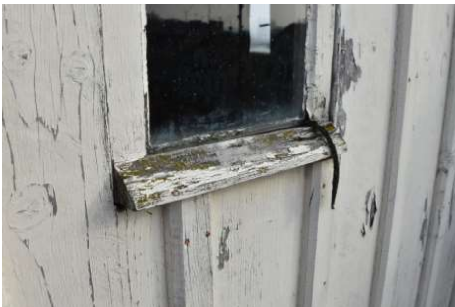
Fot. 327. Fragment elewacji: w ścianie niewielki otwór okienny; szklenie pojedyncze; ubytki kitu; parapet porażony biologicznie; powłoki malarskie złuszczone; na powierzchni wegetacja porostów;
