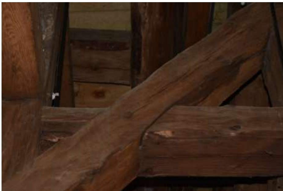
Fot. 131. Układ ramowy w osi 5-5: zastrzał górny z zaciekami; połączenie z ryglem kołkowane;
