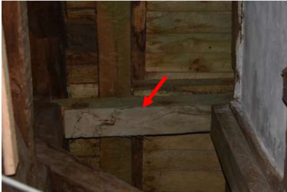
Fot. 137. Układ ramowy w osi 5-5: na odcinku G-I wymieniony sztuką nowego drewna;
