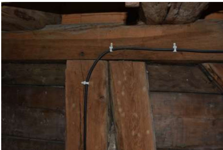
Fot. 20. Słup wieży: górna część słupa w partii pod stropem z jasnymi nalotami;
