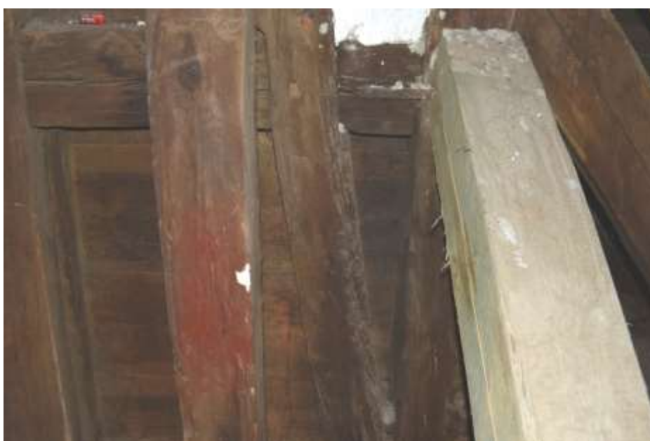
Fot. 88. Układ ściany w osi I-I: zastrzał pomiędzy osiami 9-7 o przebiegu od podstawy słupa 9/I w kierunku 7/I; o wymiarach 18x20 cm;
