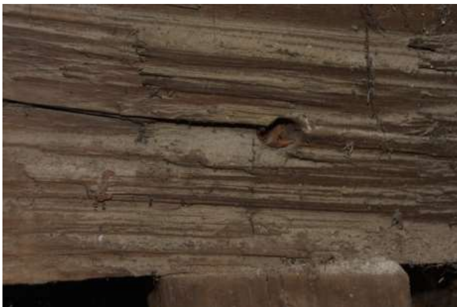
Fot. 62. Układ ściany w osi A-A: brak kołka na połączeniu z zastrzałem;
