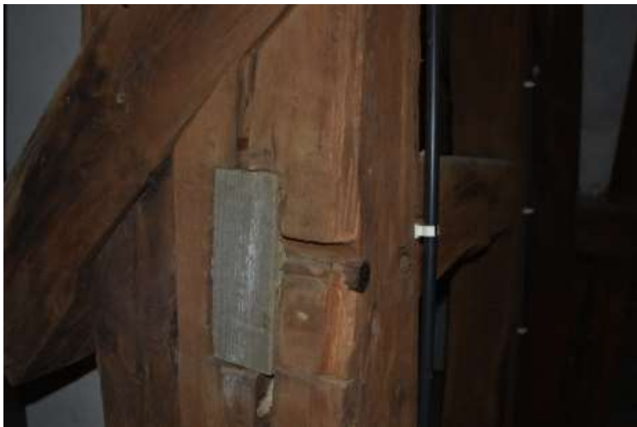
Fot. 17. Słup wieży: puste gniazdo po wyciętym ryglu I poziomu flekowane sztuką nowego drewna;
