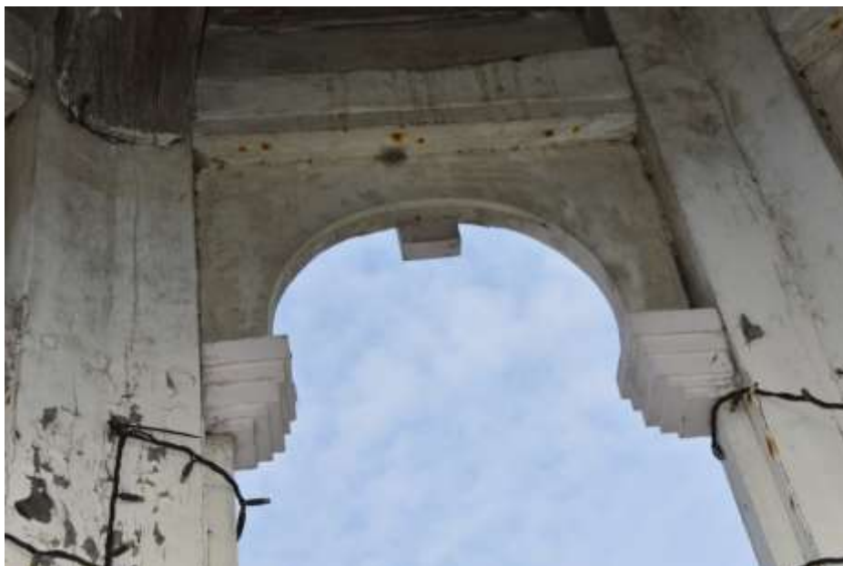
Fot. 236. Fragment latarni: pomiędzy słupami arkadowe łuki; drewno malowane; elementy w dobrym stanie;
