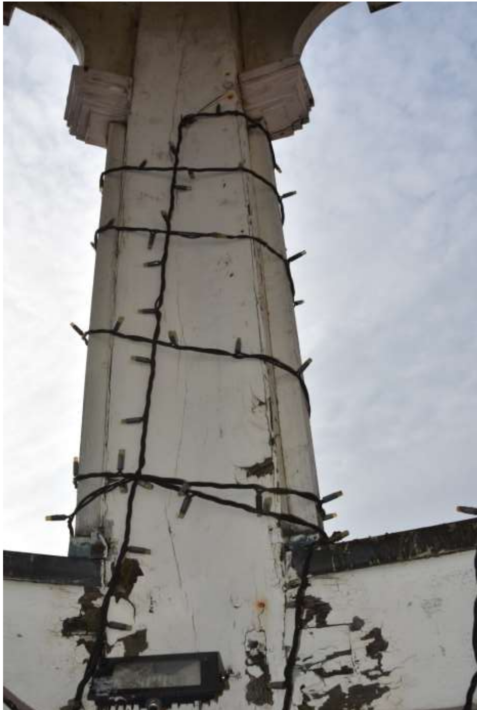
Fot. 234. Słup wieży: powyżej słup latarni malowany; złuszczenia warstw malarskich; na powierzchniach bocznych słupa warstwa ze sklejki gr. 2 mm;
