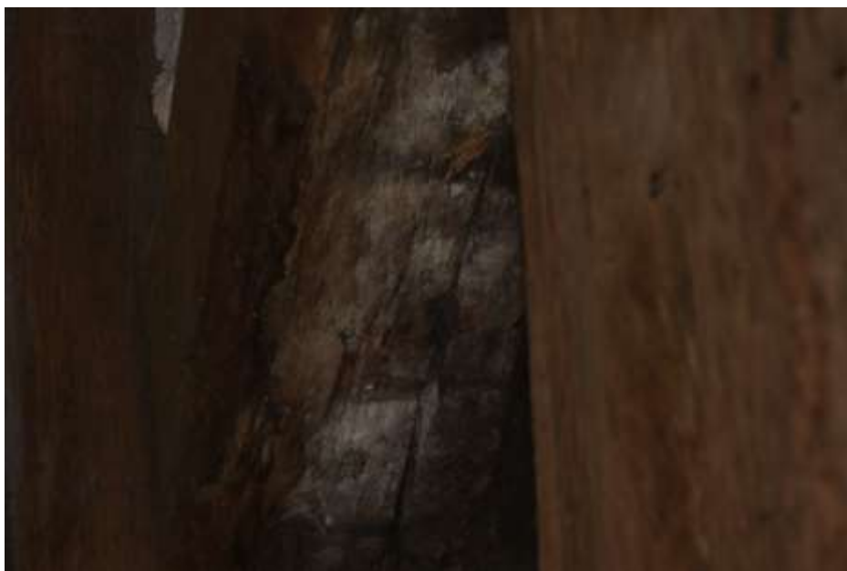
Fot. 10. Słup wieży: górna część słupa w partii pod stropem wraz z mieczem porażone biologicznie;
