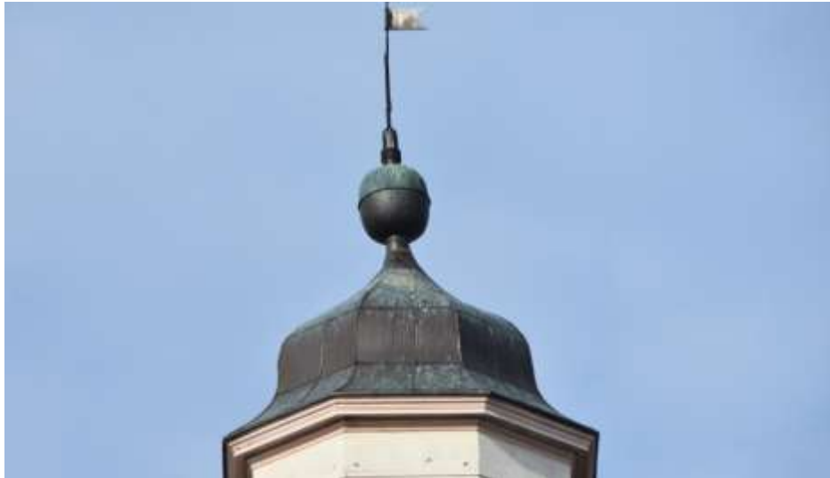
Fot. 315. Fragment elewacji: gzyms wieńczący profilowany; drewniany; drewno malowane; latarnia przykryta ozdobnym hełmem; pokrycie z blachy miedzianej;
