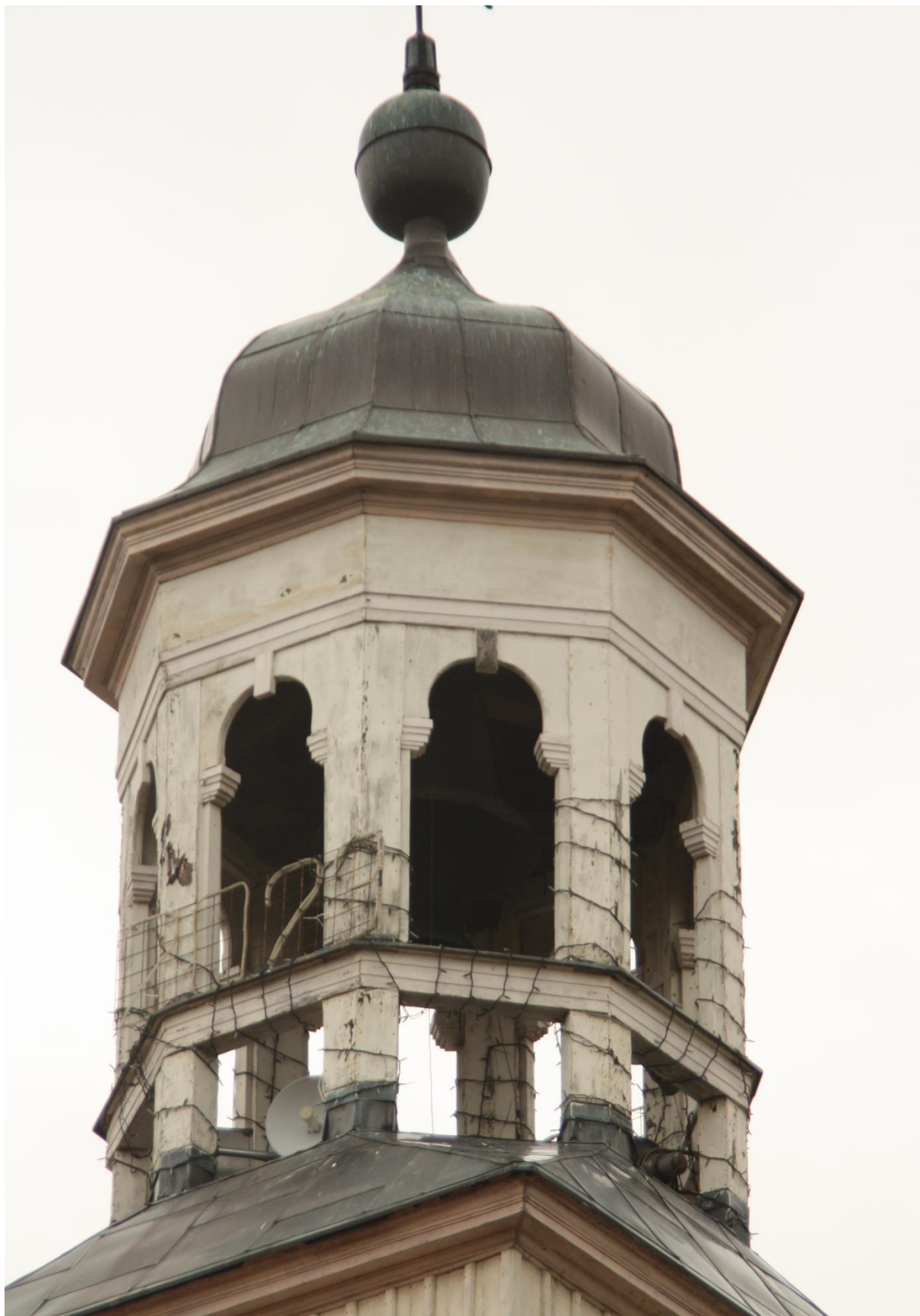
Fot. 31. Trzebiatów, ratusz, wieża zegarowa. Widok na latarnię wieży. Widoczne ubytki w warstwie dekoracyjnej, zaplamienia i złuszczenia spowodowane zawilgoceniem.
