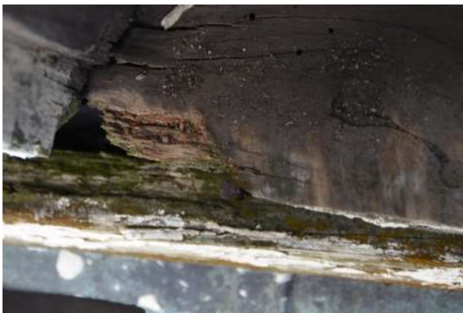
Fot. 325. Fragment elewacji: próg w drzwiach w stanie silnego rozkładu;
