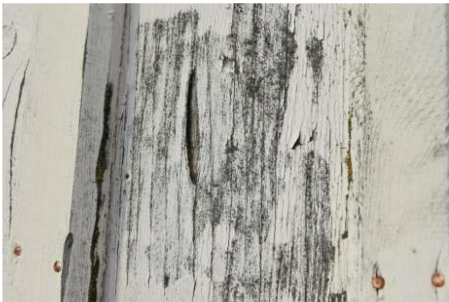
Fot. 308. Fragment elewacji: deski poszycia na pióro i wpust z listewkami na połączeniach; drewno malowane; skorodowane; na powierzchni rozwój porostów;
