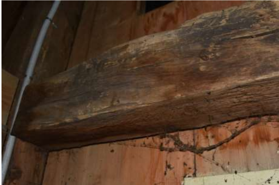
Fot. 167. Ściana w osi 8-8: rygle w poziomie VI z zaciekami; od strony deskowania nakładka grubości 3 cm porażona biologicznie; z pęknięciami wzdłuż włókien;
