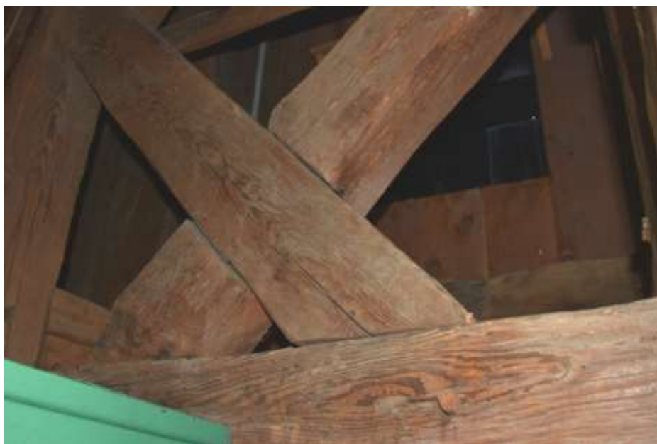
Fot. 204. Układ ramowy w osi 4-4: układ stężony zastrzałami typu X;
