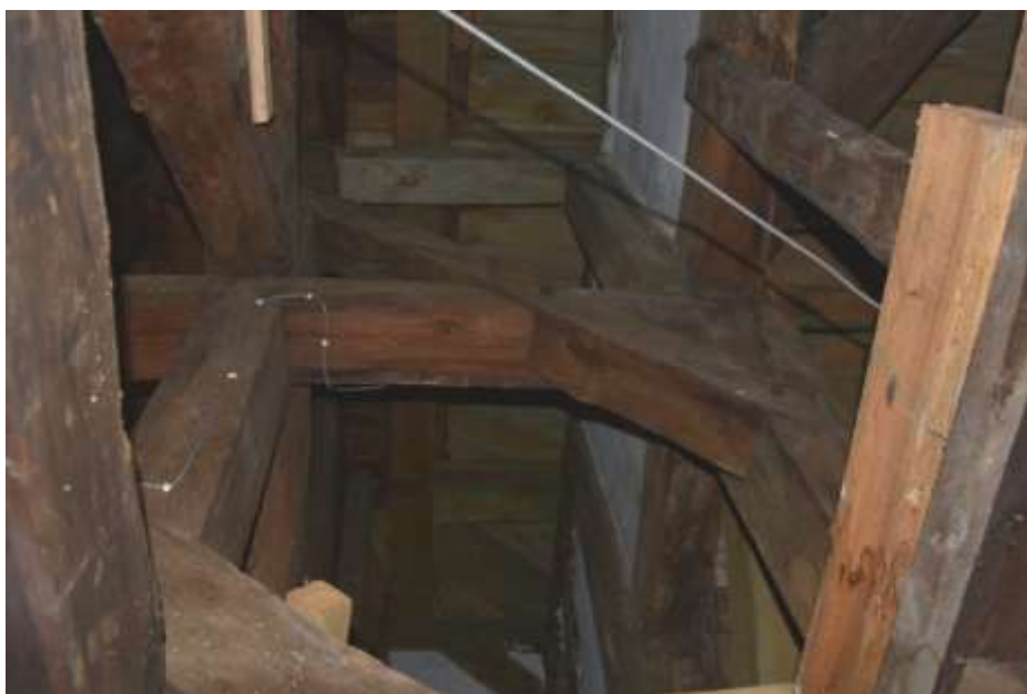
Fot. 133. Układ ramowy w osi 5-5: zastrzał górny na odcinku E-I z pęknięciami wzdłuż włókien; na powierzchni ciemne zacieki;
