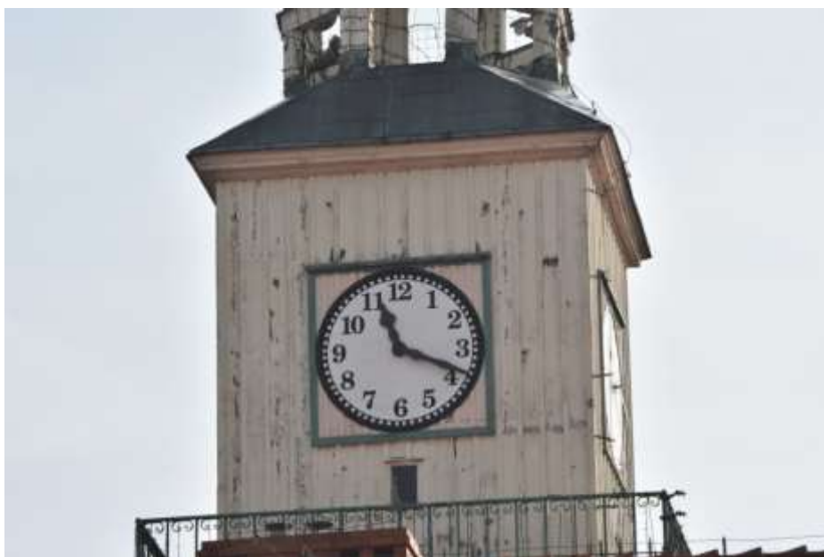
Fot. 341. Fragment elewacji: część środkowa wieży z poszyciem z desek; w osi ściany tarcza zegarowa;
