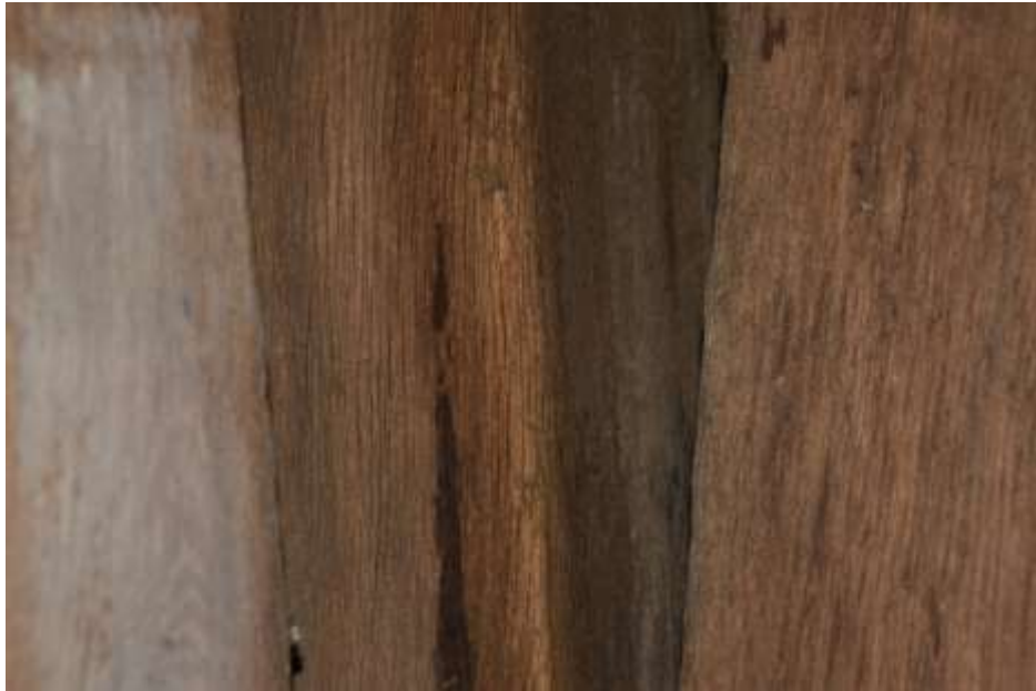
Fot. 145. Słup wieży: słup narożny; drewniany o wymiarach 22x18 cm; od strony deskowania nakładka grubości 3 cm; silnie porażona biologicznie;
