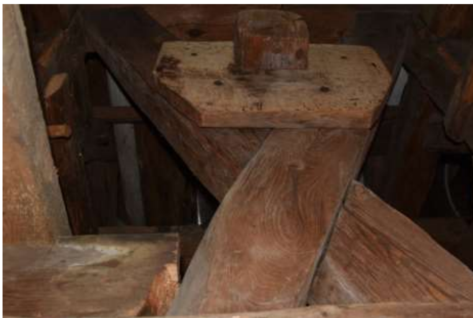
Fot. 178. Układ ramowy w osi D-D: w dolnej części ramy zastrzały typu X; połączenia kołkowane;
