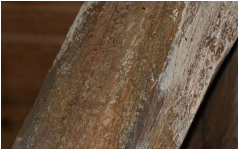
Fot. 227. Słup wieży: zastrzał porażony przez owady techniczne szkodniki drewna;
