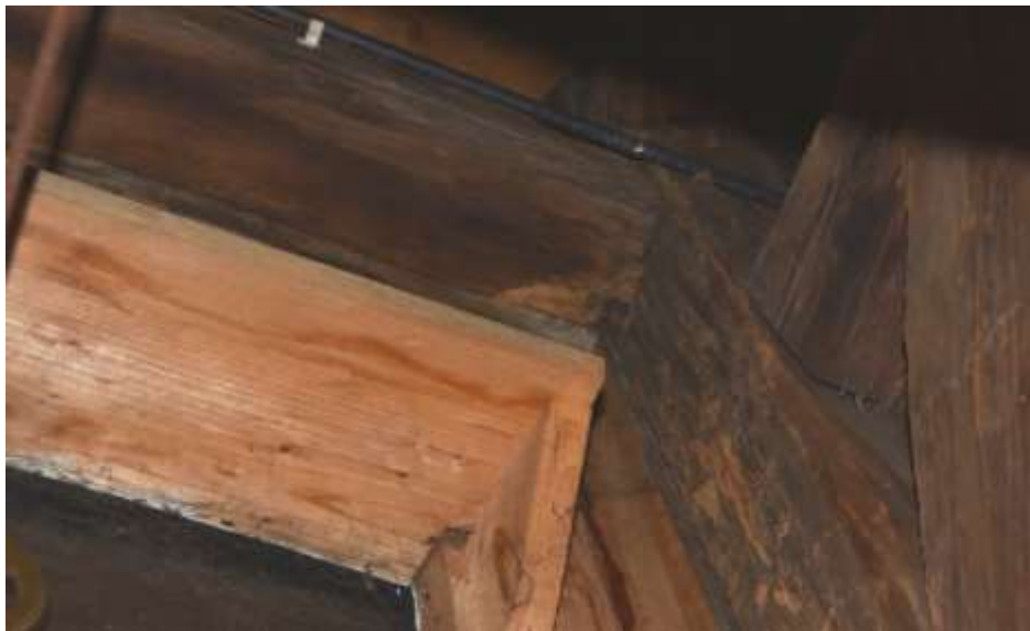
Fot. 168. Ściana w osi 8-8: rygle w poziomie VII z zaciekami; od strony deskowania nakładka grubości 3 cm porażona biologicznie; na powierzchni drewna ciemne naloty;
