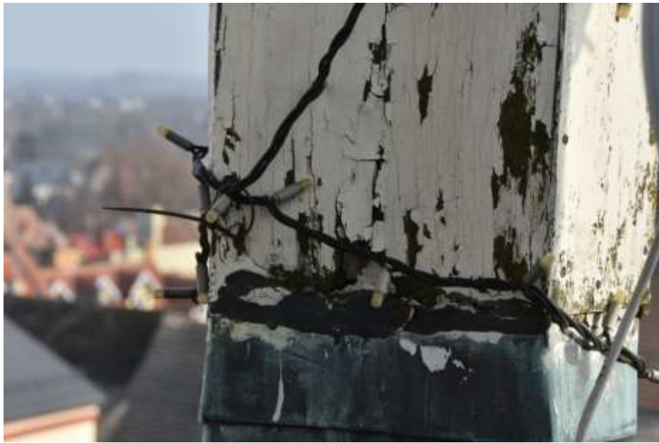
Fot. 224. Słup wieży: w dolnej części na słup wywinięta blacha miedziana; ślady uszczelnienia kitem na połączeniu; drewno zawilgocone; skorodowane; korozja sklejki;
