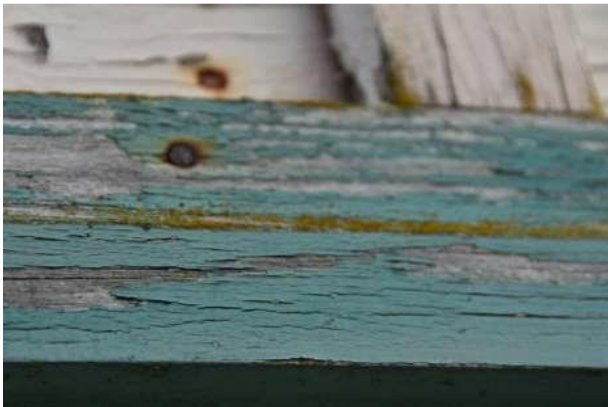
Fot. 35. Trzebiatów, ratusz, wieża zegarowa. Wysunięte elementy deskowania elewacji pokrywają nawarstwienia organiczne, glony i porosty.
