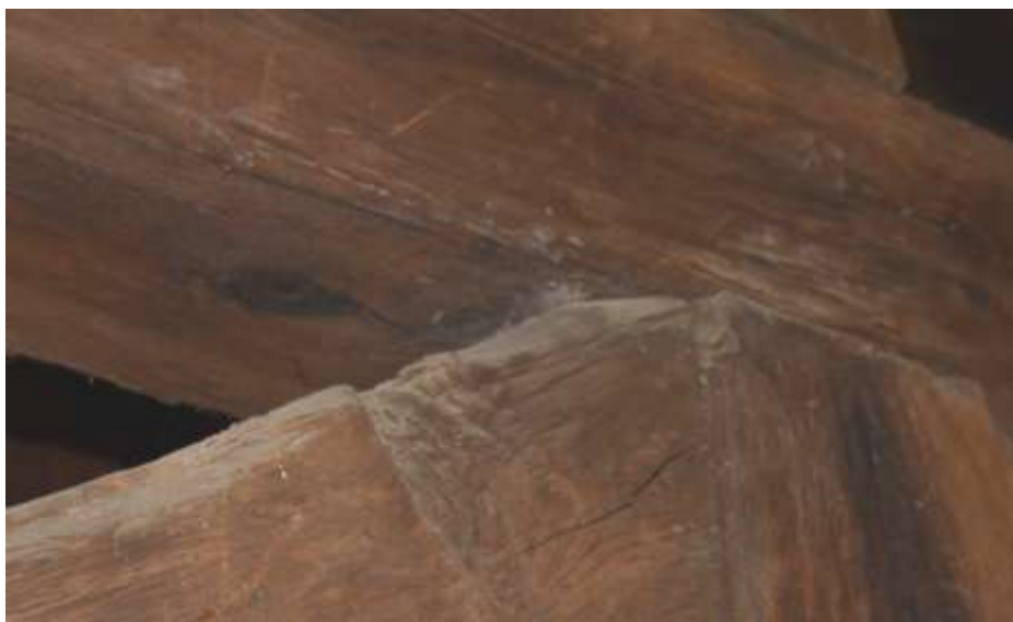
Fot. 126. Układ ramowy w osi C-C: rygle na poziomie II o wymiarach 22 x 22 cm; na powierzchni ciemne naloty;
