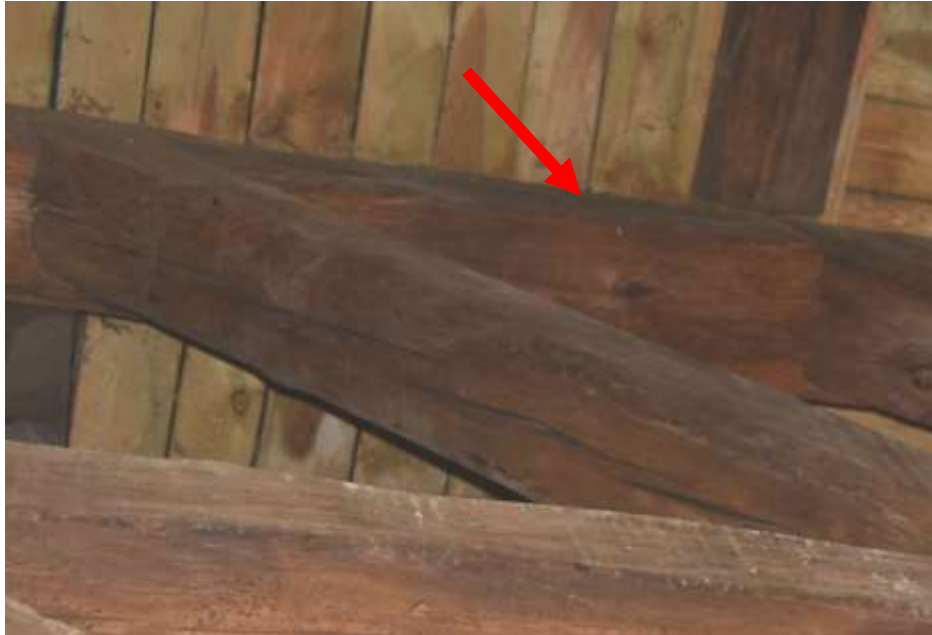
Fot. 122. Układ ramowy w osi G-G: układ w poziomie IV zwieńczony belką stanowiącą konstrukcję stropu nad dolnym poziomem wieży; drewno z zaciekami; ciemne przebarwienia na powierzchni;
