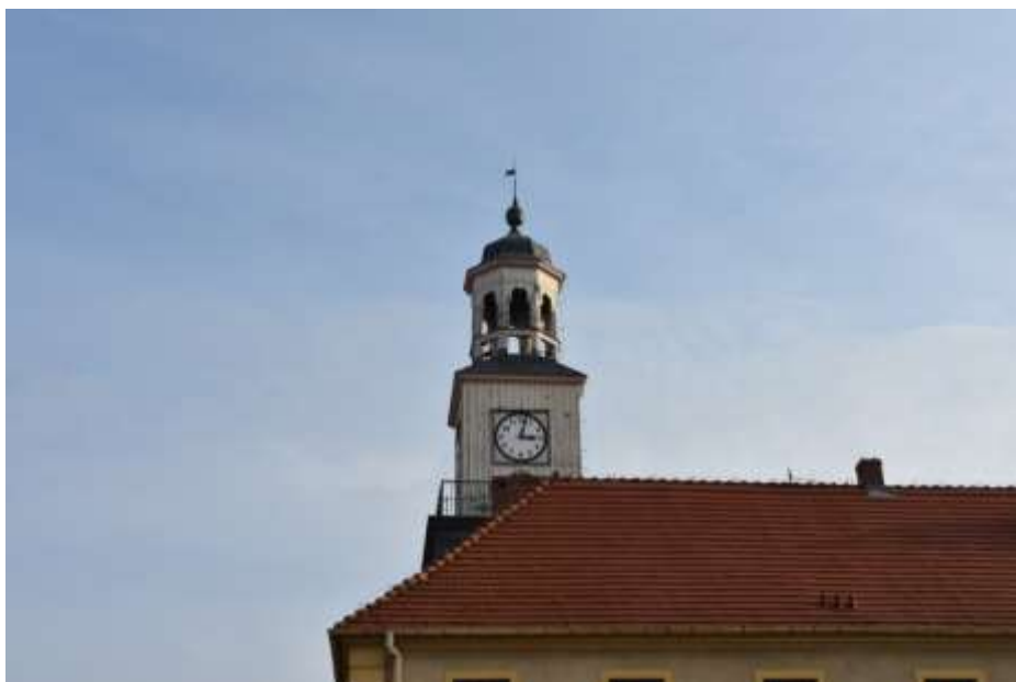
Fot. 338. Fragment elewacji: dolna część wieży widoczna we fragmencie; część środkowa na planie kwadratu z tarczą zegarową w osi ściany; wieża zwieńczona latarnią na planie ośmioboku;
