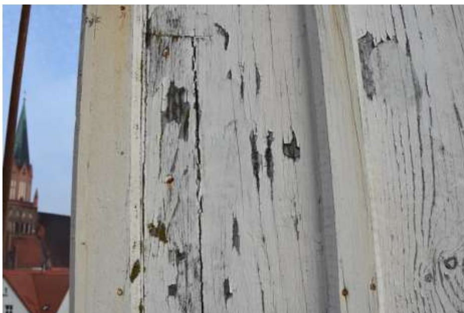
Fot. 330. Fragment elewacji: lokalnie widoczne ślady flekowania desek poszycia;
