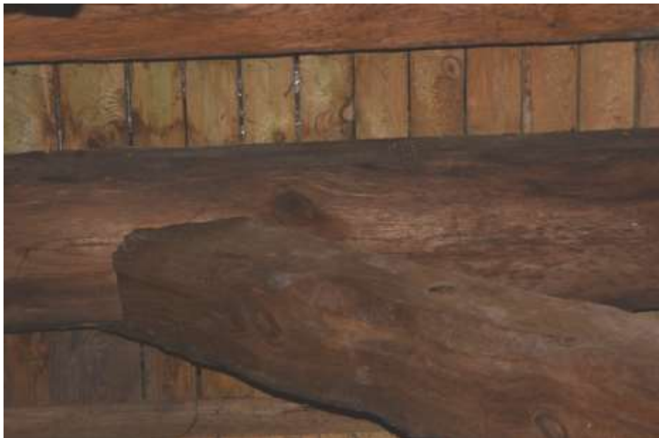
Fot. 110. Układ ramowy w osi G-G: układ w poziomie IV zwieńczony belką stanowiącą konstrukcję stropu nad dolnym poziomem wieży; drewno z zaciekami; ciemne przebarwienia na powierzchni;
