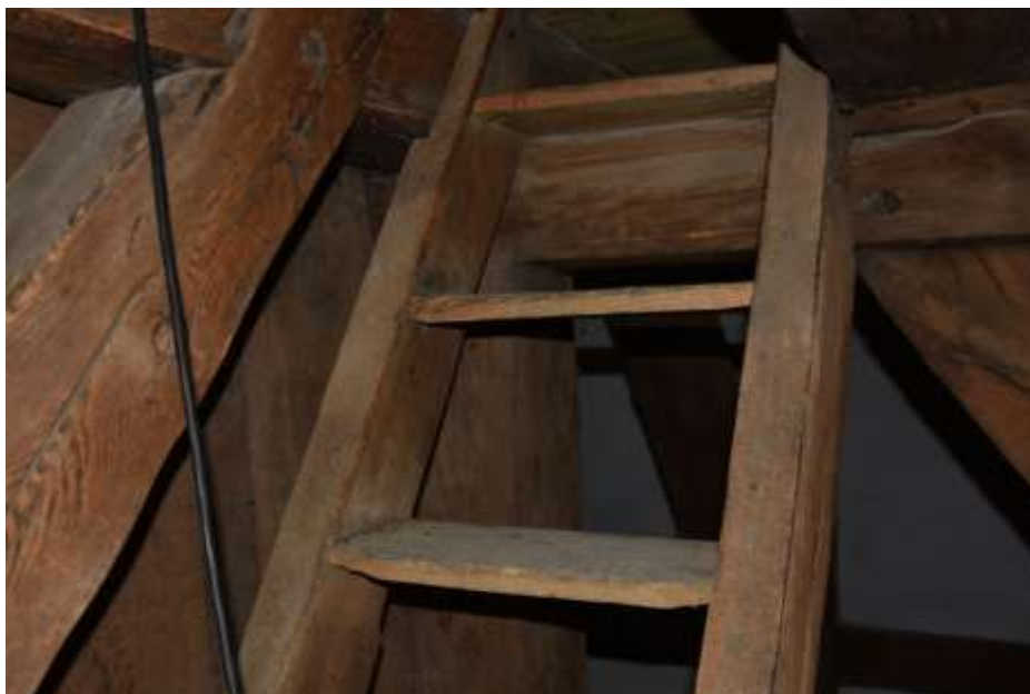
Fot. 280. Schody wieży: pod stropem spocznik; z poziomu spocznika kontynuacja schodów policzkowych;
