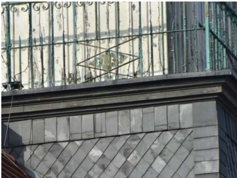
Fot. 303. Fragment elewacji: ściana zwieńczona profilowanym wysuniętym gzymsem drewnianym; drewno malowane; złuszczenia warstw malarskich;
