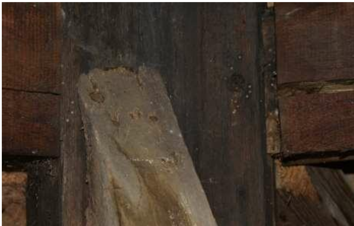
Fot. 55 . Trzebiatów, ratusz, wieża zegarowa. Stan zachowania konstrukcji wieży jest zły. Występują liczne ogniska korozji biologicznej.
