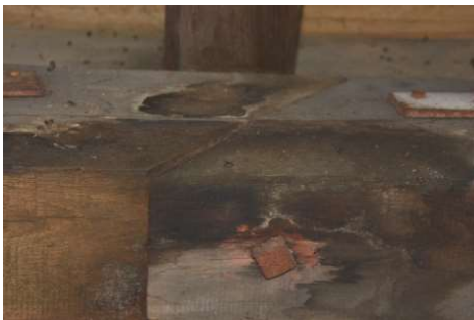
Fot. 266. Fragment stropu: w osi 3-3 belka o wymiarach 26x17 połączona w środku rozpiętości; od góry na powierzchni drewna zacieki;
