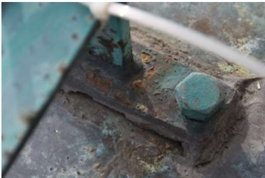
Fot. 307. Fragment elewacji: ubytki uszczelnienia w miejscu mocowania balustrady;
