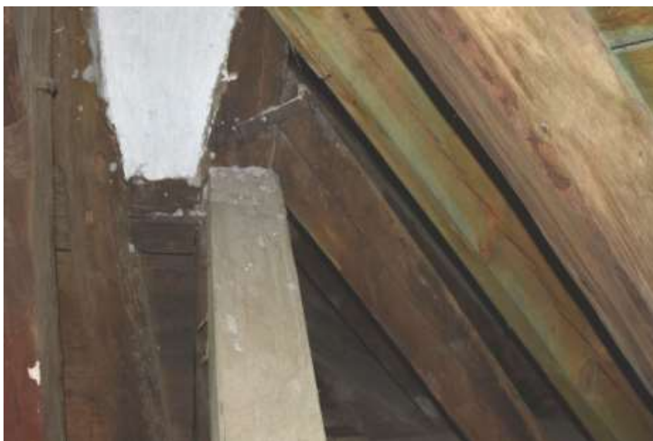
Fot. 86. Układ ściany w osi I-I: zastrzał przy słupie 9/I z pęknięciami wzdłuż włókien;
