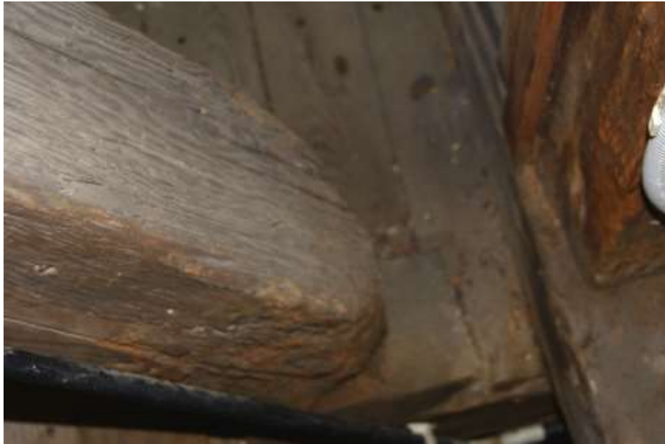
Fot. 181. Układ ramowy w osi D-D: zastrzał przy osi 8-8 w dolnej części silnie skorodowany; brak połączenia z belką stropową;
