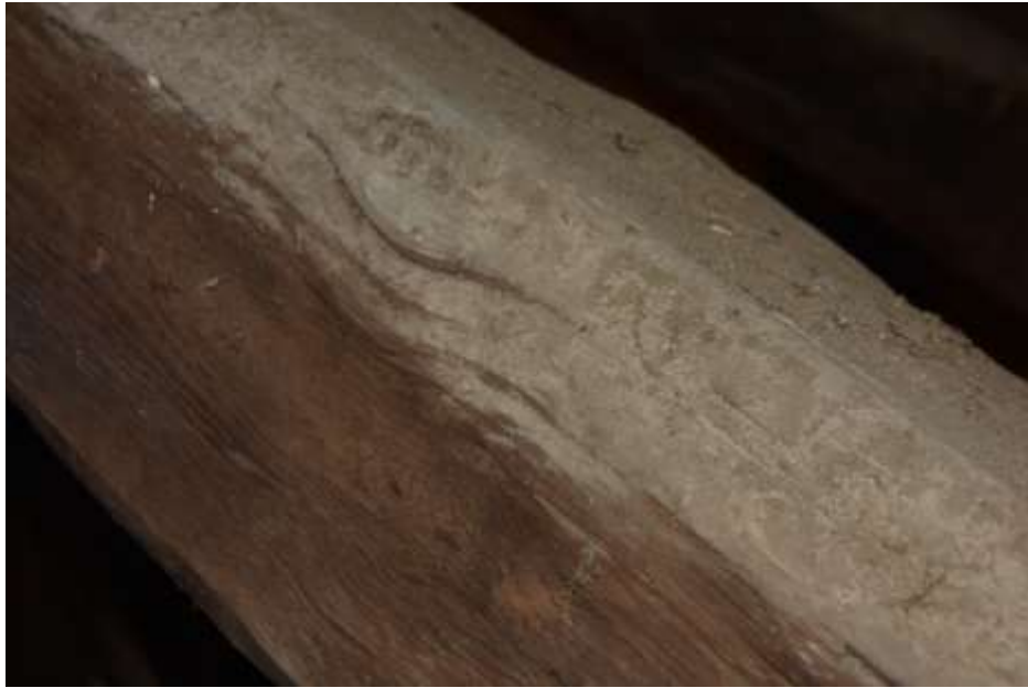
Fot. 123. Układ ramowy w osi C-C: zastrzały dolne o wymiarach 22x22 cm; o nieregularnym przekroju; drewno powierzchniowo skorodowane;
