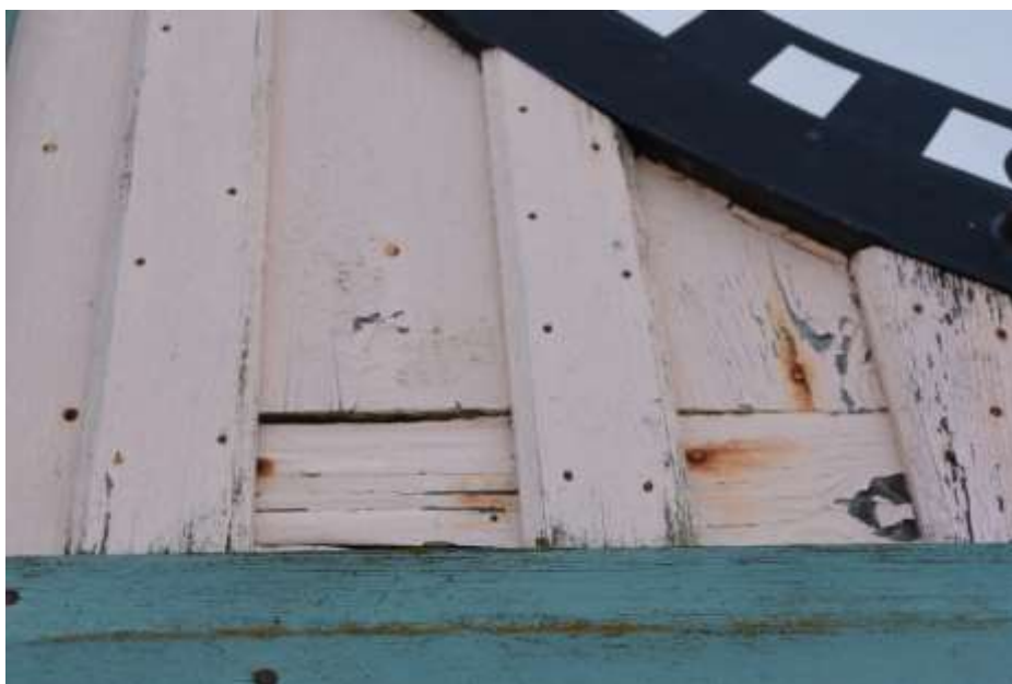
Fot. 349. Fragment elewacji: tarcza zegarowa z blachy stalowej; wokół tarczy deski drewniane z listewkami na połączeniach; deski malowane; złuszczenia warstw malarskich;
