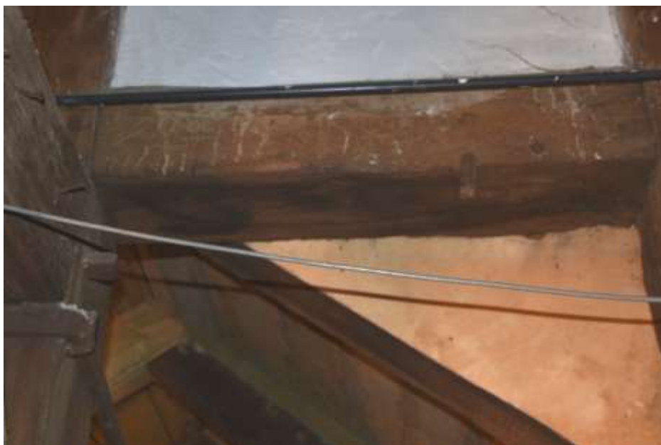
Fot. 52. Układ ściany w osi 1-1: rygle II poziomym o wymiarach 20x20cm;
