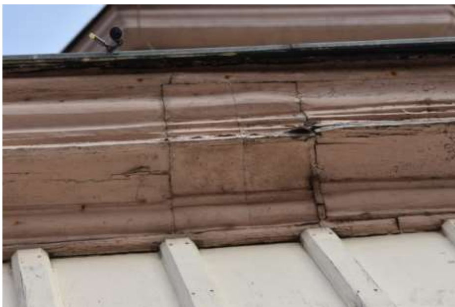
Fot. 333. Fragment elewacji: ściana zwieńczona wysuniętym profilowanym gzymsem drewnianym; we fragmencie widoczna wymiana fragmentu gzymsu; złuszczenia warstw malarskich;
