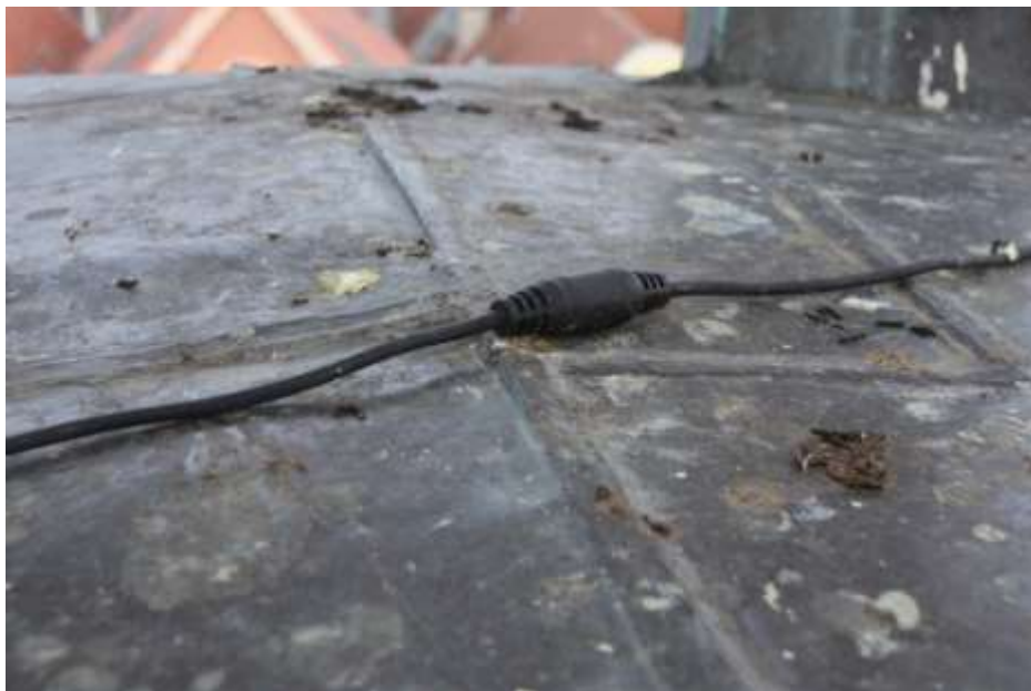
Fot. 275. Fragment stropu: od góry na deskowaniu blacha miedziana; lutowana;
