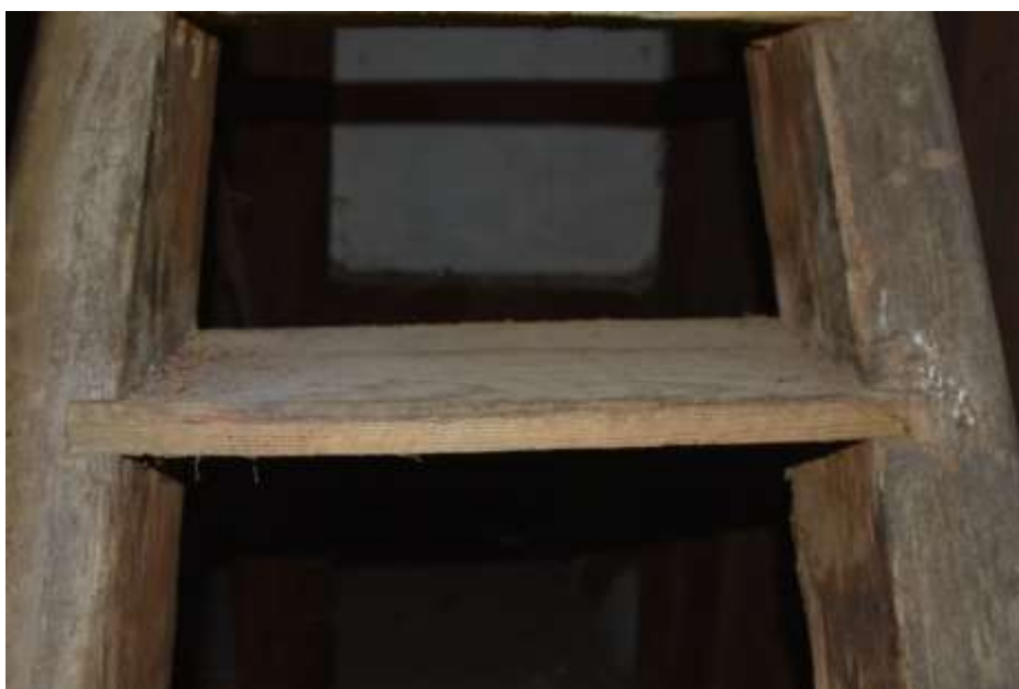
Fot. 278. Schody wieży: stopnie wpuszczane z desek o wymiarach 22x2,5 cm;
