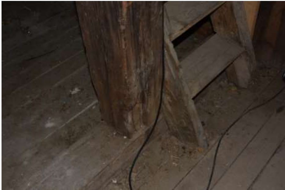
Fot. 37. Słup wieży: słup drewniany o wymiarach 23x23 cm; w dolnej części słup skorodowany; ubytki struktury drewna;
