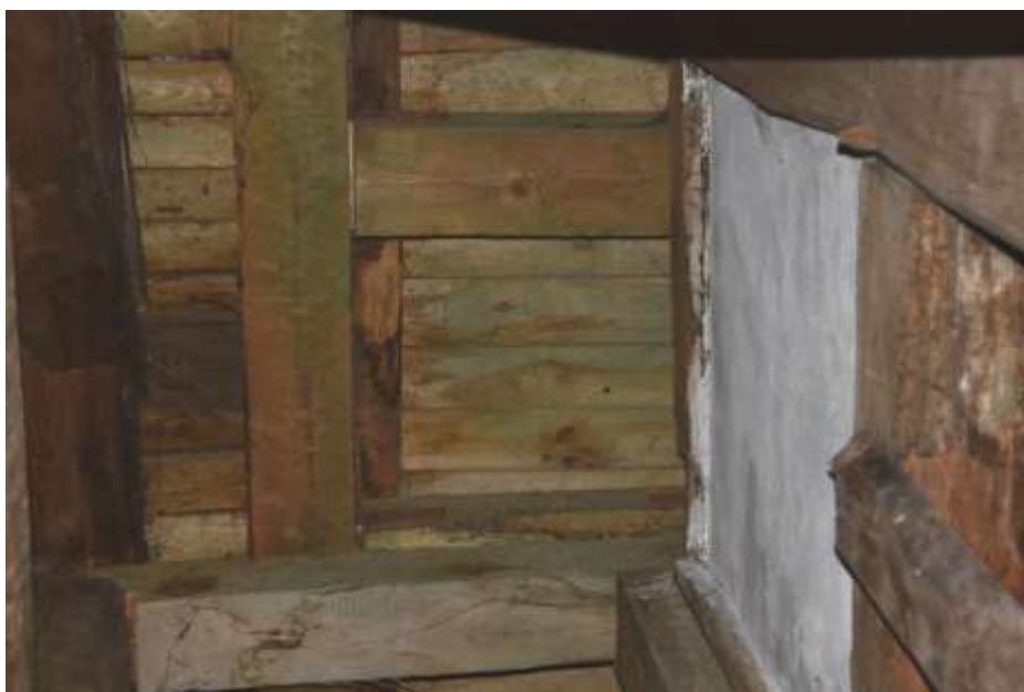
Fot. 252. Fragment stropu: belka w osi H-H belka wymieniona sztuką nowego drewna;
