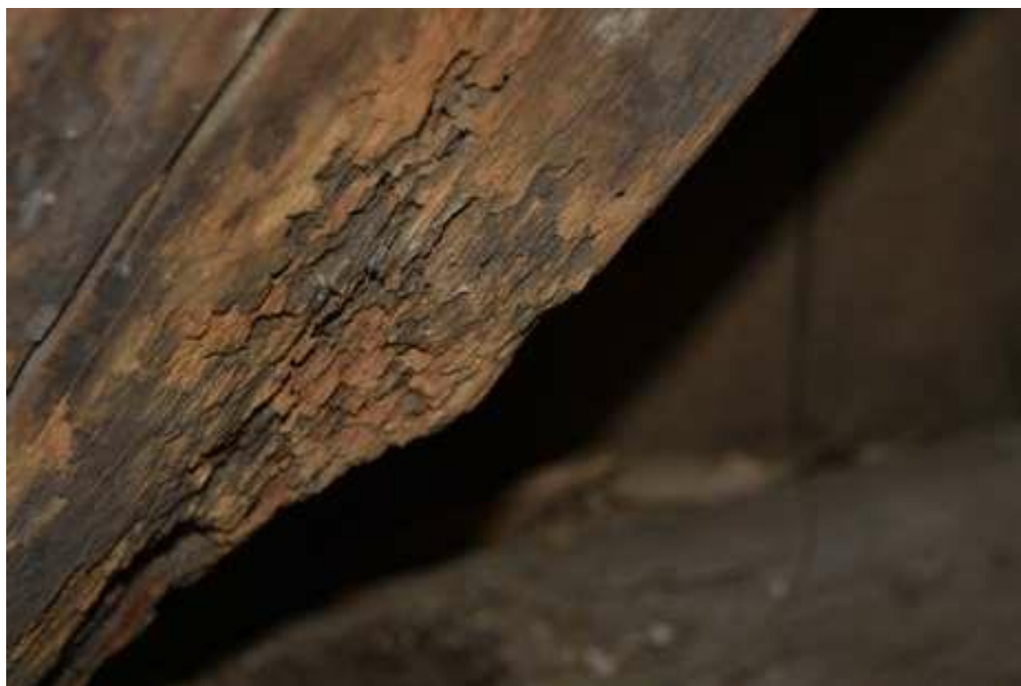
Fot. 47. Trzebiatów, ratusz, wieża zegarowa. Stan zachowania konstrukcji wieży jest zły. Występują liczne ogniska korozji biologicznej.
