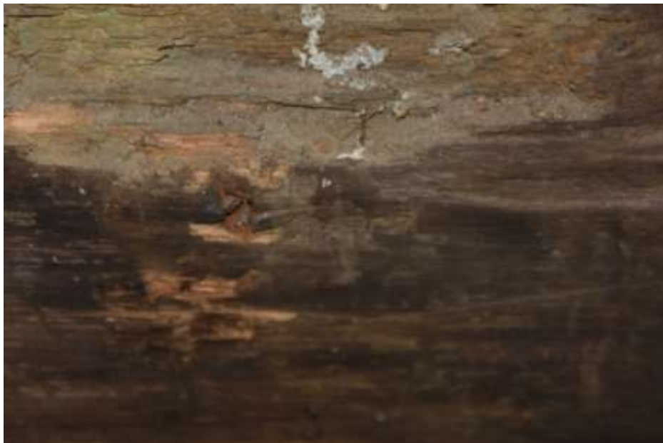
Fot. 77. Układ ściany w osi 9-9: na odcinku I-G rygiel porażony biologicznie; - rygle II (rys. E5 – załącznik nr 1) poziomemu o wymiarach 22x21cm;
