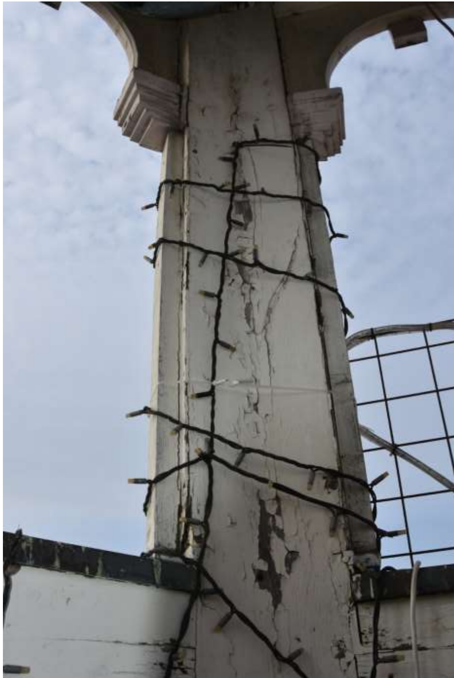
Fot. 211. Słup wieży: powyżej słup latarni malowany; złuszczenia warstw malarskich; na powierzchniach bocznych słupa warstwa ze sklejki gr. 2 mm;
