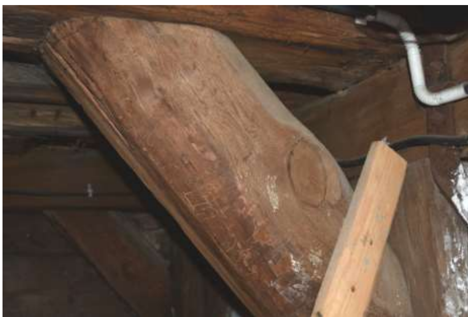
Fot. 244. Fragment stropu: belka w osi C-C podparta mieczami i zastrzałami;
