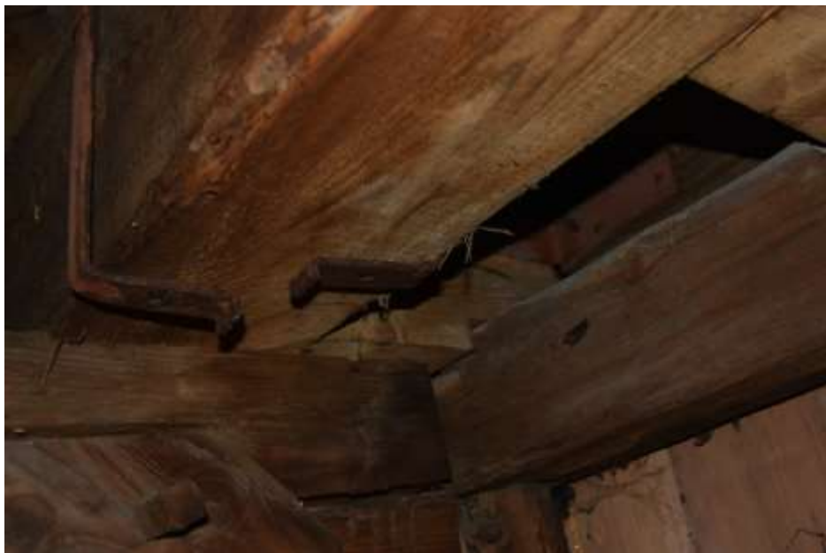
Fot. 264. Fragment stropu: belka w osi C'-C' o wymiarach 25x22 cm; przy belce elementy metalowe obejmujące belkę; płaskowniki powierzchniowo skorodowane; bez połączenia z belką;
