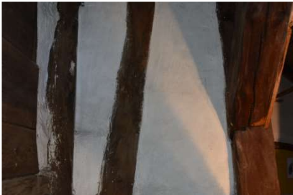
Fot. 44. Układ ściany w osi 1-1; zastrzał pomiędzy osiami I-G o przebiegu od podstawy słupa 1/I w kierunku 1/G; wypełnienie pól pomiędzy elementami drewnianymi tynkowane i malowane;
