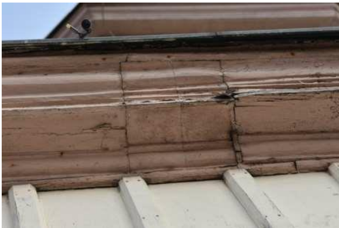
Fot. 38. Trzebiatów, ratusz, wieża zegarowa. Na gzymsie środkowej kondygnacji wieży widoczne są spękania oryginalnego materiału oraz ślady flekowania.
