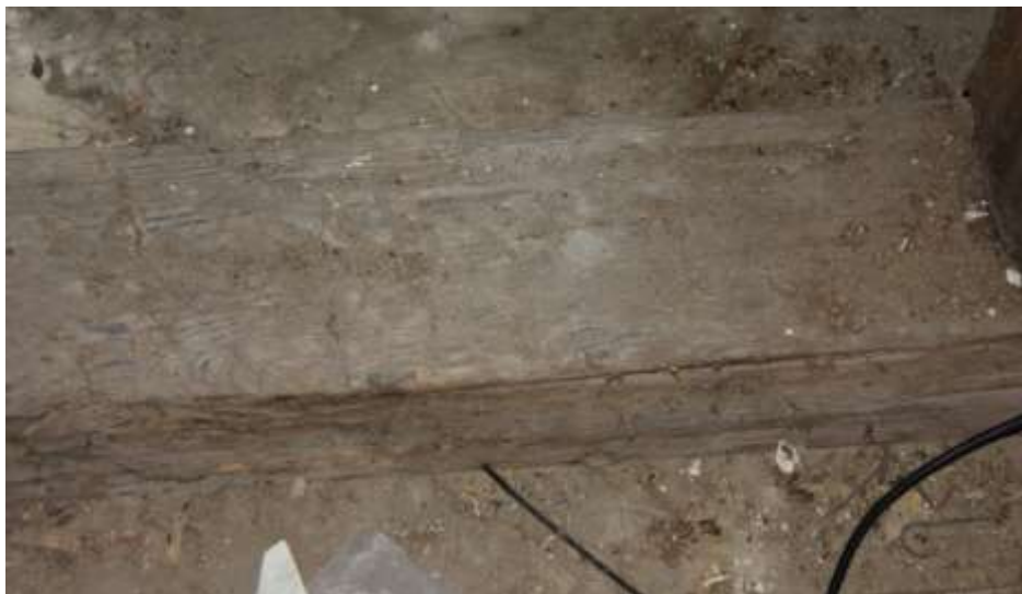
Fot. 128. Układ ramowy w osi 5-5: pod słupami podwalina o wymiarach 22x18 cm; drewno powierzchniowo skorodowane;
