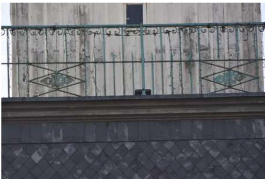
Fot. 285. Fragment elewacji: dolna część wieży zwieńczona profilowanym wysuniętym gzymsem drewnianym; na powierzchni ciemne naloty;
