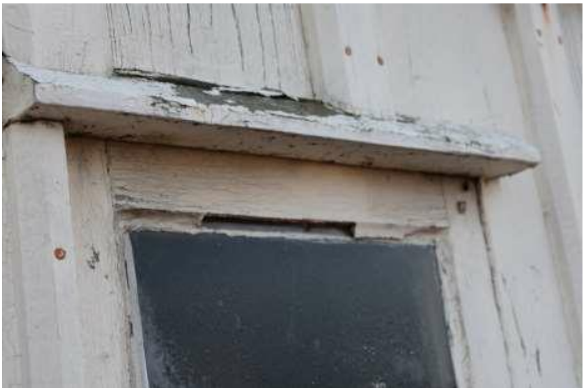
Fot. 41. Trzebiatów, ratusz, wieża zegarowa. Stolarka okienna zachowana jest pośledniej jakości zachowana w złym stanie.
