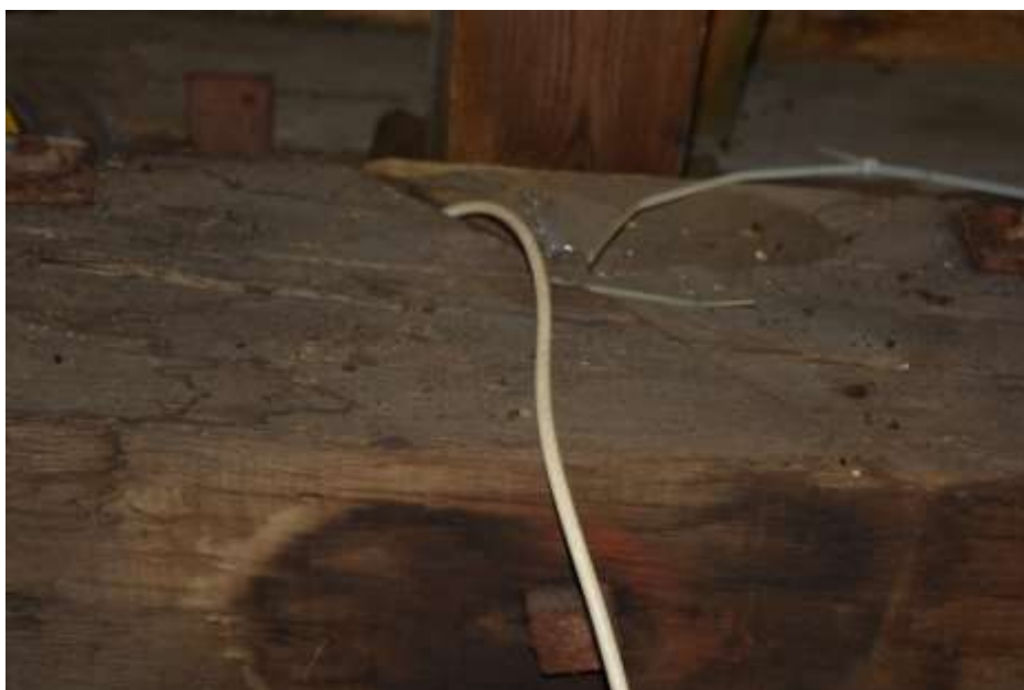
Fot. 267. Fragment stropu: w osi 7-7 belka o wymiarach 26x17 połączona w środku rozpiętości; na powierzchni drewna zacieki;
