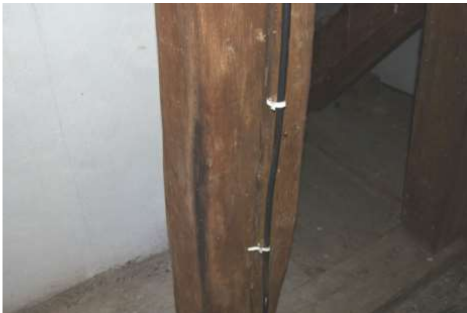
Fot. 19. Słup wieży: słup drewniany o wymiarach 24x20 cm; drewno z pęknięciami wzdłuż włókien; na powierzchni zacieki;
