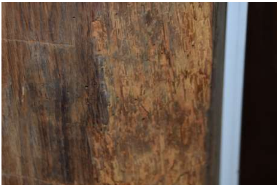
Fot. 13. Słup wieży: słup porażony przez owady techniczne szkodniki drewna; pod warstwą zewnętrzną widoczne korytarze wypełnione mączką drzewną;
