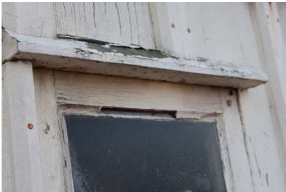
Fot. 348. Fragment elewacji: nad otworem okiennym pierwotnie listewka drewniana; obecnie zachowana w szczątkowej formie;
