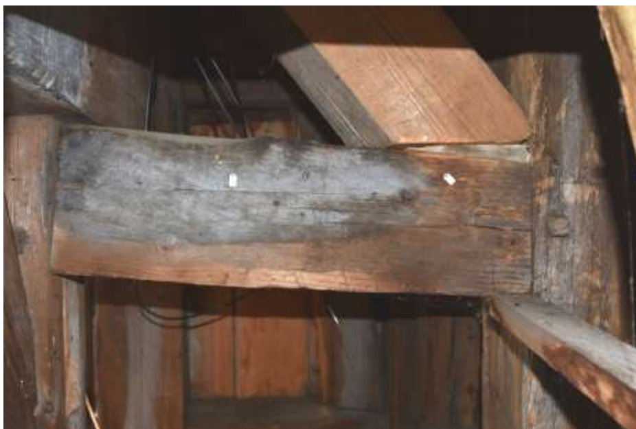
Fot. 190. Układ ramowy w osi 6-6: rygiel na odcinku F-H zdeformowany; obniżony w kierunku słupa zewnętrznego;
