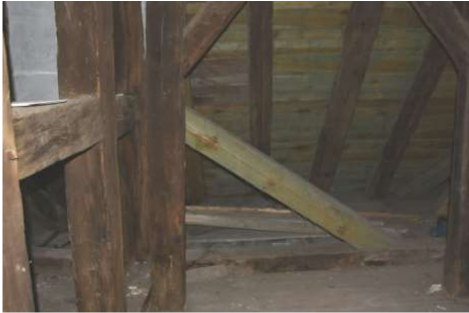
Fot. 75. Układ ściany w osi 9-9: przy słupie 9/I od strony poddasza zastrzał wymieniony sztuką nowego drewna o wymiarach 21x24 cm;
