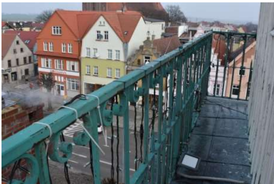
Fot. 342. Fragment elewacji: galeria zewnętrzna wieży zabezpieczona balustradą stalową;
