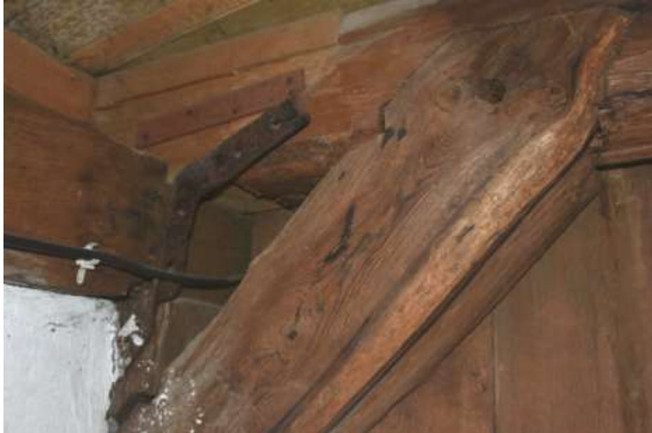
Fot. 247. Fragment stropu: belka w osi E-E o wymiarach 26 x 24 cm; podparta przy ścianie w osi 9-9 dodatkowym mieczem; końcówka wymieniona sztuką nowego drewna; Element metalowy bez połączenia z belką;
