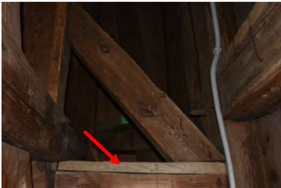
Fot. 205. Układ ramowy w osi 4-4: na odcinku B-D zastrzał oparty na ryglu poprzez nakładkę z deski o wymiarach 5x19 cm;
