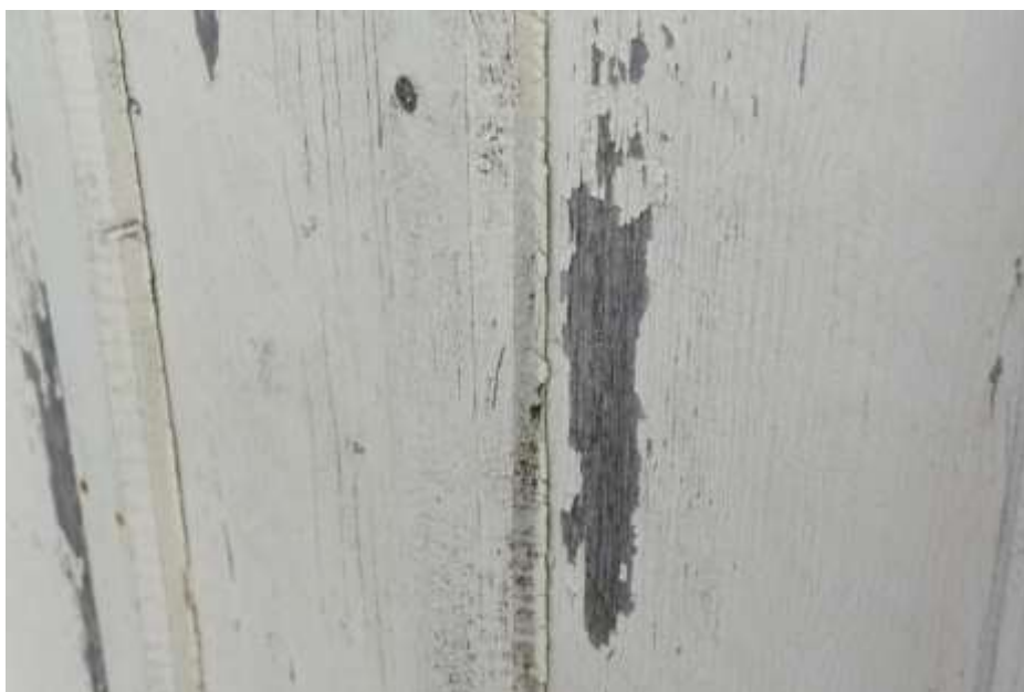
Fot. 322. Fragment elewacji: deski poszycia na pióro i wpust z listewkami na połączeniach; drewno malowane; złuszczenia warstw malarskich;
