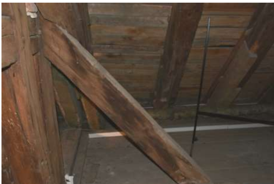
Fot. 48. Układ ściany w osi 1-1: przy słupie 1/A zastrzał o wymiarach 20x19 cm; na powierzchni drewna widoczne zacieki;
