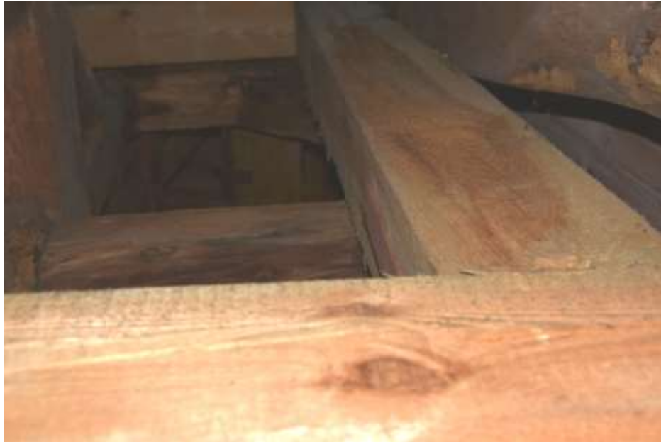
Fot. 195. Układ ramowy w osi 6-6: przy osi 6-6 wstawiona nowa konstrukcja oparta na ryglach na wysokości 220 cm od podłogi; nowy rygiel o wymiarach 18x20cm; słupy o wymiarach 17x21 cm;
