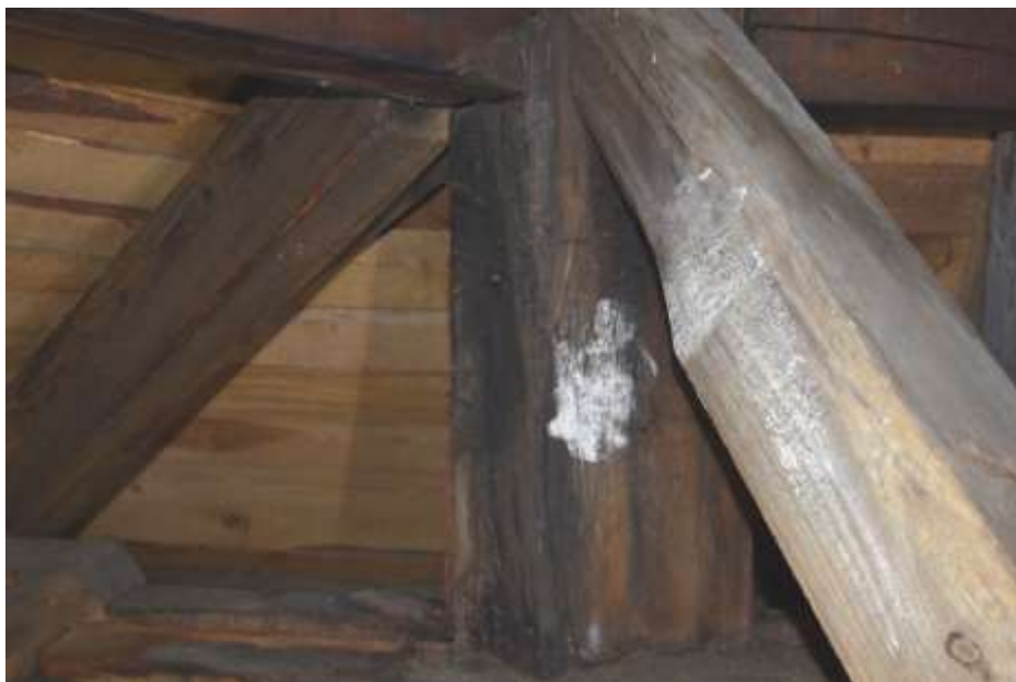
Fot. 209. Słup wieży: w przestrzeni pod zadaszeniem części zegarowej wieży słup silnie zawilgocony; porażony biologicznie; kotwiony do belki stropu dwoma kątownikami stalowymi; słup podparty zastrzałem;
