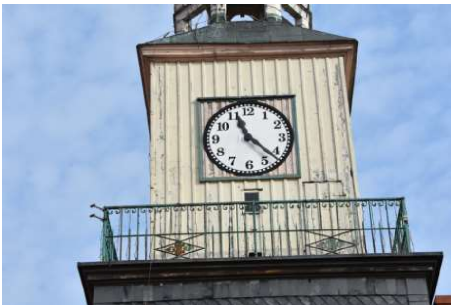
Fot. 319. Fragment elewacji: część środkowa wieży z poszyciem z desek; w osi ściany tarcza zegarowa; przy narożniku otwór drzwiowy;
