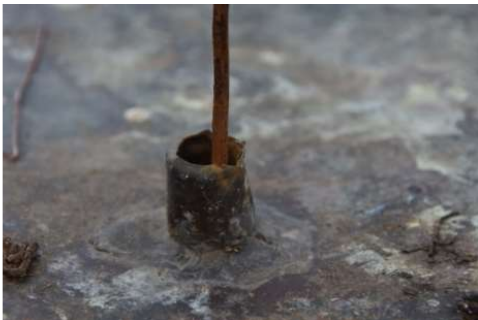
Fot. 276. Fragment stropu: brak uszczelnienia przy otworach technologicznych;
