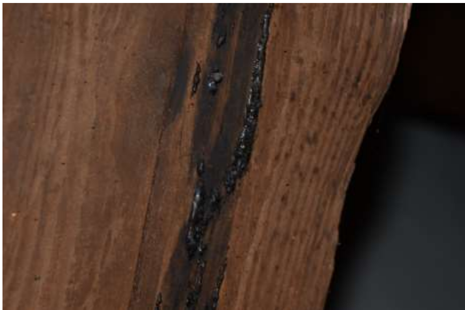
Fot. 130. Układ ramowy w osi 5-5: na powierzchni zastrzału smary;
