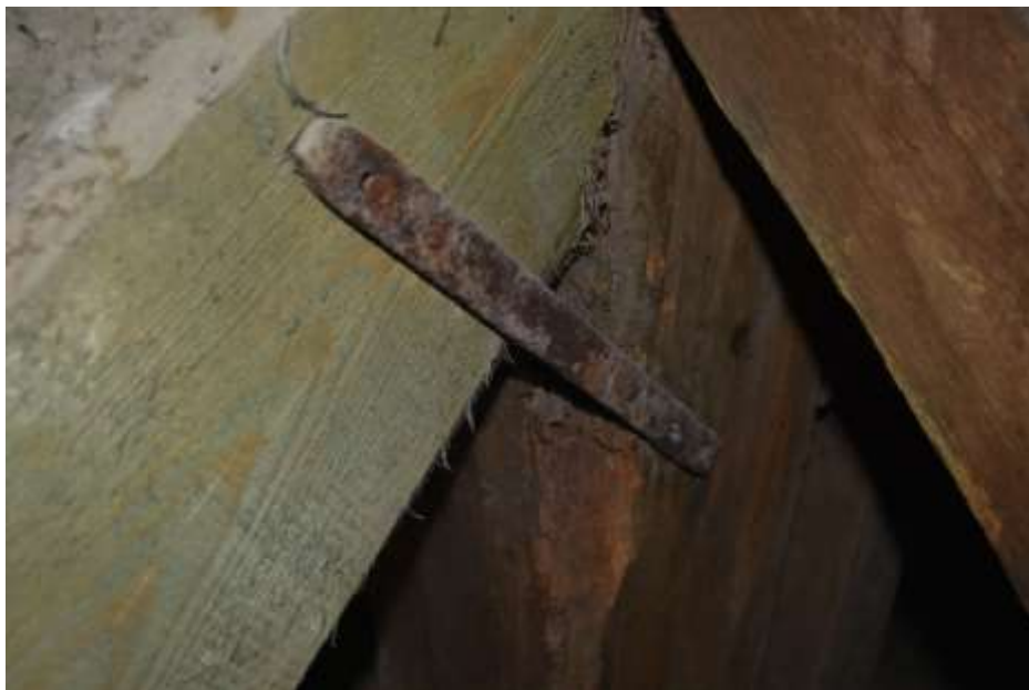
Fot. 29. Słup wieży: drewno skorodowane; ubytek struktury do 5 cm;
