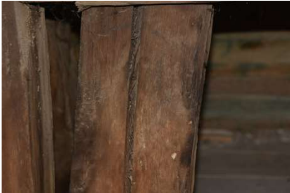
Fot. 73. Układ ściany w osi 9-9: zastrzał pomiędzy osiami A-C o przebiegu od podstawy słupa 9/A w kierunku 9/C; dolny odcinek z pęknięciami wzdłuż włókien;
