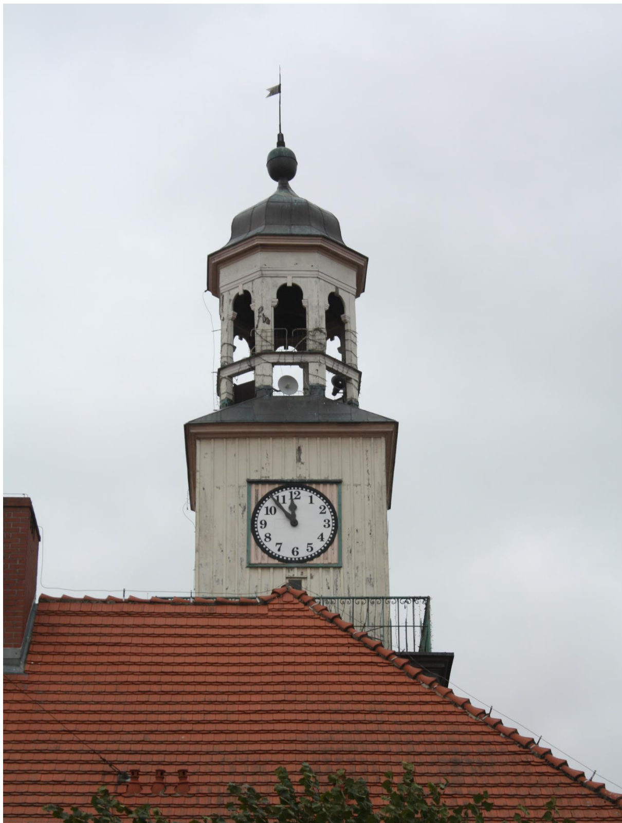
Fot. 30. Trzebiatów, ratusz, wieża zegarowa. Widok na wieżę od strony północnej. Na zdjęciu widoczne zużycie powłok dekoracyjno-ochronnych na wszystkich kondygnacjach wieży.
