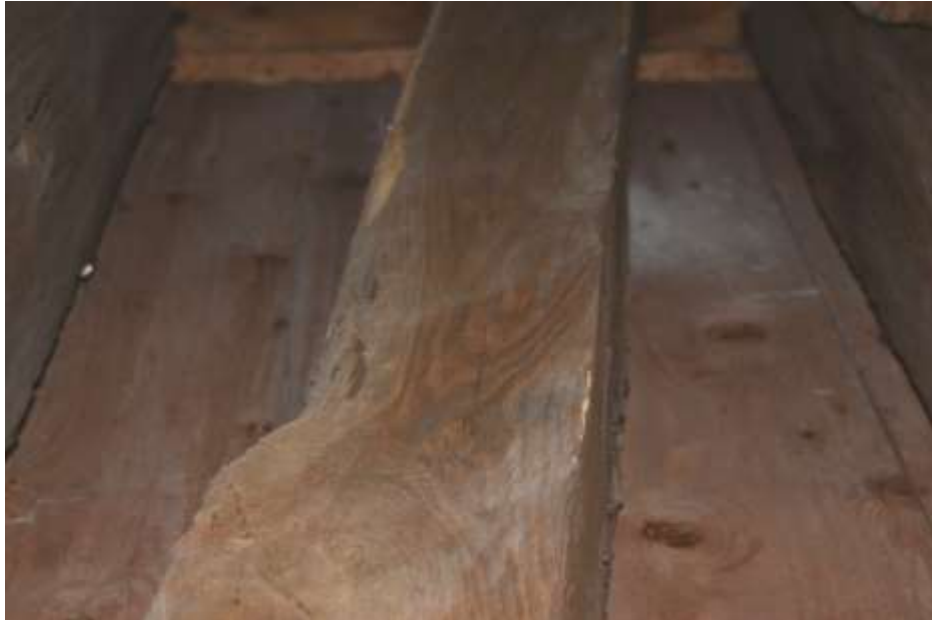
Fot. 155. Ściana w osi 2-2: zastrzał przy osi H-H o wymiarach 18x17 cm; w górnej części o zmniejszonym przekroju;
