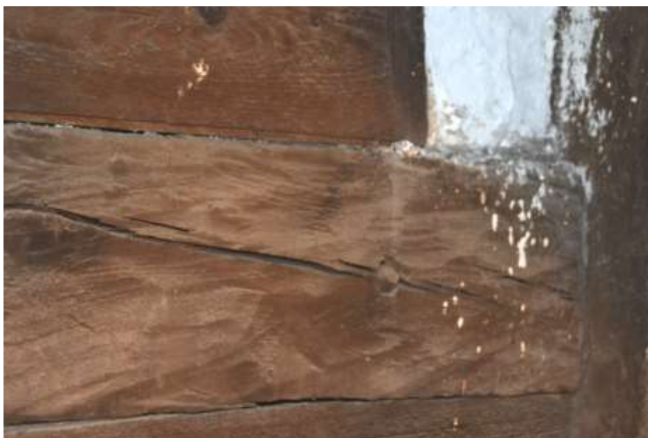
Fot. 93. Układ ściany w osi I-I: rygle w poziomie I o wymiarach 22x22 cm; na odcinku 1-3 rygiel z pęknięciami wzdłuż włókien;
