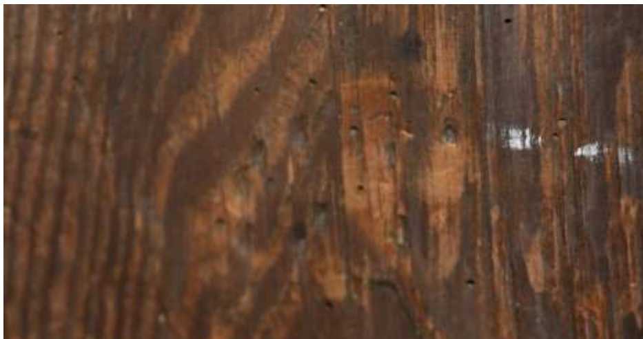
Fot. 152. Słup wieży: drewno porażone przez owady techniczne szkodniki drewna; na powierzchni widoczne otwory wylotowe;
