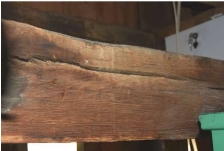
Fot. 189. Układ ramowy w osi 6-6: rygiel w poziomie VI o wymiarach 18x19 cm; drewno z pęknięciami wzdłuż włókien;
