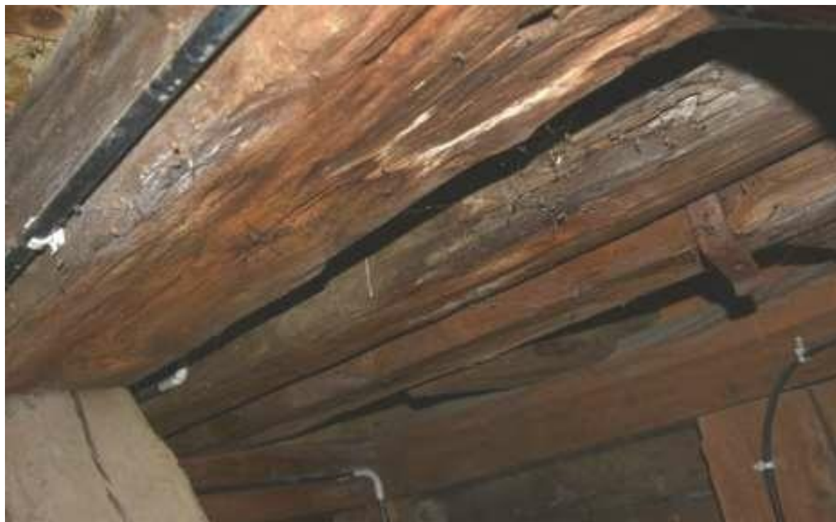
Fot. 56. Trzebiatów, ratusz, wieża zegarowa. Stan zachowania konstrukcji wieży jest zły. Występują liczne ogniska korozji biologicznej.
