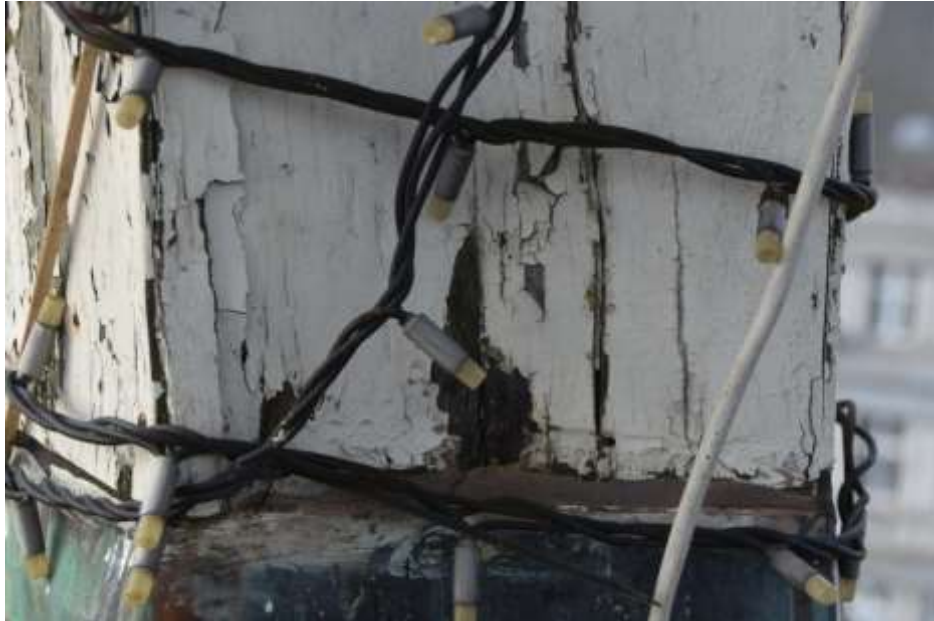
Fot. 212. Słup wieży: w dolnej części na słup wywinięta blacha miedziana; ślady uszczelnienia kitem na połączeniu; drewno zawilgocone; skorodowane;
