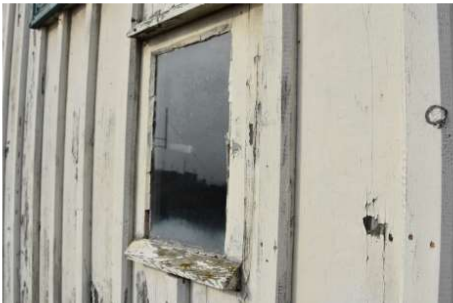
Fot. 310. Fragment elewacji: w ścianie niewielki otwór okienny; szklenie pojedyncze; nad otworem okiennym listwa drewniana; złuszczenia warstw malarskich;
