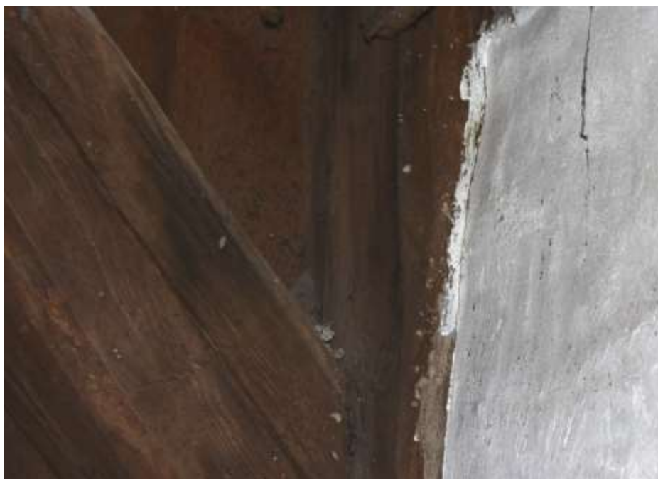
Fot. 25. Słup wieży: słup drewniany o wymiarach 25x22 cm; na powierzchni drewna zacieki;
