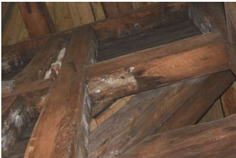
Fot. 67. Układ ściany w osi A-A: rygle III poziomu o wymiarach 20x20cm; na odcinku 3-5 zacieki; korozja biologiczna drewna;
