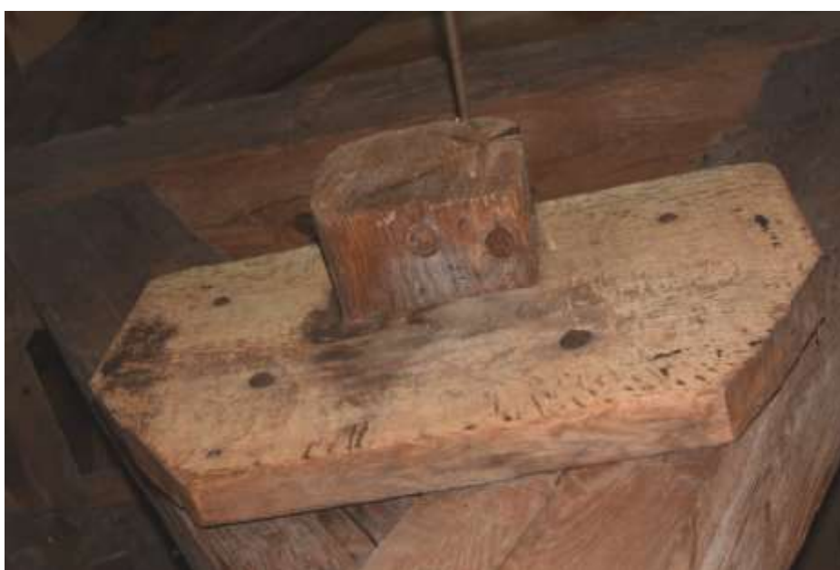
Fot. 180. Układ ramowy w osi D-D: pomiędzy zastrzałami widoczne jarzmo dawnej konstrukcji dzwonów;
