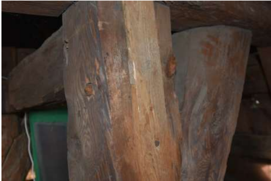
Fot. 151. Słup wieży: słup drewniany o wymiarach 17 x 18 cm; w słupie flek po usuniętych ryglu;
