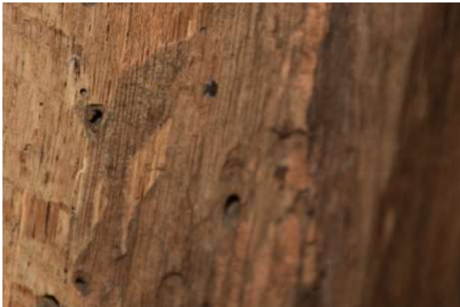
Fot. 156. Ściana w osi 2-2: drewno porażone przez owady techniczne szkodniki drewna; widoczne otwory wylotowe;
