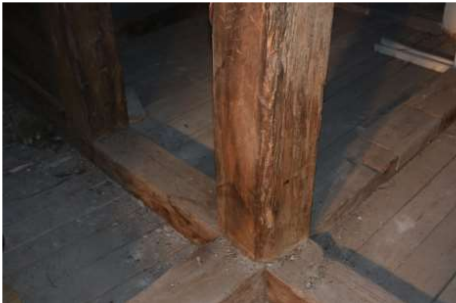
Fot. 84. Układ ściany w osi I-I: w poziomie posadzki poddasza (+7,76) podwalina drewniana o wymiarach 23x18 cm; na powierzchni drewna zacieki;
