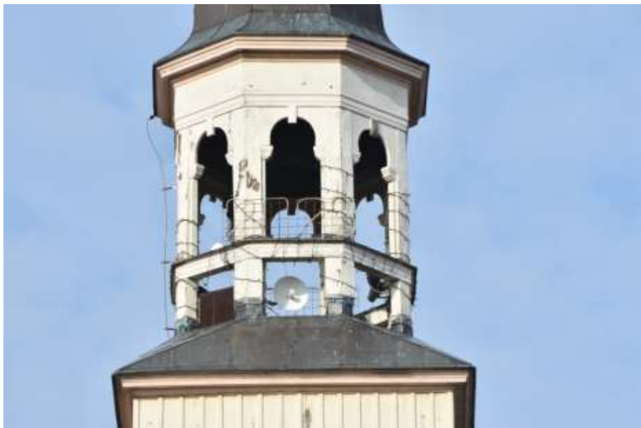
Fot. 314. Fragment elewacji: powyżej latarnia o konstrukcji drewnianej; słupy zaakcentowane płaskimi nadbitkami; drewno malowane; złuszczenia warstw malarskich;
