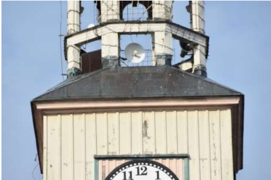
Fot. 313. Fragment elewacji: ponad gzymsem daszek pokryty blachą miedzianą; blacha wywinięta na dolne odcinki słupów latarni;
