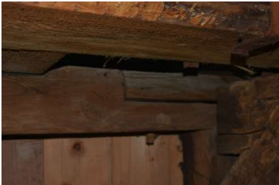
Fot. 164. Ściana w osi B-B: oczep na poziomie VIII częściowo wymieniony na odcinku 6-8;
