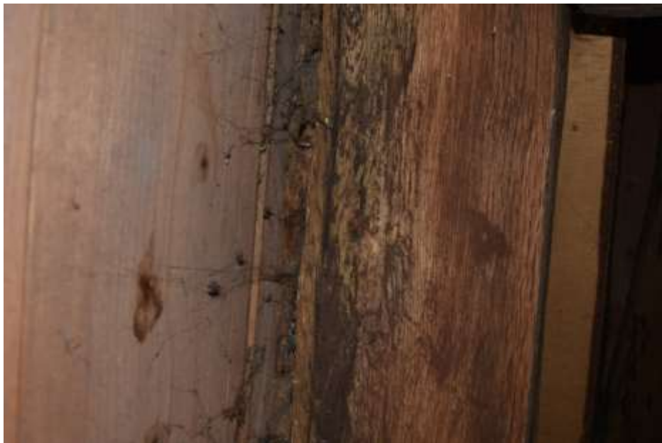
Fot. 138. Słup wieży: słup narożny; drewniany o wymiarach 18x17 cm; drewno słupa z ciemnymi nalotami;
