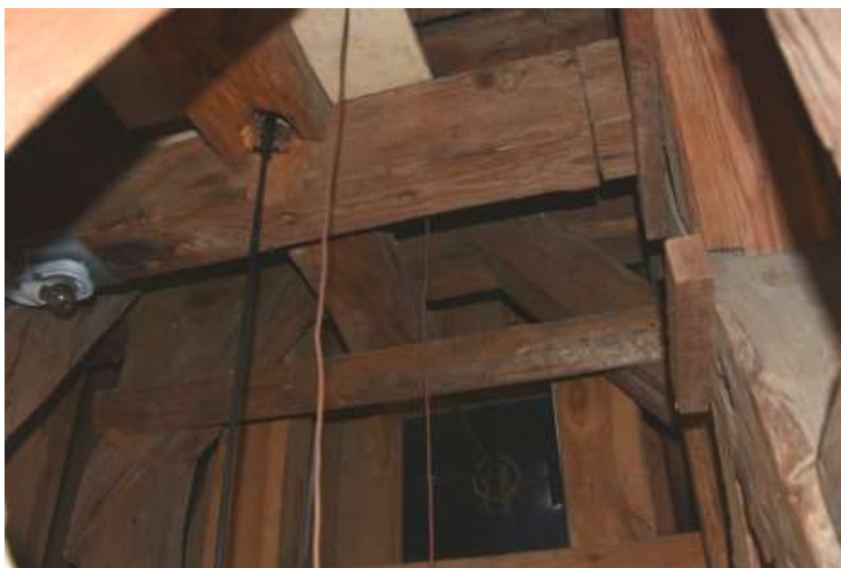
Fot. 192. Układ ramowy w osi 6-6: układ stężony zastrzałami typu X;
