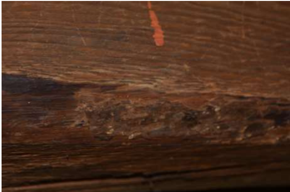
Fot. 248. Fragment stropu: drewno porażone przez owady techniczne szkodniki drewna;
