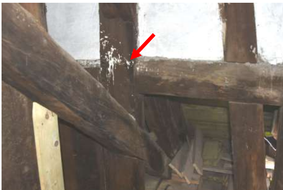
Fot. 26. Słup wieży: słup drewniany o wymiarach 25x23 cm; na powierzchni drewna zacieki; zabrudzenia farbą;
