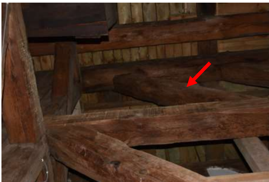
Fot. 107. Układ ramowy w osi G-G: górny poziomy zastrzałów z zaciekami;
