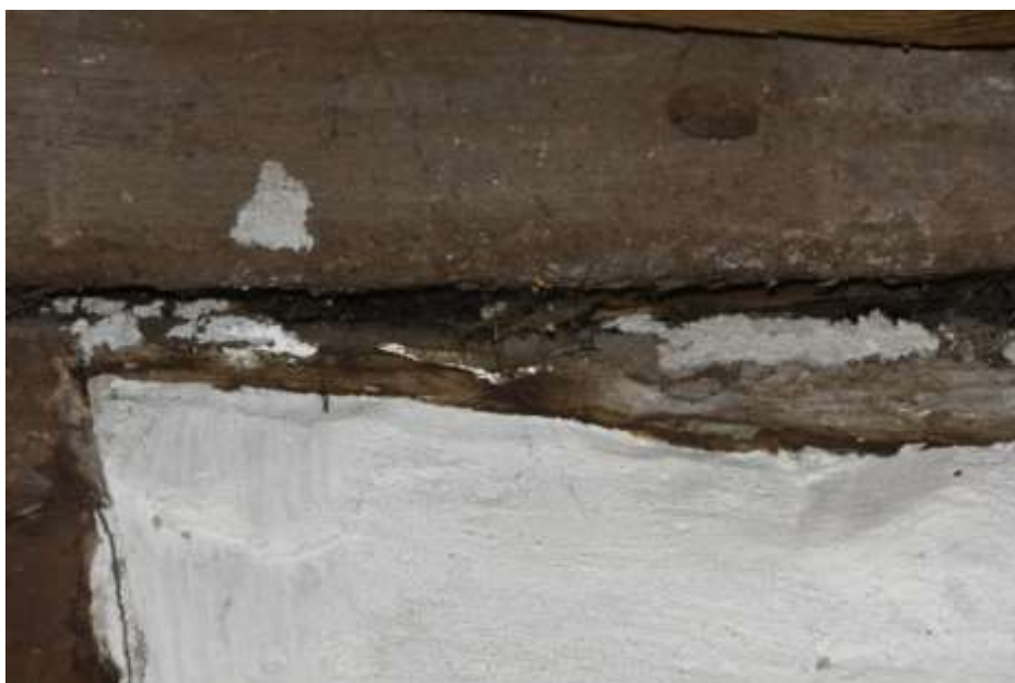
Fot. 79. Układ ściany w osi 9-9: na odcinku I-G rygiel rozwarstwiony; silnie porażony biologicznie;
