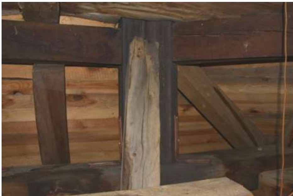
Fot. 219. Słup wieży: w przestrzeni pod zadaszeniem części zegarowej wieży słup zawilgocony; kotwiony do belki stropu dwoma kątownikami stalowymi; słup podparty zastrzałem; na powierzchni zastrzału zacieki;
