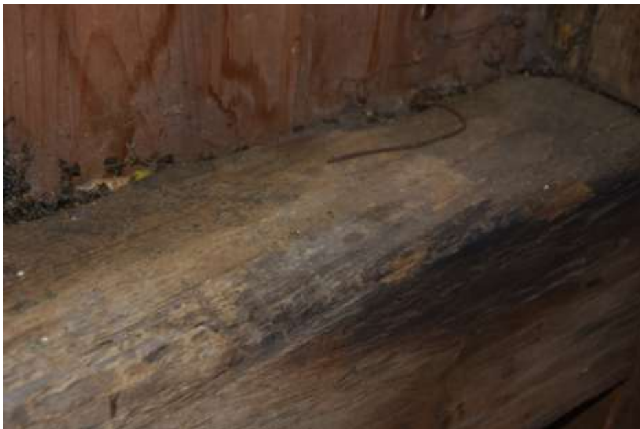
Fot. 158. Ściana w osi 2-2: drewno porażone przez owady techniczne szkodniki drewna; widoczne otwory wylotowe;
