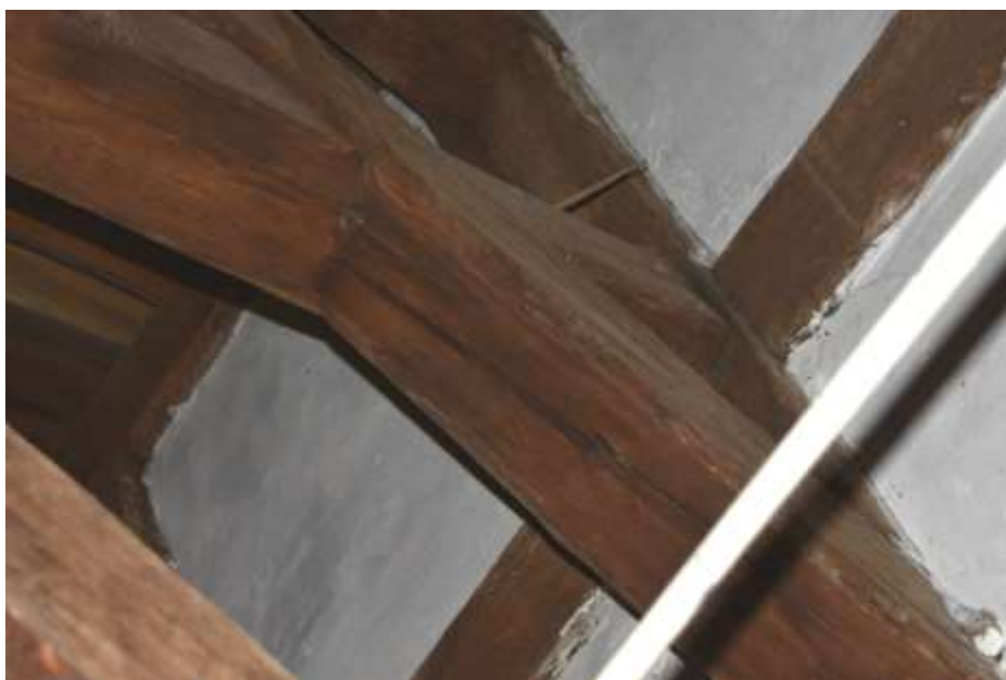
Fot. 116. Układ ramowy w osi E-E: górny poziomy zastrzał z zaciekami; pęknięciami wzdłuż włókien;
