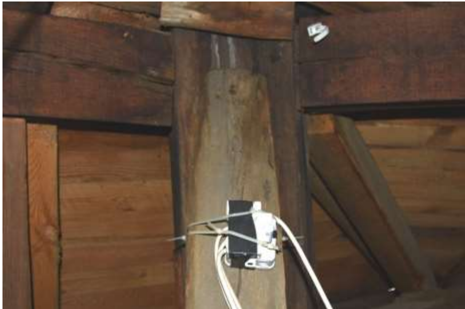
Fot. 233. Słup wieży: w przestrzeni pod zadaszeniem słup zawilgocony; porażony biologicznie; kotwiony do belki stropu dwoma kątownikami stalowymi; słup podparty zastrzałem; na powierzchni zastrzału zacieki;
