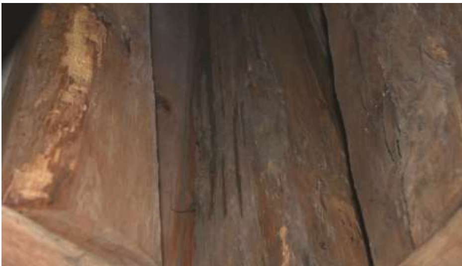
Fot. 148. Słup wieży: słup narożny; drewniany o wymiarach 22x18 cm; od strony deskowania nakładka grubości 3 cm; silnie porażona biologicznie; na powierzchni drewna zacieki;
