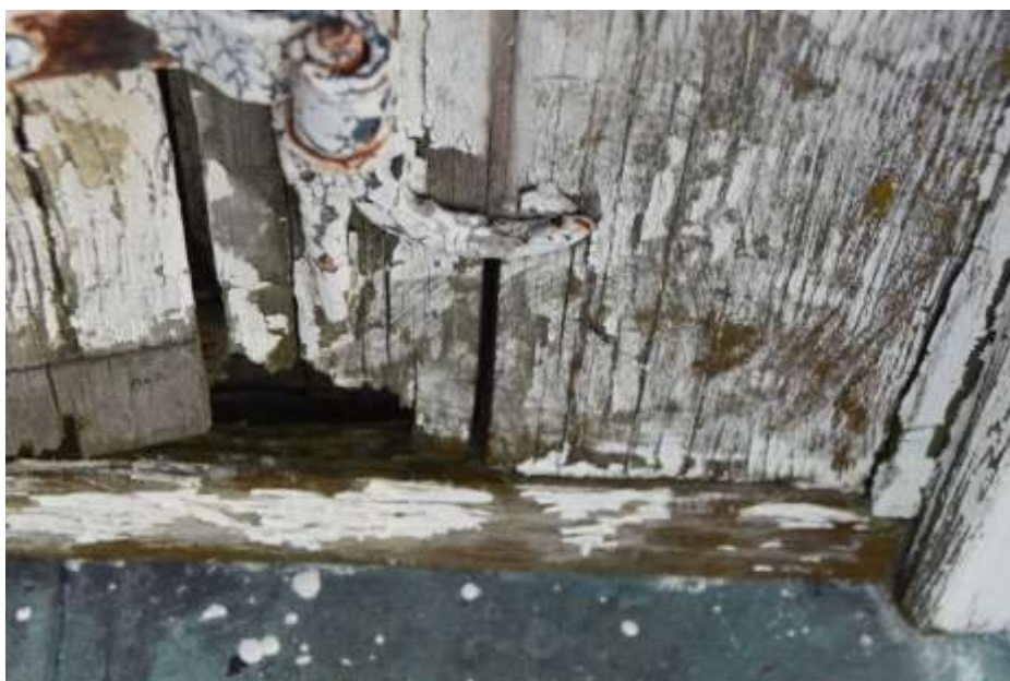
Fot. 326. Fragment elewacji: deskowanie w dolnej części skorodowane; porażone biologicznie;
