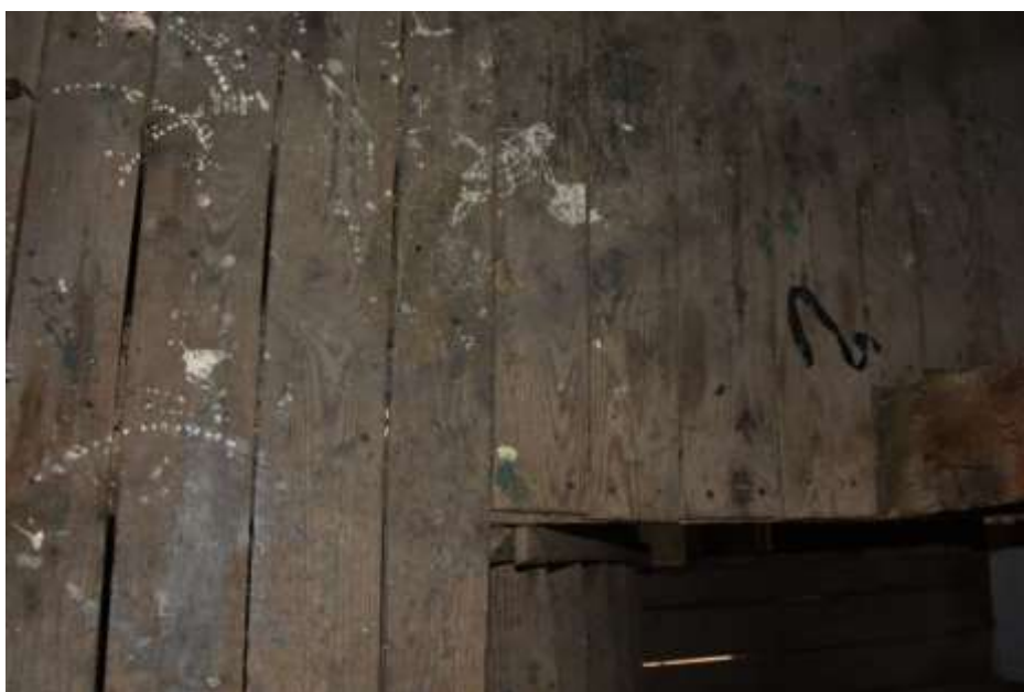
Fot. 254. Fragment stropu: podłoga z desek o grubości 3,2mm; na powierzchni zabrudzenia;
