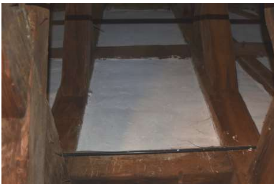
Fot. 54. Układ ściany w osi 1-1: ponad II poziomem rygli pola międzyszkieletowe wypełnione; tynkowane i malowane;
