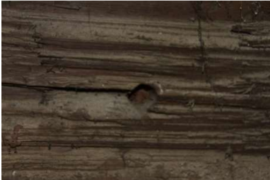
Fot. 60. Układ ściany w osi A-A: zerwany kołek na połączeniu z ryglem;
