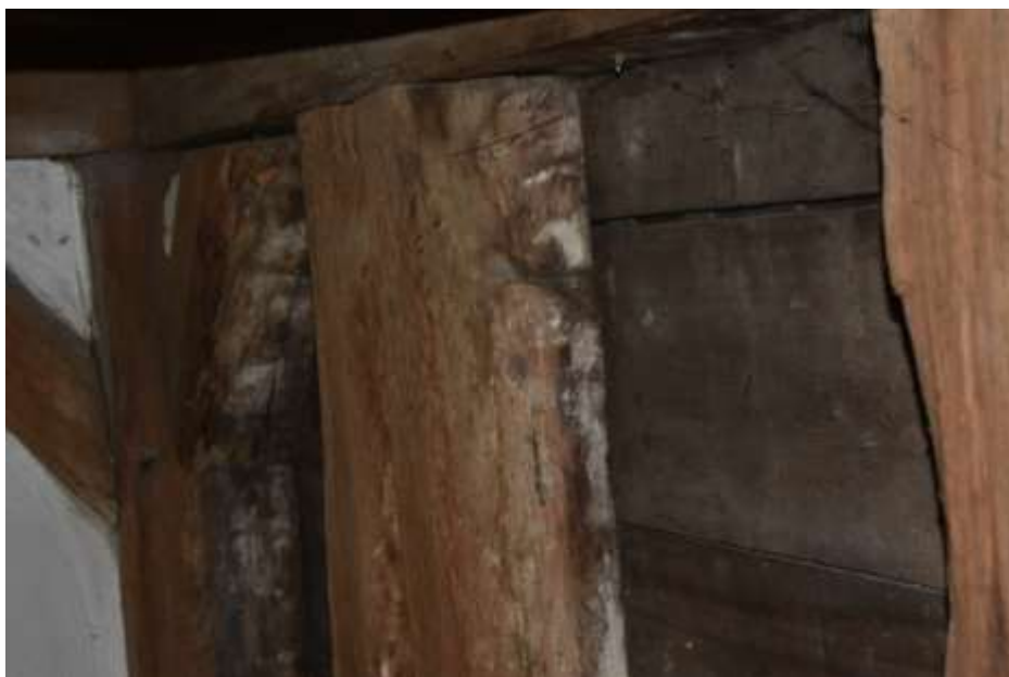
Fot. 14. Słup wieży: górna część słupa w partii pod stropem silnie porażona biologicznie;
