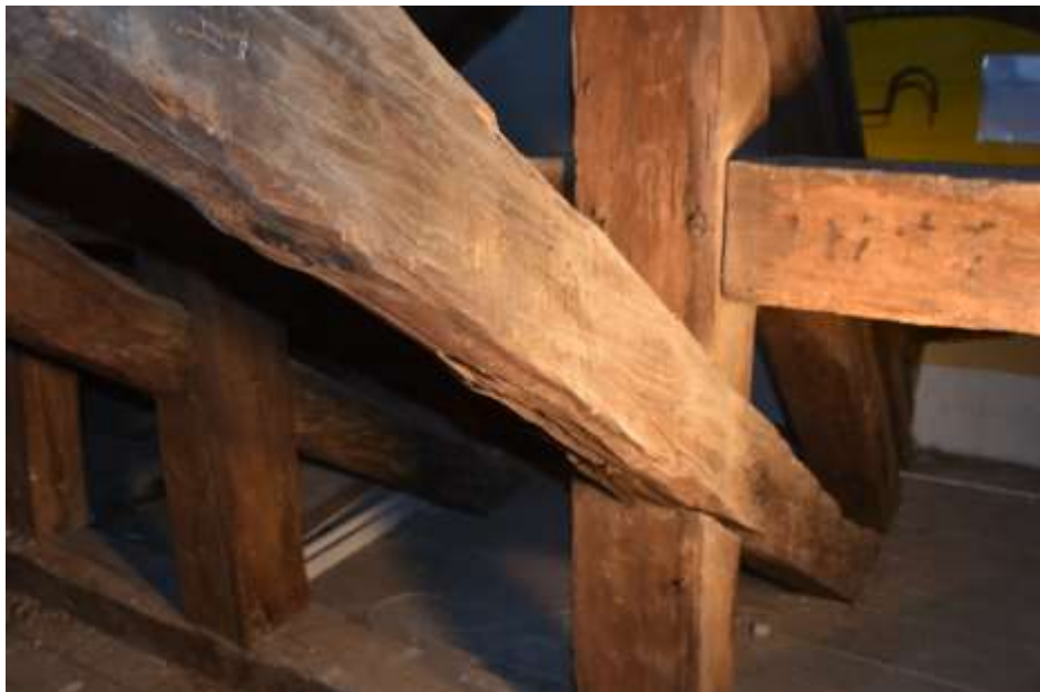
Fot. 112. Układ ramowy w osi E-E: zastrzały dolne o wymiarach 21x22 cm; o nieregularnym przekroju;
