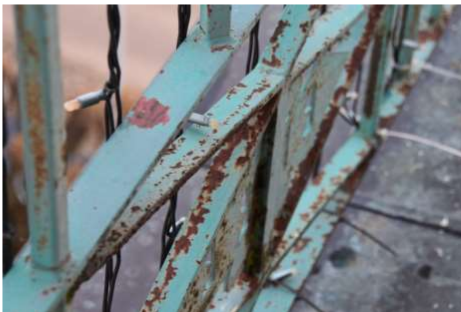
Fot. 343. Fragment elewacji: balustrada malowana; złuszczenia warstw malarskich; powierzchniowa korozja stali;
