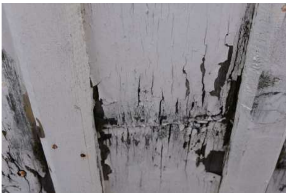
Fot. 344. Fragment elewacji: deski poszycia na pióro i wpust z listewkami na połączeniach; drewno malowane; skorodowane; złuszczenia warstw malarskich;
