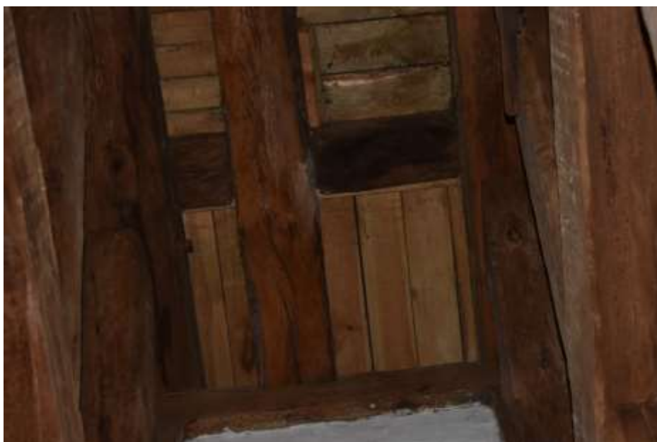
Fot. 249. Fragment stropu: belka w osi F-F z zaciekami; drewno z pęknięciami wzdłuż włókien;
