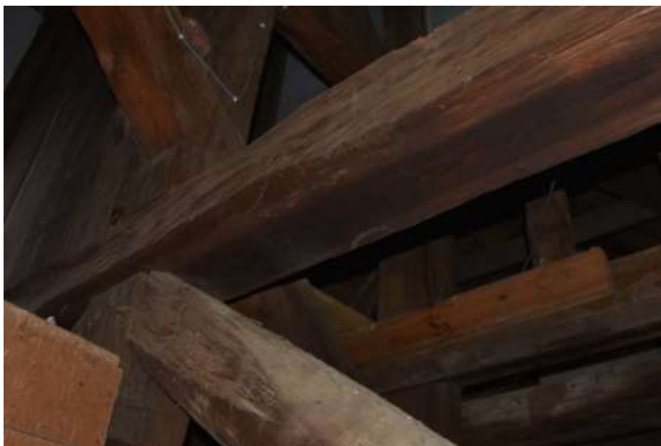
Fot. 108. Układ ramowy w osi G-G: rygle na poziomie II o wymiarach 20 x 22 cm; ze śladami ciosania toporem;
