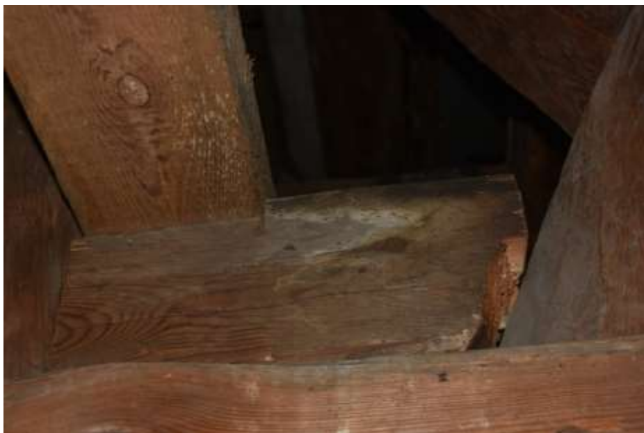
Fot. 176. Układ ramowy w osi D-D: na ryglu pomiędzy słupem 6/D a zastrzałem nakładka o wymiarach 16x16 cm;
