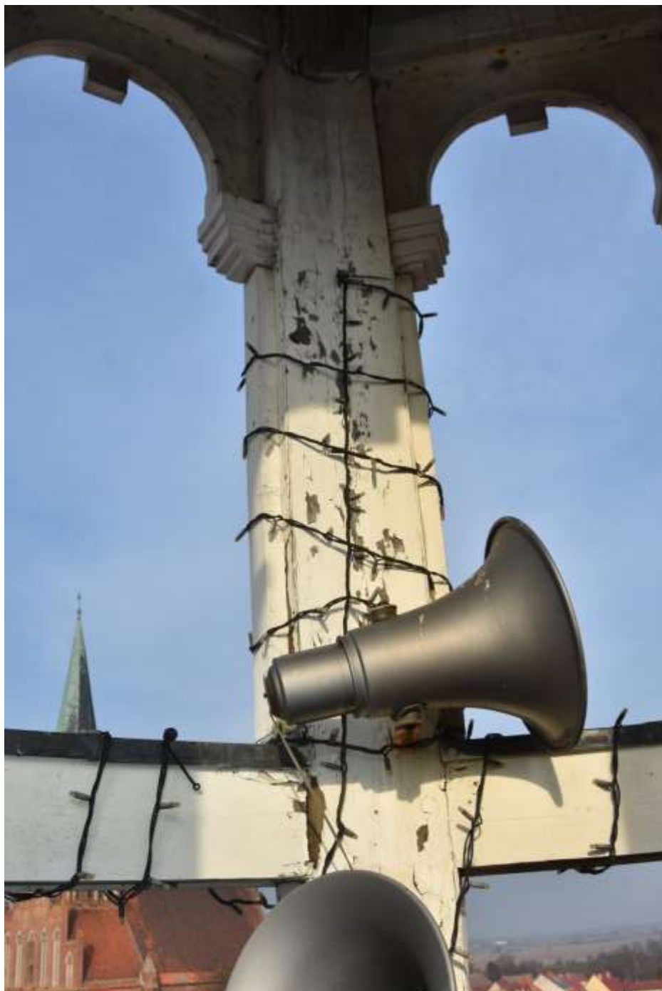
Fot. 217. Słup wieży: powyżej słup latarni malowany; złuszczenia warstw malarskich; na powierzchniach bocznych słupa warstwa ze sklejk gr. 2 mm;
