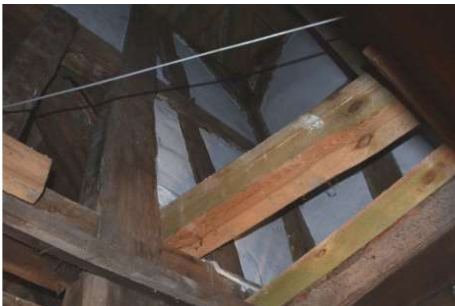
Fot. 90. Układ ściany w osi I-I: zastrzał pomiędzy osiami 1-3 o przebiegu od podstawy słupa 1/I w kierunku 3/I; o wymiarach 18x20 cm;
