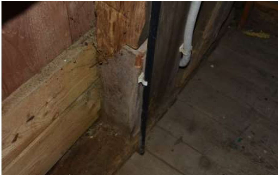
Fot. 149. Słup wieży: drewniany o wymiarach 25x17 cm; w dolnej części słup flekowany;
