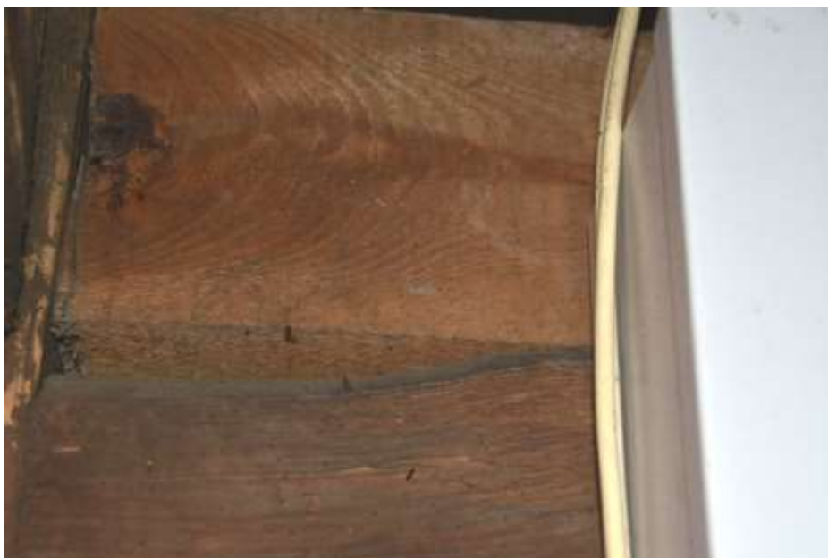
Fot. 184. Układ ramowy w osi F-F: na ryglu pomiędzy osiami 6-8 nakładka o wymiarach 17x17 cm;
