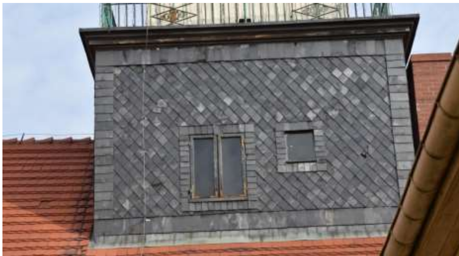
Fot. 316. Fragment elewacji: dolna część wieży z okładziną z łupka; w ścianie 2 otwory okienne o zróżnicowanych gabarytach;
