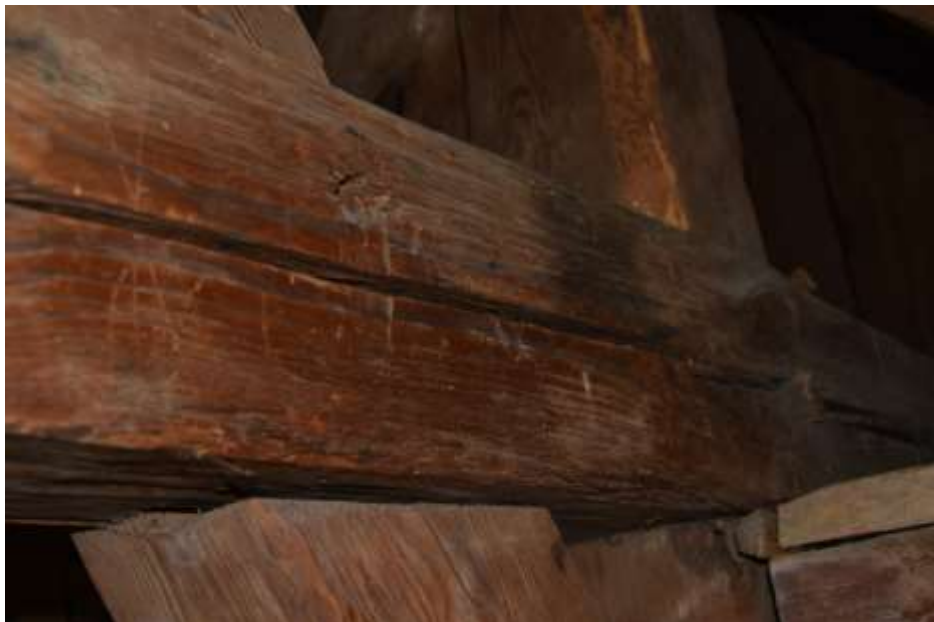
Fot. 174. Układ ramowy w osi D-D: rygiel w poziomie VI o wymiarach 20x22 cm; drewno z pęknięciami wzdłuż włókien;
