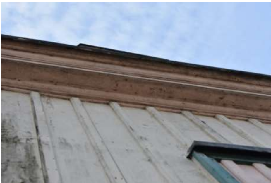
Fot. 296. Fragment elewacji: ściana zwieńczona wysuniętym profilowanym gzymsem drewnianym; na powierzchni zacieki; złuszczenia warstw malarskich;
