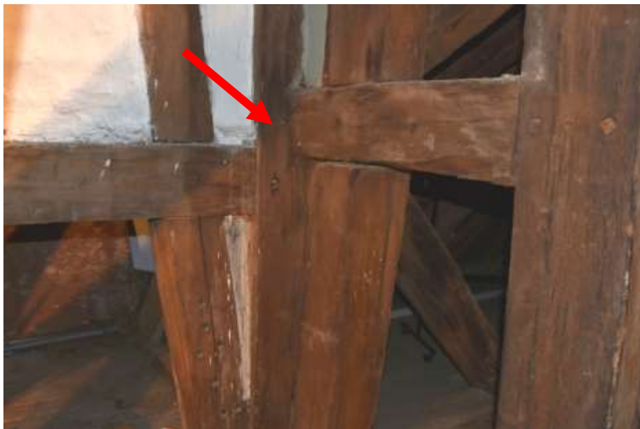
Fot. 9. Słup wieży: słup narożny; drewniany o wymiarach 30x24 cm; drewno z zaciekami; z pęknięciami wzdłuż włókien;
