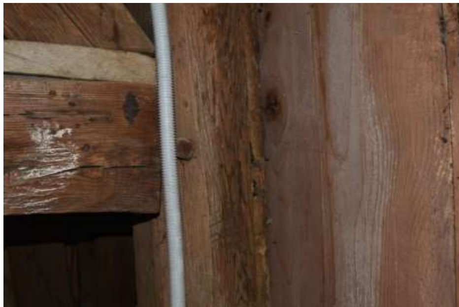
Fot. 150. Słup wieży: drewniany o wymiarach 25x17 cm; od strony deskowania nakładka grubości 3-4 cm; silnie porażona biologicznie;
