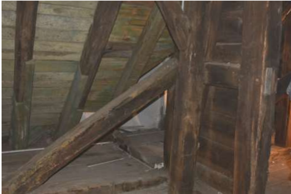
Fot. 43. Układ ściany w osi 1-1; przy słupie 1/I zastrzał o wymiarach 23x23 cm;
