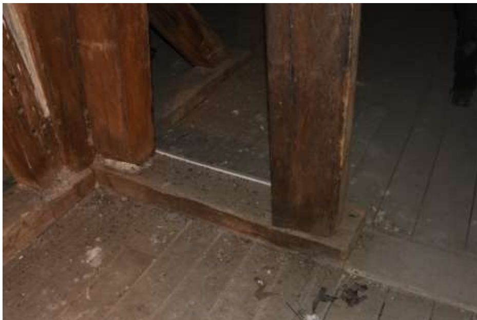
Fot. 57. Układ ściany w osi A-A: w poziomie posadzki poddasza (+7,76) podwalina drewniana o wymiarach 23x14 cm; na odcinku 3-5 usunięta;
