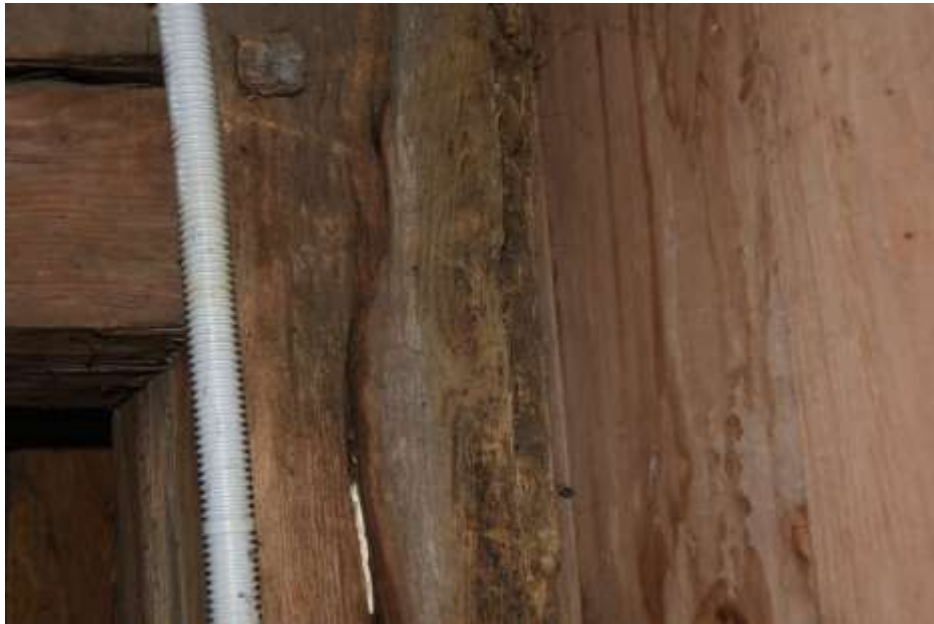
Fot. 141. Słup wieży: słup połączony z podwaliną elementem stalowym;
