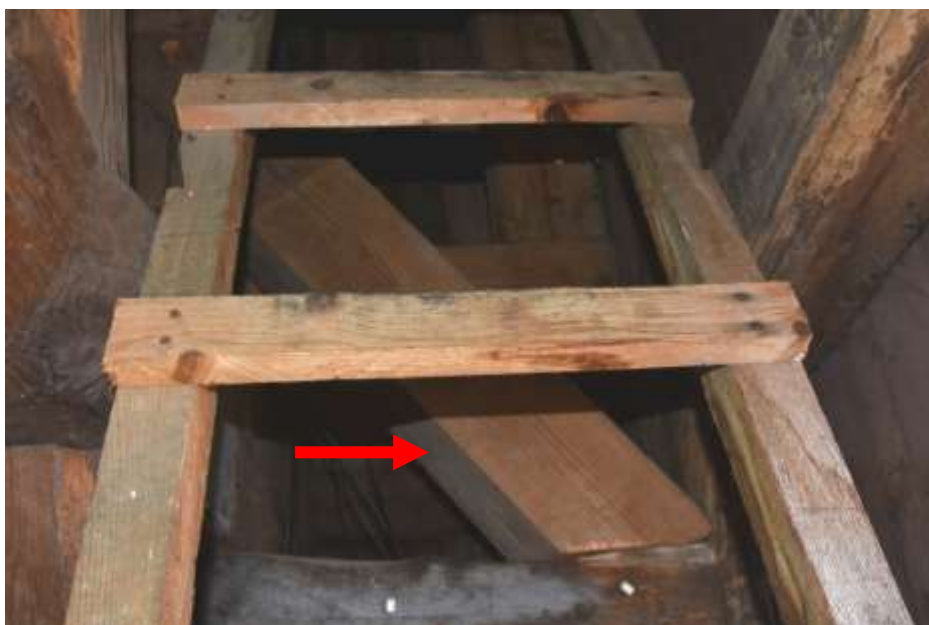
Fot. 194. Układ ramowy w osi 6-6: na odcinku F-H dolny fragment zastrzału wymieniony sztuką nowego drewna;
