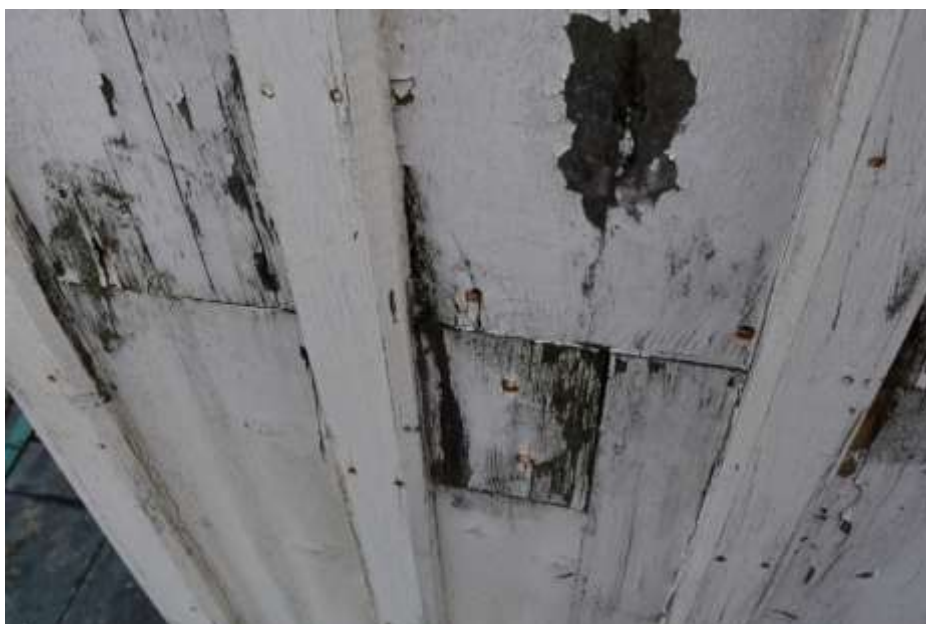
Fot. 346. Fragment elewacji: lokalnie wstawki; drewno skorodowane;
