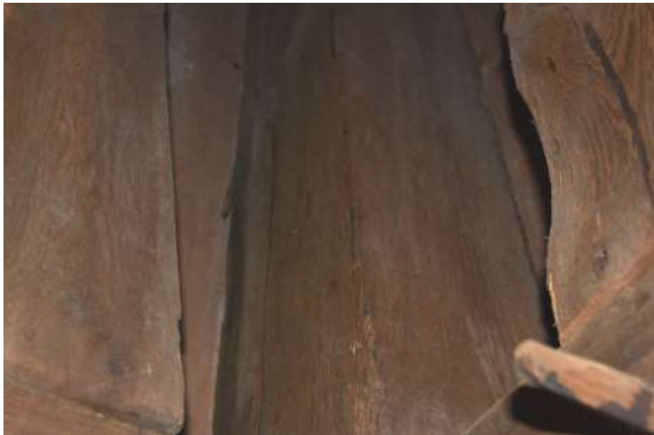
Fot. 142. Słup wieży: słup narożny; drewniany o wymiarach 20x19 cm; drewno słupa z ciemnymi nalotami;
