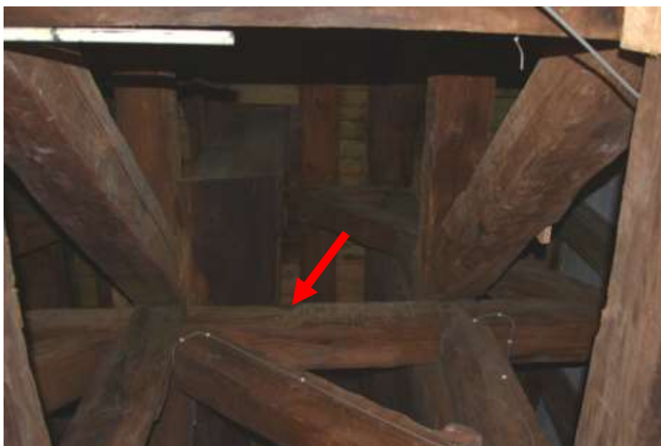
Fot. 134. Układ ramowy w osi 5-5: w poziomie III rygiel o wymiarach 21x22 cm;
