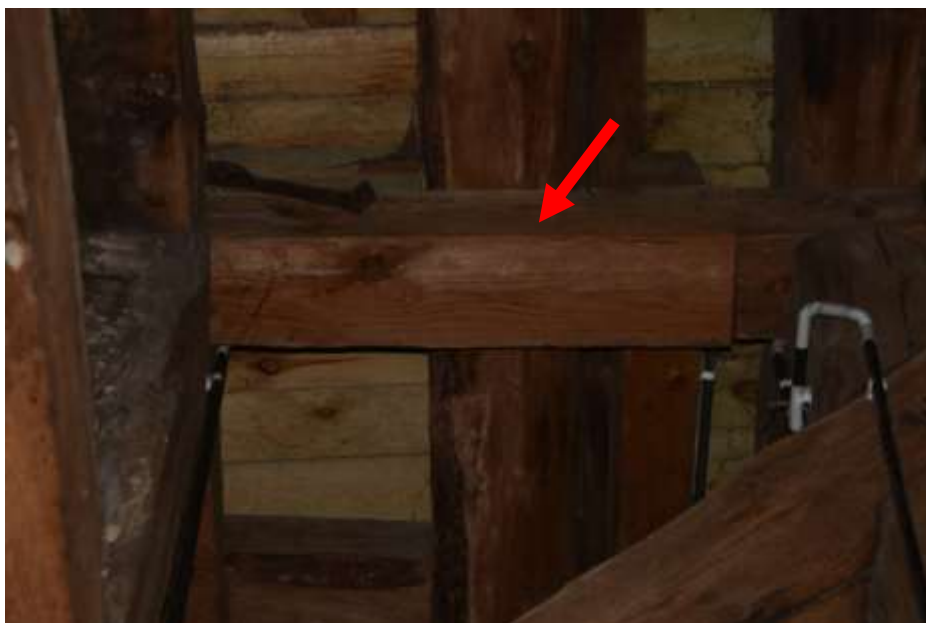
Fot. 136. Układ ramowy w osi 5-5: na odcinku A-C wymieniony sztuką nowego drewna;
