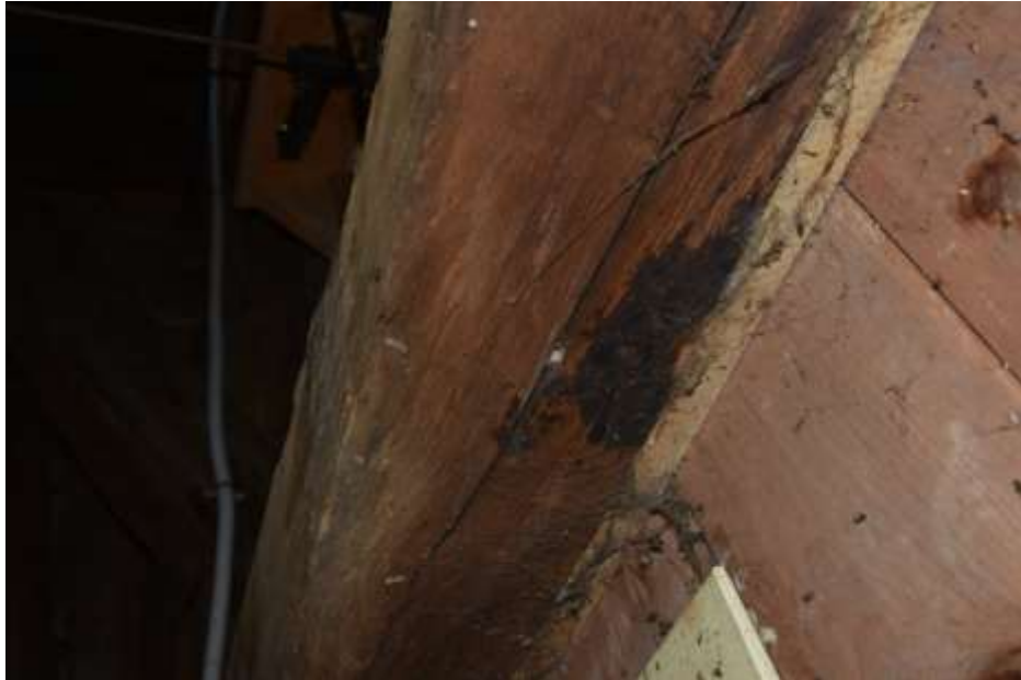
Fot. 159. Ściana w osi 2-2: rygle w poziomie VI z zaciekami; od strony deskowania nakładka grubości 3 cm porażona biologicznie; na powierzchni drewna ciemne zabrudzenia;
