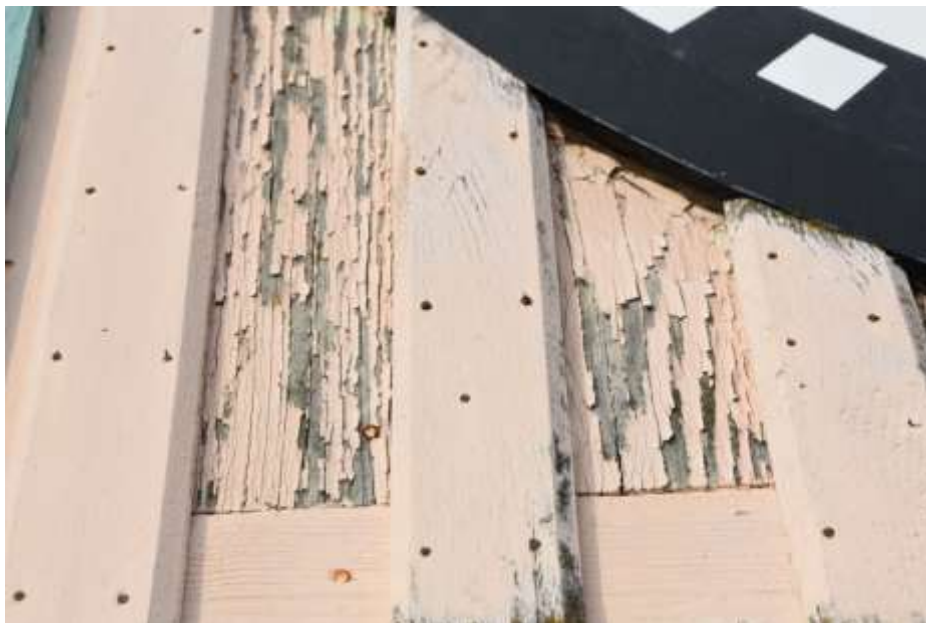
Fot. 311. Fragment elewacji: tarcza zegarowa z blachy stalowej; wokół tarczy deski drewniane z listewkami na połączeniach; deski malowane; złuszczenia warstw malarskich;
