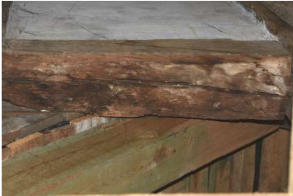
Fot. 99. Układ ściany w osi I-I: rygle III poziomu o wymiarach 22x21cm; drewno silnie skorodowane; z pęknięciami wzdłuż włókien;
