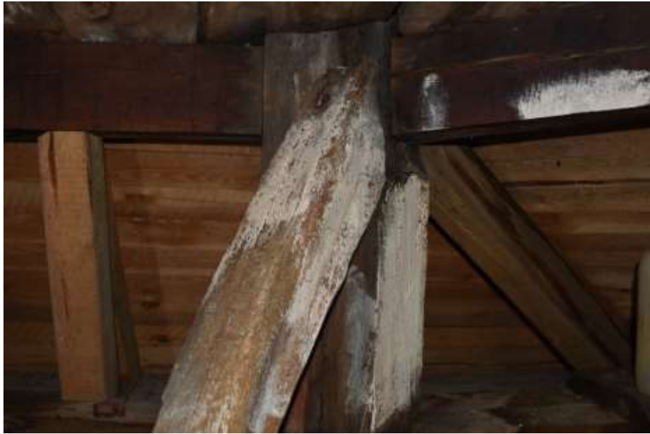
Fot. 226. Słup wieży: w przestrzeni pod zadaszeniem części zegarowej wieży słup zawilgocony; porażony biologicznie; drewno słupa i zastrzału silnie porażone przez grzyb;
