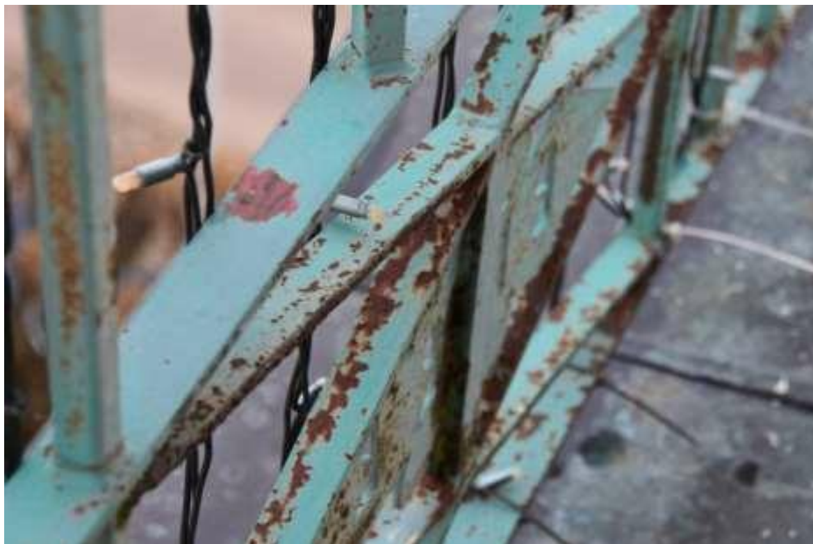
Fot. 37. Trzebiatów, ratusz, wieża zegarowa. Balustrada tarasu jest skorodowana, warstwa zabezpieczająca złuszcza się na całej powierzchni.
