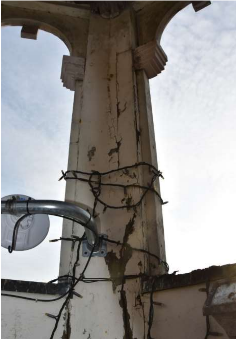
Fot. 231. Słup wieży: powyżej słup latarni malowany; złuszczenia warstw malarskich; na powierzchniach bocznych słupa warstwa ze sklejki gr. 2 mm;
