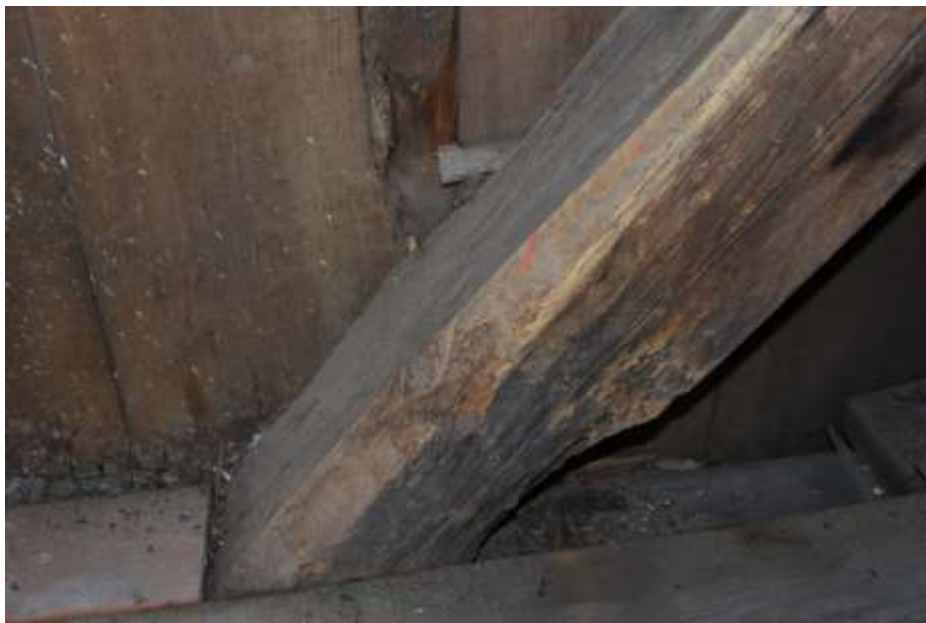
Fot. 117. Układ ramowy w osi E-E: zastrzał przy schodach skorodowany; porażony przez owady techniczne szkodniki drewna;
