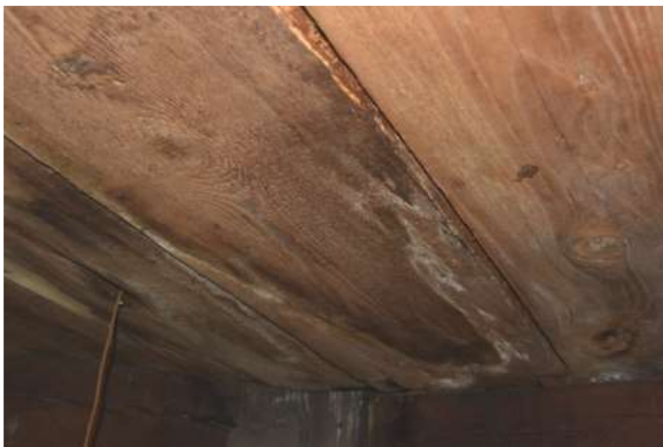
Fot. 273. Fragment stropu: deskowanie z zaciekami;
