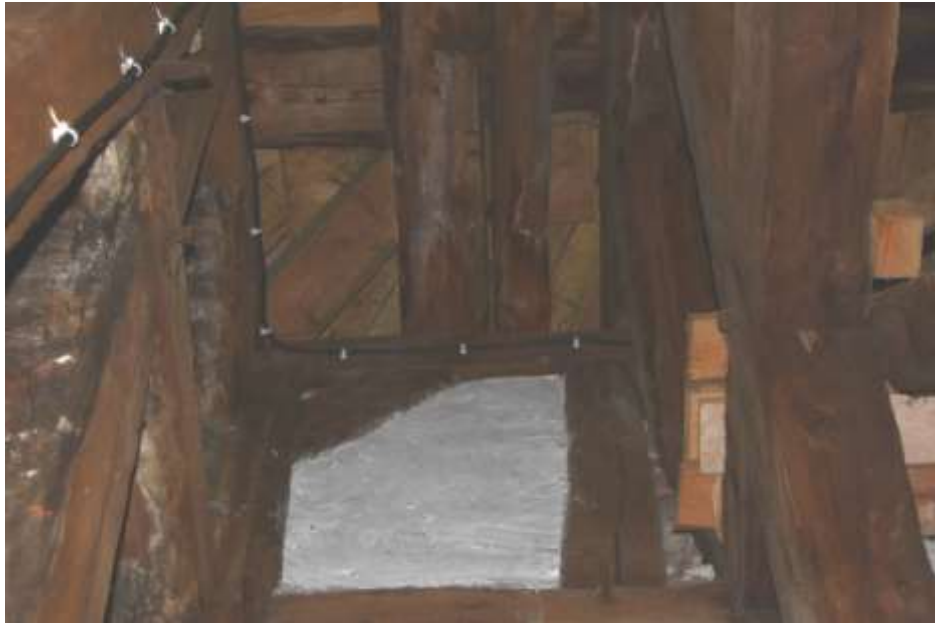
Fot. 83. Układ ściany w osi 9-9: oczep w poziomie IV o wymiarach 22x21 cm; na powierzchni drewna zacieki;
