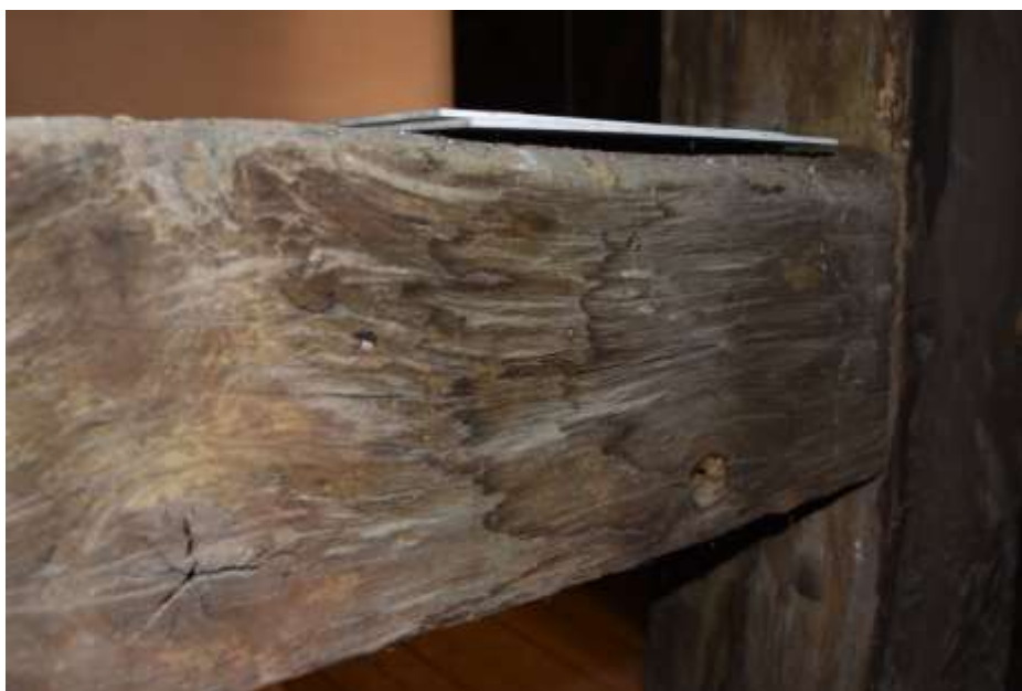
Fot. 95. Układ ściany w osi I-I: na odcinku 5-7 rygiel z zaciekami; powierzchniowa korozja drewna;
