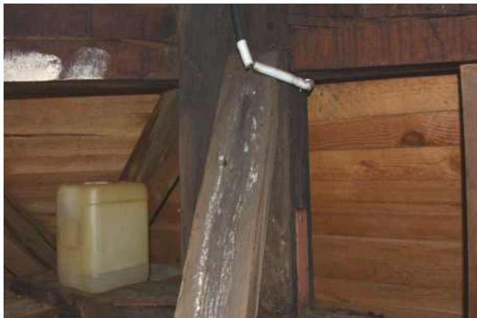
Fot. 230. Słup wieży: w przestrzeni pod zadaszeniem słup zawilgocony; porażony biologicznie; kotwiony do belki stropu dwoma kątownikami stalowymi; słup podparty zastrzałem; na powierzchni zastrzału zacieki;
