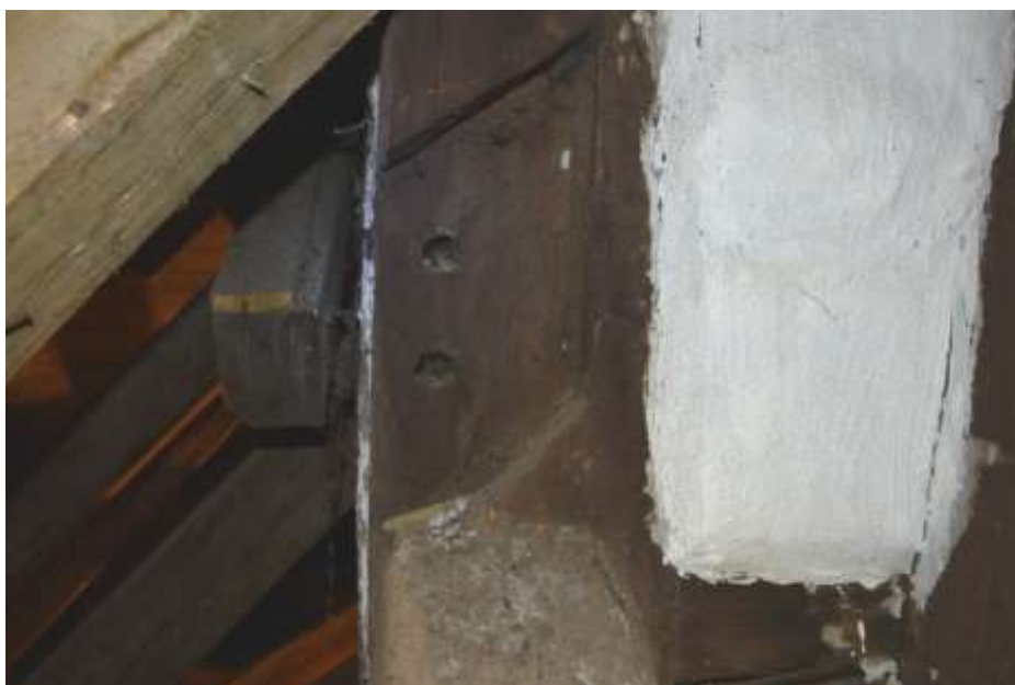
Fot. 92. Układ ściany w osi I-I: zastrzał przy słupie 1/I usunięty; w słupie puste gniazdo;
