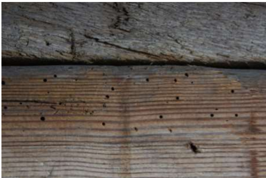
Fot. 201. Układ ramowy w osi 4-4: drewno rygla porażone przez owady techniczne szkodniki drewna; widoczne otwory wylotowe;
