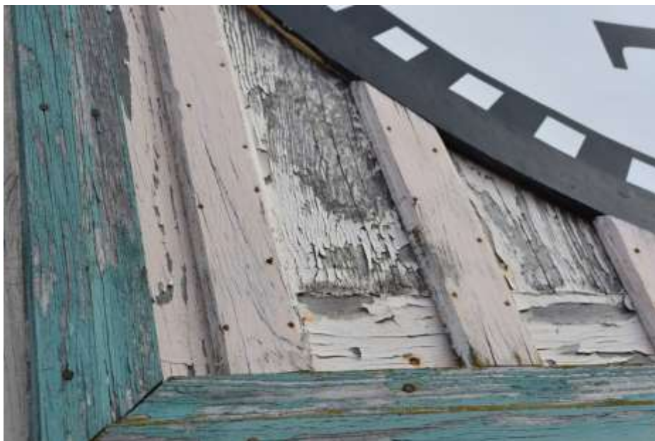
Fot. 331. Fragment elewacji: tarcza zegarowa z blachy stalowej; wokół tarczy deski drewniane z listewkami na połączeniach; deski malowane; złuszczenia warstw malarskich;
