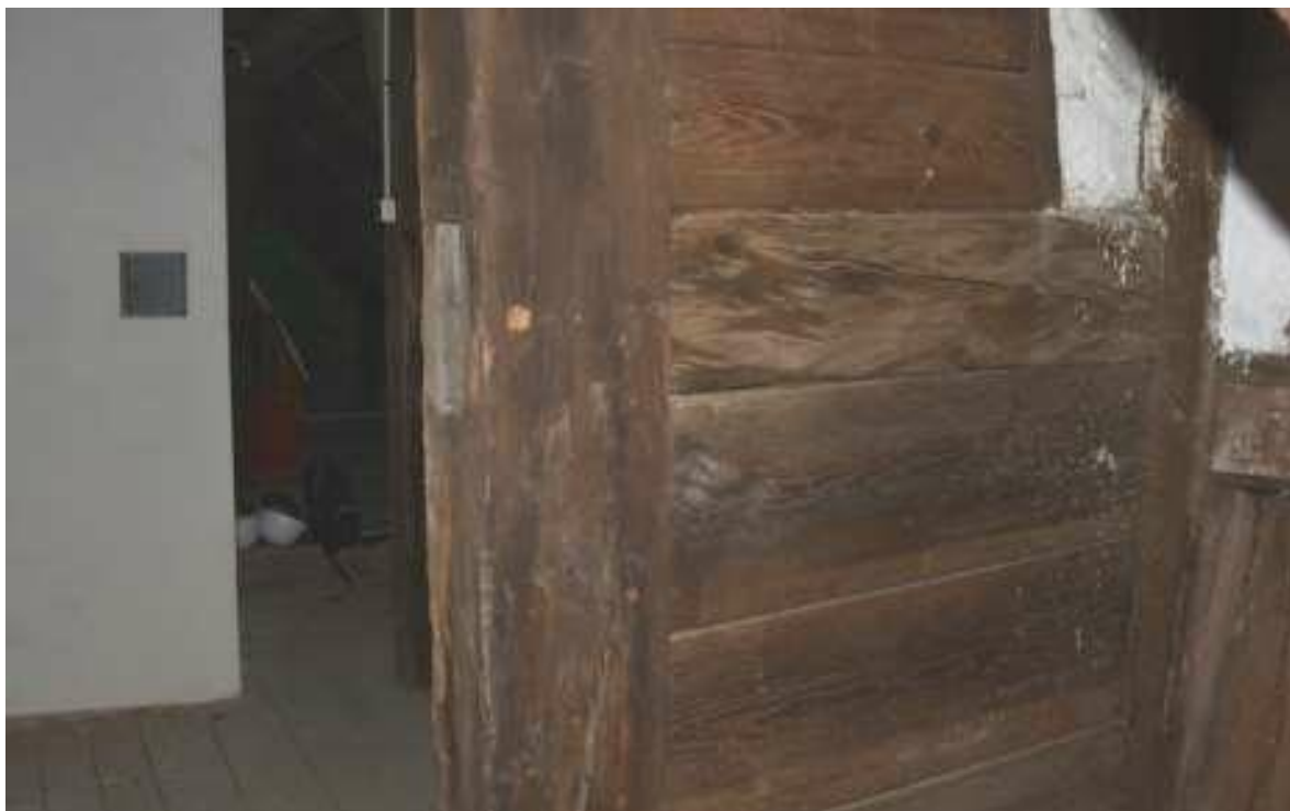
Fot. 44. Trzebiatów, ratusz, wieża zegarowa. Stan zachowania konstrukcji wieży jest zły. Występują liczne braki elementów konstrukcyjnych.
