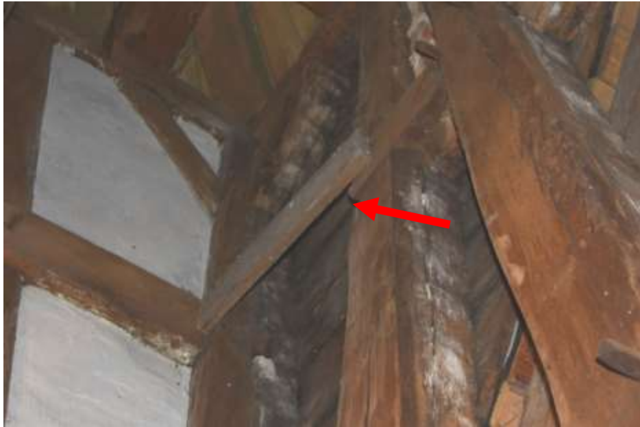
Fot. 69. Układ ściany w osi A-A: brak rygla pomiędzy słupem 1/A i zastrzałem;
