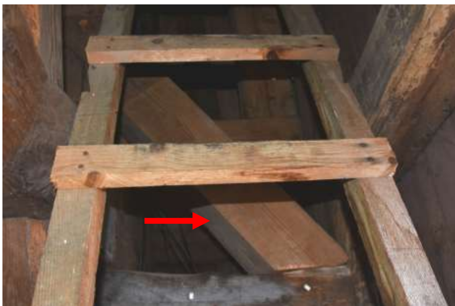
Fot. 206. Układ ramowy w osi 4-4: na odcinku F-H dolny fragment zastrzału wymieniony sztuką nowego drewna;
