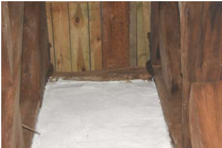
Fot. 56. Układ ściany w osi 1-1: oczep o wymiarach 20x20 cm; na powierzchni drewna zacieki;
