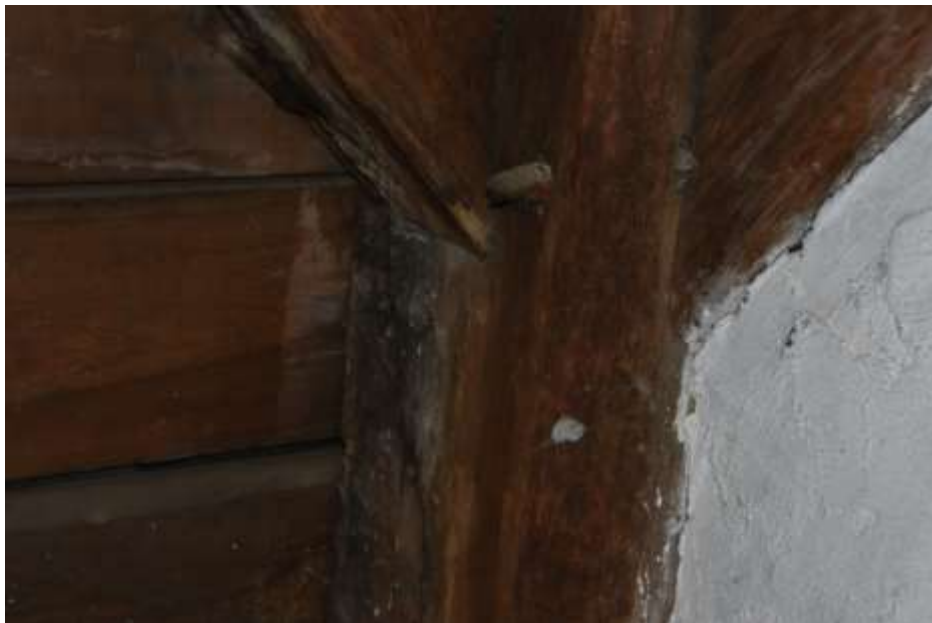
Fot. 24. Słup wieży: poniżej poziomu mieczy drewno słupa porażone biologicznie;
