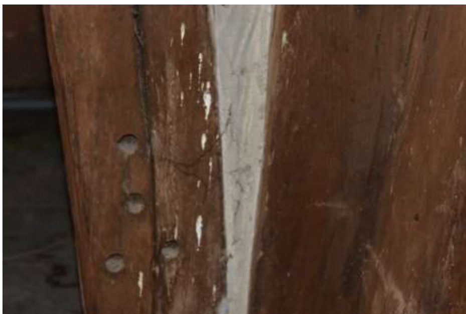
Fot. 47. Układ ściany w osi 1-1: drewno zastrzału z pęknięciami wzdłuż włókien; u podstawy widoczne nawiercone otwory;
