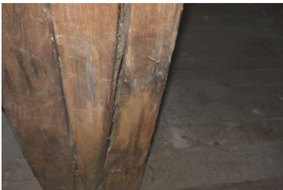
Fot. 16. Słup wieży: słup w dolnej części rozłupany; szczelina do 3 cm; - puste gniazdo po wyciętym ryglu I (rys. E5 – załącznik nr 1) poziomu flekowane sztuką nowego drewna;
