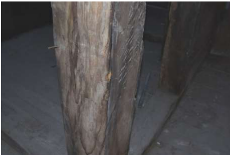
Fot. 31. Słup wieży: słup drewniany o wymiarach 25x22 cm; na powierzchni drewna zacieki;
