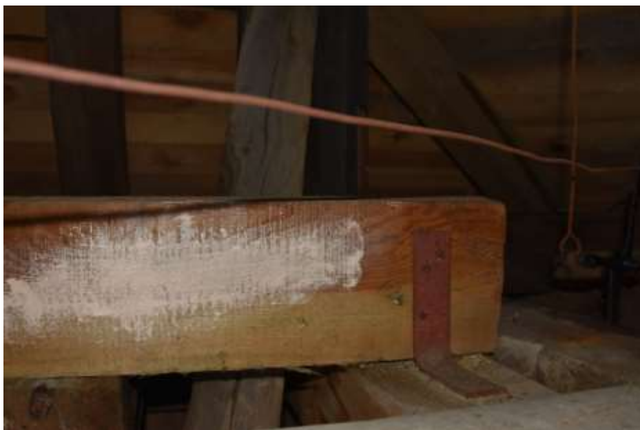
Fot. 268. Fragment stropu: przy osi F-F na odcinku 2-8 belka ze sztuki nowego drewna o wymiarach 18x20 cm;
