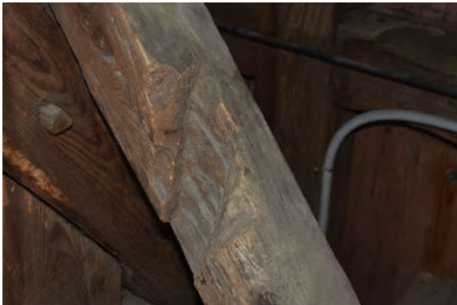
Fot. 208. Układ ramowy w osi 4-4: zastrzał przy słupie 4/F w wyciętym gniazdem;
