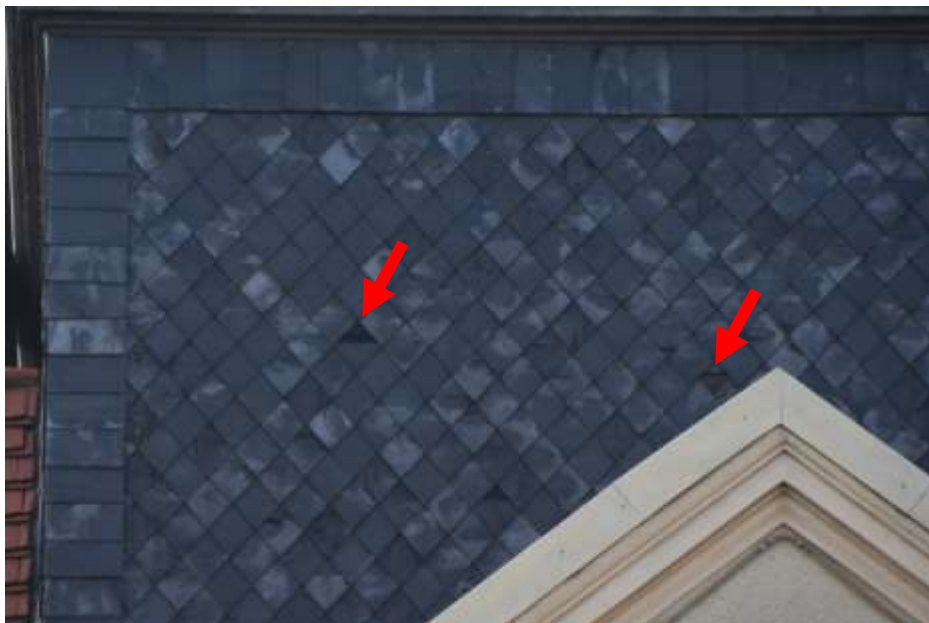
Fot. 284. Fragment elewacji: lokalnie uszkodzenia okładziny; ubytki łupka;
