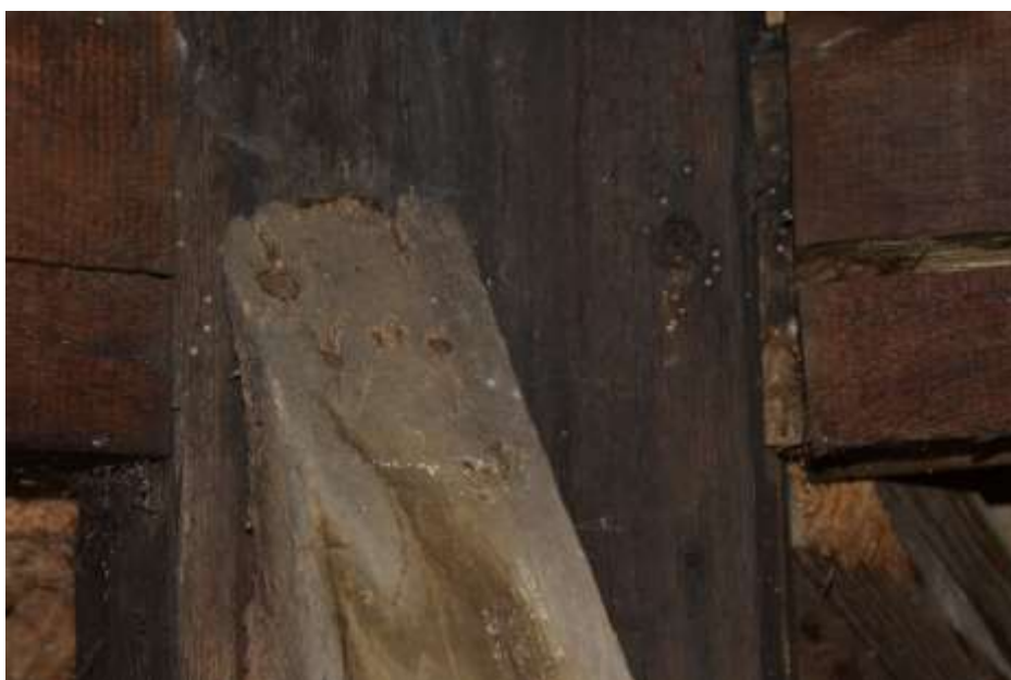
Fot. 210. Słup wieży: końcówka silnie porażona biologicznie; drewno w stanie rozkładu;
