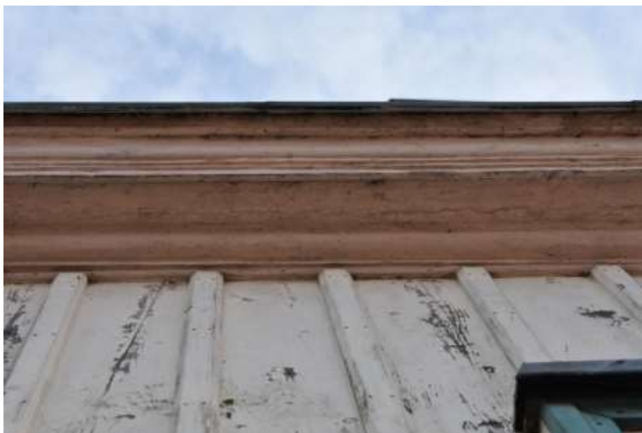
Fot. 350. Fragment elewacji: ściana zwieńczona wysuniętym profilowanym gzymsem drewnianym; na powierzchni zacieki; złuszczenia warstw malarskich;
