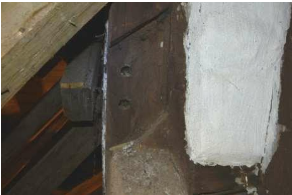
Fot. 42. Trzebiatów, ratusz, wieża zegarowa. Stan zachowania konstrukcji wieży jest zły. Występują liczne braki elementów konstrukcyjnych.
