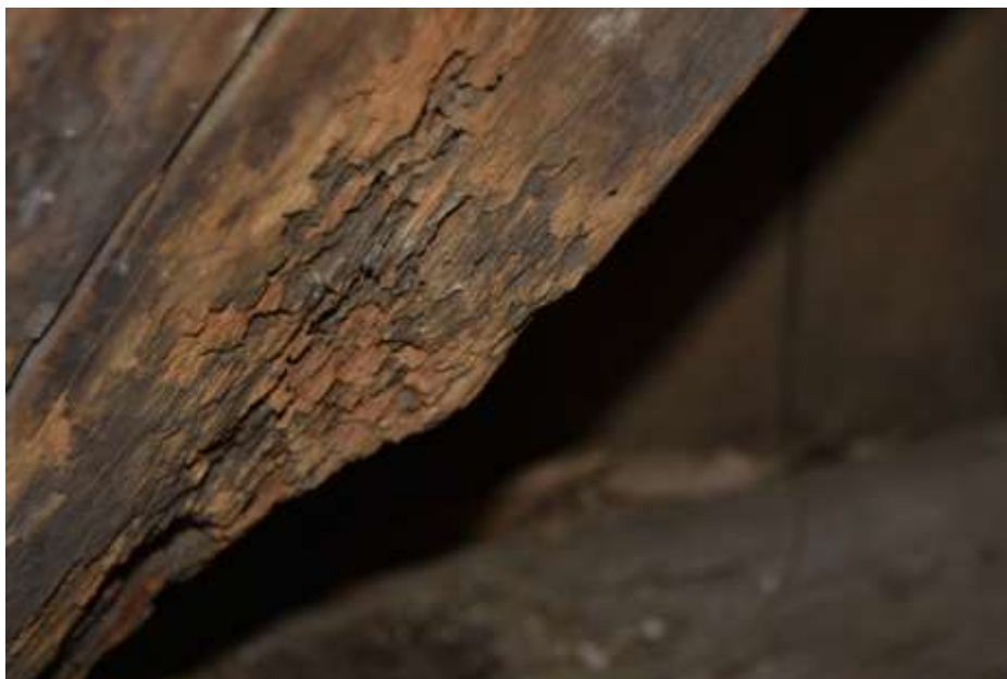
Fot. 118. Układ ramowy w osi E-E: pod warstwą zewnętrzną mączka drzewna; ubytki struktury;
