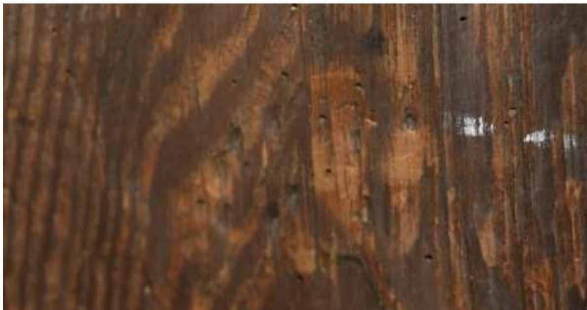
Fot. 49. Trzebiatów, ratusz, wieża zegarowa. Stan zachowania konstrukcji wieży jest zły. Występują liczne ogniska korozji biologicznej.
