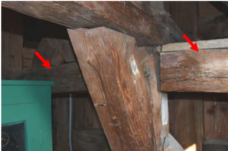
Fot. 200. Układ ramowy w osi 4-4: rygiel w poziomie VI o wymiarach 18x19 cm; drewno z pęknięciami wzdłuż włókien;
