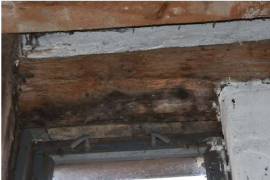
Fot. 81. Układ ściany w osi 9-9: nad otworem okiennym rygiel skorodowany; porażony biologicznie;
