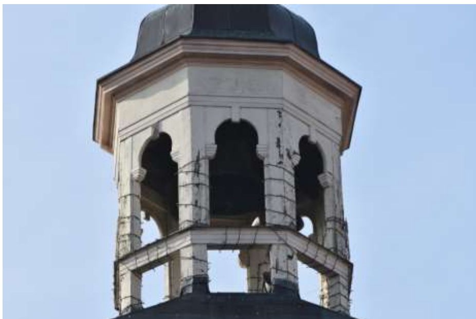
Fot. 298. Fragment elewacji: powyżej latarnia o konstrukcji drewnianej; słupy zaakcentowane płaskimi nadbitkami; drewno malowane; złuszczenia warstw malarskich;
