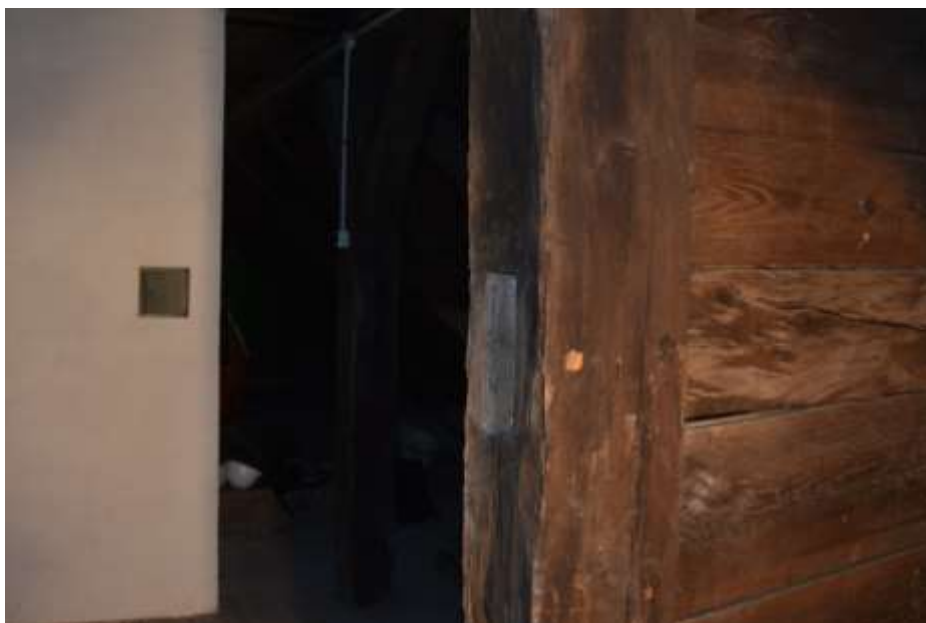
Fot. 94. Układ ściany w osi I-I: na odcinku 3-5 rygiel usunięty;
