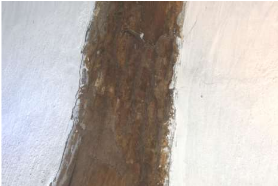
Fot. 45. Układ ściany w osi 1-1: drewno zastrzału lokalnie porażone biologicznie
