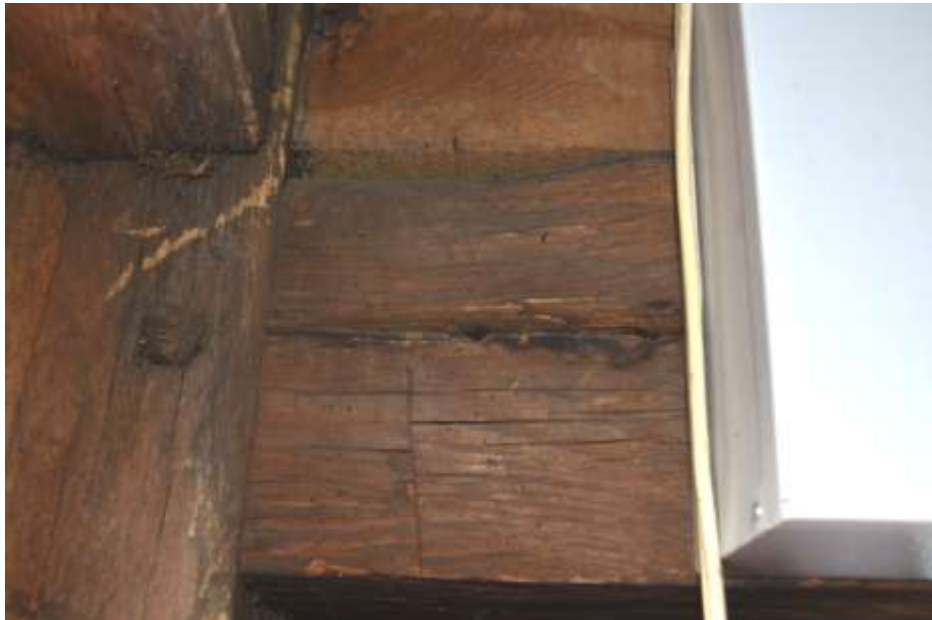
Fot. 182. Układ ramowy w osi F-F: w poziomie VI pomiędzy słupami i zastrzałami rygiel o wymiarach 20x22 cm; drewno z pęknięciami wzdłuż włókien;
