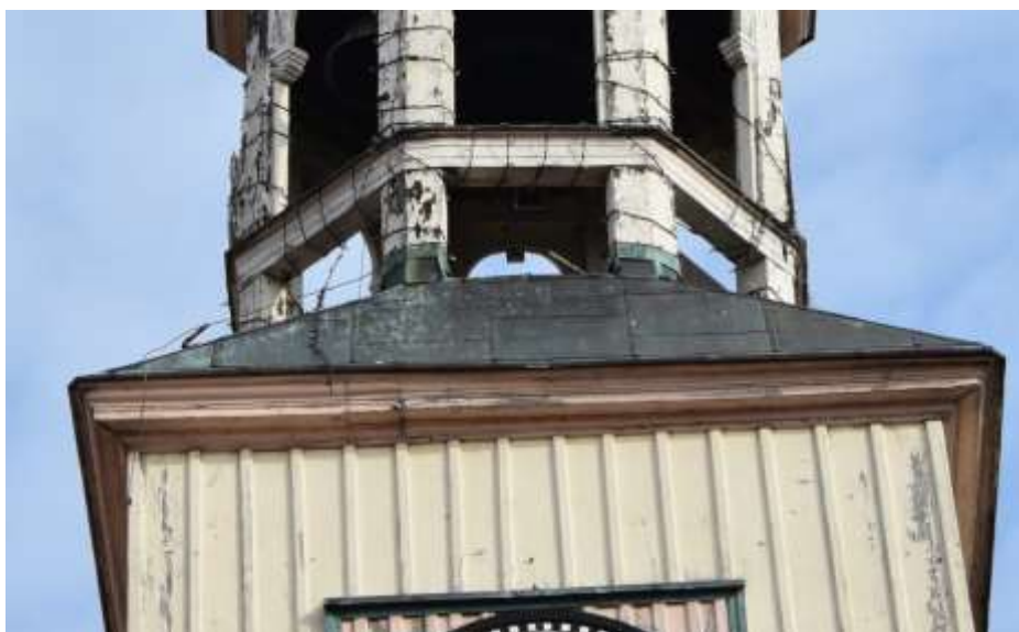
Fot. 334. Fragment elewacji: ponad gzymsem daszek pokryty blachą miedzianą; blacha wywinięta na dolne odcinki słupów latarni;
