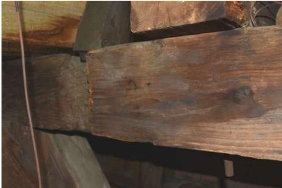
Fot. 207. Układ ramowy w osi 4-4: rygle w poziomie VIII o wymiarach 17x21 cm; na powierzchni zacieki; zawilgocenie drewna;
