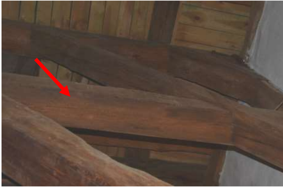
Fot. 121. Układ ramowy w osi G-G: rygle w poziomie III o wymiarach 22 x 16 cm; drewno ze śladami zacieków;
