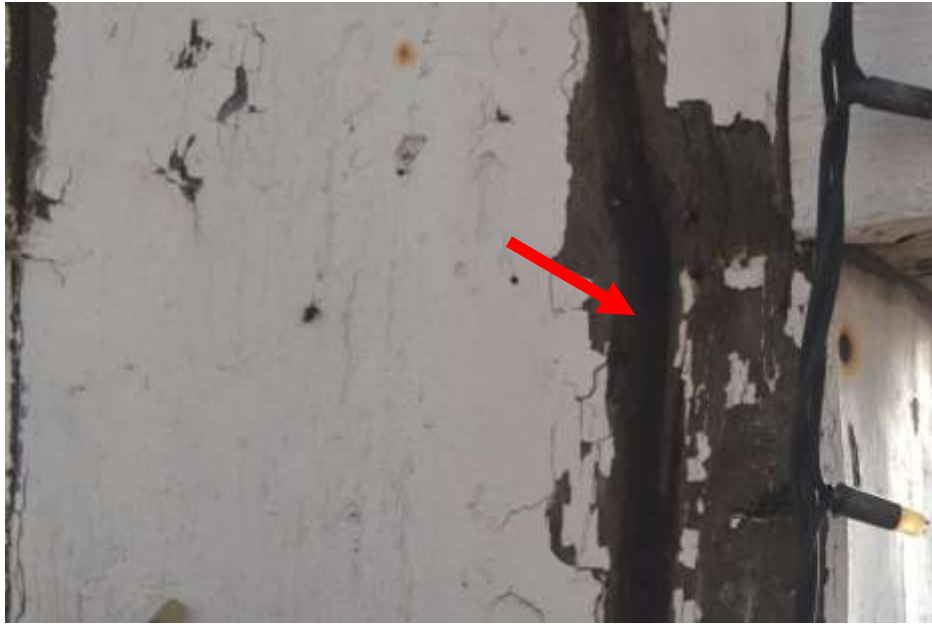
Fot. 232. Słup wieży: drewno słupa z pęknięciem wzdłuż włókien; rozwarcie do 2 cm;
