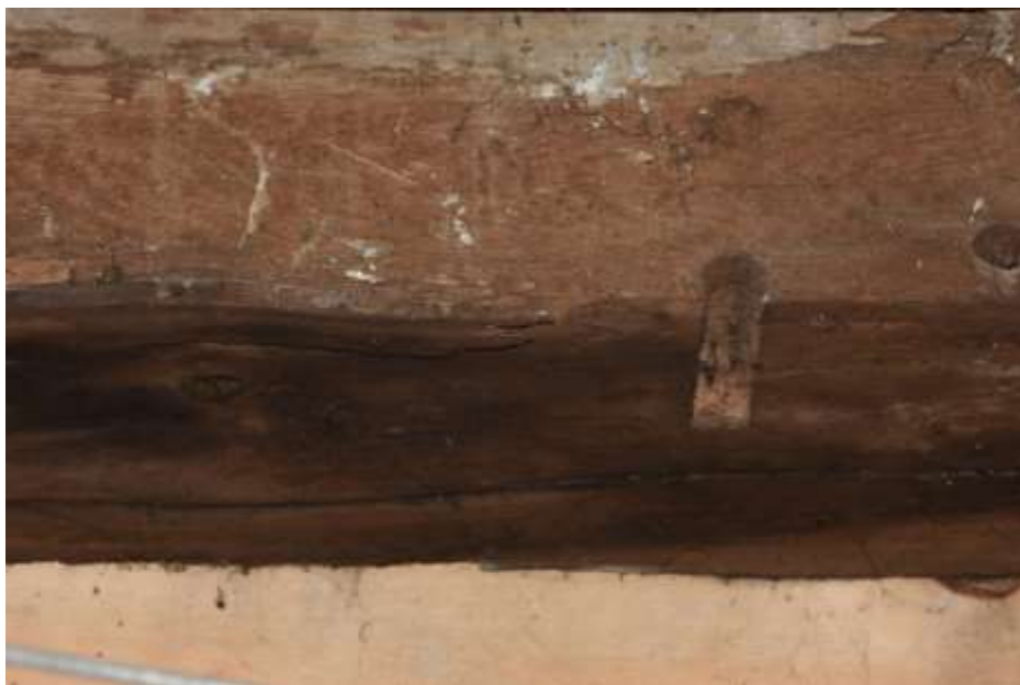
Fot. 53. Układ ściany w osi 1-1: na powierzchni drewna ślady zacieków; w ryglach wywiercone otwory;
