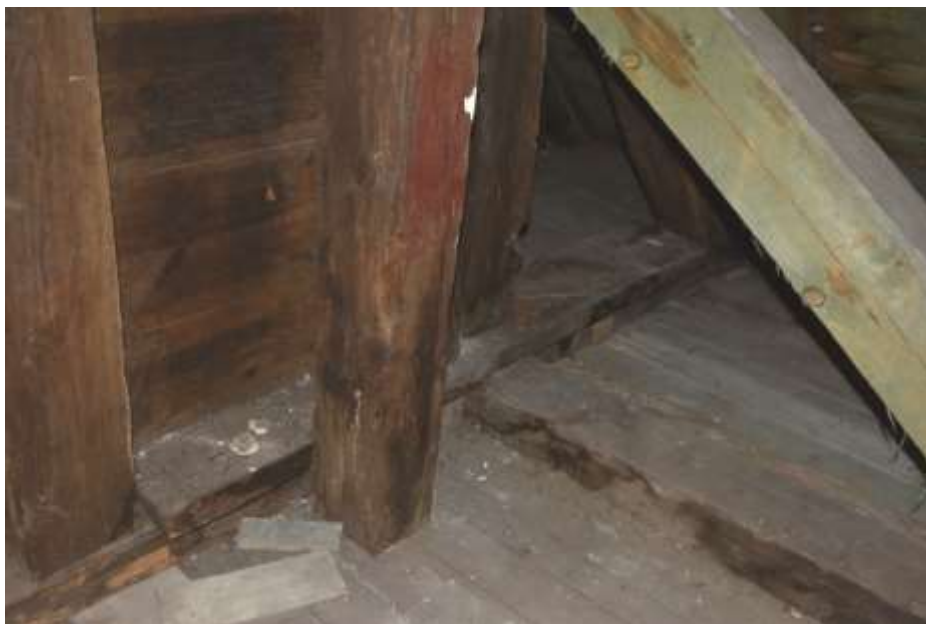
Fot. 85. Układ ściany w osi I-I: na odcinku 7-9 i dalej do zastrzału na podwalinie nakładka o wymiarach 31x8 cm; drewno z zaciekami;
