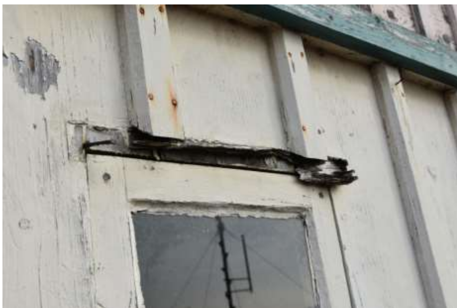
Fot. 328. Fragment elewacji: nad otworem okiennym pierwotnie listewka drewniana; obecnie zachowana w szczątkowej formie;
