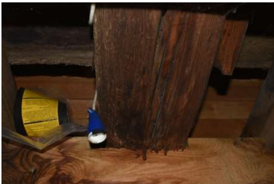
Fot. 270. Fragment stropu: przy osi E-E na odcinku 6-8 belka o wymiarach 25x21 cm; końcówka przy ścianie silnie skorodowana; utraciła oparcie;
