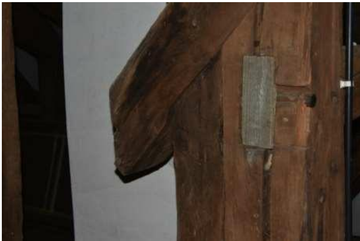
Fot. 46. Trzebiatów, ratusz, wieża zegarowa. Stan zachowania konstrukcji wieży jest zły. Występują liczne braki elementów konstrukcyjnych.
