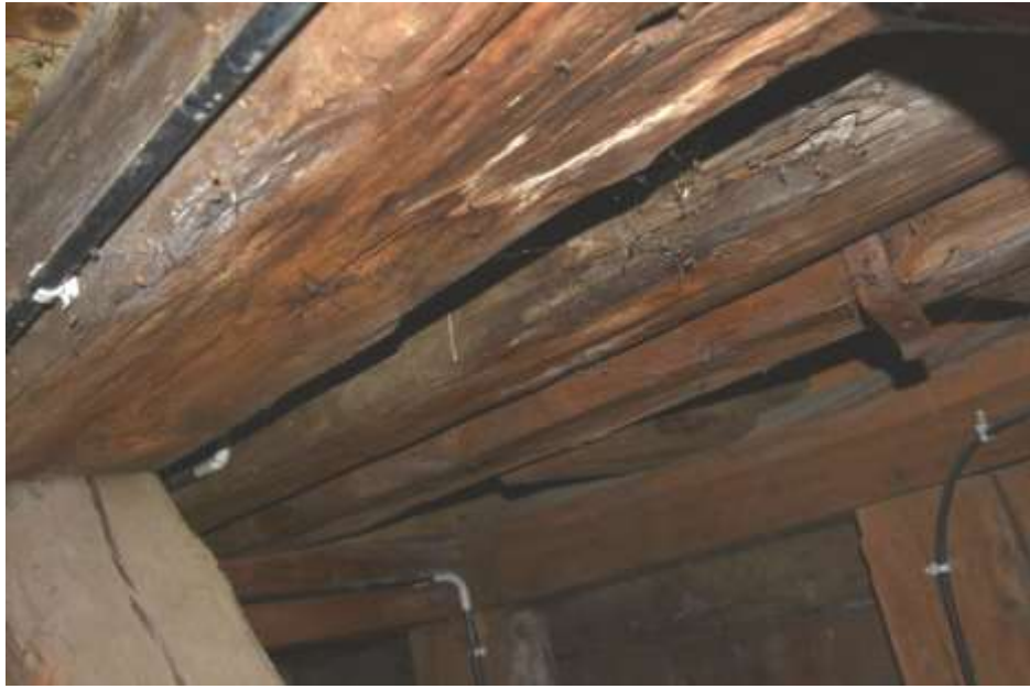
Fot. 241. Fragment stropu: belki stropu oparte na oczepach w osi 2-2 i 8-8; główne belki w osiach C-C, E-E i G-G;
