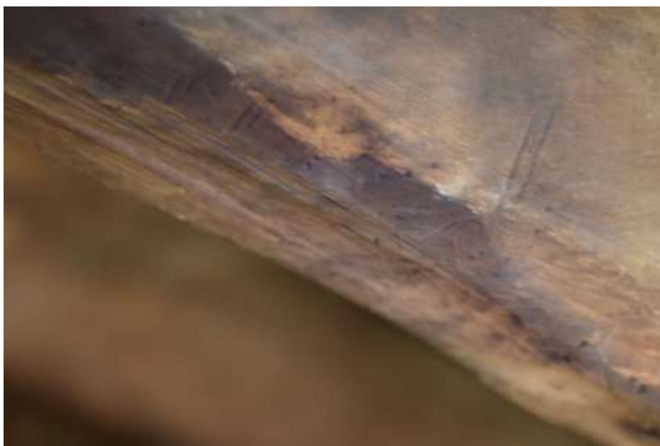
Fot. 113. Układ ramowy w soi E-E: drewno porażone przez owady techniczne szkodniki drewna; na powierzchni widoczne otwory wylotowe;
