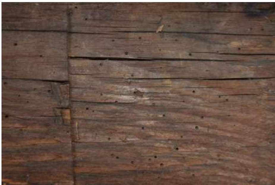
Fot. 183. Układ ramowy w osi F-F: rygiel porażony przez owady techniczne szkodniki drewna; lokalnie widoczne otwory wylotowe;
