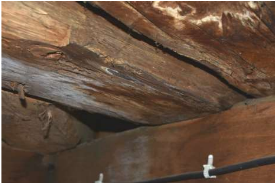
Fot. 242. Fragment stropu: między osiami A-C dwie dodatkowe belki: belka w osi B-B o wymiarach 20x24 cm; kolejna belka między B-C niekonstrukcyjna o wymiarach 14 x 18 cm;
