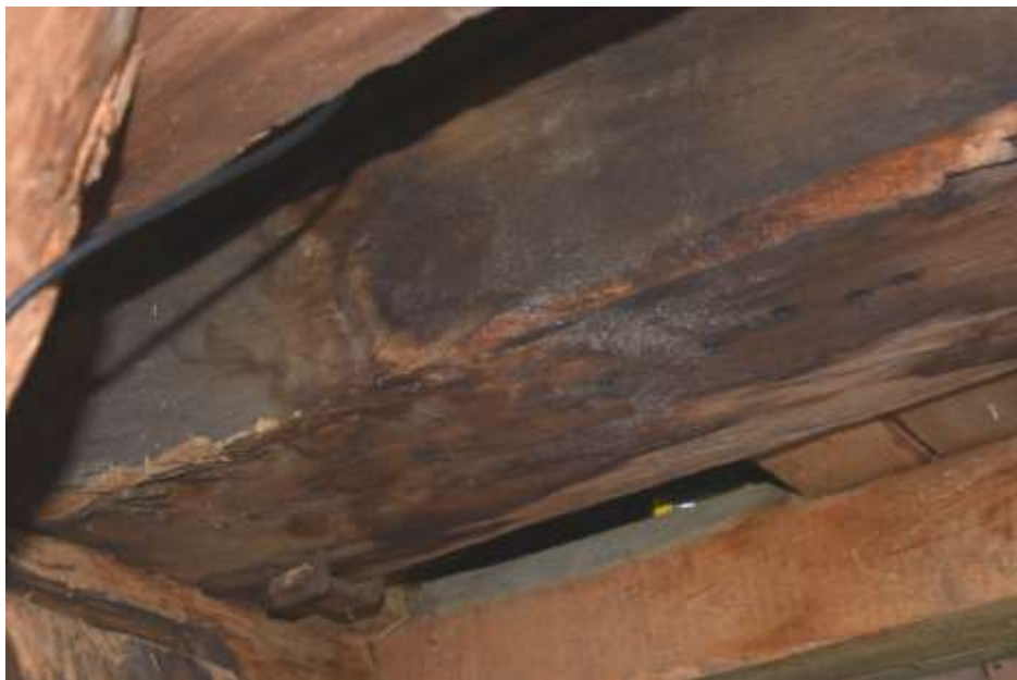
Fot. 260. Fragment stropu: belka w osi F'-F' o wymiarach 25x22 cm; silnie zawilgocona; na powierzchni wysolenia;
