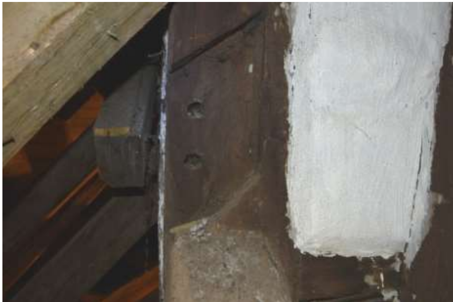
Fot. 2. Słup wieży: w słupie puste gniazdo po zastrzale wzdłuż osi I-I w kierunku ściany frontowej;
