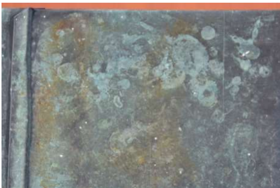
Fot. 257. Fragment stropu: na powierzchni rdzawe naloty;
