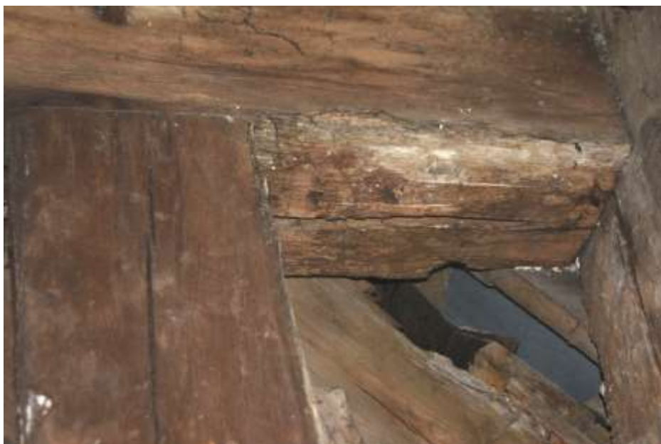
Fot. 66. Układ ściany w osi A-A: przy słupie 9/A rygiel skorodowany biologicznie; odcinek rygla wymiany;
