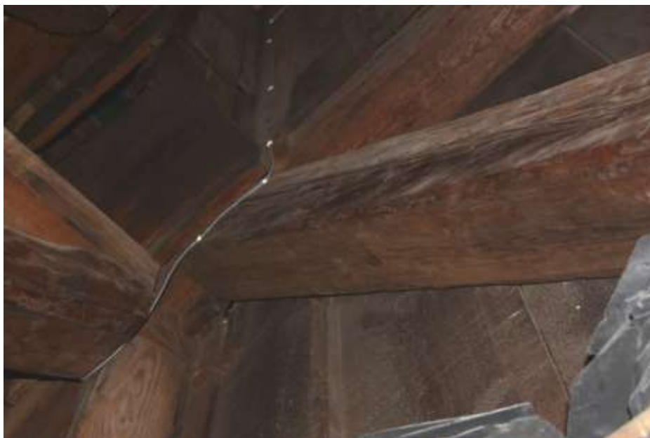
Fot. 115. Układ ramowy w osi E-E: zastrzały środkowe o wymiarach 21x22 cm; zacieki na powierzchni drewna;
