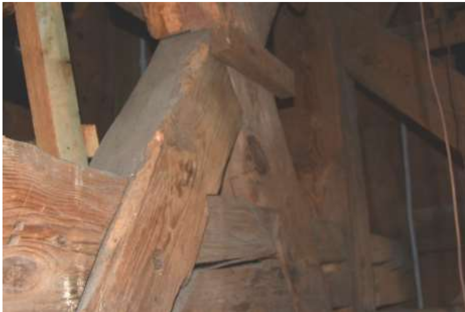
Fot. 185. Układ ramowy w osi F-F: w dolnej części ramy zastrzały typu X; połączenia kołkowane;
