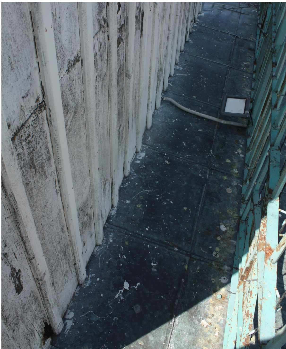
Fot. 34. Trzebiatów, ratusz, wieża zegarowa. Widok na latarnię wieży. Stan zachowania deskowania kondygnacji środkowej. Farba się łuszczy, odsłonięte drewno jest pociemniałe w wyniku działania wilgoci. Powierzchnię elewacji pokrywają nawarstwienia organiczne. Na zdjęciu widoczne nieprawidłowe wykończenie deskowania. Sięga ono do samego podestu. W okresie jesiennym i zimowym czoła desek mają stały kontakt z wilgocią.
