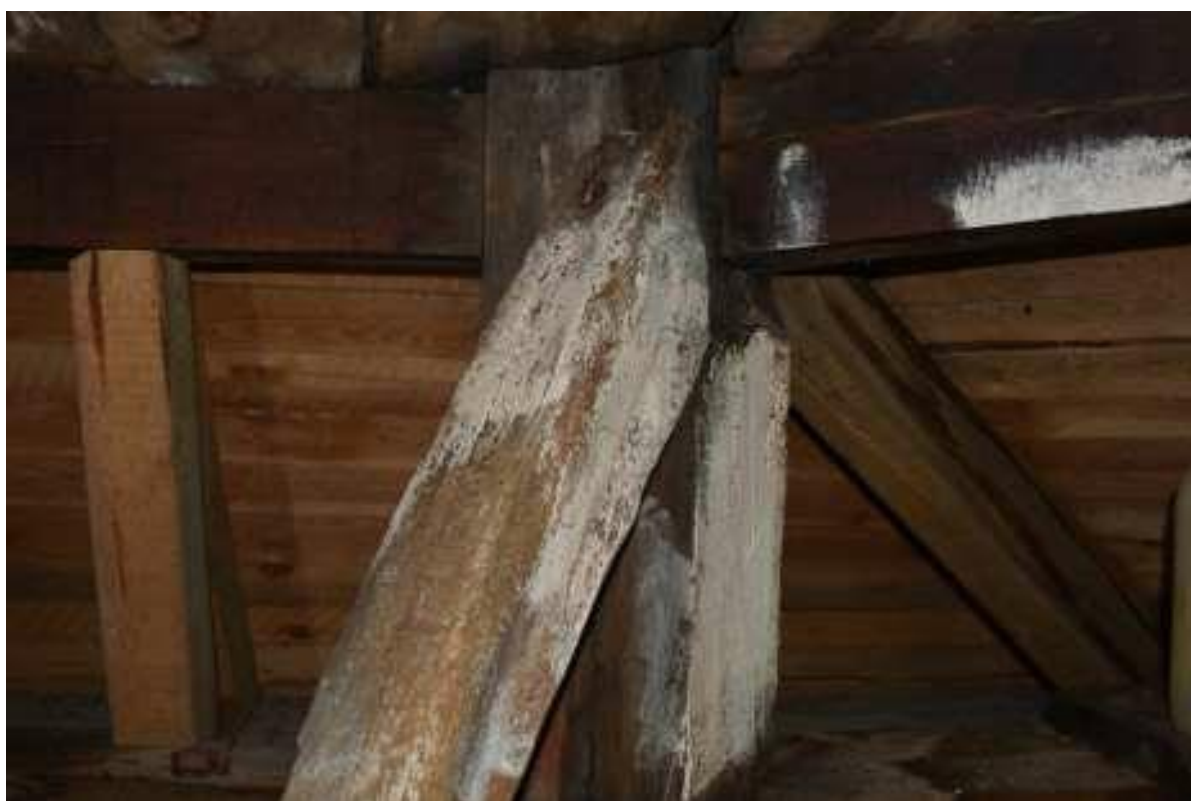
Fot. 57 . Trzebiatów, ratusz, wieża zegarowa. Stan zachowania konstrukcji wieży jest zły. Występują liczne ogniska korozji biologicznej.
