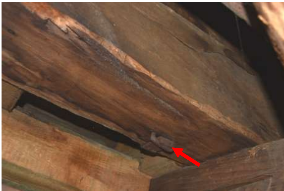
Fot. 261. Fragment stropu: do belki kotwiony element stalowy; płaskownik powierzchniowo skorodowany;
