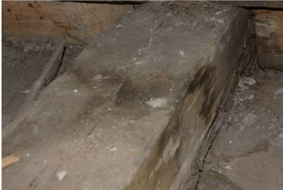
Fot. 71. Układ ściany w osi 9-9: podwalina drewniana o wymiarach 23x21 cm; na powierzchni zacieki; pęknięcia wzdłuż włókien;
