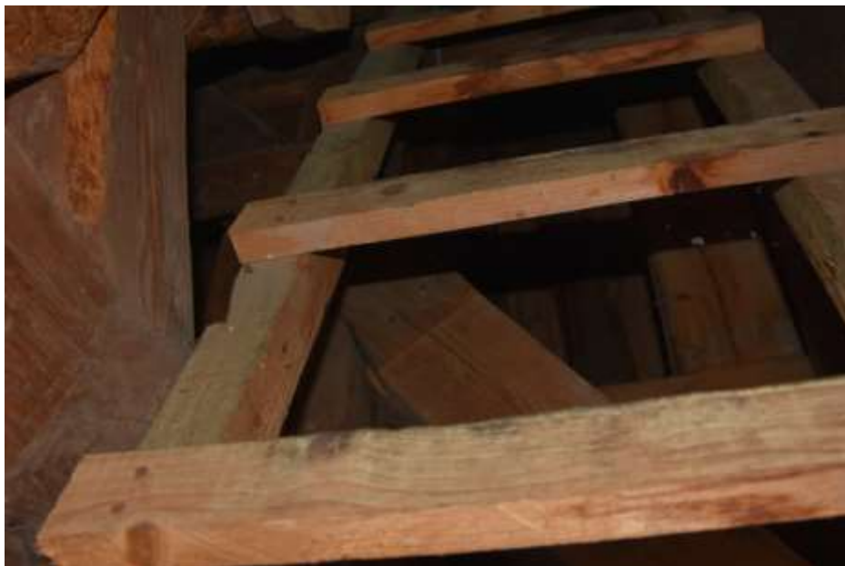
Fot. 281. Schody wieży: na poziom latarni drabina z elementów drewnianych;
