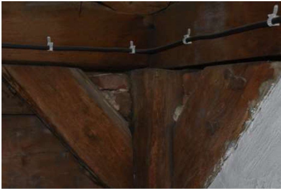
Fot. 23. Słup wieży: słup w partii pod stropem z mieczami podpierającymi belki oczepowe;
