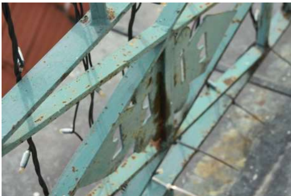
Fot. 306. Fragment elewacji: balustrada malowana; złuszczenia warstw malarskich; powierzchniowa korozja stali;
