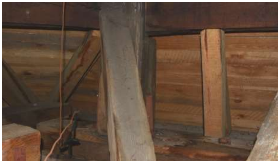
Fot. 222. Słup wieży: w przestrzeni pod zadaszeniem części zegarowej wieży słup zawilgocony; porażony biologicznie; kotwiony do belki stropu dwoma kątownikami stalowymi;
