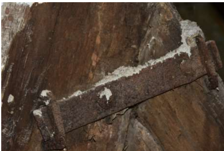
Fot. 87. Układ ściany w osi I-I: połączenie ze słupem wzmocnione płaskownikiem stalowym; element powierzchniowo skorodowany;
