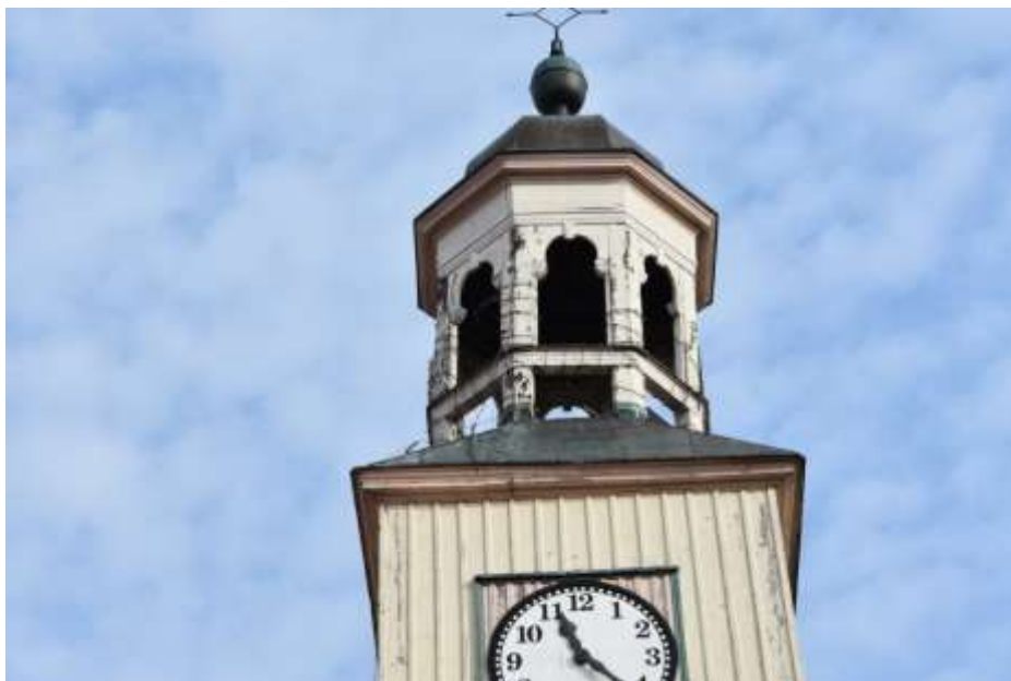
Fot. 335. Fragment elewacji: powyżej latarnia o konstrukcji drewnianej; słupy zaakcentowane płaskimi nadbitkami;
