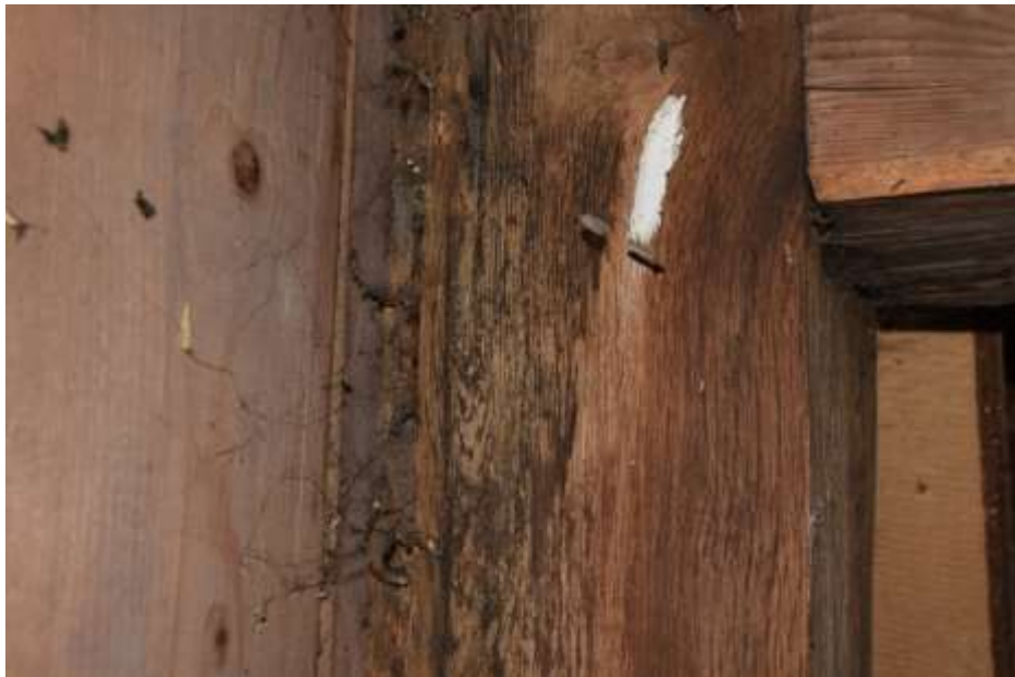
Fot. 140. Słup wieży: słup narożny; drewniany o wymiarach 23x16 cm; od strony deskowania nakładka grubości 3-4 cm; silnie porażona biologicznie;
