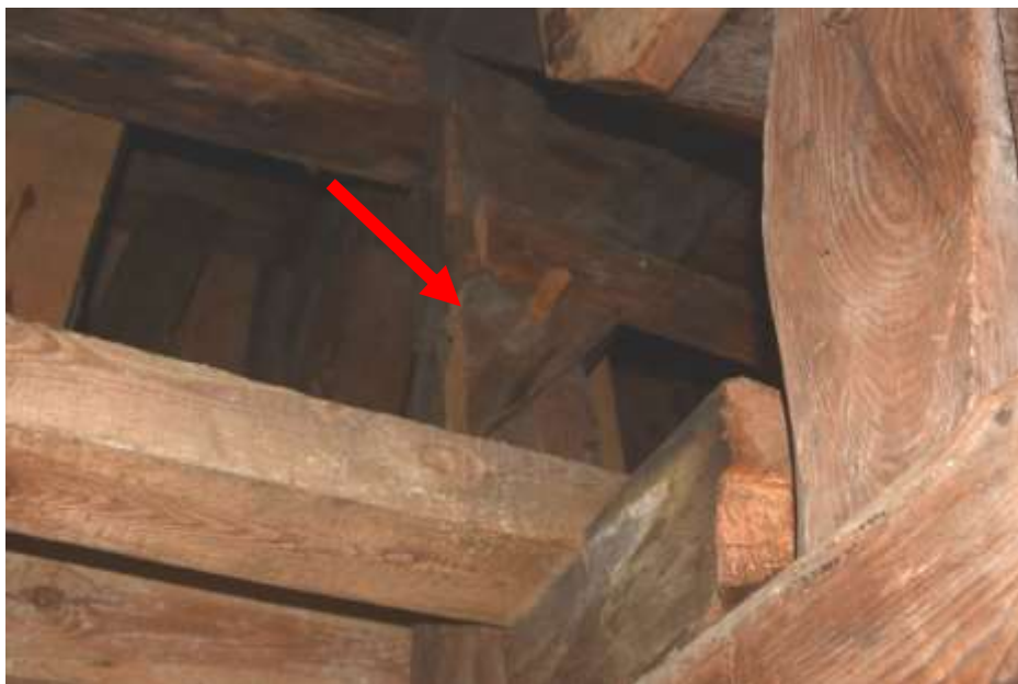
Fot. 193. Układ ramowy w osi 6-6: brak dolnego fragmentu zastrzału na odcinku B-D;
