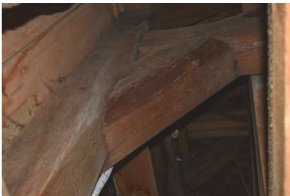
Fot. 177. Układ ramowy w osi D-D: rygiel poziom VII przy osi 8-8 i 2-2 podparte mieczami;
