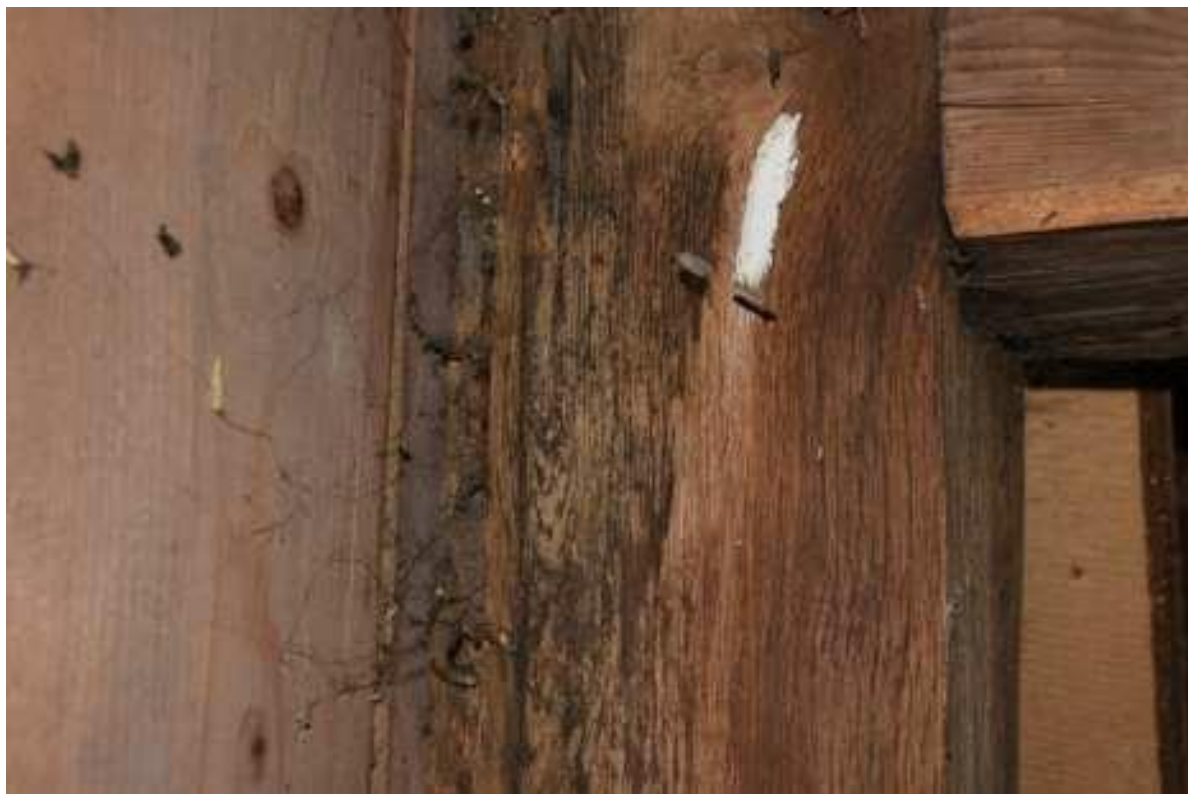
Fot. 48. Trzebiatów, ratusz, wieża zegarowa. Stan zachowania konstrukcji wieży jest zły. Występują liczne ogniska korozji biologicznej.
