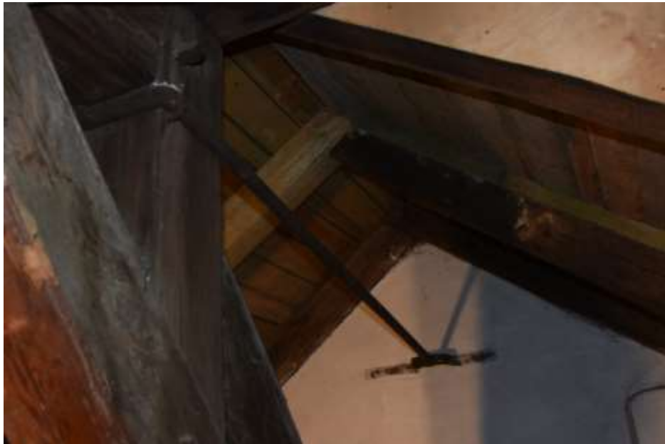
Fot. 111. Układ ramowy w osi E-E: słup 1/E pod II poziomem rygli zakotwiony do muru płaskownikiem stalowym o wymiarach 35x16mm;
