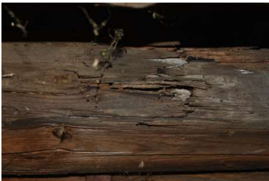
Fot. 243. Fragment stropu: belki ze śladami zacieków; skorodowane; porażone biologicznie;
