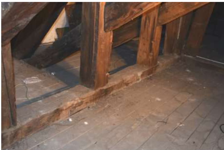
Fot. 40. Układ ściany w osi 1-1: w poziomie posadzki poddasza podwalina drewniana o wymiarach 25x20 cm;
