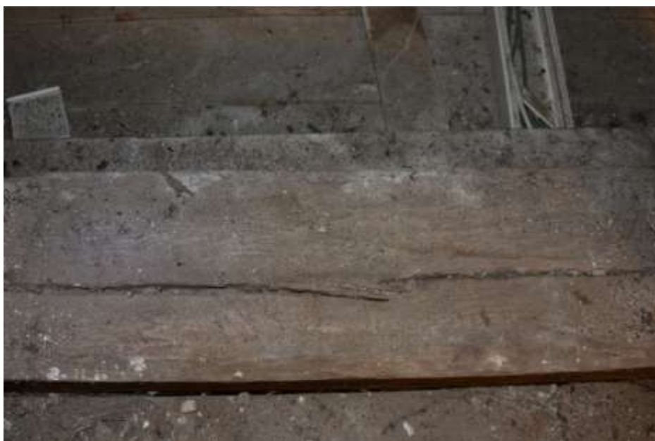
Fot. 41. Układ ściany w osi 1-1: podwalina z pęknięciami wzdłuż włókien;
