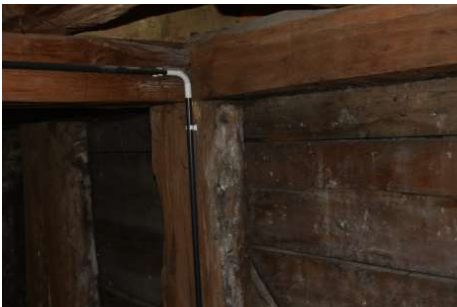
Fot. 18. Słup wieży: górna część słupa w partii pod stropem silnie porażona biologicznie;
