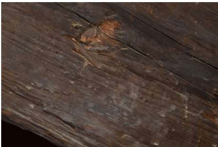
Fot. 103. Układ ramowy w soi G-G: drewno porażone przez owady techniczne szkodniki drewna; na powierzchni widoczne otwory wylotowe;
