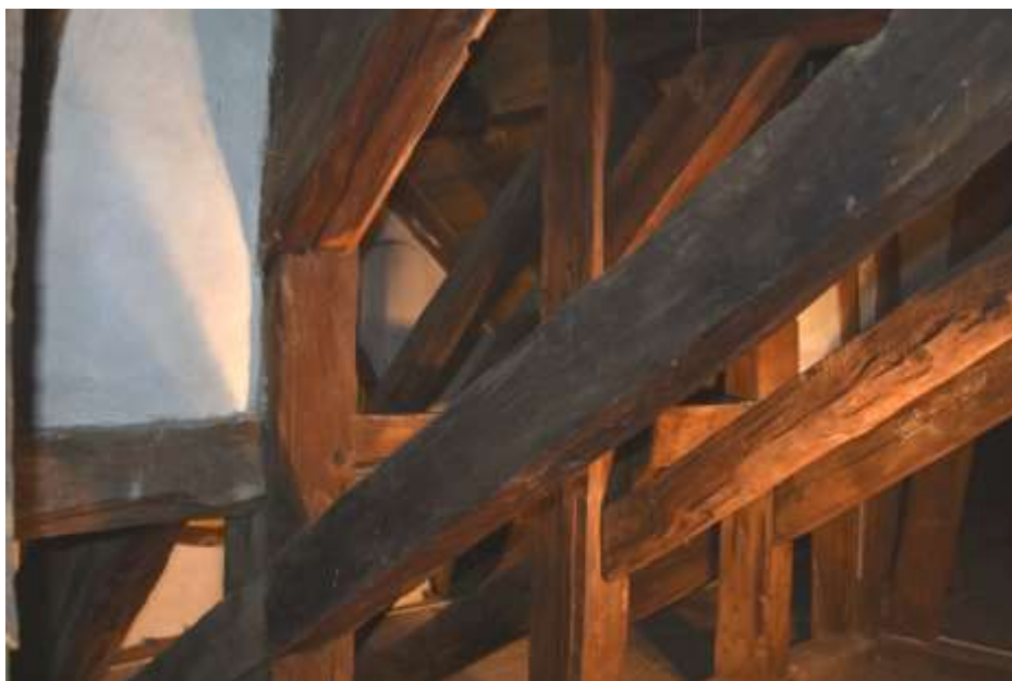
Fot. 39. Układ ściany w osi 1-1: układ ściany złożony z podwaliny, słupów; rygli i zastrzałów;
