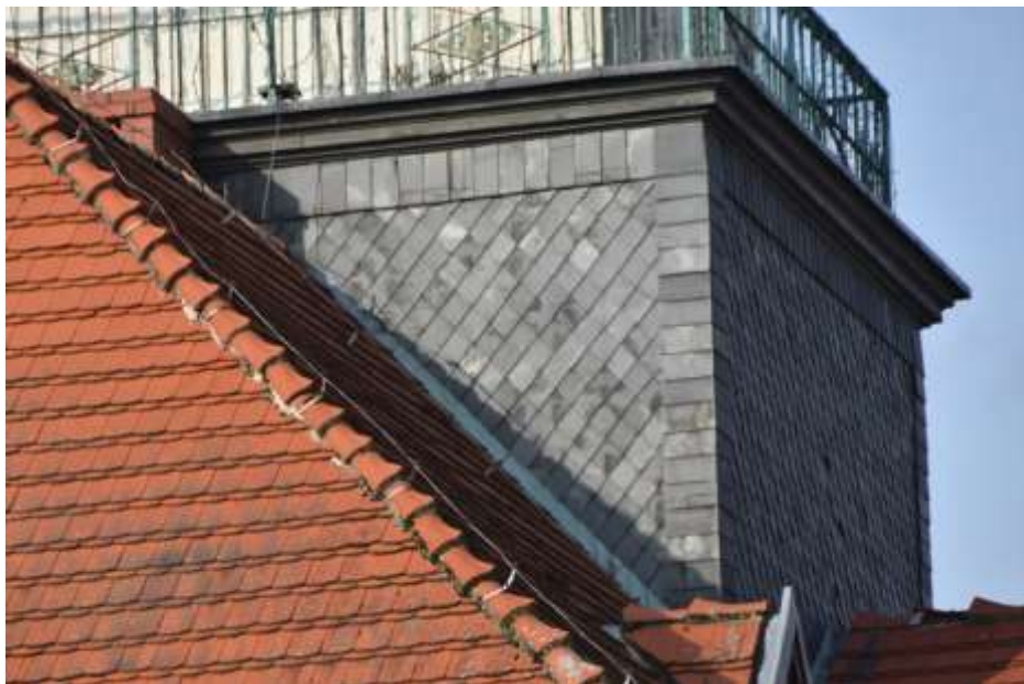
Fot. 302. Fragment elewacji: dolna część wieży z okładziną z łupka;
