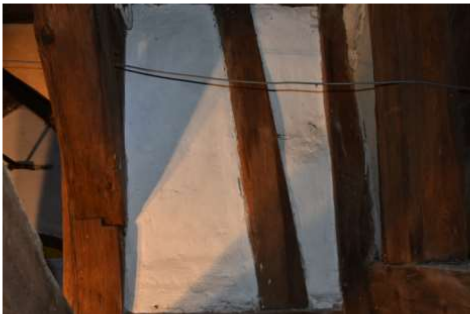
Fot. 46. Układ ściany w osi 1-1: zastrzał pomiędzy osiami A-C o przebiegu ukośnym od podstawy słupa 1/A w kierunku słupa 1/C; wypełnienie pól pomiędzy elementami drewnianymi tynkowane i malowane;
