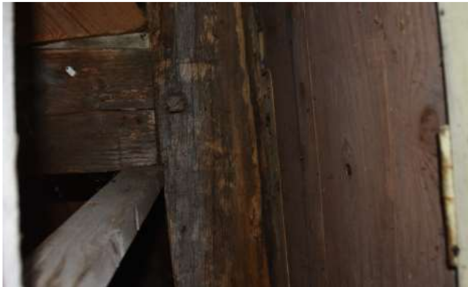
Fot. 144. Słup wieży: drewniany o wymiarach 22x17 cm; od strony deskowania nakładka grubości 3cm; drewno słupa porażona biologicznie;
