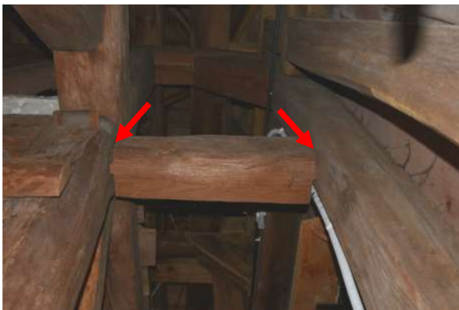
Fot. 203. Układ ramowy w osi 4-4: na odcinku H-F rygiel odchylony od poziomu; połączenia poluzowane;
