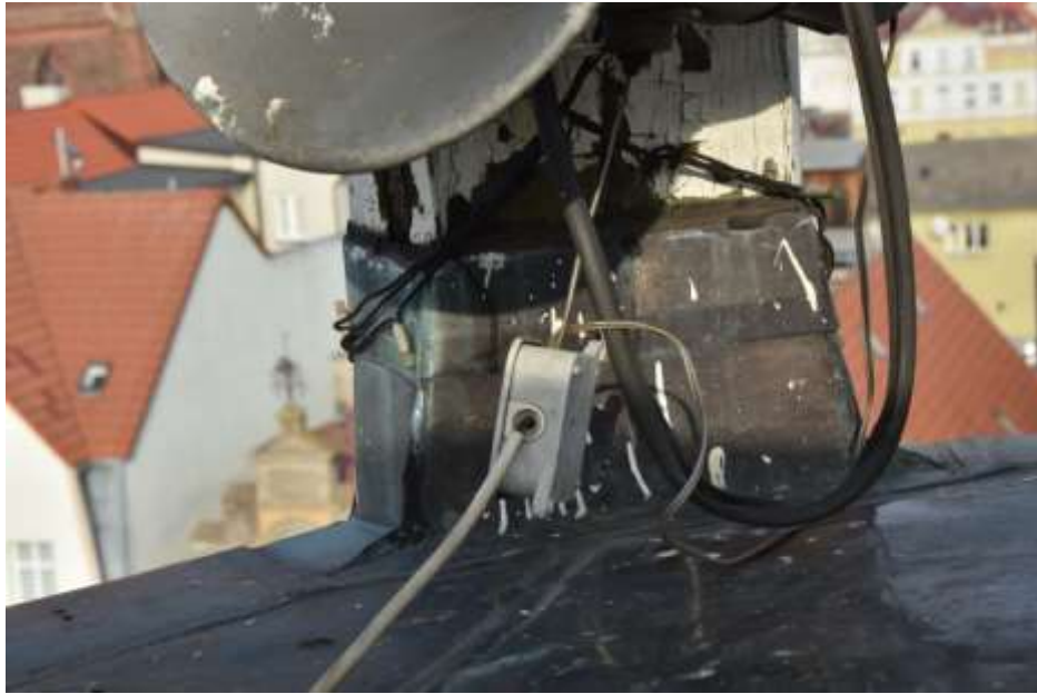
Fot. 218. Słup wieży: w dolnej części na słup wywinięta blacha miedziana; ślady uszczelnienia kitem na połączeniu; drewno zawilgocone; skorodowane; korozja sklejki;
