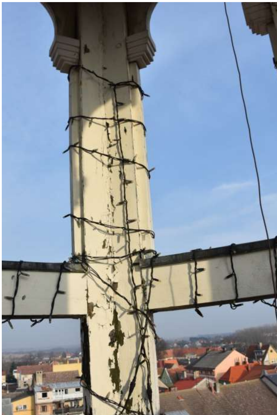
Fot. 220. Słup wieży: powyżej słup latarni malowany; na powierzchniach bocznych słupa warstwa ze sklejki gr. 2 mm;
