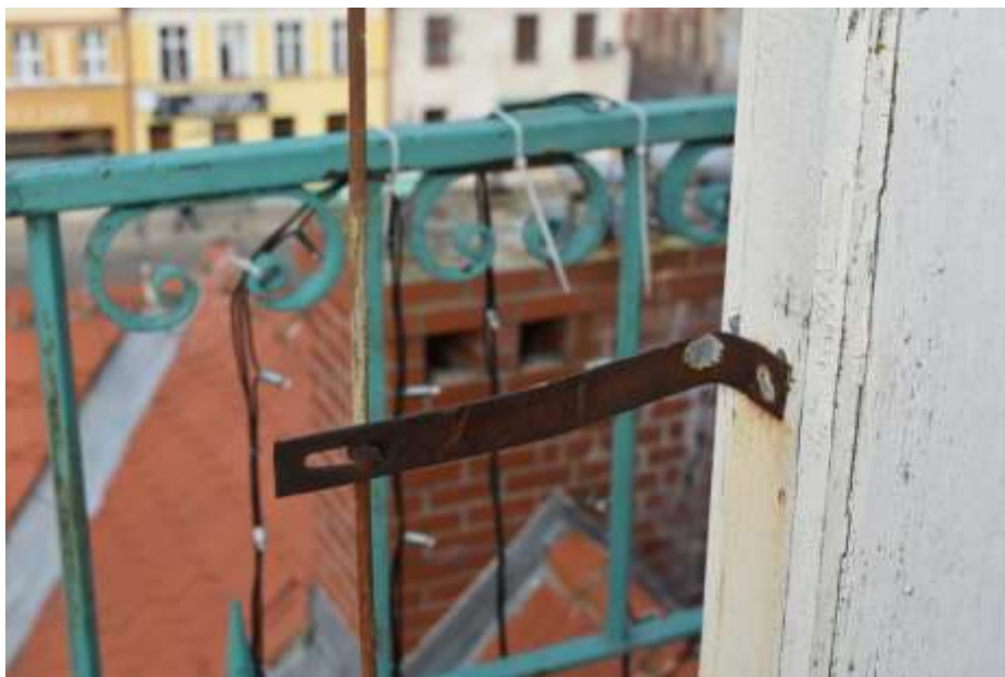
Fot. 329. Fragment elewacji: w narożniku zachodnim instalacja odgromowa; mocowana kątownikami do poszycia z desek; elementy stalowe powierzchniowo skorodowane;
