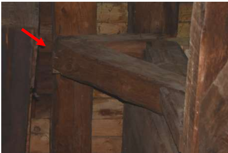
Fot. 135. Układ ramowy w osi 5-5: w poziomie IV rygiel przerwany przy osi E-E;
