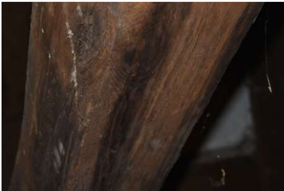
Fot. 125. Układ ramowy w osi C-C: zastrzały środkowe o wymiarach 21x22 cm; zacieki na powierzchni drewna;
