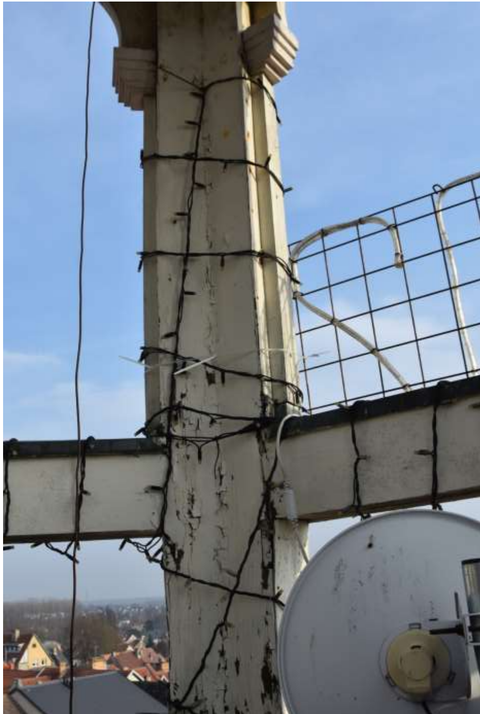
Fot. 223. Słup wieży: powyżej słup latarni malowany; złuszczenia warstw malarskich; na powierzchniach bocznych słupa warstwa ze sklejk gr. 2 mm;
