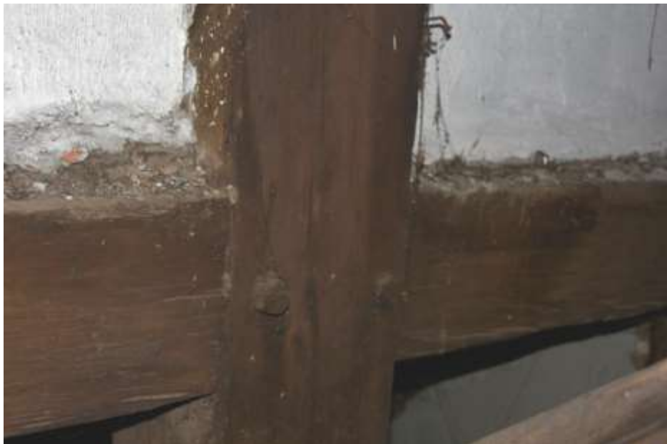
Fot. 76. Układ ściany w osi 9-9: rygle w poziomie I-I o wymiarach 23x21 cm; połączenia kołkowane; na powierzchni drewna zacieki;
