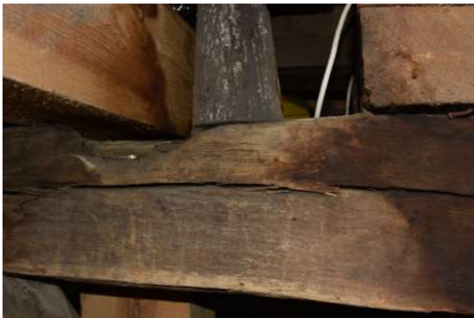
Fot. 197. Układ ramowy w osi 6-6: rygiel poziomu VIII o wymiarach 17x21 cm; z pęknięciami wzdłuż włókien; przy słupie 6/D wycięty od góry;
