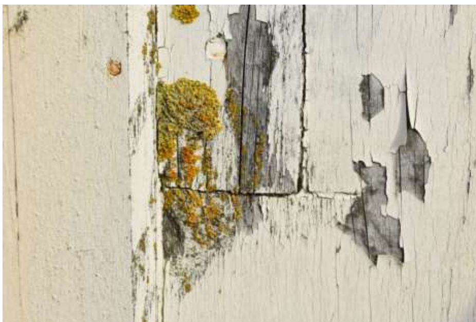
Fot. 323. Fragment elewacji: lokalnie na powierzchni deskowania rozwój porostów;
