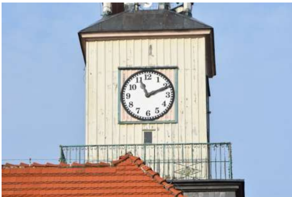
Fot. 304. Fragment elewacji: część środkowa wieży z poszyciem z desek; w osi ściany tarcza zegarowa;
