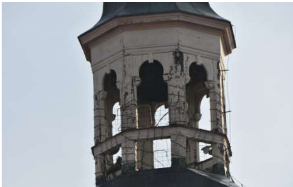
Fot. 352. Fragment elewacji: powyżej latarnia o konstrukcji drewnianej; słupy zaakcentowane płaskimi nadbitkami; drewno malowane; złuszczenia warstw malarskich; silnie skorodowany nadbitki na słupach;
