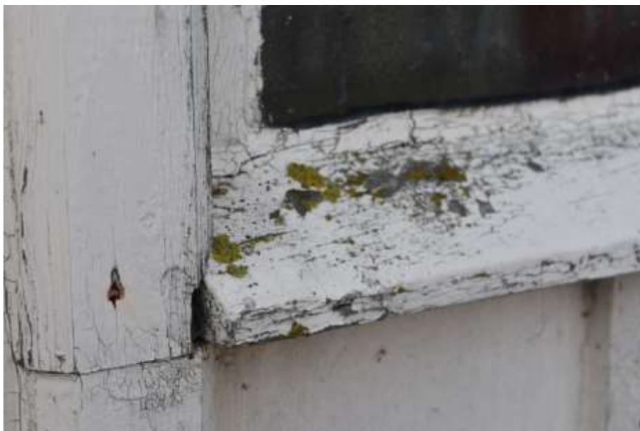
Fot. 294. Fragment elewacji: nad otworem okiennym pierwotnie listewka drewniana; obecnie zachowana w szczątkowej formie;
