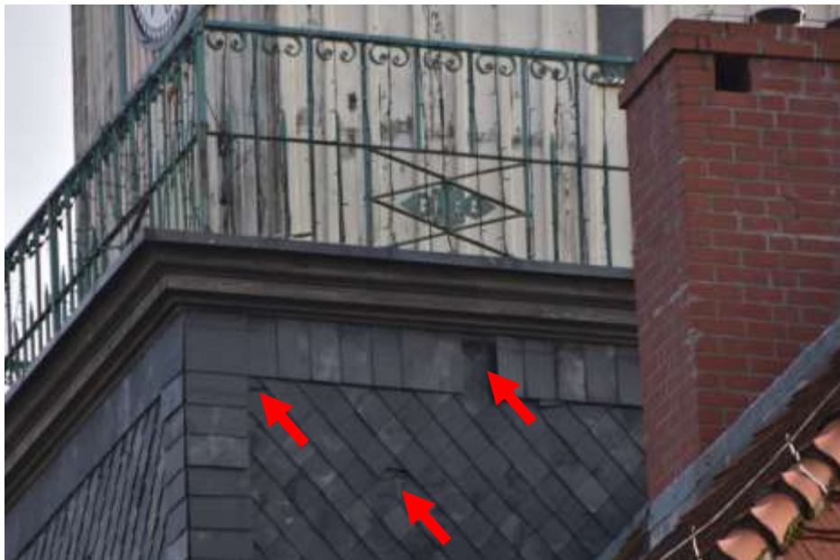
Fot. 340. Fragment elewacji: ściana zwieńczona profilowanym wysuniętym gzymsem drewnianym; lokalnie uszkodzenia okładziny; ubytki płytek łupka;
