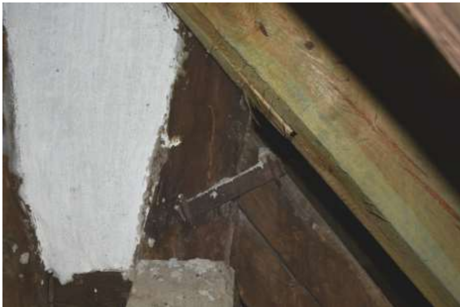
Fot. 28. Słup wieży: drewno z pęknięciami wzdłuż włókien; skorodowane biologicznie;
