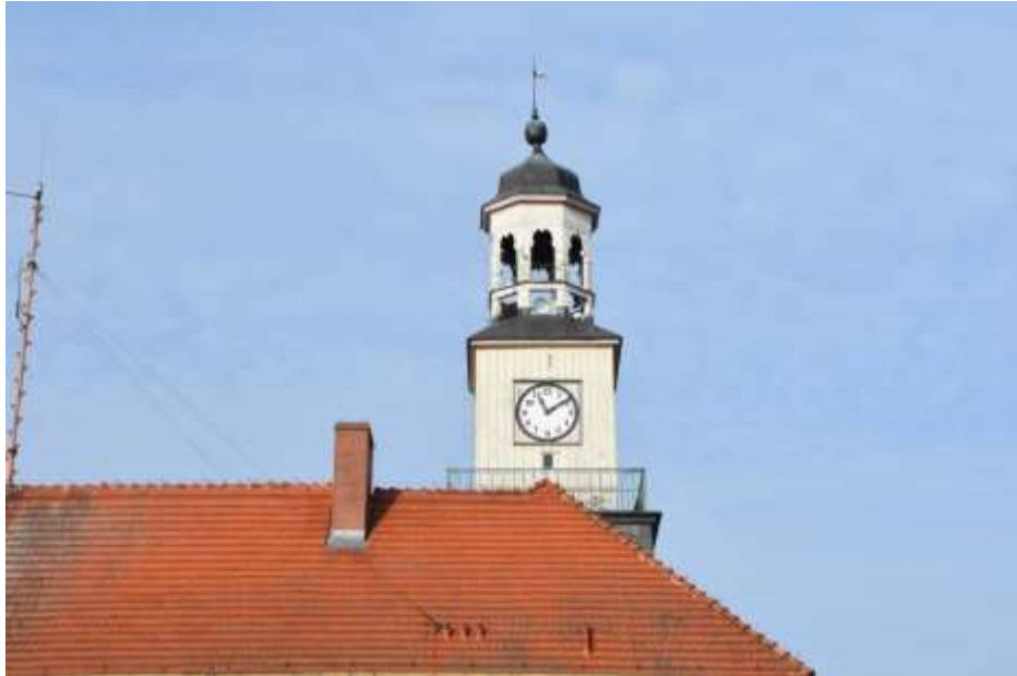
Fot. 301. Fragment elewacji: dolna część wieży widoczna we fragmencie; część środkowa na planie kwadratu z tarczą zegarową w osi ściany; wieża zwieńczona latarnią na planie ośmioboku;
