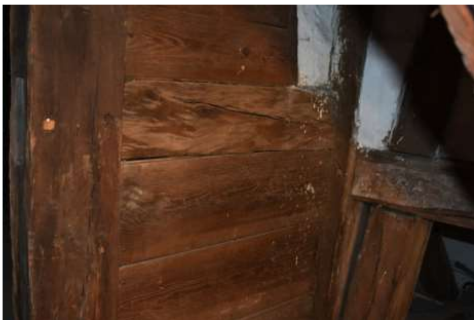
Fot. 91. Układ ściany w osi I-I: w dolnej części wypełnienie deskami; deski lokalnie porażone przez owady techniczne szkodniki drewna;
