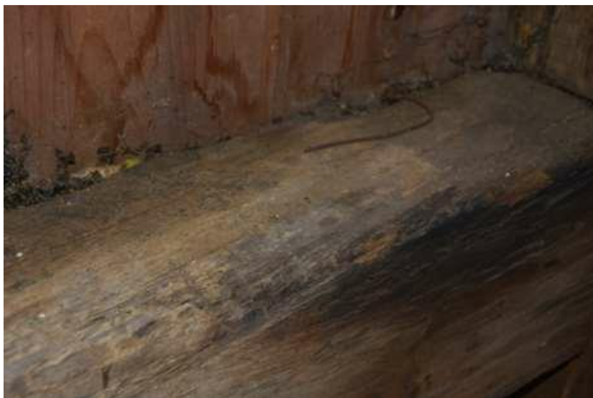
Fot. 51. Trzebiatów, ratusz, wieża zegarowa. Stan zachowania konstrukcji wieży jest zły. Występują liczne ogniska korozji biologicznej.
