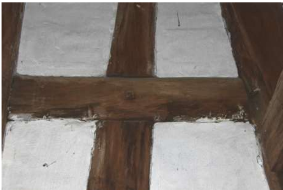
Fot. 78. Układ ściany w osi 9-9: rygle II poziomemu o wymiarach 20x20cm; - na odcinku I-G (rys. E2 – załącznik nr 1) rygiel rozwarstwiony; silnie porażony biologicznie;
