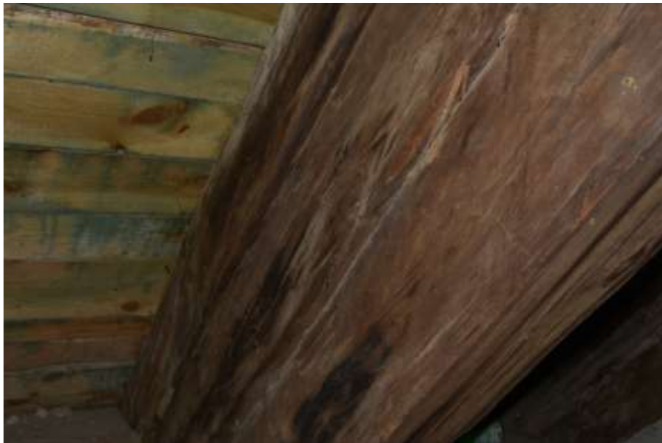
Fot. 124. Układ ramowy w osi C-C: przy osi 9-9 pomiędzy zastrzałami dodatkowa belka; na powierzchni drewna ciemne zacieki;
