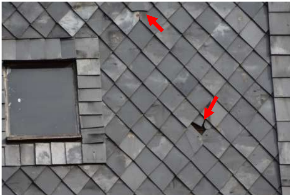
Fot. 317. Fragment elewacji: lokalnie uszkodzenia okładziny; ubytki łupka;
