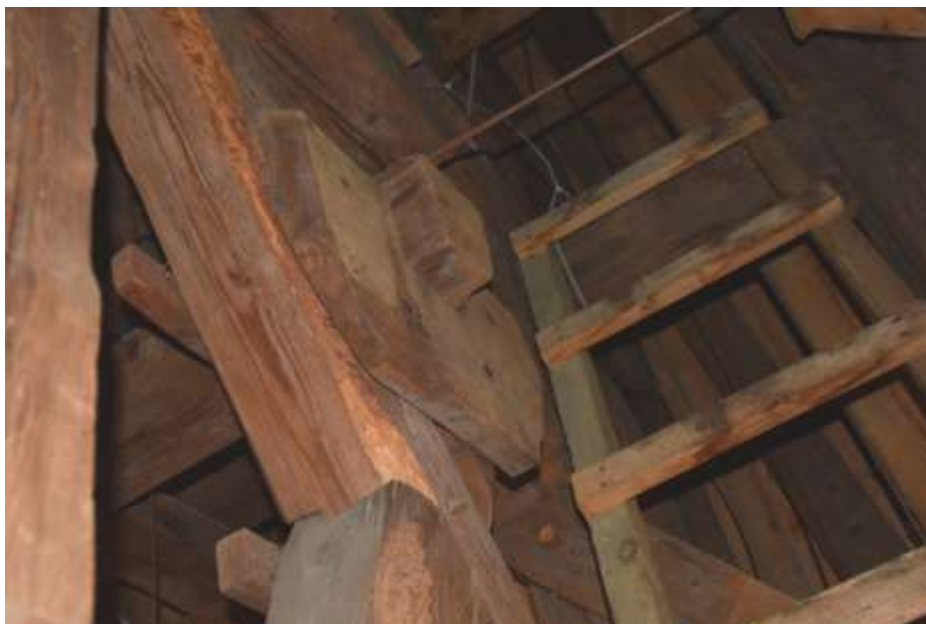
Fot. 187. Układ ramowy w osi D-D: pomiędzy zastrzałami widoczne jarzmo dawnej konstrukcji dzwonów;
