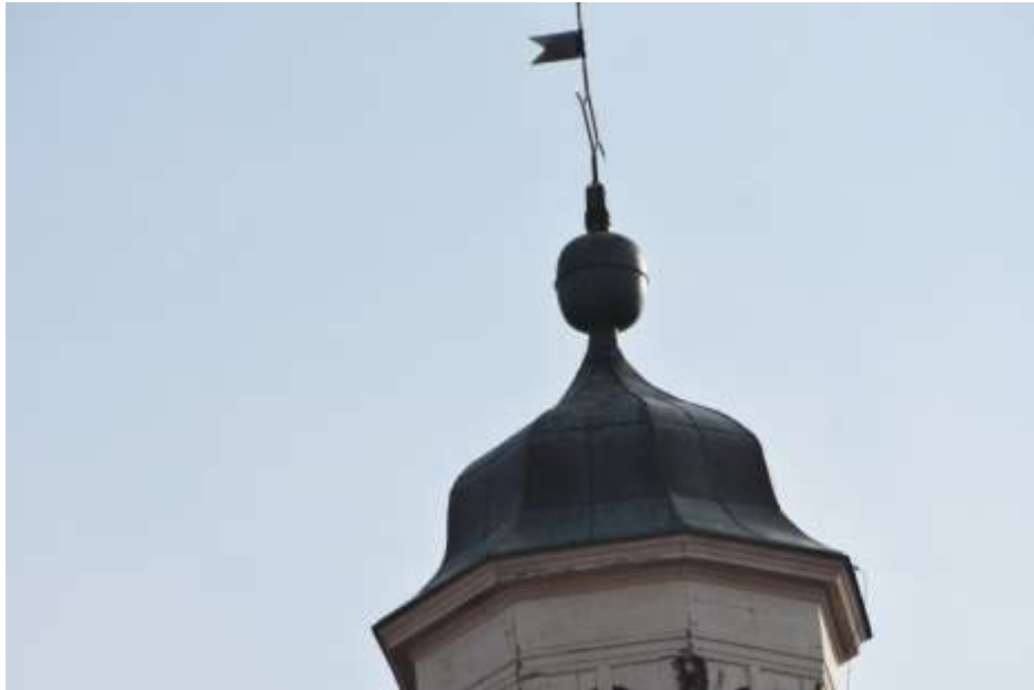
Fot. 353. Fragment elewacji: gzyms wieńczący profilowany; drewniany; drewno malowane; latarnia przykryta ozdobnym hełmem; pokrycie z blachy miedzianej;
