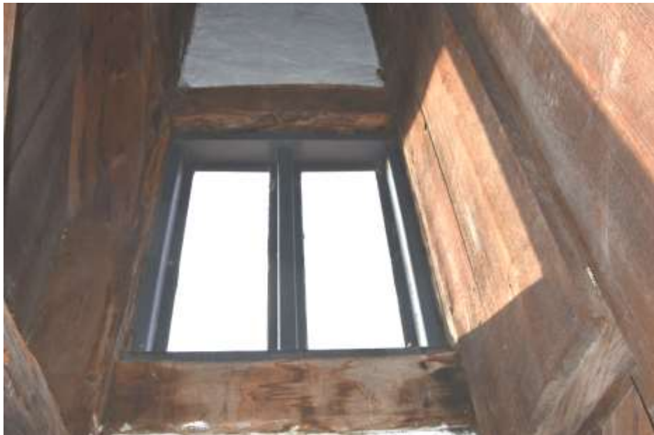
Fot. 82. Układ ściany w osi 9-9: na odcinku E-G większy otwór okienny; stolarka krosnowa; rygiel nad oknem skorodowany; rygiel pod otworem okiennym silnie zawilgocony
