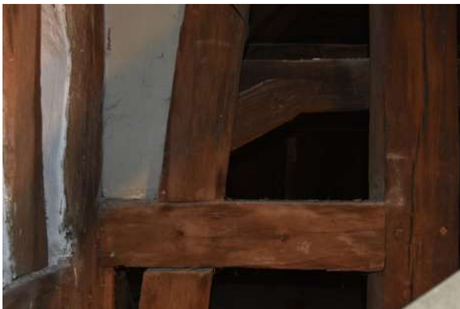
Fot. 58. Układ ściany w osi A-A: zastrzał pomiędzy osiami 1-3 o wymiarach 21x21 cm; pole pomiędzy zastrzałem i słupem oraz ryglami I i II poziomu wypełnione; tynkowane i malowane;
