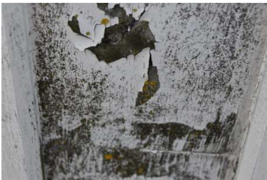
Fot. 292. Fragment elewacji: rozległe złuszczenia warstw malarskich; na powierzchni wegetacja porostów;
