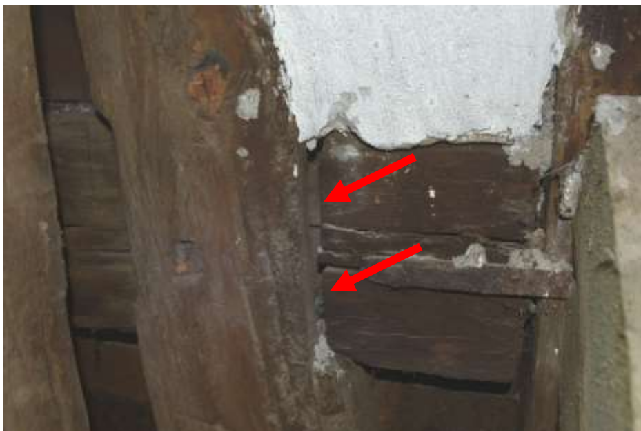
Fot. 97. Układ ściany w osi I-I: poluzowany węzeł rygla z zastrzałem na odcinku 7-9;
