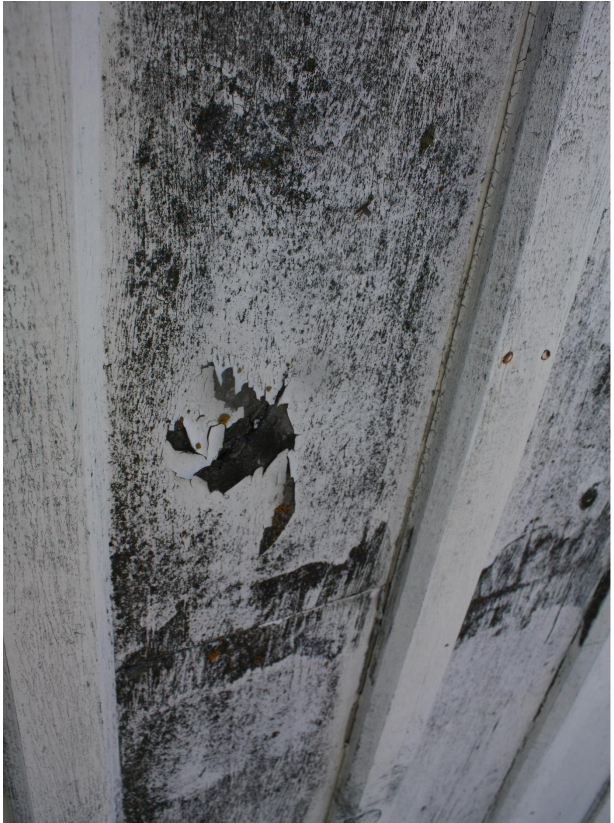
Fot. 32. Trzebiatów, ratusz, wieża zegarowa. Widok na latarnię wieży. Stan zachowania deskowania kondygnacji środkowej. Farba się łuszczy, odsłonięte drewno jest pociemniałe w wyniku działania wilgoci. Powierzchnię elewacji pokrywają nawarstwienia organiczne.
