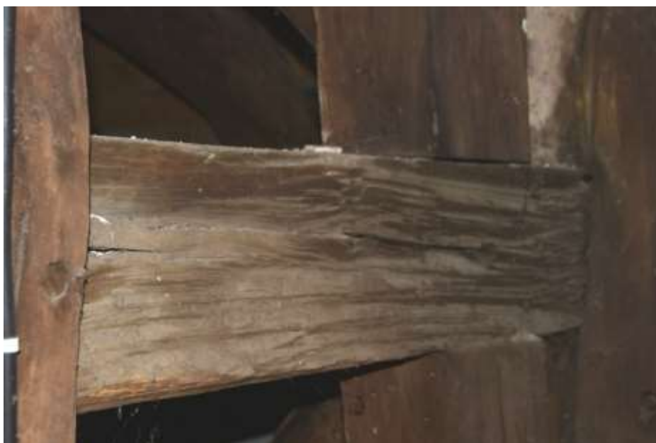
Fot. 61. Układ ściany w osi A-A: rygle w poziomie I o wymiarach 22x21 cm; drewno skorodowane; na odcinku 7-9 ubytek struktury;
