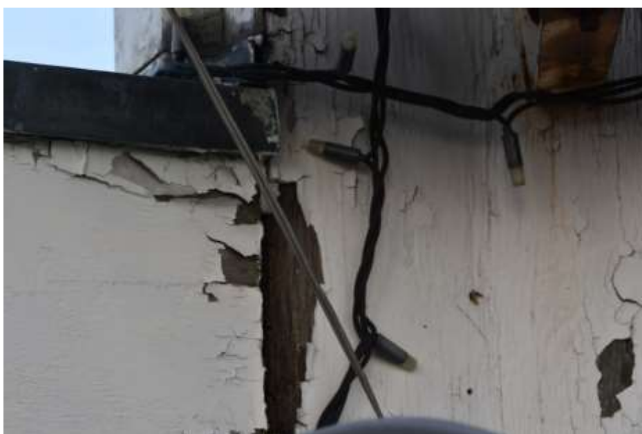
Fot. 238. Fragment latarni:: lokalnie korozja drewna na połączenia ze słupami;
