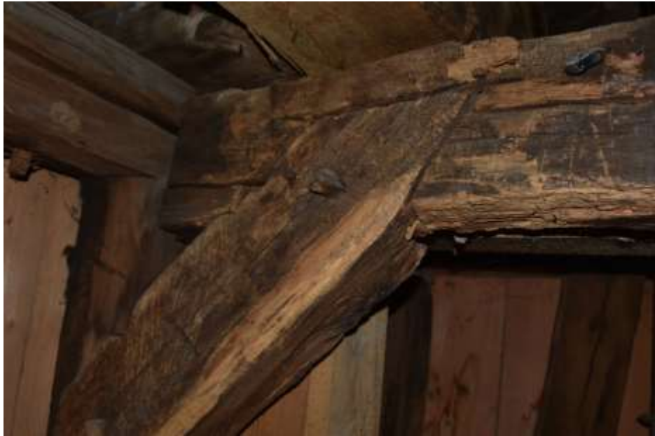
Fot. 199. Układ ramowy w osi 6-6: końcówka rygla przy osi B-B silnie skorodowana; ubytki struktury; belka utraciła właściwości nośne;
