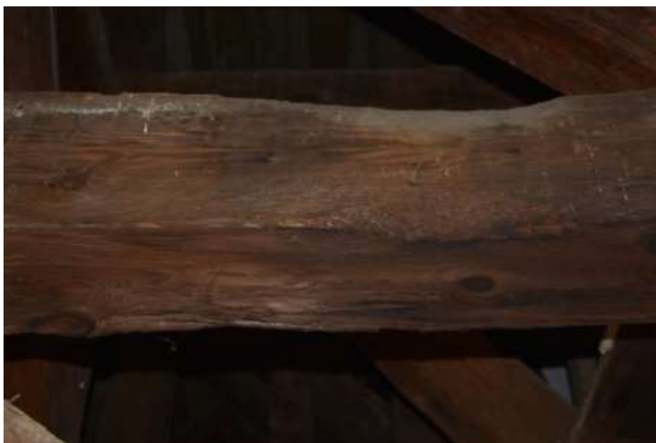
Fot. 119. Układ ramowy w osi E-E: rygle na poziomie II o wymiarach 22 x 23 cm; ze śladami zacieków; o nieregularnym przekroju;
