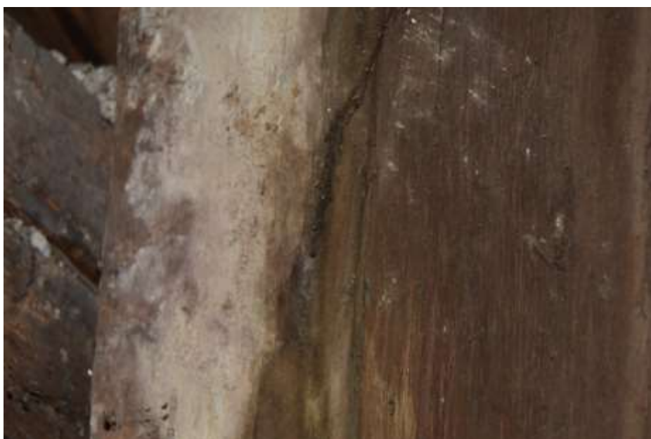
Fot. 22. Słup wieży: drewno z pęknięciami wzdłuż włókien; skorodowane biologicznie;
