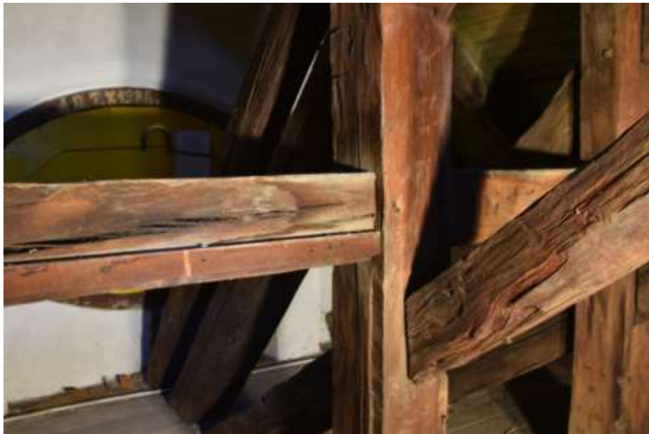
Fot. 49. Układ ściany w osi 1-1: dolny poziom rygli o wymiarach 20x21 cm; - drewno z pęknięciami wzdłuż włókien;
