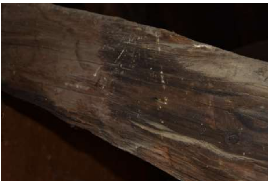
Fot. 114. Układ ramowy w osi E-E: powierzchniowa korozja drewna; na powierzchni zacieki;
