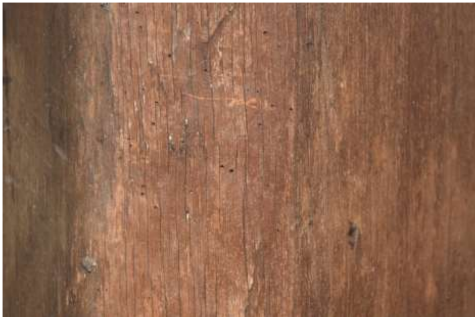
Fot. 8. Fragment stropu: drewno porażone przez owady techniczne szkodniki drewna; na powierzchni widoczne otwory wylotowe;
