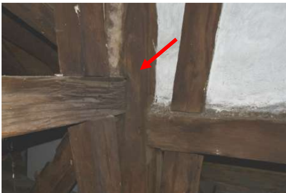
Fot. 21. Słup wieży: słup w dolnej części rozłupany; szczelina do 3 cm;
