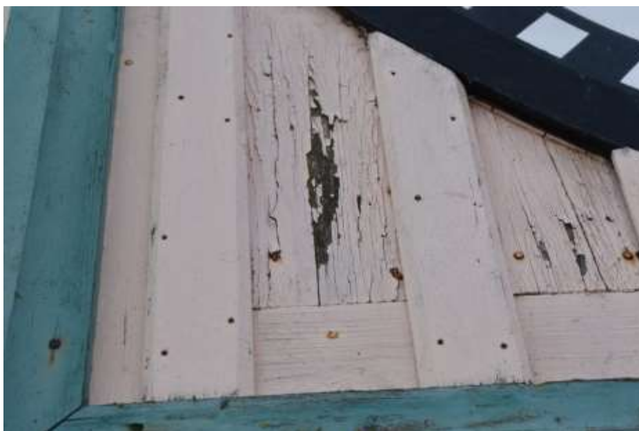
Fot. 295. Fragment elewacji: tarcza zegarowa z blachy stalowej; wokół tarczy deski drewniane z listewkami na połączeniach; deski malowane; złuszczenia warstw malarskich;
