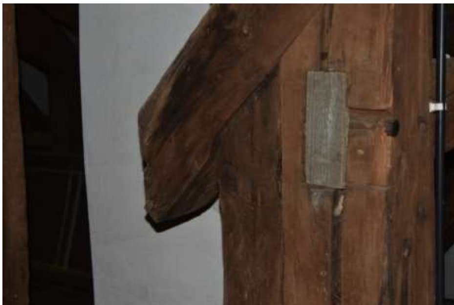
Fot. 63. Układ ściany w osi A-A: na odcinku 3-5 rygiel wycięty;
