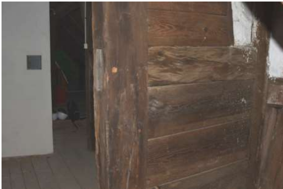
Fot. 32. Słup wieży: słup drewniany o wymiarach 22x25 cm; w miejscu usuniętego rygla gniazdo zaflekowane sztuką nowego drewna;
