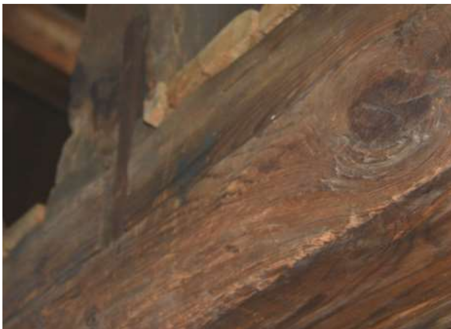
Fot. 246. Fragment stropu: belka w osi D-D o wymiarach 22x24 cm; na belce oparte słupy 6/D i 4/D; słupy mocowane elementem stalowym;
