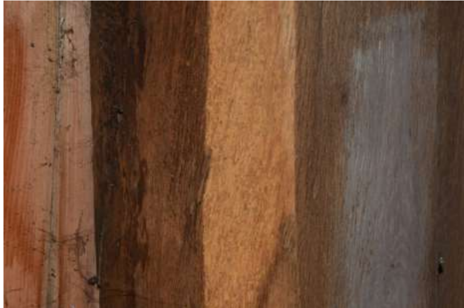
Fot. 165. Ściana w osi 8-8: zastrzał przy osi H-H o wymiarach 18x17 cm; porażony biologicznie; ociosany;
