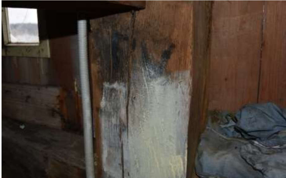
Fot. 143. Słup wieży: drewniany o wymiarach 27x17 cm; od strony deskowania nakładka grubości 3cm; silnie porażona biologicznie; drewno słupa z pęknięciami wzdłuż włókien;
