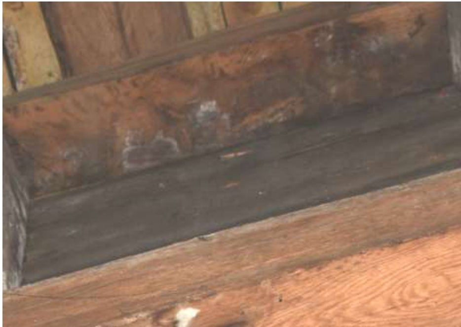
Fot. 70. Układ ściany w osi A-A: oczep w poziomie IV o wymiarach 22x20 cm; na powierzchni drewna zacieki; korozja biologiczna
