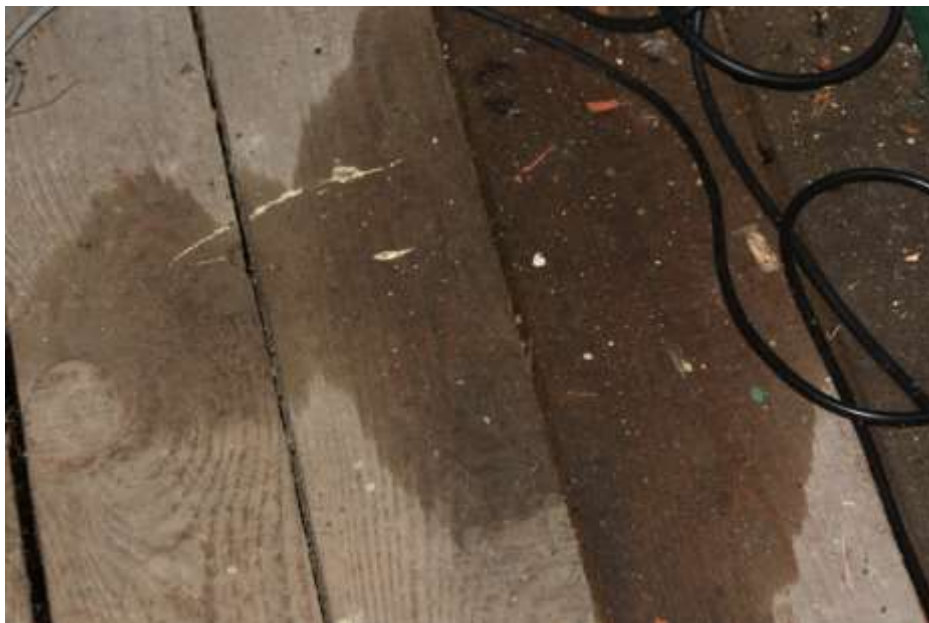
Fot. 255. Fragment stropu: podłoga z desek o grubości 3,2mm; na powierzchni zabrudzenia;
