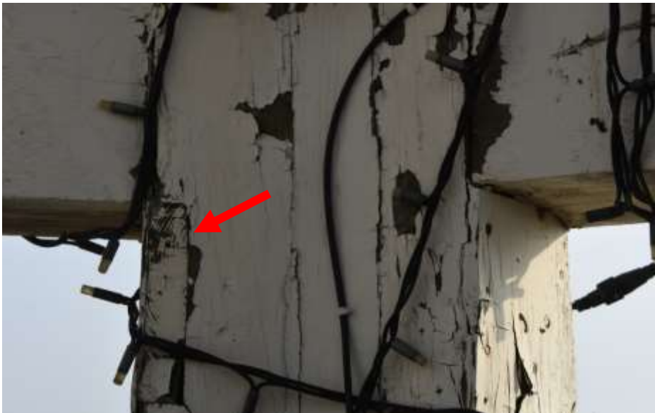
Fot. 229. Słup wieży: w dolnej części na słup wywinięta blacha miedziana; ślady uszczelnienia kitem na połączeniu; drewno zawilgocone; skorodowane; korozja sklejki;
