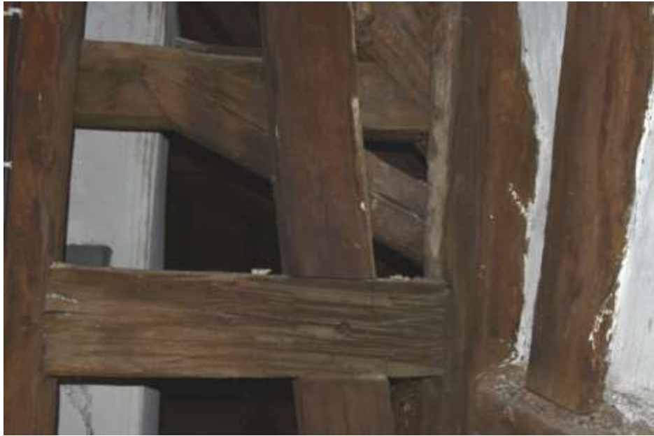
Fot. 59. Układ ściany w osi A-A: zastrzał pomiędzy osiami 7-9 o przebiegu ukośnym od podstawy słupa 9/A w kierunku słupa 7/A;
