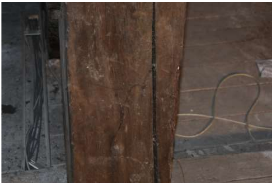
Fot. 4. Słup wieży: w dolnej części słup rozwarstwiony; szczelina do 1 cm; drewno z zaciekami;
