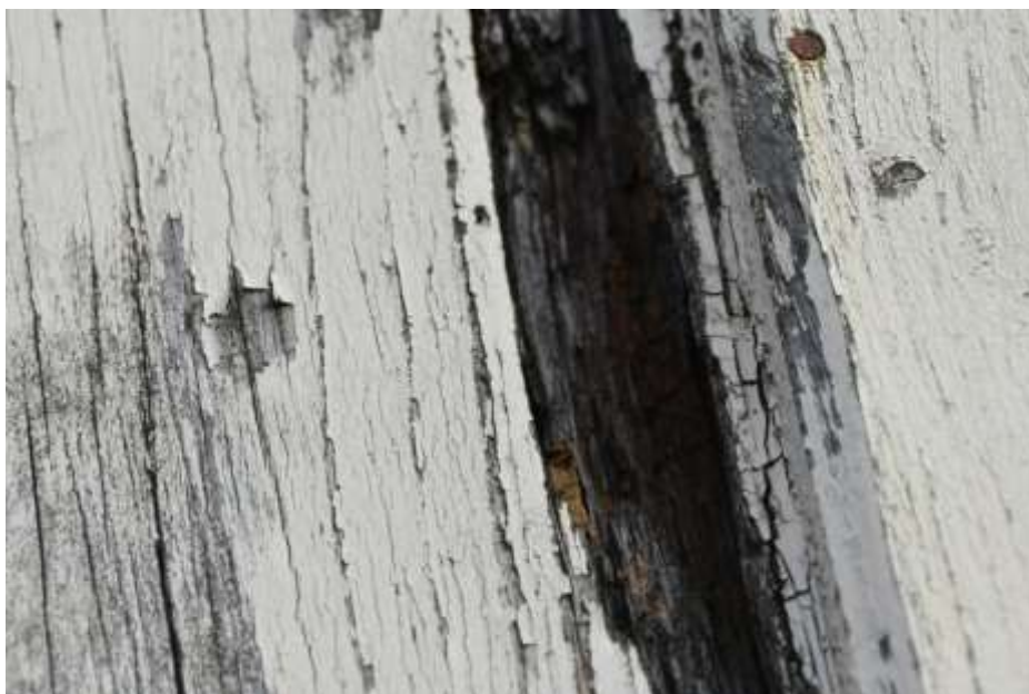
Fot. 324. Fragment elewacji: deski poszycia na pióro i wpust z listewkami na połączeniach; drewno malowane; złuszczenia warstw malarskich;
