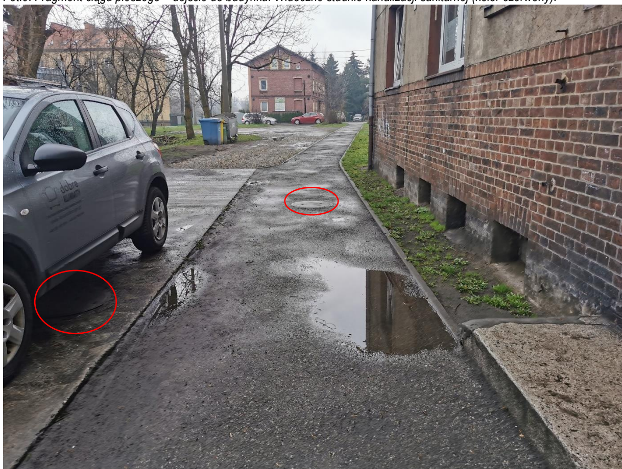
Fot.10. Fragment ciągu pieszego – obecne dojście do budynku o nawierzchni z asfaltobetonu, od ul. Oswobodzenia. Widoczne studnie kanalizacji sanitarnej (kolor czerwony).
