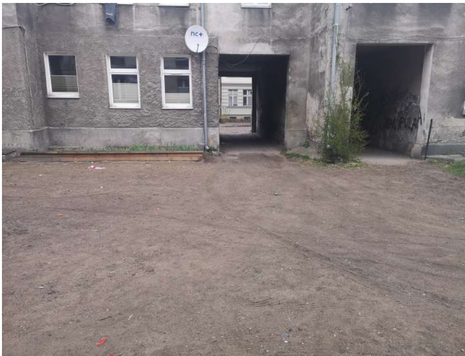
Przejście w przejściu budynku
