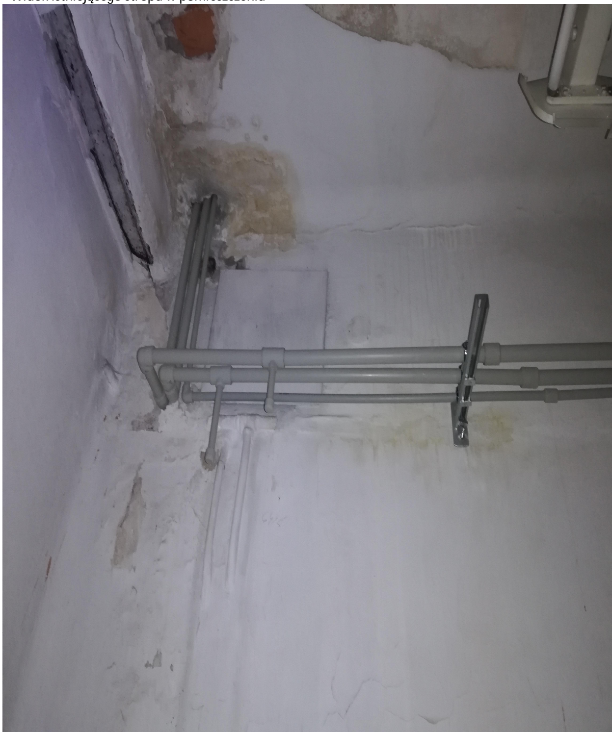
- Widok istniejącego stropu w pomieszczeniu
