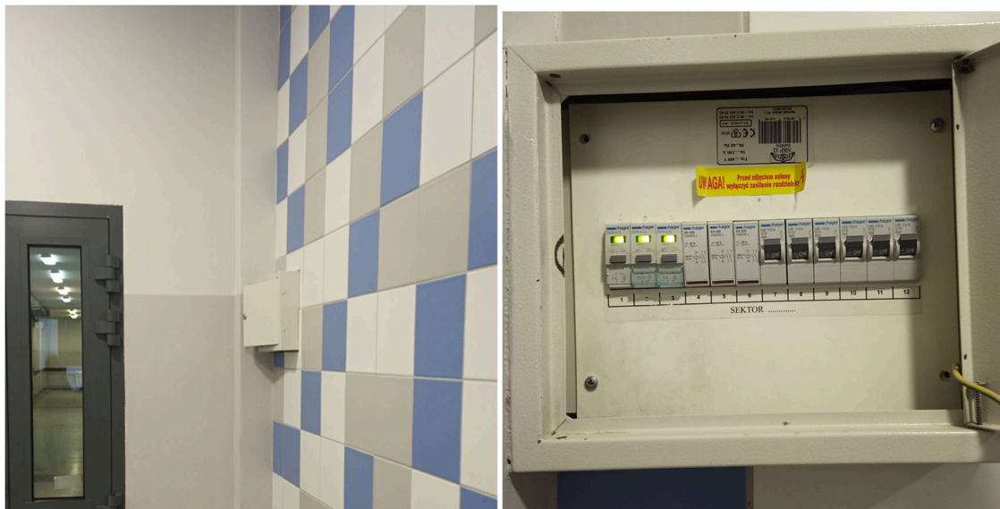
Istniejąca rozdzielnia sterowania oświetleniem sali gimnastycznej przeznaczona do likwidacji.
