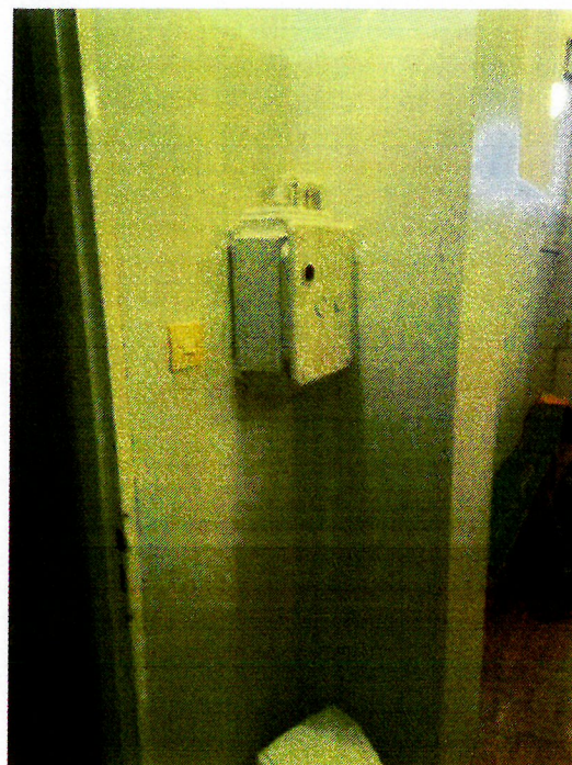
Zdj. Nieczynne zasilanie systemu wentylacji – do odłączenia i demontażu, ewentualne pozostałe przewody należy zabezpieczyć i zasłonić.
