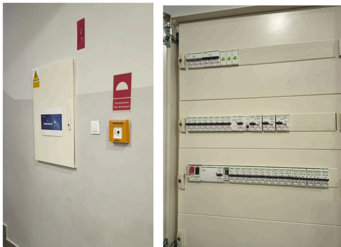
Istniejąca rozdzielnia RS1 (parter) podlegająca modernizacji
