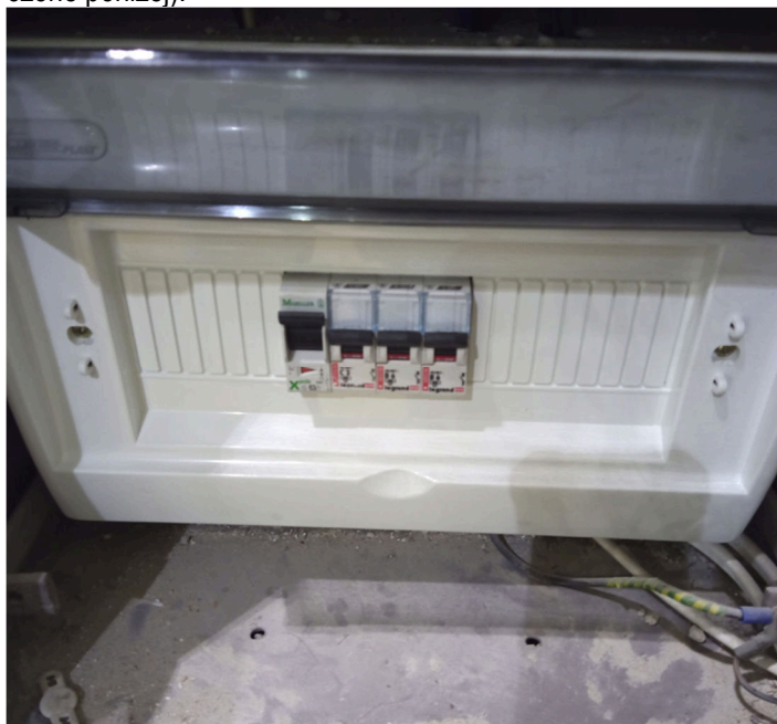
Obwody zasilania nagłośnienia w istniejącej rozdzielni na sali gimnastycznej
