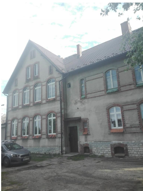
Fot.1 Fragment elewacji południowo-zachodniej
