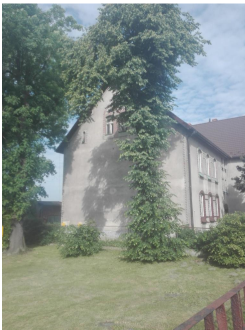
Fot.4 Elewacja południowo-wschodnia
