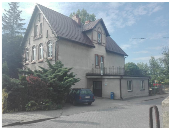
Fot.6 Elewacja północno-zachodnia
