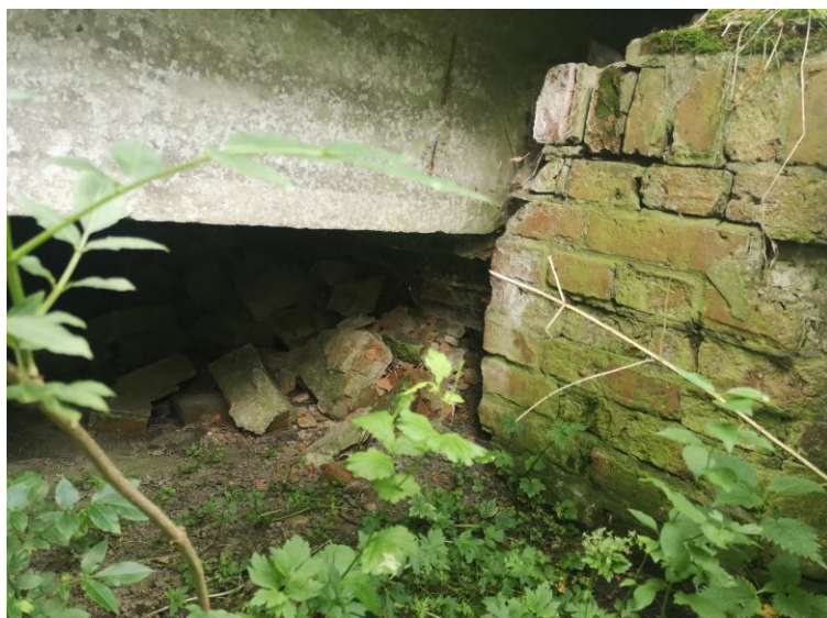
Fot. Widok wylotu – uszkodzone podparcie dla płyty nośnej.
