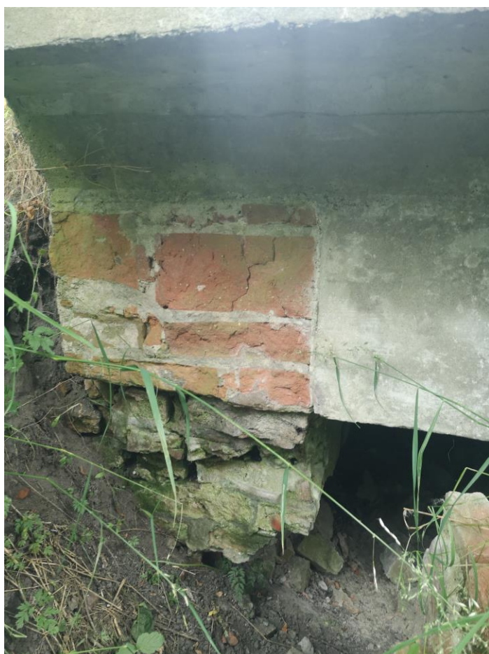
Fot. Widok wlotu – uszkodzony przyczółek i podparcie
