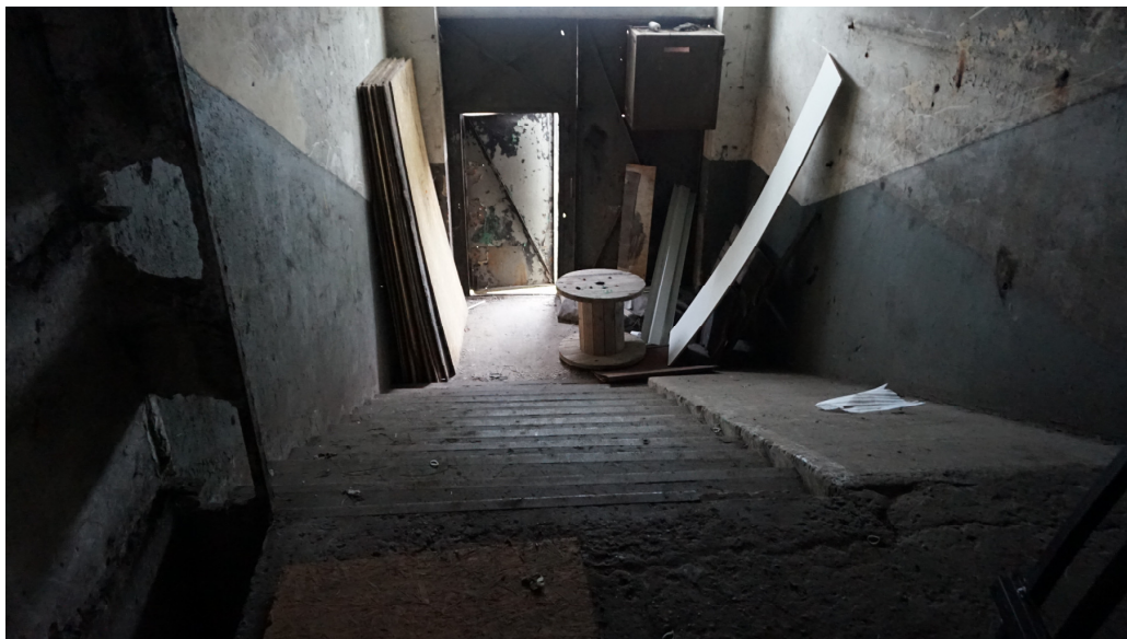
Fot. 8 Schody prowadzące z zewnątrz budynku na poziom posadzki.
