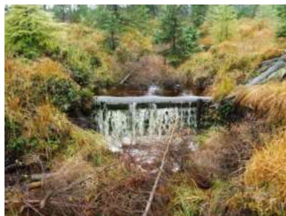
Próg drewniany na rowie odprowadzającym wodę z torfowisk po zboczu oraz rumosz drzewny wrzucany do rowu celem przyspieszenia zarastania – Nadleśnictwo Świeradów. Źródło: Archiwum CKPŚ
