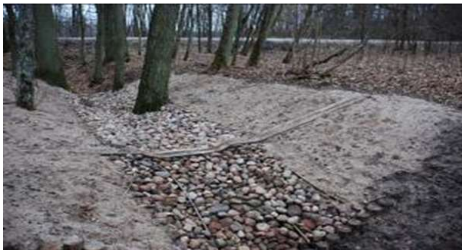
Bystrzok faszynowo-kamienny z drewnianą ścianką szczelną i palisadą drewnianą w Nadleśnictwie Strzałowo (fot. M. Goździk)
