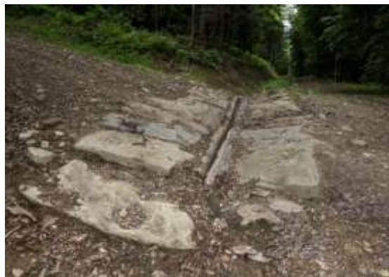
Wodospust odprowadzający wodę z drogi do lasu.
