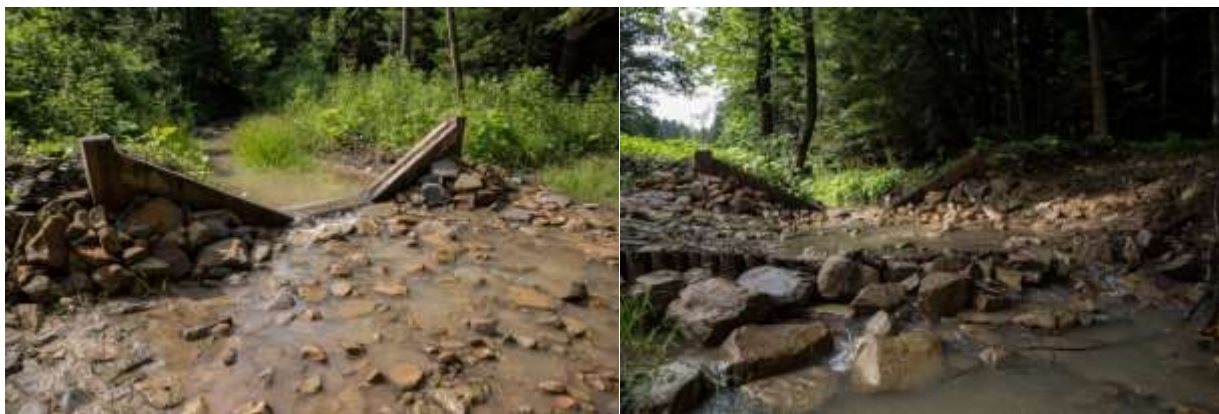
Próg powyżej brodu ukierunkowujący wodę na bród.
