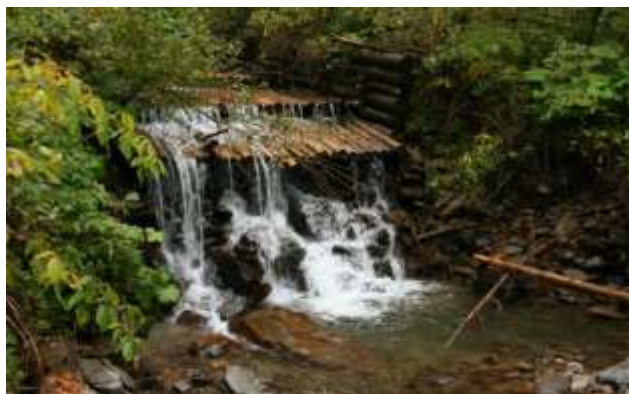
Tego typu konstrukcje są mało odporne na niszczące działanie wód wezbraniowych. Źródło: Archiwum CKPŚ
