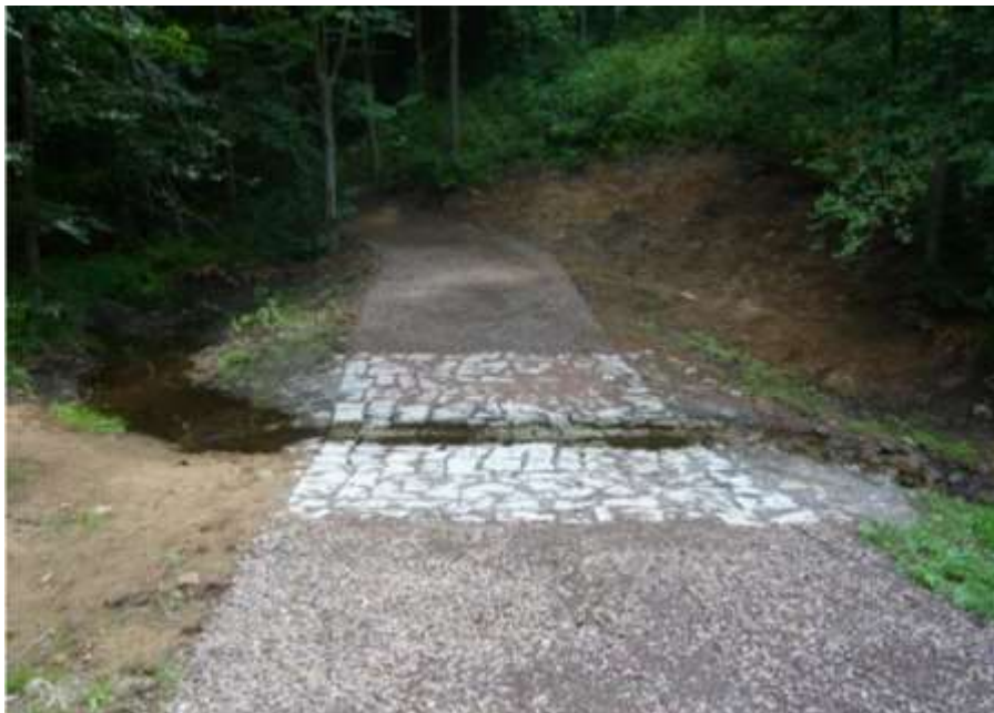
Bród w układzie „V” koncentrujący wodę pośrodku – Nadleśnictwo Wałbrzych (fot. Ryszard Majewicz)
