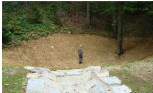
Miejsca na mikrozbiorniki wykopane na zboczach górskich zasilane splotem powierzchniowym przygotowane w Nadleśnictwie Piwniczna – Źródło: Archiwum CKPŚ.
