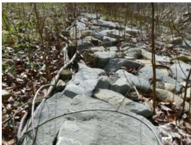
Zabezpieczony faszyną narzut kamienny z nasadzeniami wierzbowymi. Źródło: Archiwum CKPŚ
