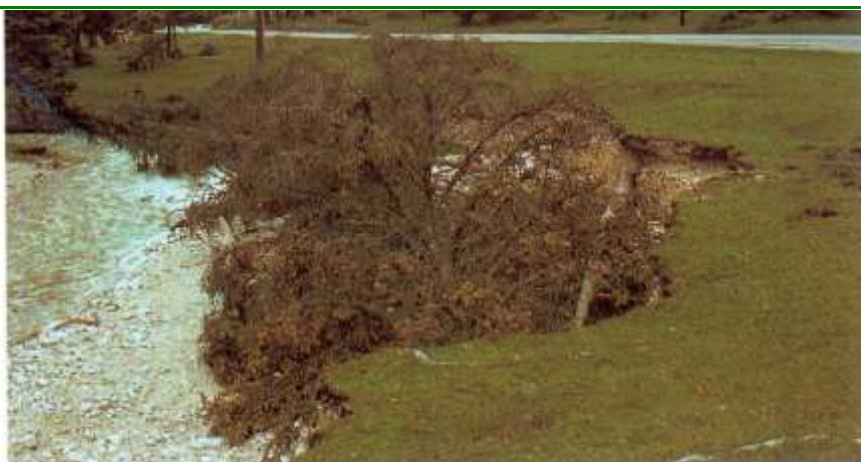
Powalony świerk zabezpieczający podmyty brzeg (Begemann i Schiechl 1999)
