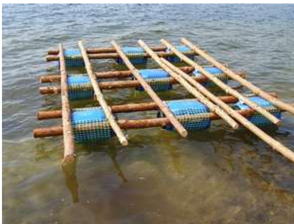
Ptasia wyspa w Lednicy (konstrukcja) - źródło: http://old.zpkww.pl
