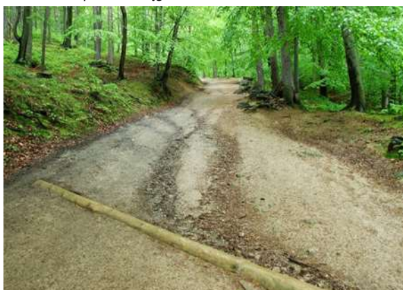
Wodospust z pojedynczego okrągłaka
