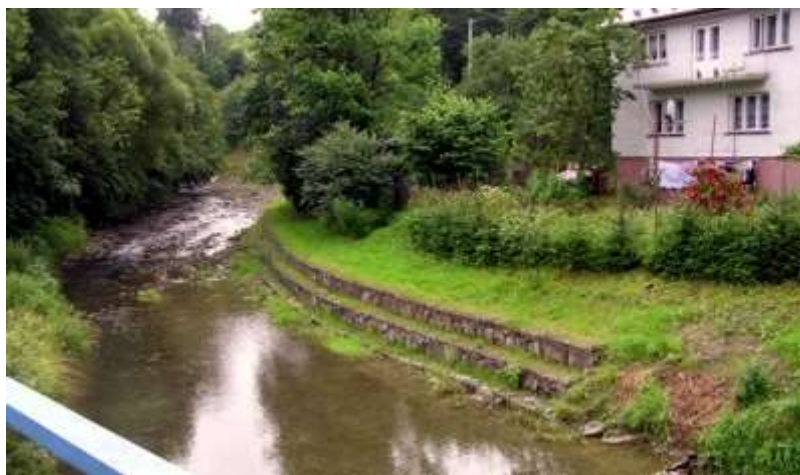
Fot. 3. Zabezpieczenie konstrukcji budowlanych
