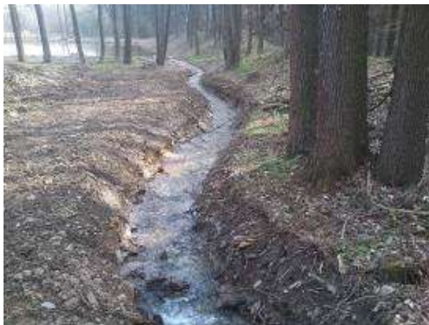
Kanał ziemny łączący 2 zbiorniki (N-ctwo Świdnica)
