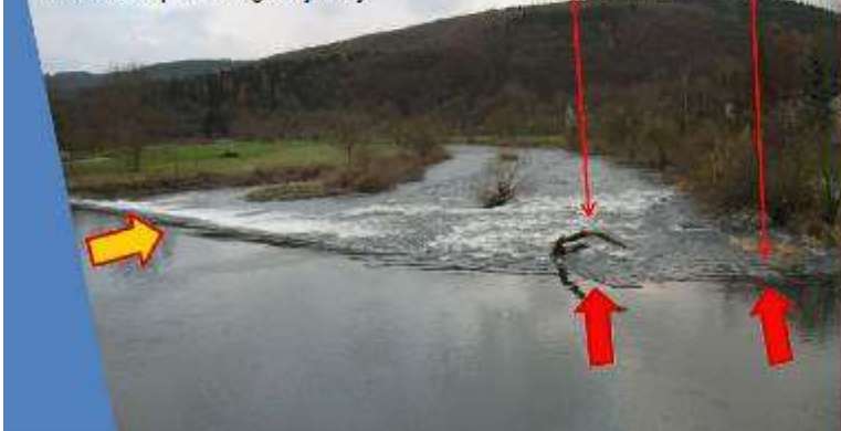
Bystrze dwuspadowe na stopniu poniżej mostu (Jelonek 2008)
