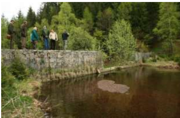
Bliźniaczo podobny materiał zgromadzony w zaporze jak na prawym zdjęciu przygotowany sztucznie. Źródło: Archiwum CKPŚ.
