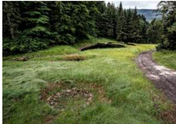
Doły chłonne i kałuże przejmujące wodę odprowadzaną rowkami z drogi. Warto zwrócić uwagę, że sytuacja terenowa położenia drogi względem cieku bardzo sprzyja odprowadzeniu wody z drogi wodospustami i dolotami także do zbiorników widocznych poniżej. Źródło: Archiwum CKPŚ.
