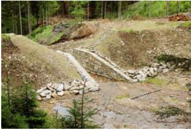
Widok na zaporę czołową dawnego zbiornika na cieku do spławu drewna przerobionego na zbiornik przeciwpowodziowy – Nadleśnictwo Międzyzlesie. Źródło: Archiwum CKPŚ. (rys. na górze)
