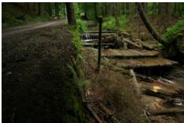
Tego typu konstrukcje są mało odporne na niszczące działanie wód wezbraniowych. Źródło: Archiwum CKPŚ
