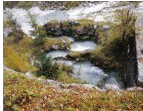
Przeplawka z połączonych akwenów (Żbikowski i Żelazo 1993, fot. M. Jelonek 2008): 1 – zapora/jaz 2 - akweny 3 - połączenia
