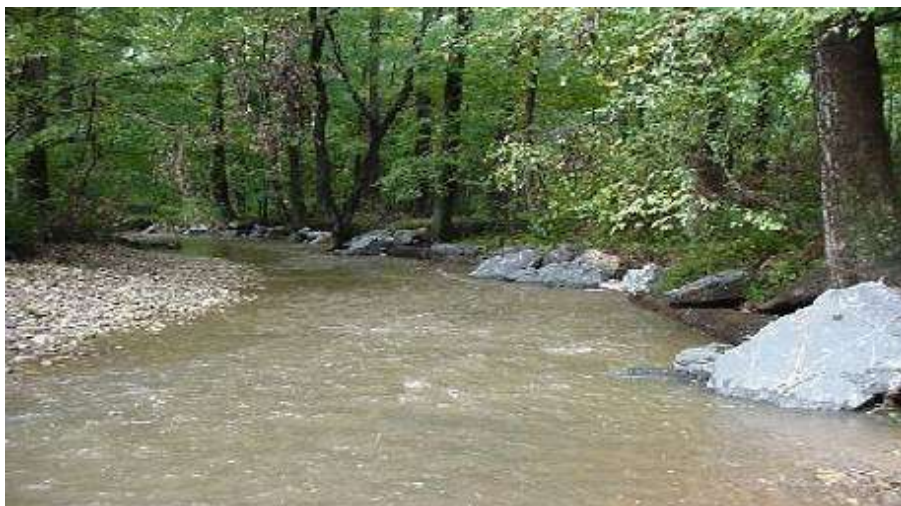
Zabezpieczenie brzegu wklęsłego głazami (fot. Montgomery County Department of Environmental Protection)
