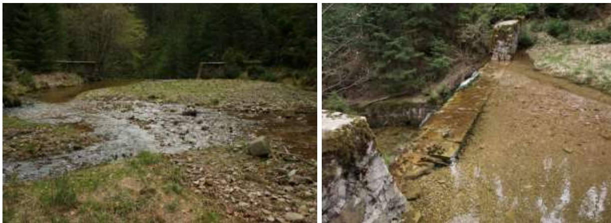
Rumosz różnych frakcji zalegający w czaszy różnych zapór – Nadleśnictwo Łądek Zdrój. Źródło: Archiwum CKPŚ.
