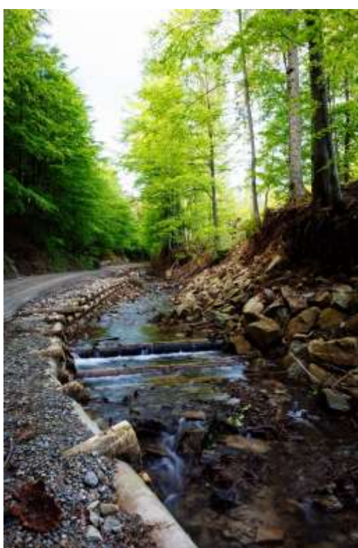
Poniżej progu widoczne są dwa „baseny”, próg pośredni i gurt. Niestety próg nie ma przelewu na małą wodę. Źródło: Archiwum CKPŚ.
