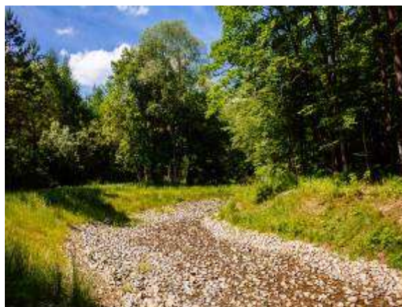
Bystrze o zwiększonej szorstkości w miejscu rozebranego betonowego jazu, przywracające ciągłość biologiczną cieku
