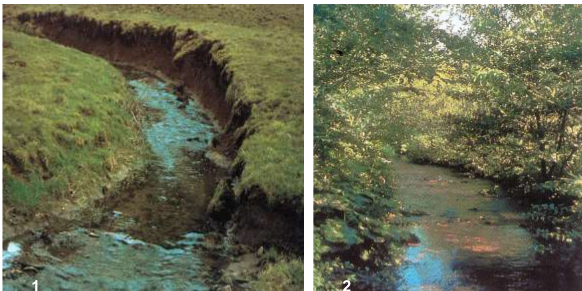
Fot. 1. Zabudowa biologiczna brzegów potoku: 1 - stan wyjściowy, 2 - stan po 10 latach (Begemann i Schiechtl 1999)
