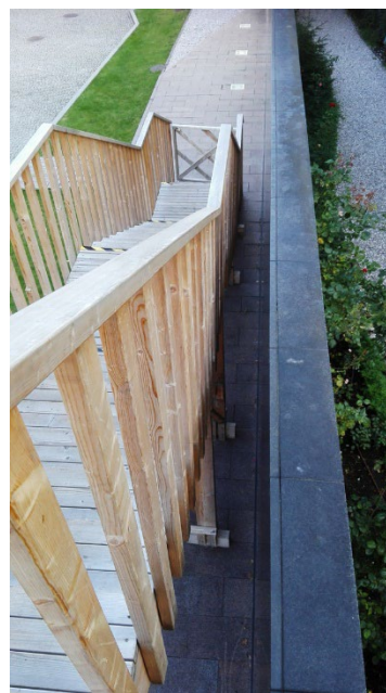
Widok na schody z poziomego pomostu.
