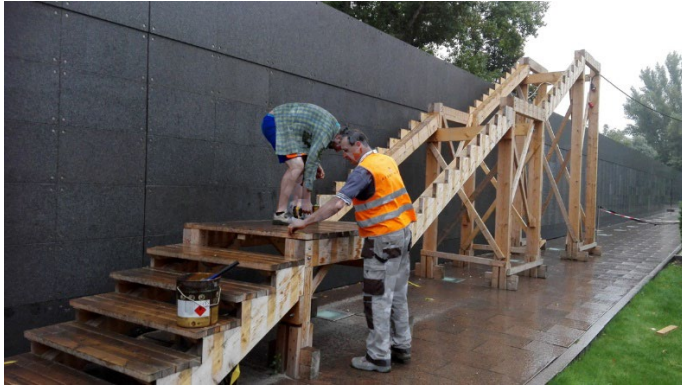
Demontaż schodów przy Murze Pamięci we wrześniu 2017r.
