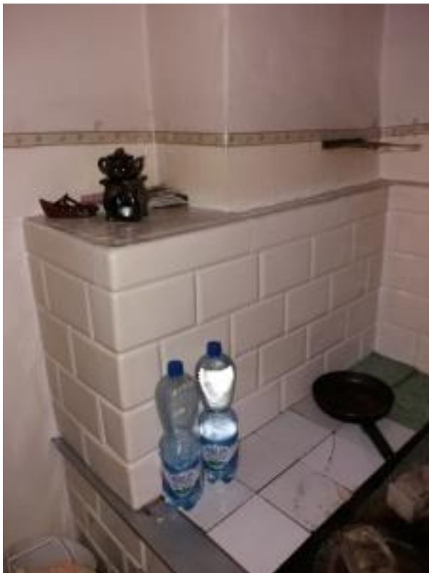
Trzon kuchenny jako źródło ogrzewania budynku
