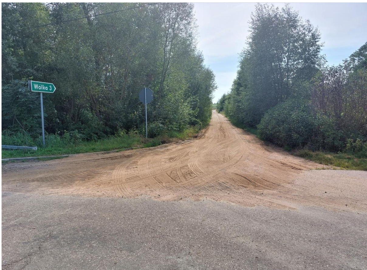
Foto nr 1 Początek DG 103601B w obrębie skrzyżowania w m. Bierwicha w km ewidencyjnym 2+650 na wysokości krawędzi istniejącej nawierzchni bitumicznej DP2114B.
