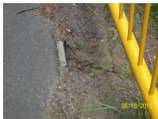
Przepusty - luźne kamienie zabruku do ponownego montażu
