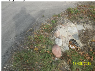
Przepusty - luźne kamienie zabruku do ponownego montażu
