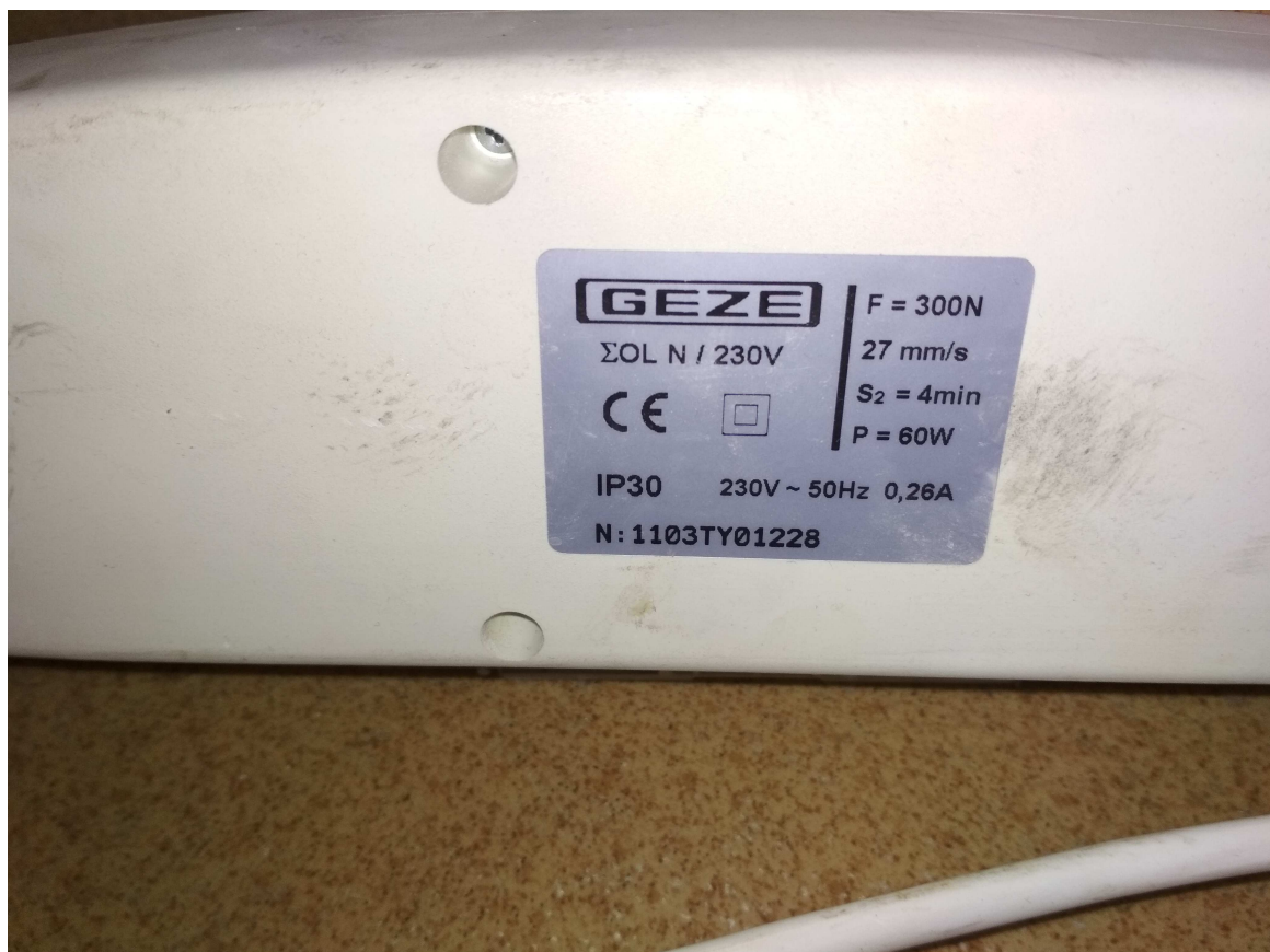
Fotografia nr 8: Typ siłowników okiennych (materiały powierzone przez Zamawiającego)
