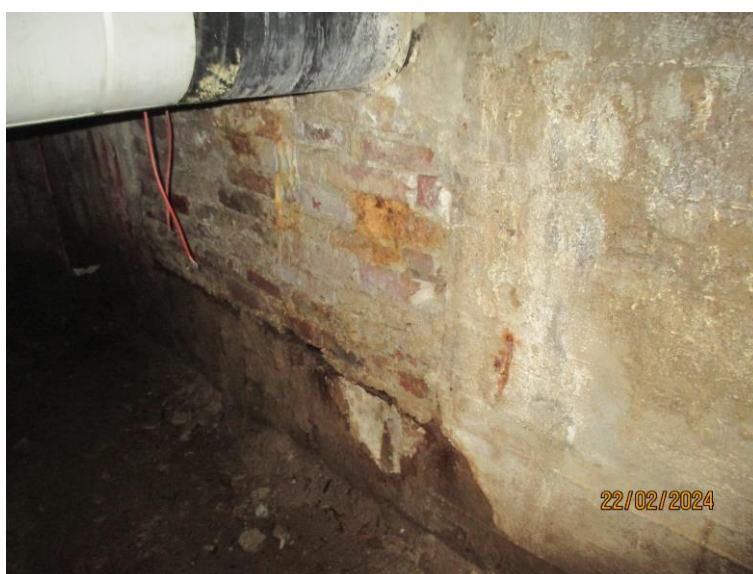
Fot. 8. Widok na otwór dla instalacji rurociągów – замуrowany, ściana zachodnia Źródło pochodzenia fotografii: źródło własne
