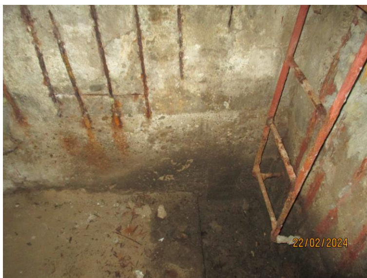
Fot. 7. Widok na narożnik ścian żelbetowych i rzępie w dnie komory Źródło pochodzenia fotografii: źródło własne
