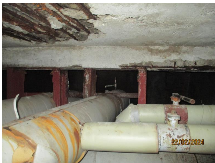
Fot. 5. Widok na podciąg stropu komory Źródło pochodzenia fotografii: źródło własne
