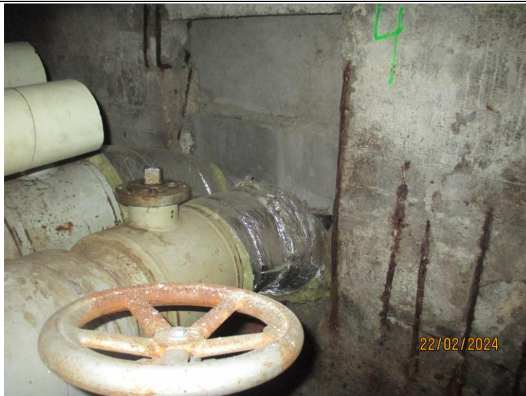
Fot. 9. Widok na otwór dla instalacji rurociągów – zaślepiiony elementami prefabrykowanymi, ściana południowa Źródło pochodzenia fotografii: źródło własne
