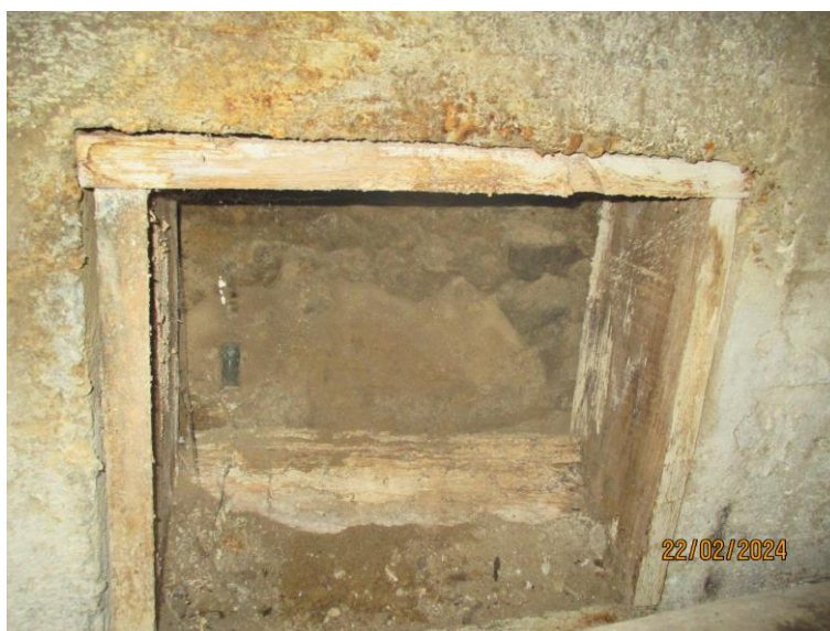
Fot. 11. Widok na otwór po instalacji rurociągów – niezaślepiiony, ściana północna Źródło pochodzenia fotografii: źródło własne
