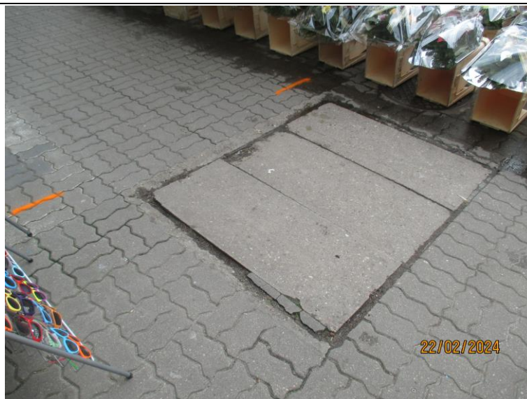
Fot. 3. Widok na płyty przykrywające otwór technologiczny Źródło pochodzenia fotografii: źródło własne
