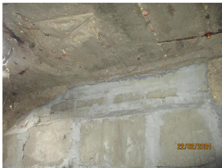
Fot. 7. Widok na ścianę w miejscu otworu instalacyjnego w ścianie północnej (od strony ul. Podolskiej). Miejsce projektowanego nadproża. Źródło pochodzenia fotografii: źródło własne
