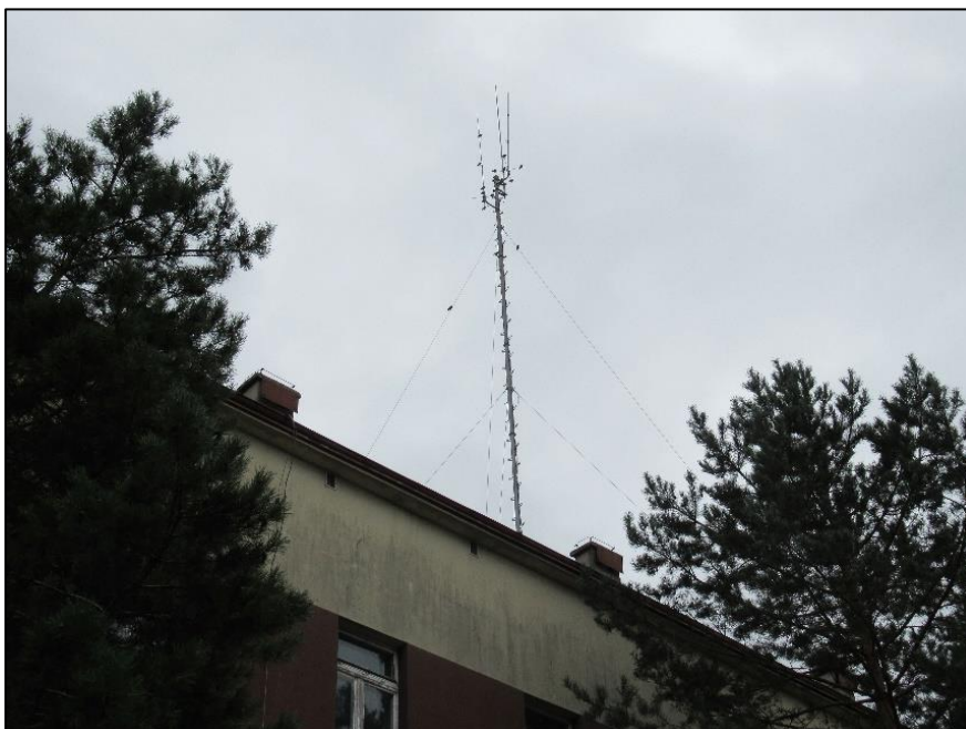
Zdjęcie nr 10. Wspornikowy maszt antenowy z odciągami na dachu budynku „A”. Zabrudzenia osadem na zewnętrznych ścianach ocieplonych styropianem w systemie izolacji termicznej ETICS z tynkiem cienkowarstwowym.
