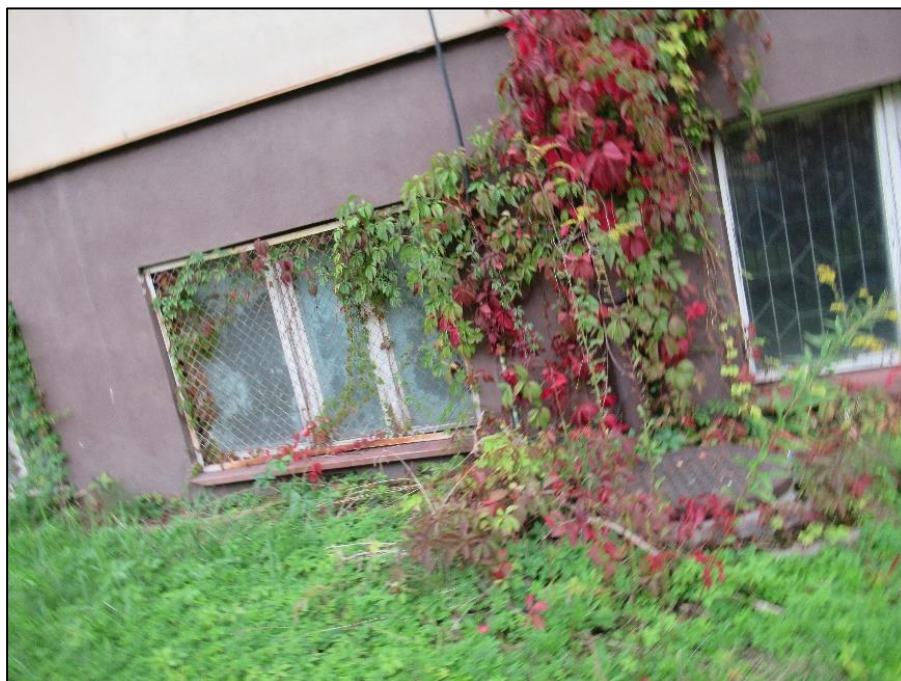
Zdjęcie nr 16. Fasada wschodnia budynku „A”. Nieocieplona strefa cokołowa z malaturą. Nasyp ziemny porośnięty trawą z nasadzeniami bluszczem ściany poprzecznej od strony pomieszczeń schronowych. Przy oknach piwnicznych studzienka kanalizacji sanitarnej.
