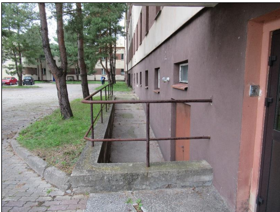
Zdjęcie nr 8. Elewacja południowa. Zespołowa zabudowa budynków „A” i „B”. Pochylnia dojścia do pomieszczenia kablowni w budynku „A”. Nieocieplona strefa cokołowa z malaturą. Tereny zielone porośnięte trawą z nasadzeniami wysokimi drzewami.
