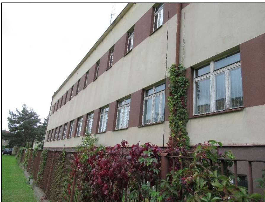
Zdjęcie nr 14. Fasada wschodnia budynku „A”. Zewnętrzne ściany ocieplone styropianem w systemie izolacji termicznej ETICS z tynkiem cienkowarstwowym. Nieocieplona strefa cokołowa z malaturą. Ogrodzenie zewnętrzne porośnięte bluszczem i tereny zielone.
