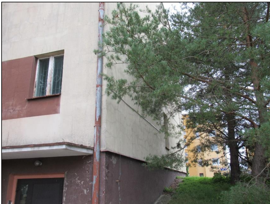
Zdjęcie nr 9. Elewacja południowa budynku „A”. Nasyp ziemny porośnięty trawą z nasadzeniami wysokimi drzewami, nad poziomą czerpnią powietrza z wyjściem awaryjnym z pomieszczeń piwnicznych schronu. Nieocieplona strefa cokołowa z malaturą.
