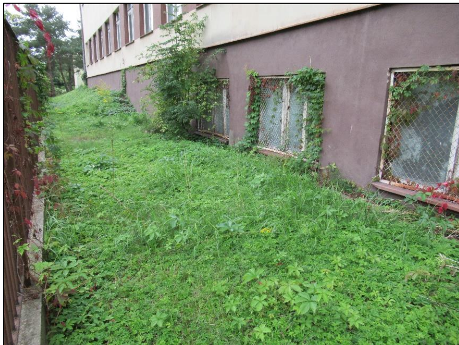
Zdjęcie nr 15. Fasada wschodnia budynku „A”. Nieocieplona strefa cokołowa z malaturą. Nasyp ziemny ściany poprzecznej z pomieszczeniami schronowymi. Teren zielony porośnięty trawą, z nasadzeniami niskim krzewami samosiejkami i bluszczem.
