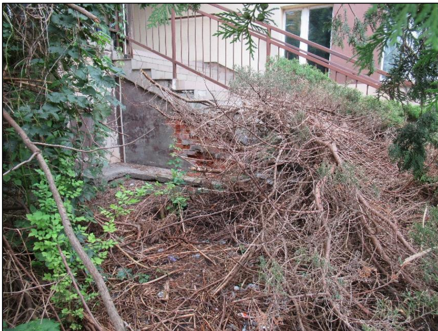
Zdjęcie nr 13. Budynek „A” elewacja zachodnia. Odpadnięte płytki na zewnętrznych schodach i odpadnięty tynk odsłaniający materiał ceramiczny ściany dojścia do budynku „A”. W otoczeniu nasadzenia niskimi krzewami.
