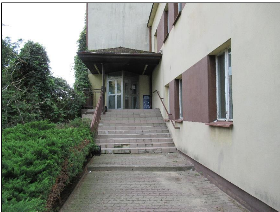
Zdjęcie nr 12. Budynek „A” elewacja zachodnia. Odpadnięte płytki na zewnętrznych schodach dojścia do budynku „A” i lokalnie zapadnięta kostka przed wejściem.
