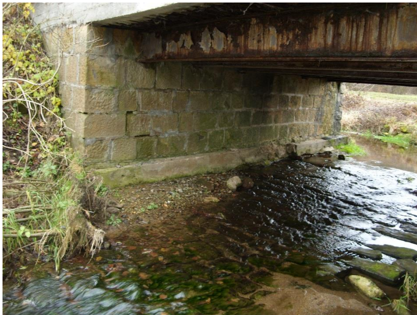
Fot. 4. Widok na podporę nr 2.
