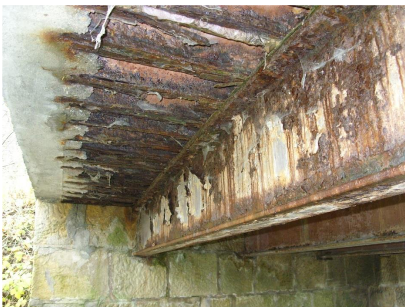
Fot. 3. Widok przęsła mostu od spodu.
