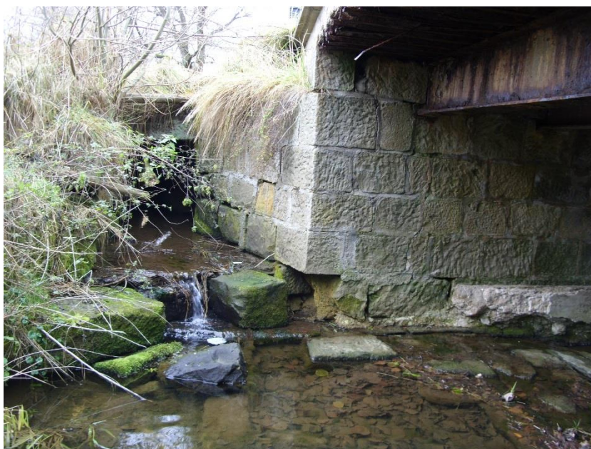
Fot. 5. Widok na podporę nr 1 oraz na przepust płytowy przy skrzydle podpory.
