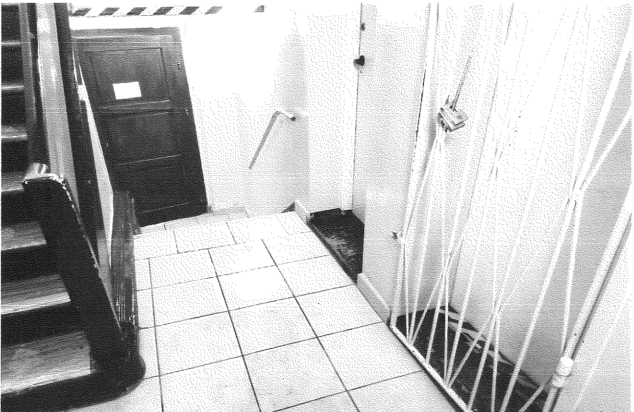
Istniejąca przestrzeń swobodna nad schodami wejściowymi
