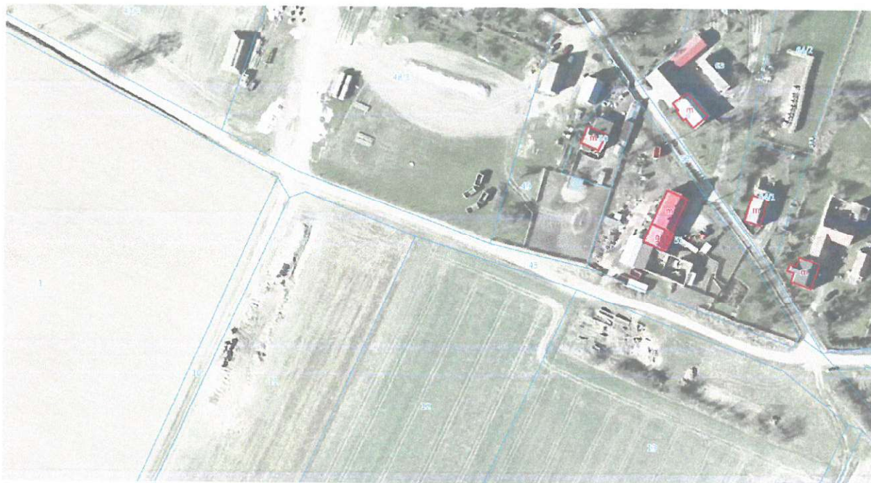
Rys. nr 2. Przebieg drogi w terenie, odcinek w obszarze o charakterze zabudowanym.
