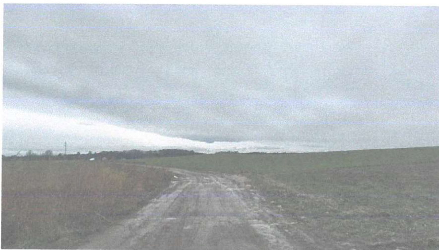
Fot. Nr 4. Widok drogi niepublicznej-końcowy odcinek drogi przewidzianej do przebudowy.
