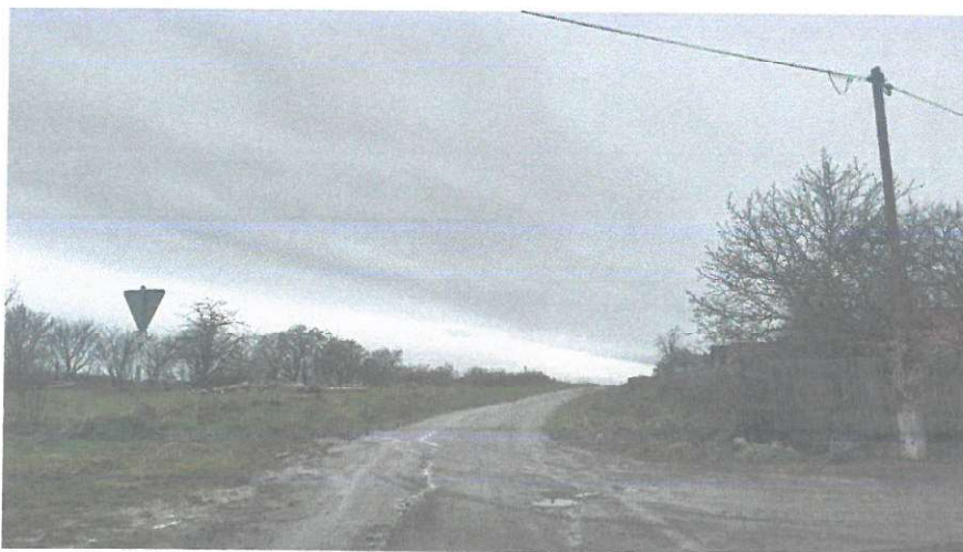
Fot. Nr 1. Początek przebiegu drogi.
