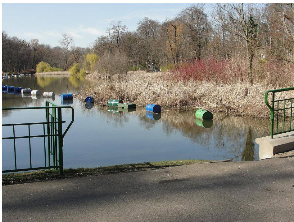
Fot. 8. Pływaki do poprowadzenia rurociągu z refulera po powierzchni stawu
