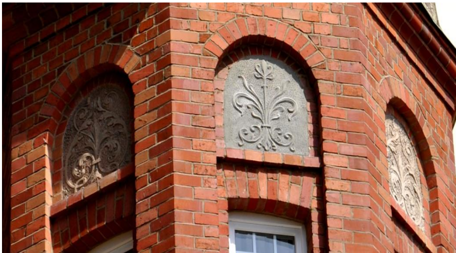
Fot. 1. Szprotawa, ul. Niepodległości 6, lokalizacja ozdobnych płytek nad trzecią kondygnacją okien.
