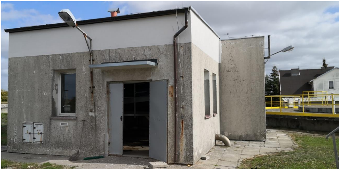
Fot. 4 Budynek mechanicznego oczyszczania ścieków
