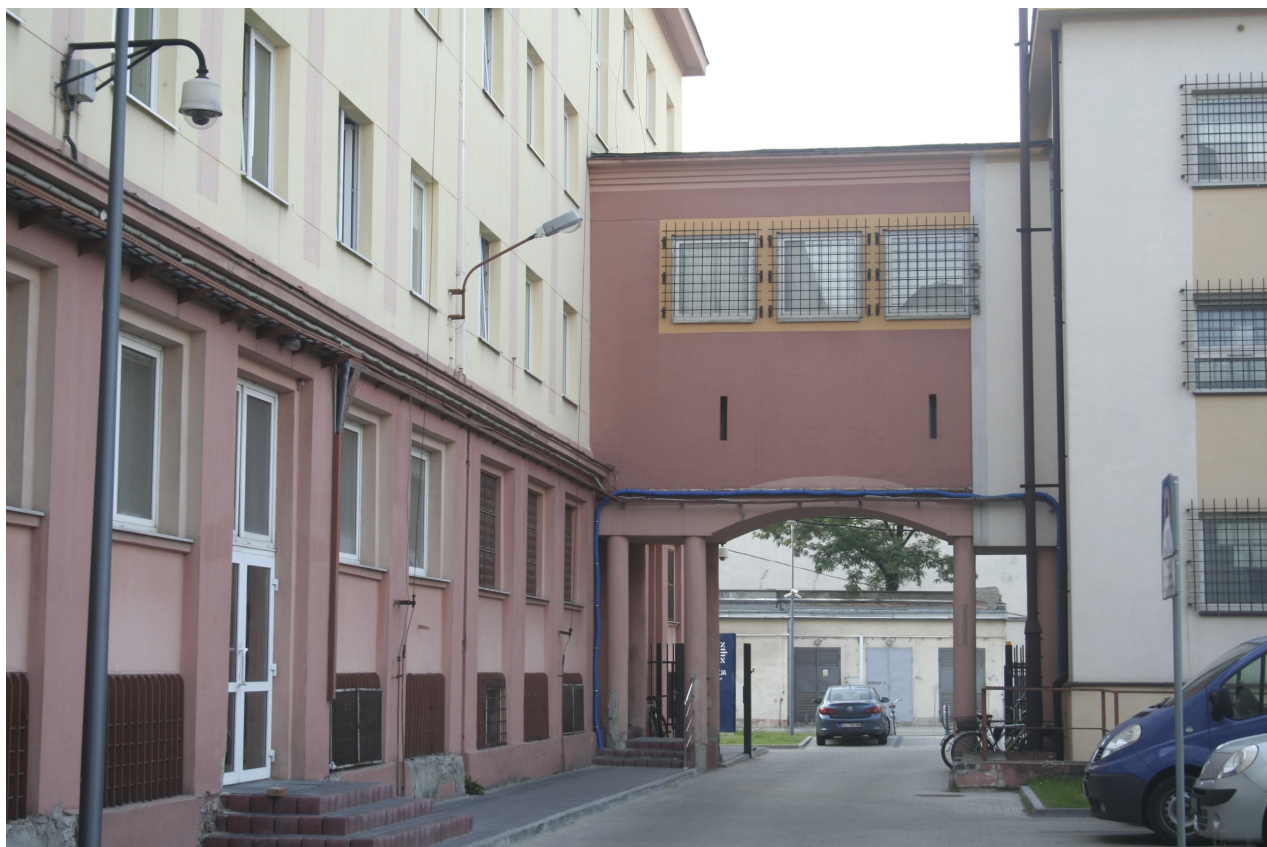
Elewacja wschodnia (część północna – łącznik z drugim budynkiem).
