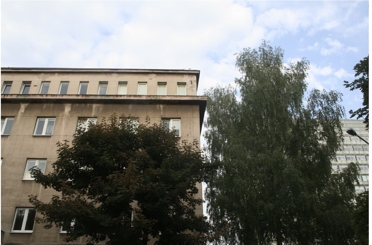
Elewacja zachodnia (część południowa).
