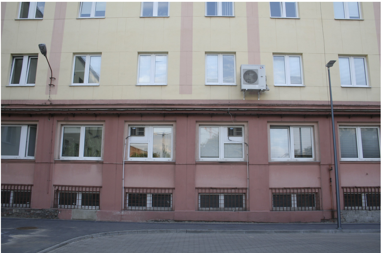
Elewacja wschodnia (część środkowa).
