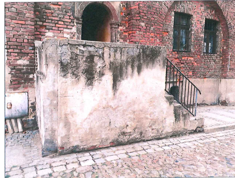
2. Widok boczny schodów
