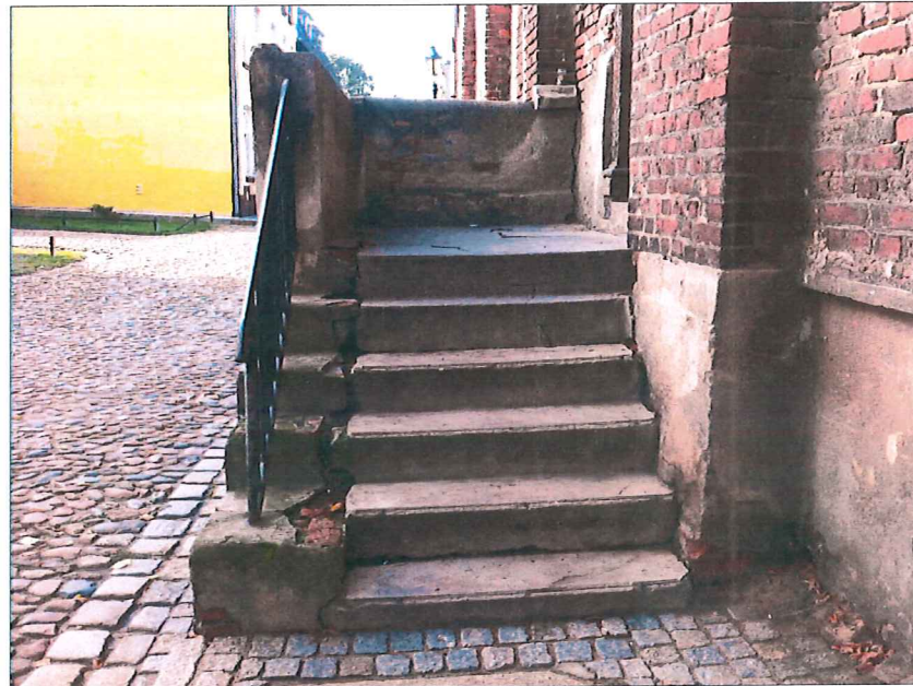
1. Bieg schodowy od czola
