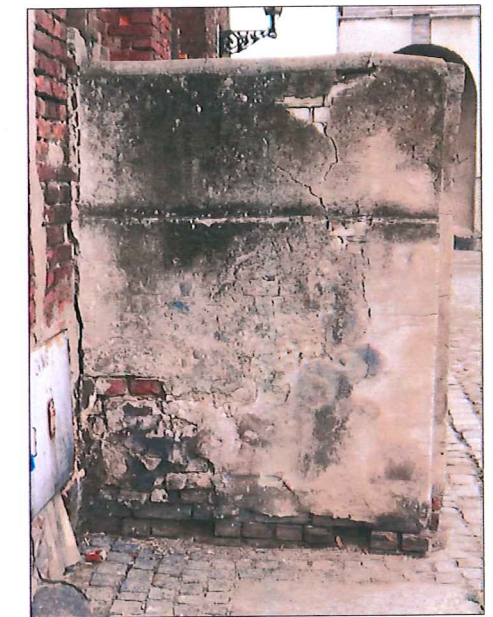
8. Widok ściany tylnej schodów
