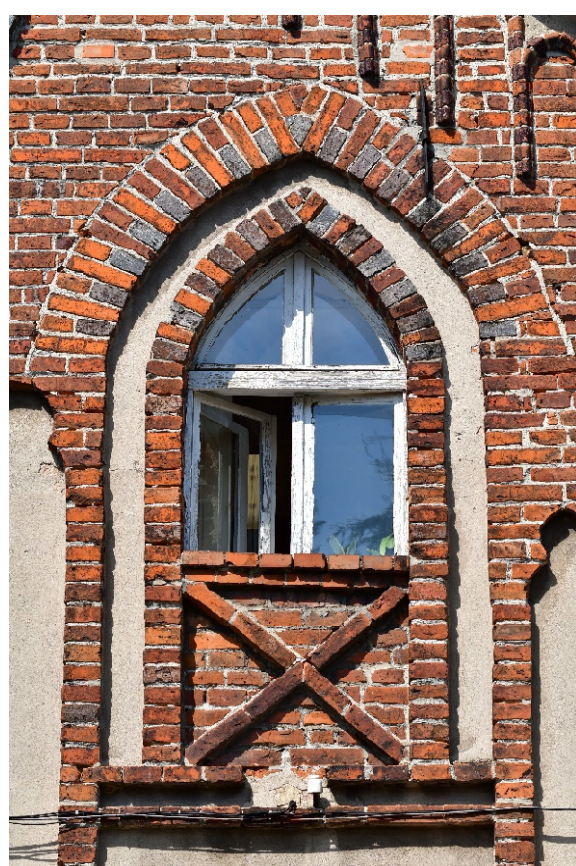
Fot. 11. i 12. – Okna '09' (lewe) i '010' (prawe) na poddaszu elewacji południowej: opaski murowane z jednakowych cegieł, do rekonstrukcji/uzupełnienia/wymiany na szklwione co drugą cegła w łuku; parapety obu okien wtórne (rozebrać, ew. uzupełnić uszkodzone/brakujące elementy niszy, a nowe parapety wymurować z pojedynczej warstwy cegieł główkowo o wymiarze pierwotnym)
