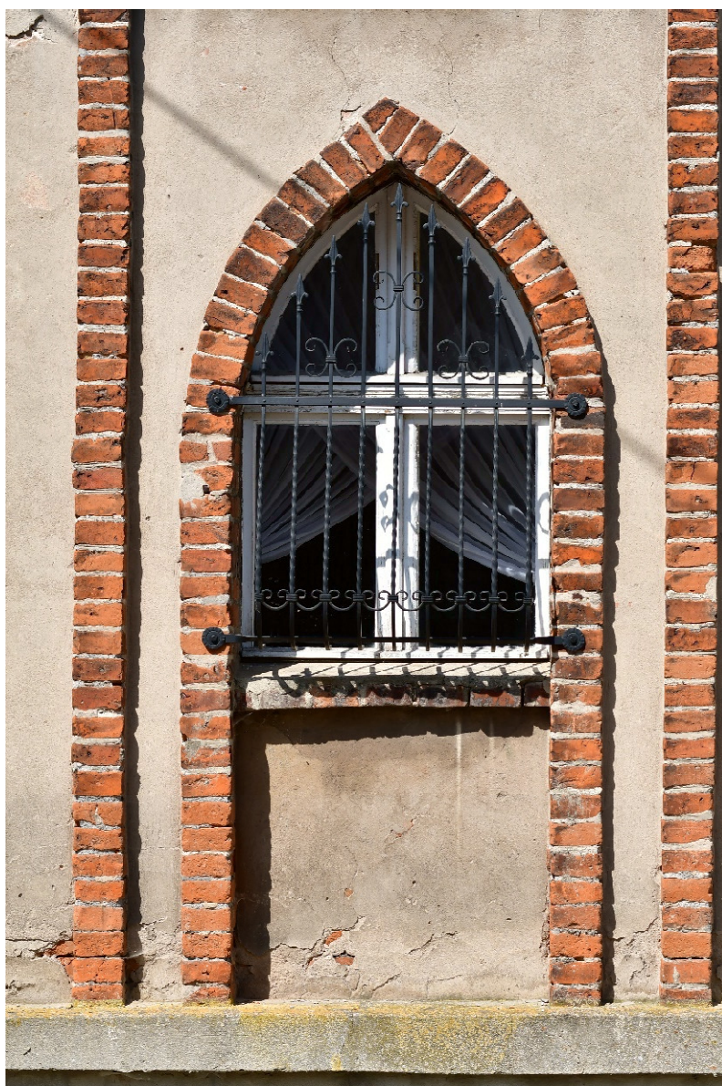
Fot. 13. – Okno '01' na parterze elewacji południowej: opaska murowana z jednakowych cegieł, do uzupełnienia/wymiany na glazurowane co druga cegła w łuku (szkliwo mocno zniszczone); cofnięty względem lica opaski parapet z pojedynczej warstwy cegieł murowanych główkowo; nisza podokienna wtórnie tynkowana po rozbiórce istniejących wcześniej skrzyżowanych na skos pasów cegieł – do odtworzenia
