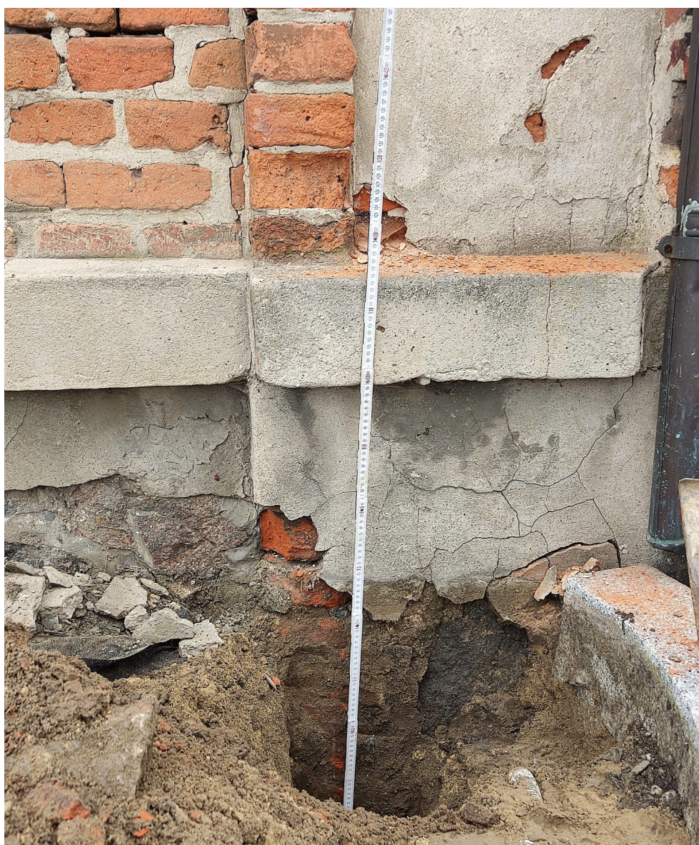
Fot. 1. – Miejscowa odkrywka w gruncie przy budynku w północno-wschodnim narożniku; brak izolacji przeciwwilgociowych, opracowanie narożnika z różnych drobnowymiarowych elementów murowych (cegły i łupane skały wulkaniczne), wtórne i szczelne tynki cementowe w strefie ponad powierzchnią terenu
