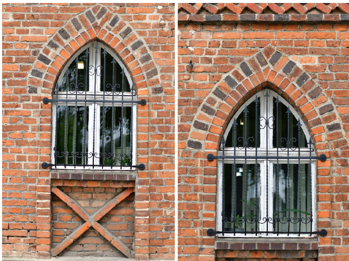
Fot. 16. i 17. – Okna '04' (lewe) i '05' (prawe) na parterze elewacji frontowej wschodniej, po prawej stronie wejścia: opaski murowane górą wtórnie z węższych cegieł (do przemurowania jak niżej z jednakowych cegieł i z zastosowaniem co drugiej cegły szklwionej w łuku); parapety obu okien wtórne (rozebrać, a nowe parapety wymurować z pojedynczej warstwy cegieł główkowo o wymiarze pierwotnym)
