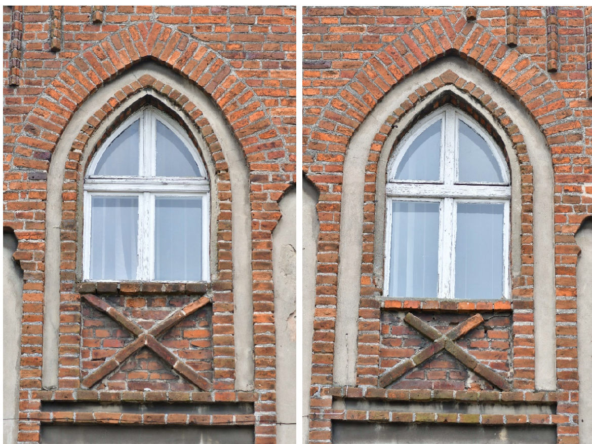
Fot. 9. i 10. – Okna '012' (lewe) i '013' (prawe) na poddaszu elewacji północnej: opaski murowane górną wtórnie z węższych cegieł (do przemurowania jak niżej z jednakowych cegieł i z zastosowaniem co drugiej cegły szklwionej w łuku); parapet okna '013' wtórny (rozebrać, elementy niszy z brakującymi fragmentami skosów uzupełnić, a nowy parapet wymurować wyżej, z pojedynczej warstwy cegieł główkowo)
