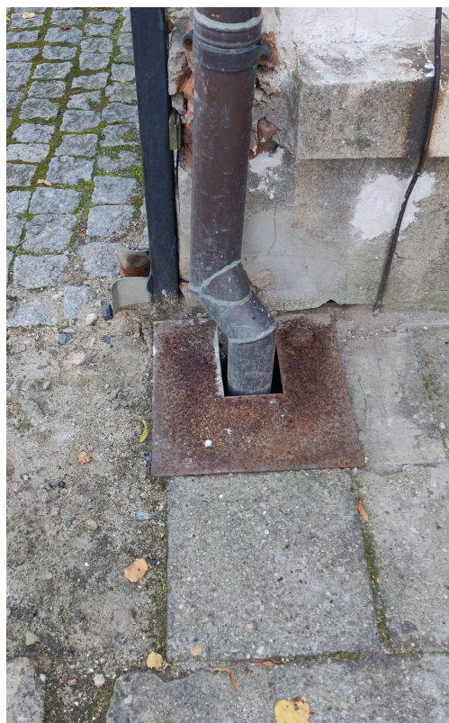
Fot. 2. i 3. - Różne rozwiązania wpustów do kanalizacji deszczowej przy rurach spustowych (odpowiednio narożnik północno-zachodni i południowo-wschodni)
