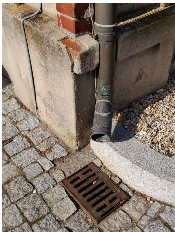
Fot. 2. i 3. - Różne rozwiązania wpustów do kanalizacji deszczowej przy rurach spustowych (odpowiednio narożnik północno-zachodni i południowo-wschodni)
