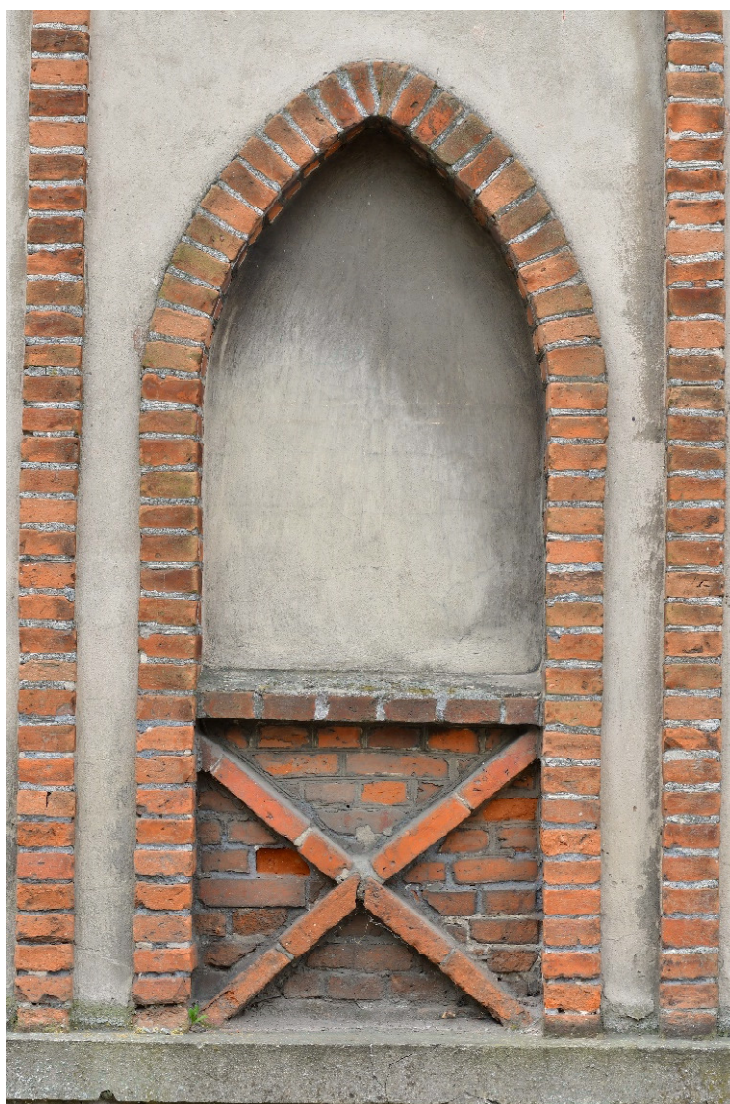
Fot. 7. – Blenda na parterze elewacji północnej: opaska murowana z jednakowych cegieł, do wymiany na szkliwione co druga cegła w łuku; cofnięty względem lica opaski parapet z pojedynczej warstwy cegieł murowanych główkowo – w płaszczyźnie lica skrzyżowanych na skos pasów cegieł w niszy podokiennej
