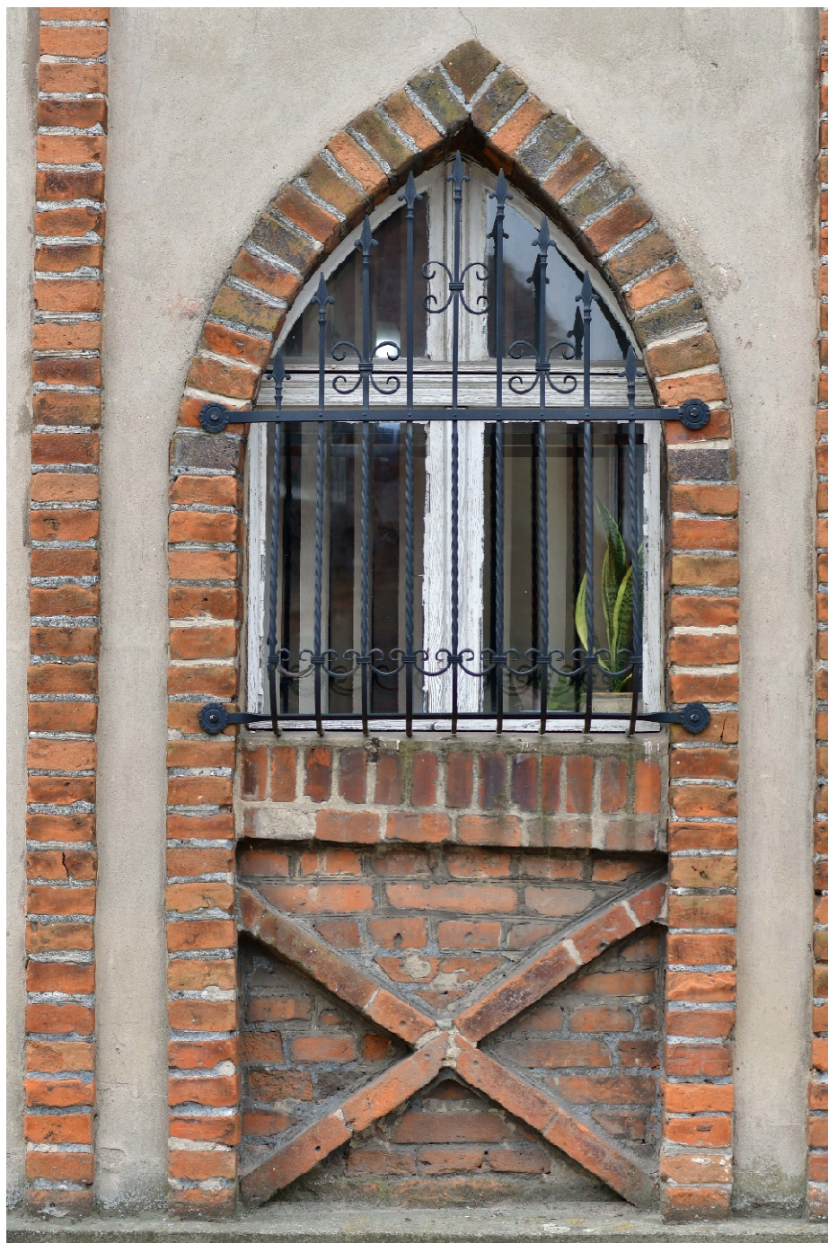
Fot. 8. – Okno '06' na parterze elewacji północnej; opaska murowana z jednakowych cegieł, do uzupełnienia/wymiany na szkliwione co druga cegła w łuku; cofnięty względem lica opaski parapet z wtórnie nadmurowaną rolką leżącą na warstwie cegieł murowanych główkowo (do przemurowania na pojedynczą warstwę) – w płaszczyźnie lica skrzyżowanych na skos pasów cegieł w niszy podokiennej
