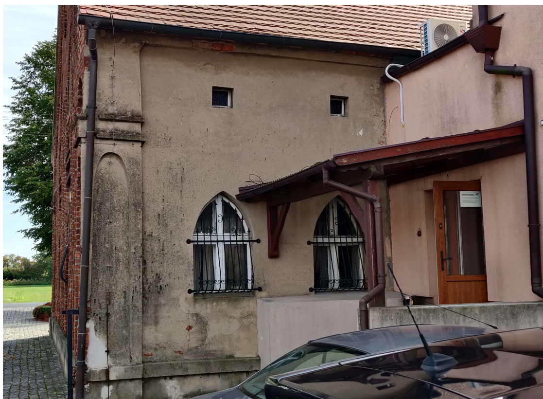
Fot. 18. – Elewacja zachodnia (tylna): zdegradowany wtórny tynk cementowy, uproszczony detal architektoniczny, brak widocznych pierwotnych elementów wystroju – założono do odtworzenia
