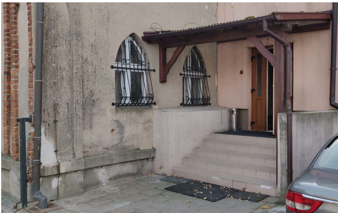
Fot. 5. – Schody zewnętrzne do części budynku niebędącej zabytkiem i nieobjętej opracowaniem: lewa balustrada do rozbiórki; schody lewostronnie do skrócenia; powstanie przestrzeni zapewniającej swobodne 'oddychanie' ścian zabytku; do zamontowania palisada krawędziująca lewostronnie schody i nowa balustrada; istniejące zadaszenie do demontażu/wymiany/przebudowy
