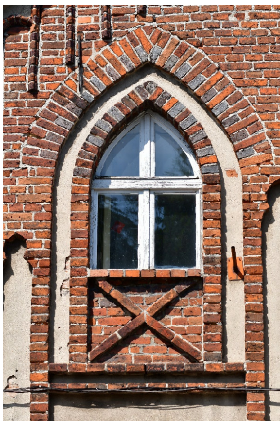
Fot. 11. i 12. – Okna '09' (lewe) i '010' (prawe) na poddaszu elewacji południowej: opaski murowane z jednakowych cegieł, do rekonstrukcji/uzupełnienia/wymiany na szklwione co drugą cegła w łuku; parapety obu okien wtórne (rozebrać, ew. uzupełnić uszkodzone/brakujące elementy niszy, a nowe parapety wymurować z pojedynczej warstwy cegieł główkowo o wymiarze pierwotnym)
