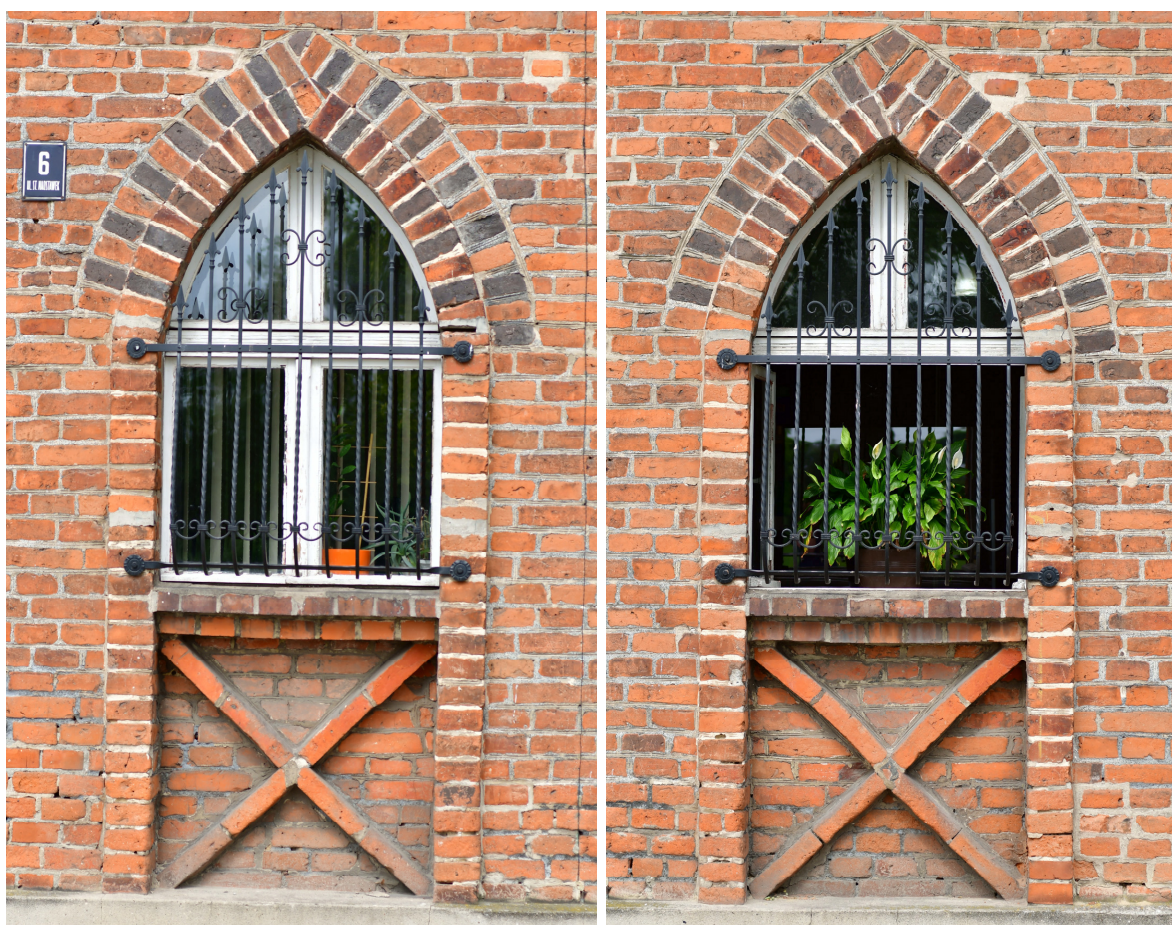
Fot. 14. i 15. – Okna '02' (lewe) i '03' (prawe) na parterze elewacji frontowej wschodniej, po lewej stronie wejścia: opaski murowane z jednakowych cegieł, do rekonstrukcji/uzupełnienia/wymiany na szkliwione co druga cegła w łuku; parapety obu okien wtórne (rozebrać, a nowe parapety wymurować z pojedynczej warstwy cegieł główkowo o wymiarze pierwotnym)
