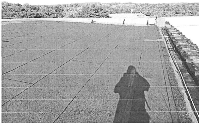
Dach nad częścią sportowa – część kryta papą termozgrzewalną
