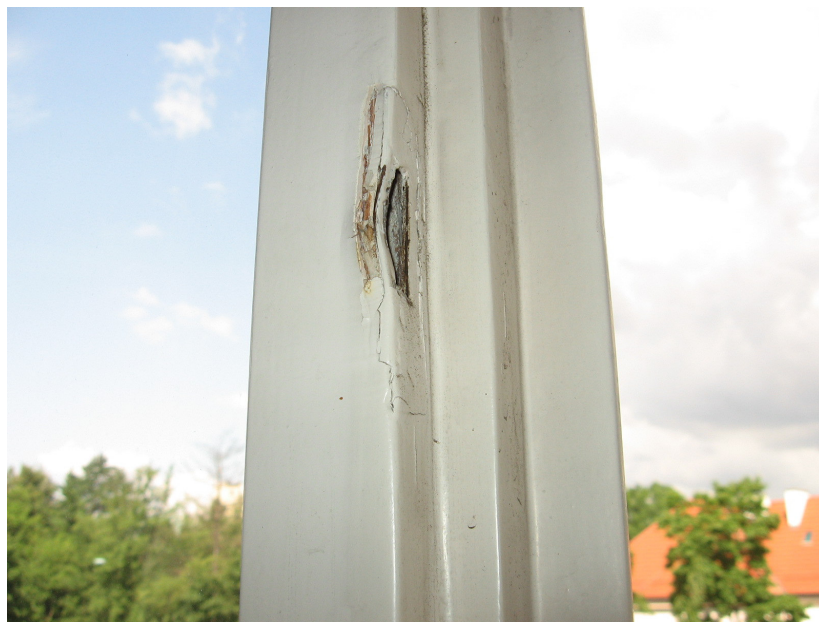
Il. 81. Okno 53 –L, deformacja okuć
