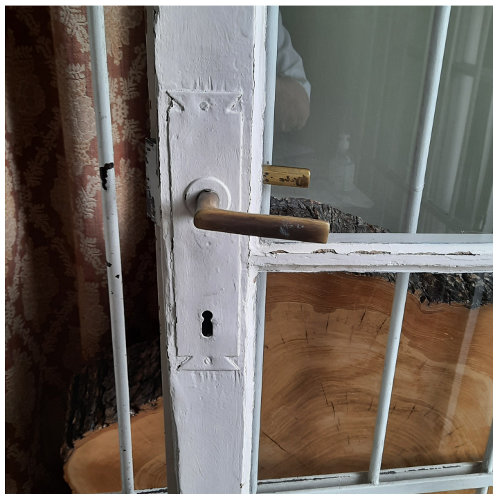
Il. 44. Drzwi 13- E , skrzydła wewnętrzne, tarczka zamka pseudoklasycystyczna i klameczka modernistyczna
