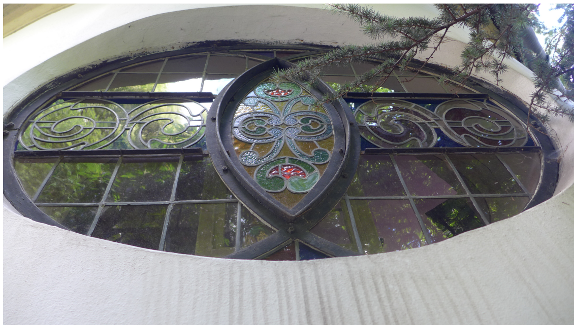
Il. 13. Okno nr 9-A, widok od strony elewacji, część środkowa eliptyczna – otwieralna do wewnątrz
