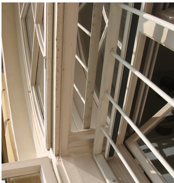
Il. 34. Odształcenie półkolistej kwatery, kwatera nie przylega przylgą (anszlakiem) do krosna-ślemienia, na ramiaku skrzydła widoczny jest ogranicznik dla nie zamontowanej zakrętki, widoczne punkty osadzania się skroplin co skutkuje w rezultacie spęcherzeniami farby. Punkty skroplin (parowania) widoczne są również na elementach metalowych kraty.
