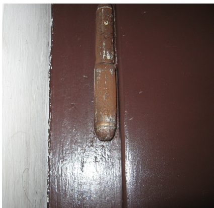
Il. 7. Drzwi nr 21, skorodowany zawias czopowy wbijany
