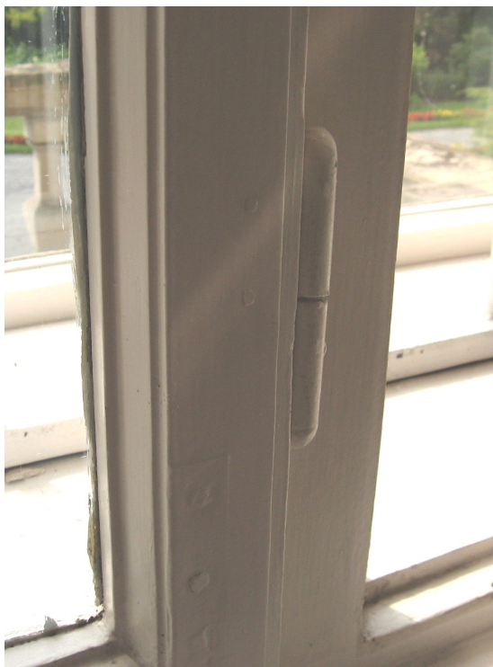
Il. 30. Zawias wbijany o zakończeniu półkolistym dla kwater wewnętrznych.
