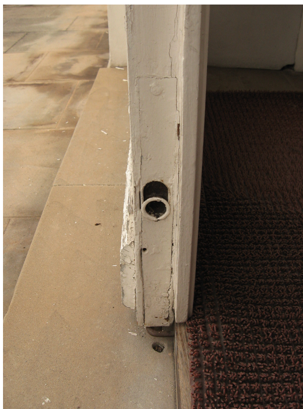
Il. 49. Drzwi 13-E, skrzydła zewnętrzne, Zasuwa czołowa dolna
