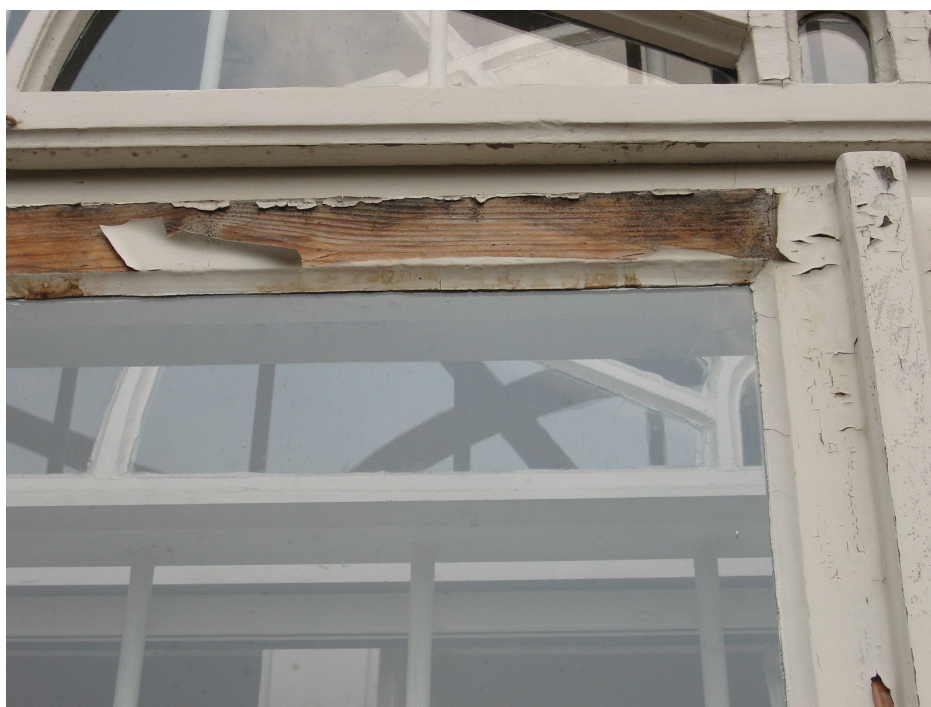
Il. 31. Spęcherzenia i złuszczenia kwater zewnętrznych
