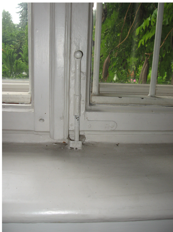
Il. 21. Okno 11-C, widok od strony wnętrza, zabytkowa zasuwka okienna
