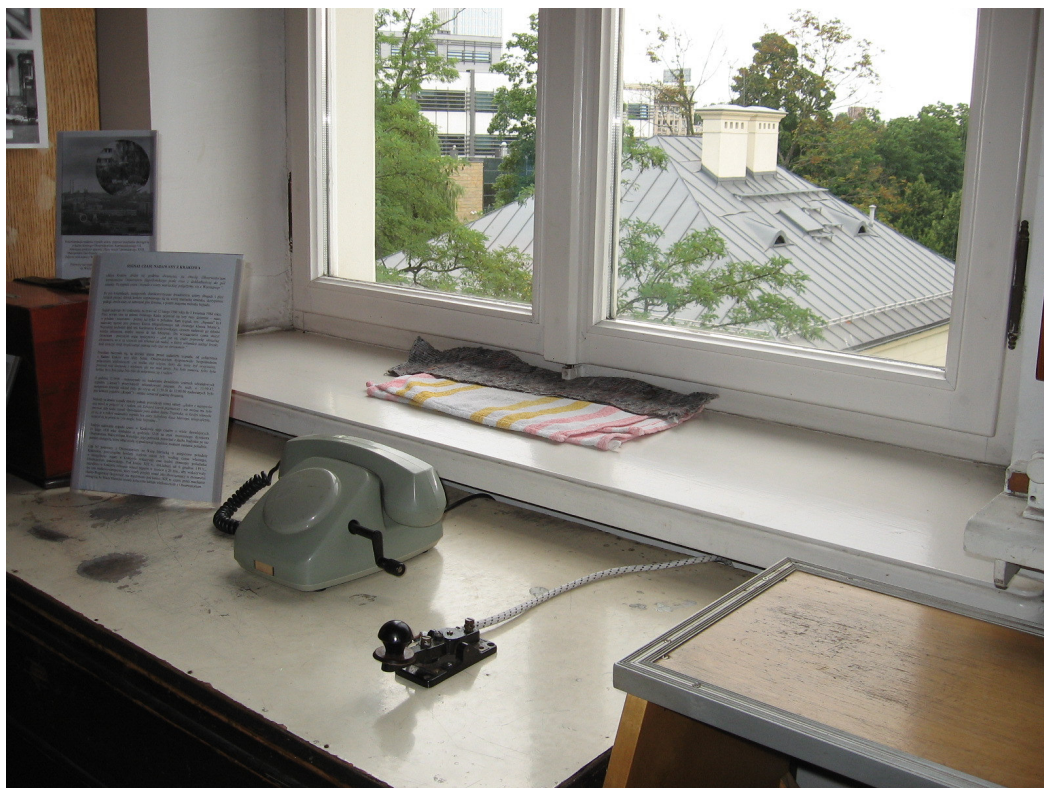
Il. 117. Okno K-47 na II piętrze, położony ręcznik na parapecie dowodzi nieuszczelności okna na wody opadowe
