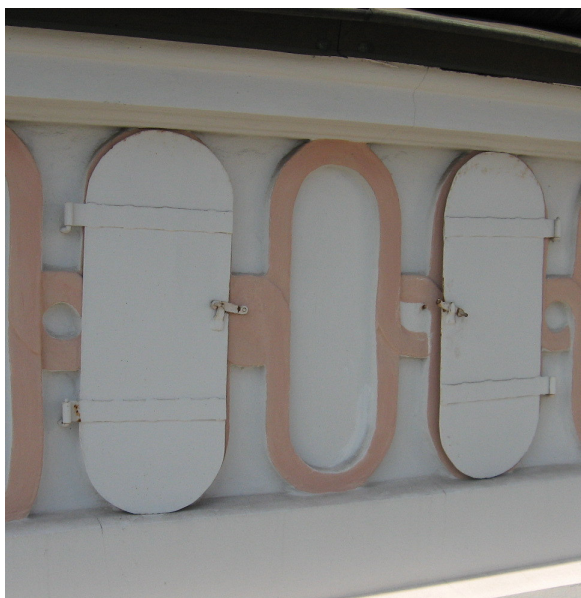
II. 98. Okienka w obserwatorium po stronie wschodniej, blaszane okiennice.
