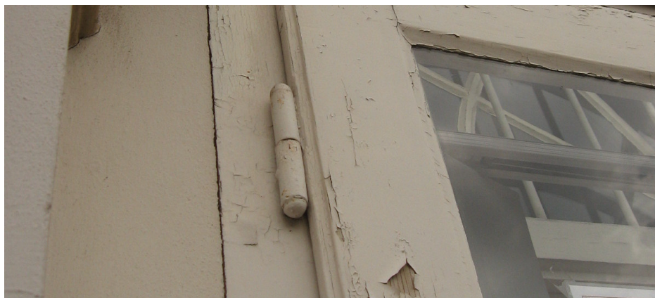
Il. 51. Drzwi 13-E, skrzydła zewnętrzne, zawias czopowy wbijany.
