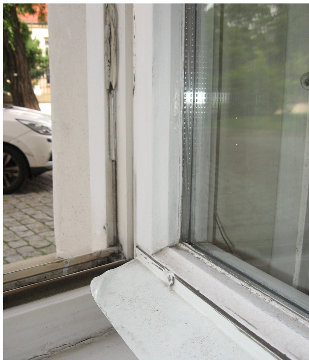
Il. 104. Okno H-26 na parterze, wręby krosna zanieczyszczone z ubytkami uszczelek.
