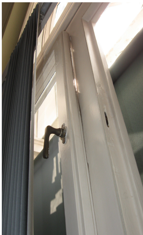
Il. 33. Odształcenie prawej kwatery wewnętrznej
