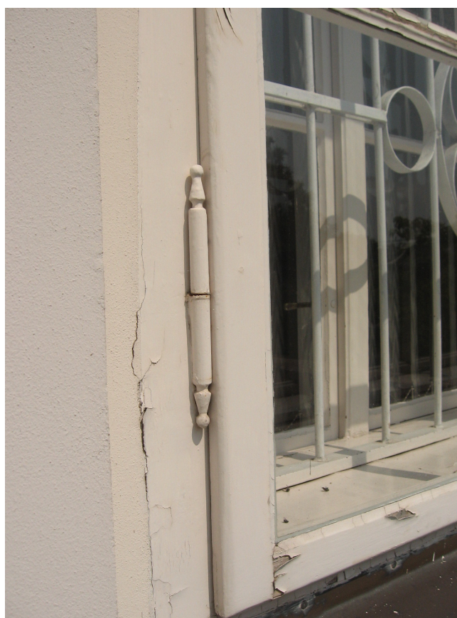
Il. 40. Okno 14-D, pęknięcia i złuszczenia farby
