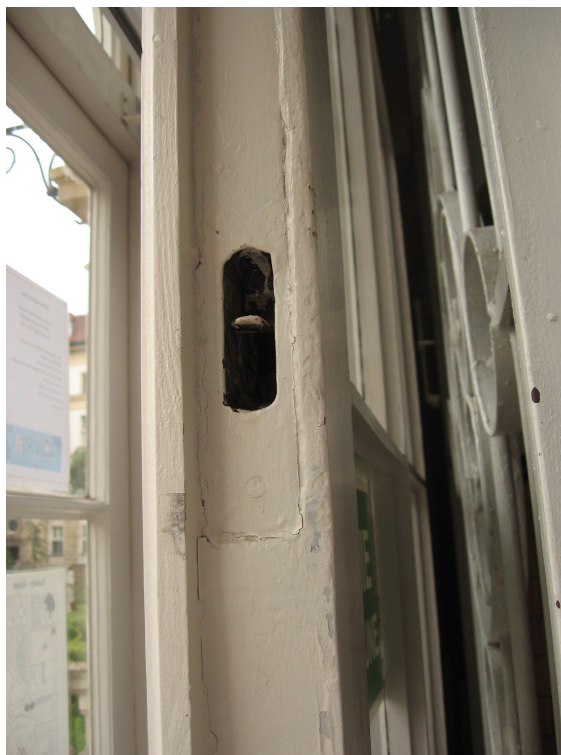
Il. 46. Drzwi 13-E , drzwi wewnętrzne, zasuwą czołowa górna
