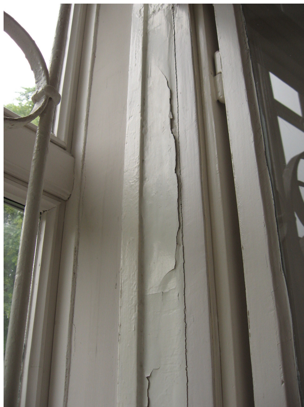
Il. 65. I piętro okno nr 40-I, spęcherzenia farby na powierzchni stojaka ościeży okna
