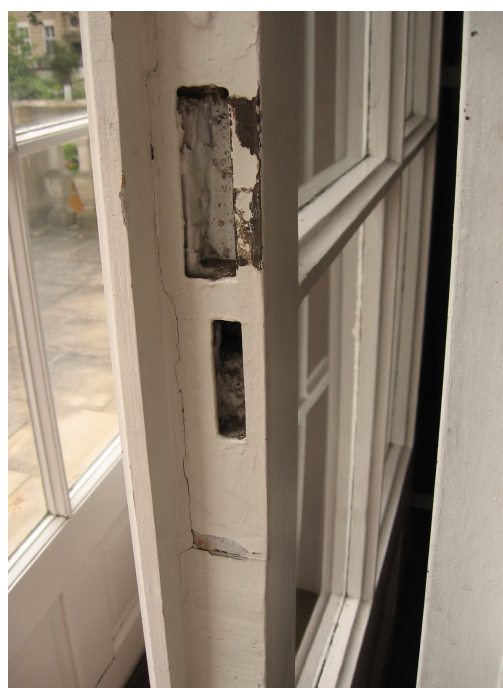
Il. 45. Drzwi 13- E, skrzydła drzwi wewnętrzne, zamek drzwiowy, zapewne oryginalny z wieku osiemnastego.
