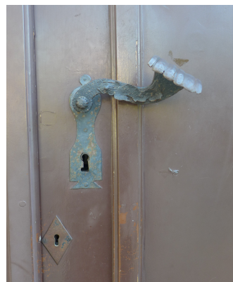
Il. 5. Drzwi wejściowe nr 1. Ogniska korozji na klamce i tarczce zamka
