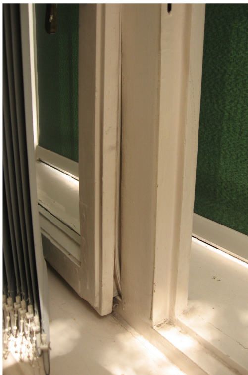
Il. 32. Odształcenie prawej kwatery wewnętrznej
