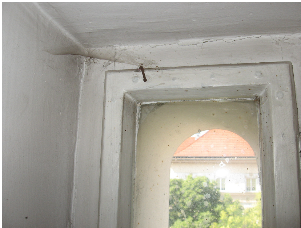
II. 97. Prowizoryczne zamknięcie zagiętym gwoździem Brakującą zakrętkę zrekonstruować.
