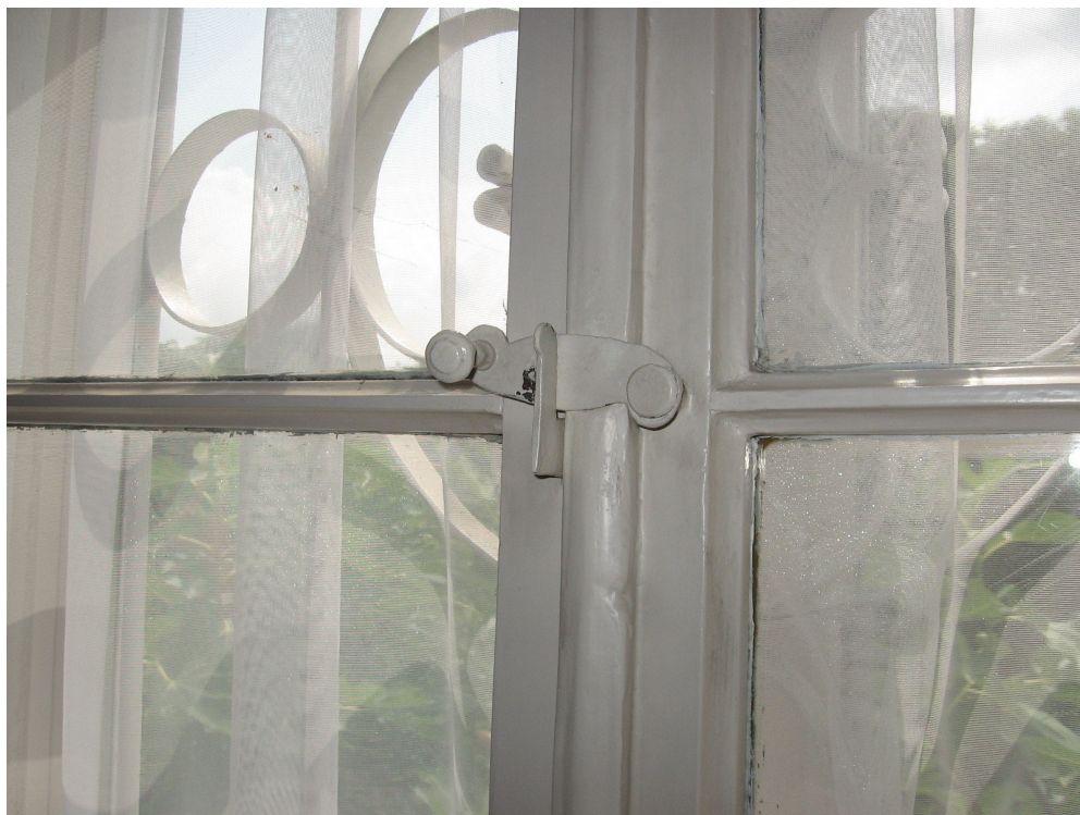
Il. 57. Widok na skrzydła wewnętrzne i zawrotnicę w oknach gabinetu profesora Szafera
