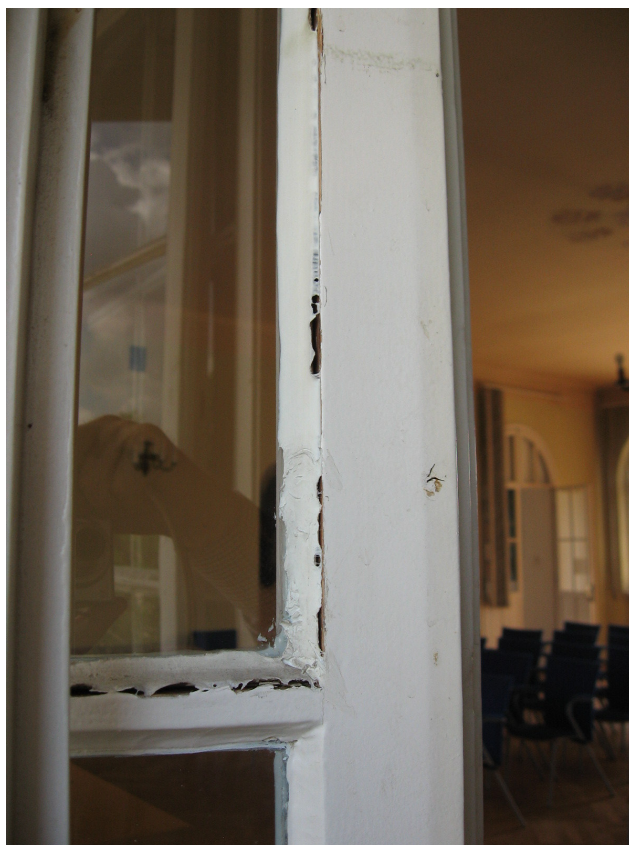
Il. 80. Okno 53 –L, ubytki kitowania
