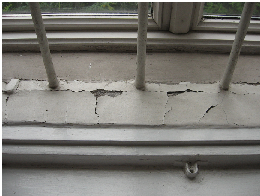
Il. 64. I piętro okno nr 40-I, spęcherzenia farby na powierzchni progu ościeży okna
