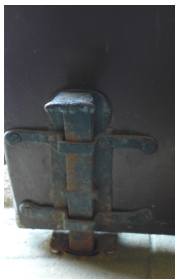
Il. 4. Drzwi wejściowe nr 1. Skorodowana zasuwa boczna dolna
