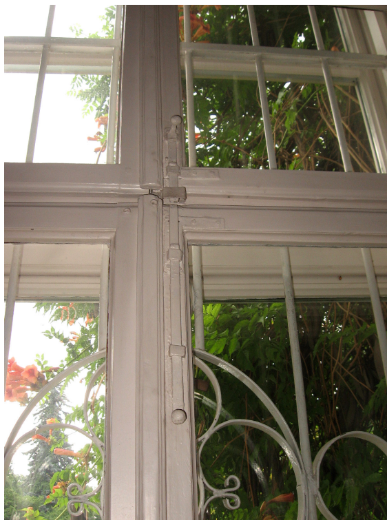
Il. 20. Okno 11-C, widok od strony wnętrza, zabytkowe zasuwki okienne
