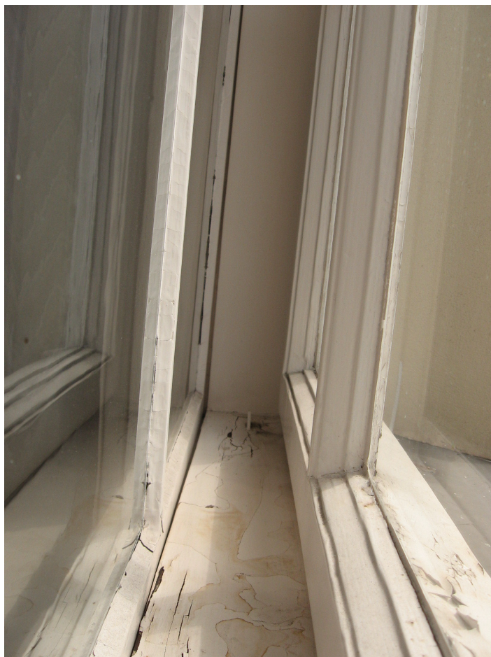
Il. 73. Okno 61, zacieki na progu ościeżnicy, będące skutkiem nieszczelności okna przed deszczem.
