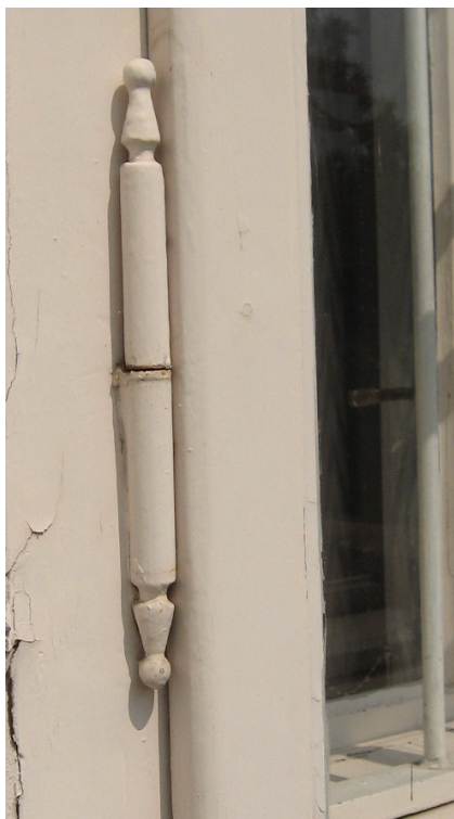
Il. 29. Zawias wbijany lalkowy dla kwater zewnętrznych
