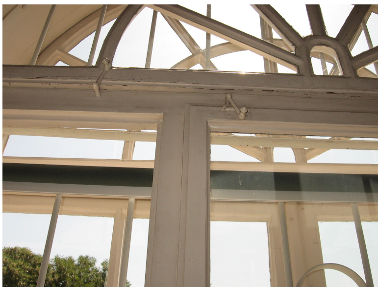
Il. 38. Okno 14-D, zakrętki kwater wewnętrznych pod ślemieniem
