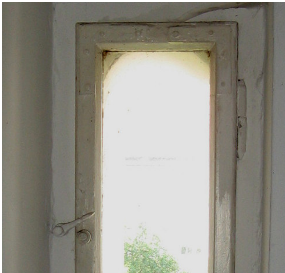
Il. 95. Okienka w Obserwatorium, widok od strony wnętrza, zakrętka skrzydełkowa służąca do zamykania, zawiasy czopowe wbijane, narożniki okienne przybijane gwoźdźmi
