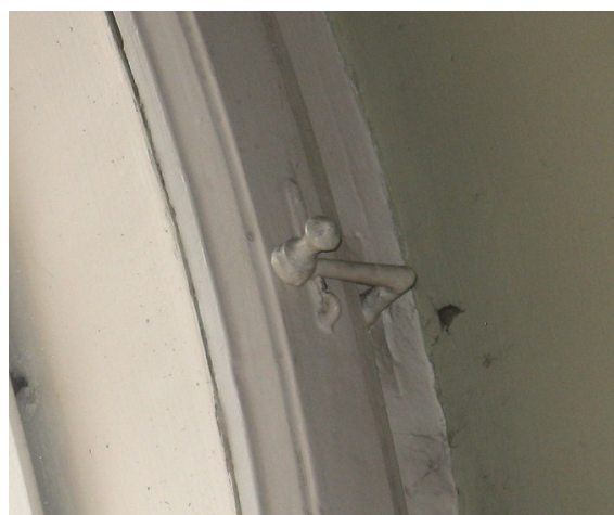
Il. 28. Zakrętka skrzydeł półkolistych wewnętrznych z ochroniaczem i ogranicznikiem wykonanym ze sprężynującego drutu.
