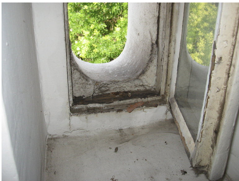
Il. 96. Zabrudzenia okna, ubytki kitowania
