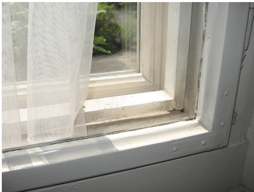
Il. 58. Widok na ramiaki skrzydła wewnętrznego , konstrukcję kraty międzyokiennej i ramiaki skrzydła zewnętrznego w oknie w gabinecie profesora Szafera
