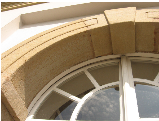
Il. 88. Okno 58-R, widoczne niedoleganie kwatery, co jest powodem nieszczelności.
