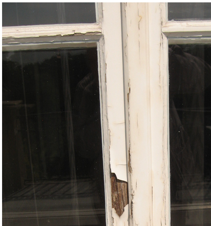
Il. 84. Okno 59-L, spęcherzenia farby na ramiaku kwatery, ubytki kitowania.
