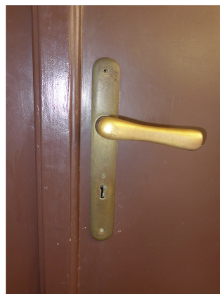
Il. 8. Drzwi nr 21. Ubytki wkrętów na tarcze zamka
