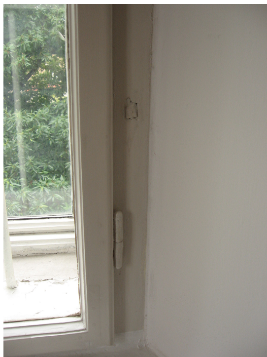
Il. 69. I piętro okno nr 40-I, zawias okienny, nakrętka pręta stalowego spinającego krosno zewnętrzne z wewnętrznym
