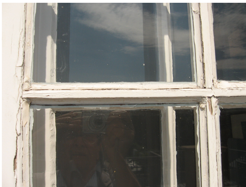
Okno 59-L, ubytki kitowania
