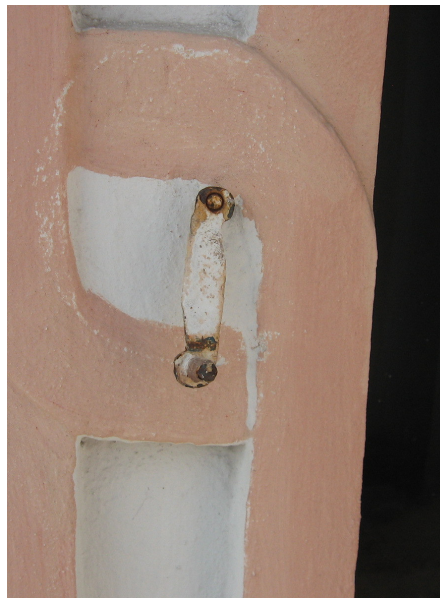
II.99. Okienka w obserwatorium po stronie wschodniej, blaszane okiennice, zdeformowana zakrętka.
