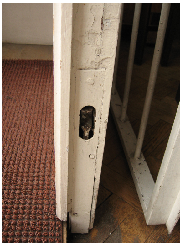
Il. 47. Drzwi 13-E, skrzydła wewnętrzne, Zasuwa czołowa dolna
