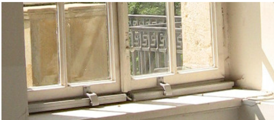
Il. 89. Okno 58-R, siłowniki funkcji oddymiania
