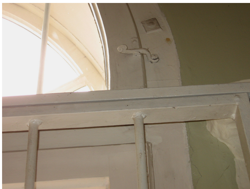
Il. 53. Drzwi 13-E, skrzydła wewnętrzne, zakrętka skrzydła półkolistego.
