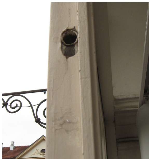
Il. 48. Drzwi 13-E, skrzydła zewnętrzne, Zasuwa czołowa górna
