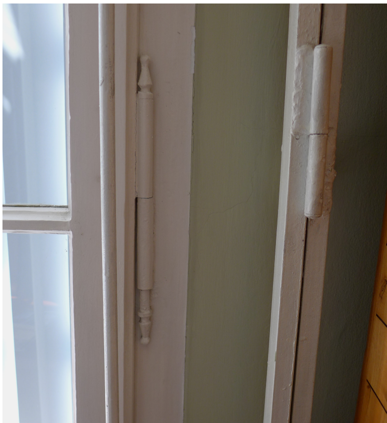
Il. 52. Drzwi 13-E, skrzydła wewnętrzne, zawias czopowy wbijany, zdeformowany.
