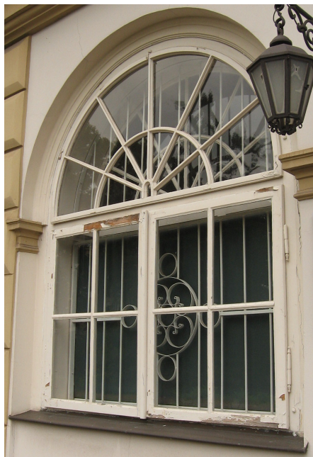
Il. 22. Okno nr 12 z widoczną wewnętrzną kratą i wewnętrzną zasłoną harmonijkową przeciwsłoneczną
