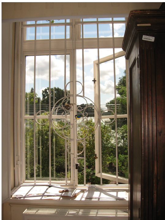
Il. 108. W oknach nr G-16 i 17 na parterze, oprócz krat występują blaszane okiennice, w okiennice nie ingerować.
