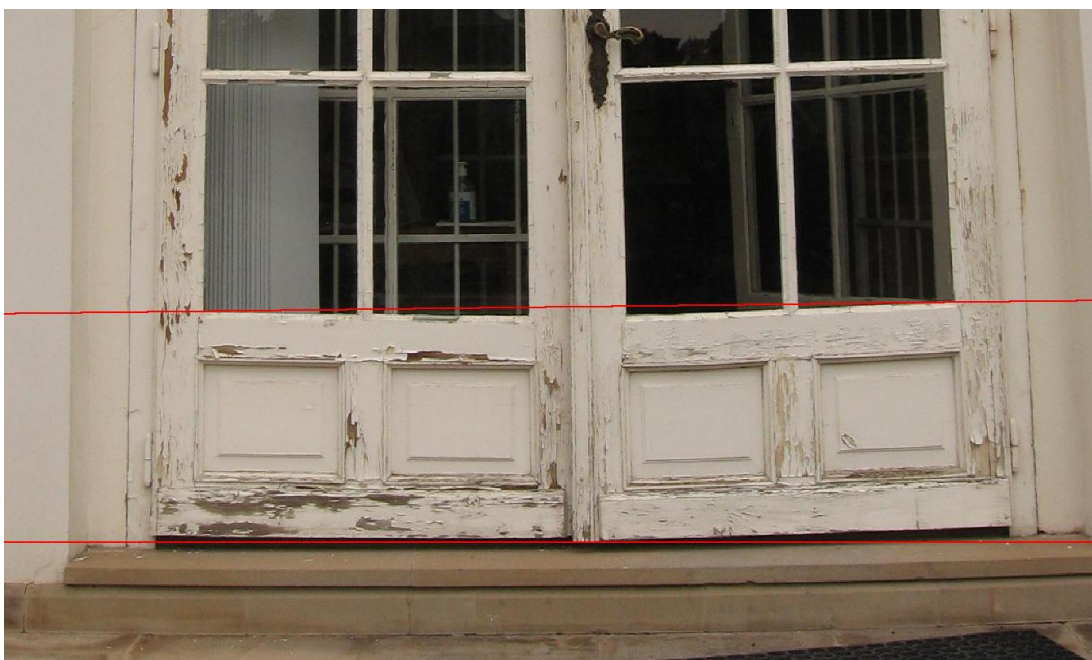
Il. 54. Drzwi 13-E, skrzydła zewnętrzne, czerwone linie pokazują deformację skrzydeł zewnętrznych.
