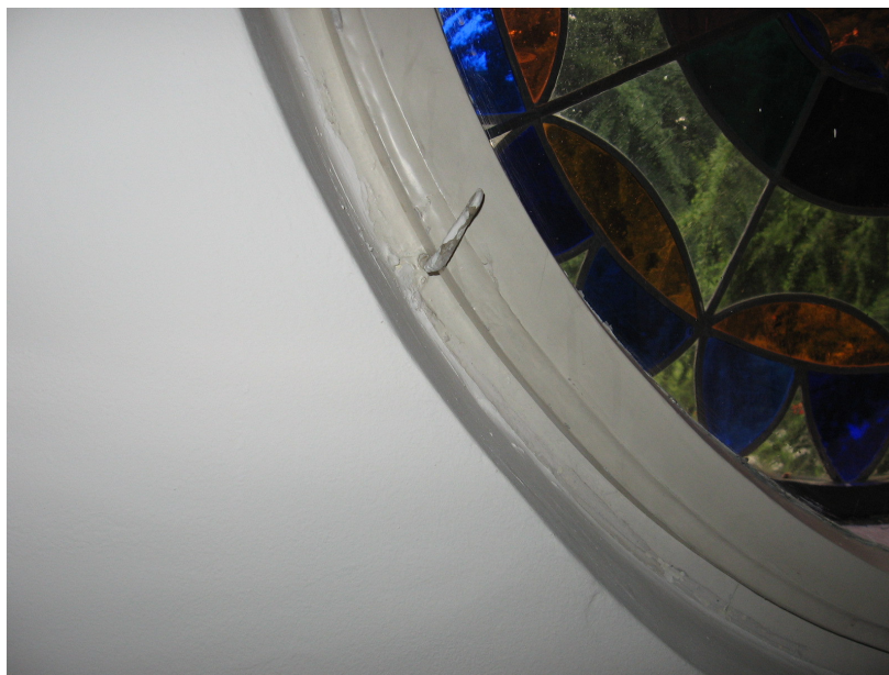
Il. 17. Okno 10-B widok od strony wnętrza, prosta zakrętka bez ochraniacza.
