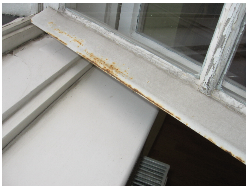
Il. 78. Okno 53 –L, ubytki kitowania, korozja okapnika
