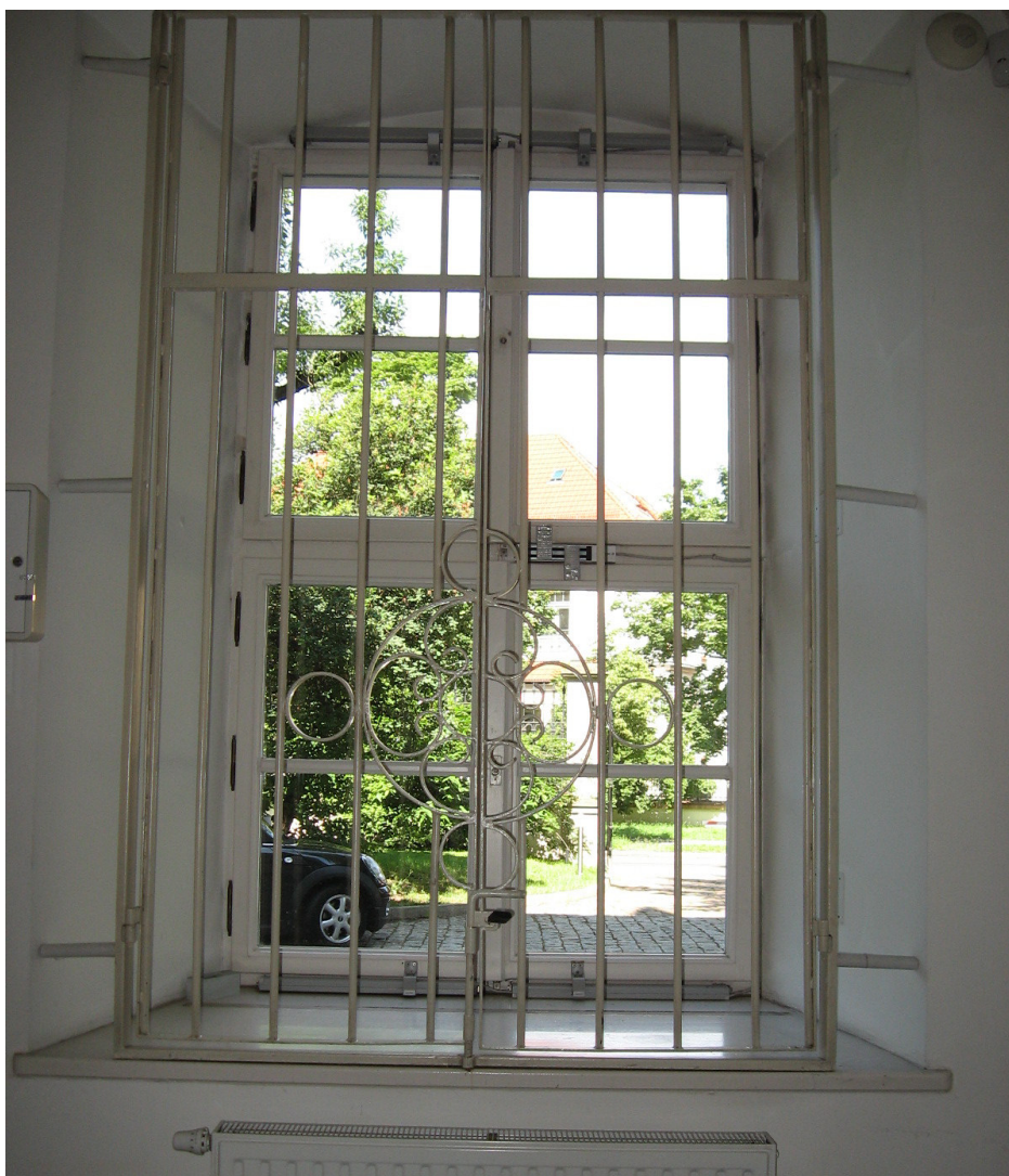
Il. 90. Okno 2-H na parterze, okno napowietrzające uruchamiane automatycznie siłownikami.
