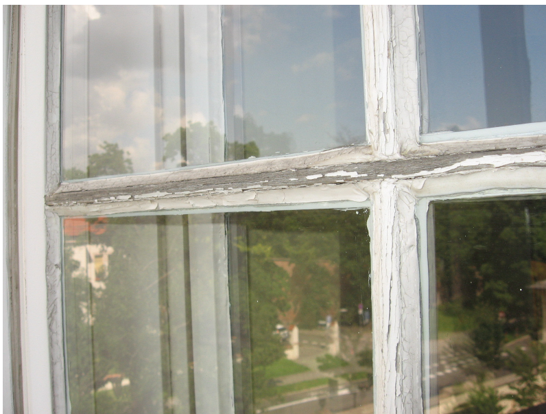
Il. 79. Okno 53 –L, ubytki kitowania
