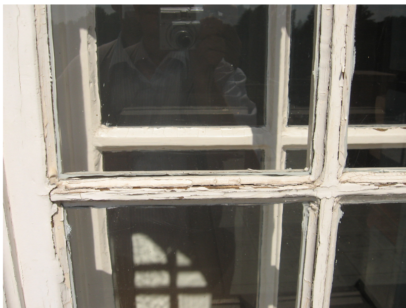
Okno 59-L, ubytki kitowania
