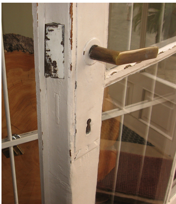
Il. 45. Drzwi 13- E, skrzydła drzwi wewnętrzne, zamek drzwiowy, zapewne oryginalny z wieku osiemnastego.
