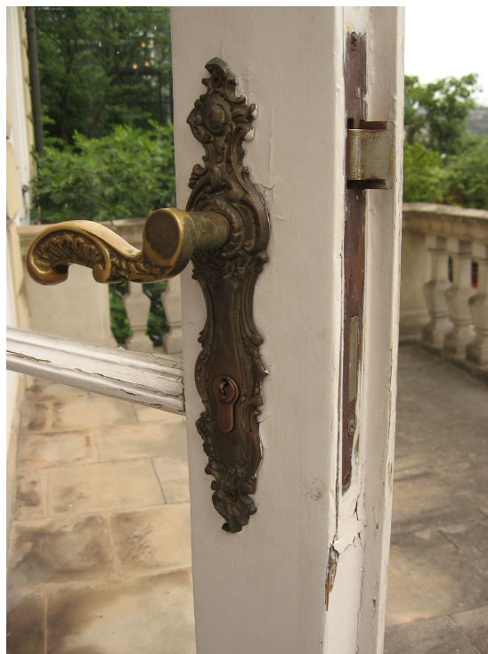
Il. 50. Drzwi 13-E, skrzydła zewnętrzne, klamka i tarczka neorokokowa
