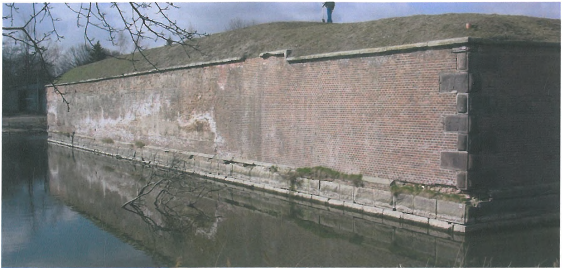
Fot. 1 Ściana bastionu Południowo-Wschodniego od strony Wschodniej
