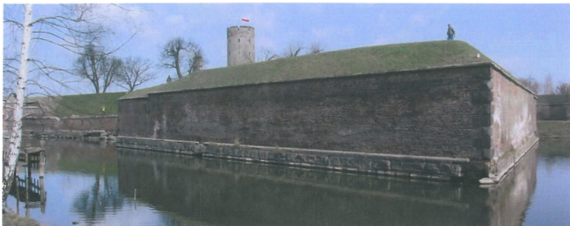
Fot. 5 Widok na ścianę południową Bastionu Południowo-Wschodniego
