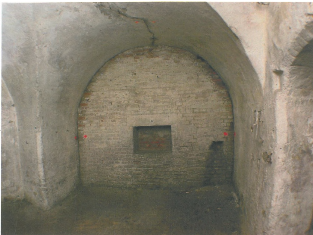
Fot. 13 Ściany pomieszczeń wymurowane po ukończeniu budowy Bastionu Południowo - Wschodniego
