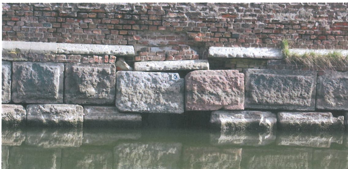
Fot. 6 Szczegół opuszczonych kamieni fundamentu
