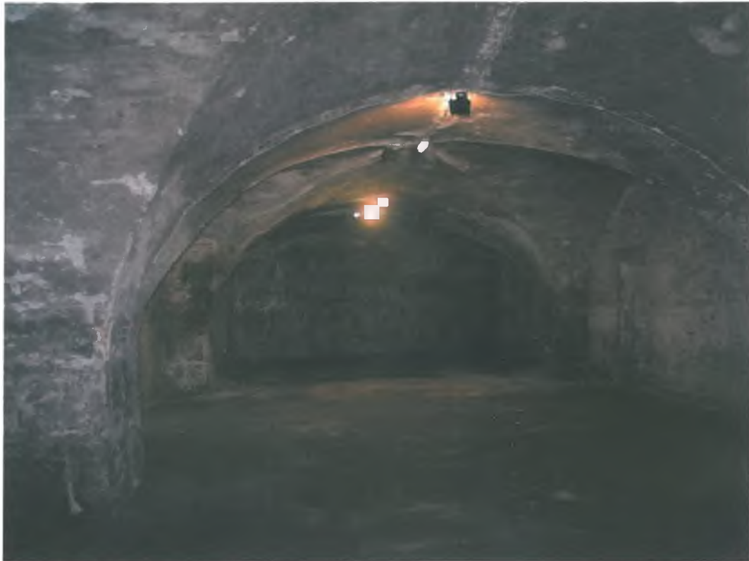
Fot. 12 Pomieszczenia wewnątrz Bastionu Południowo-Wschodniego
