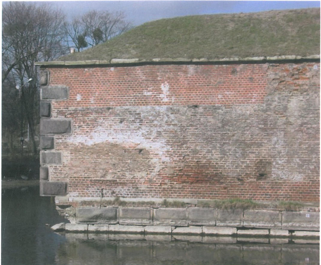
Fot. 3 Narożnik ściany południowej i wschodniej bastionu
