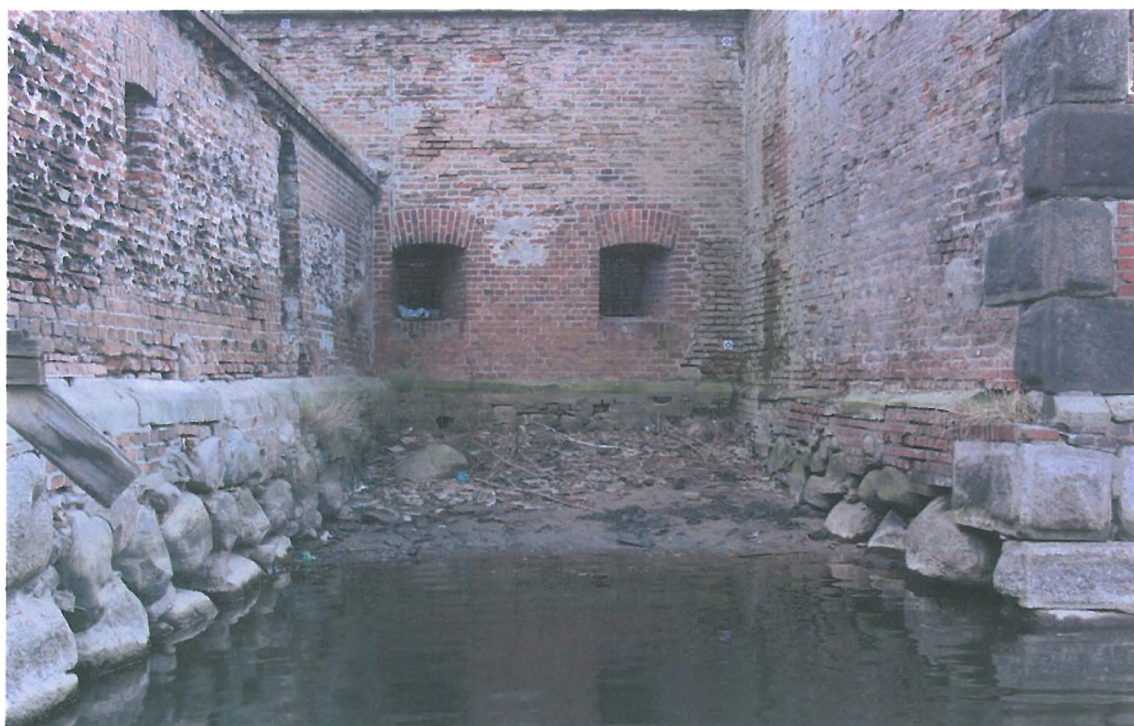
Fot. 8 Wnętrze ucha pomiędzy Bastionem Południowo-Wschodnim a Murem Fosbrei Południowym
