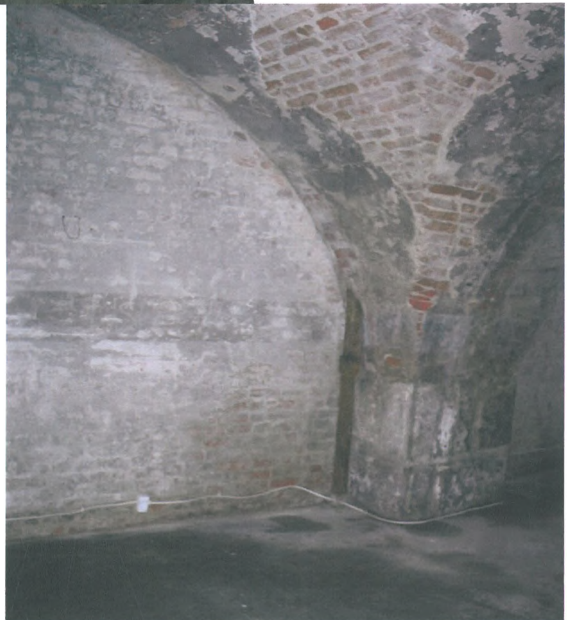
Fot. 16 Szczegół wnętrza kazamat bastionu; widoczne rury kanalizacji deszczowej
