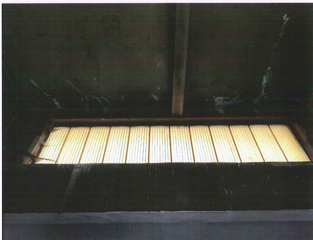
Fot.7. Szczegół okna z poliwęglanu.
