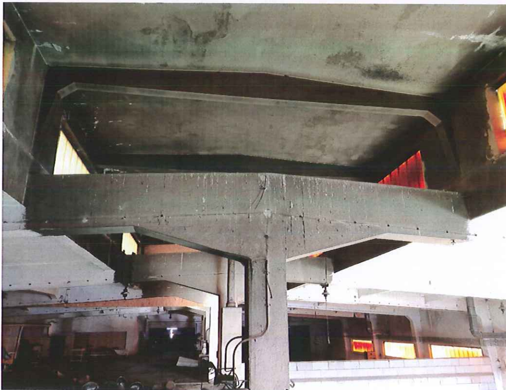
Fot.5. Widok na konstrukcję ramy żelbetowej i świetlika.
