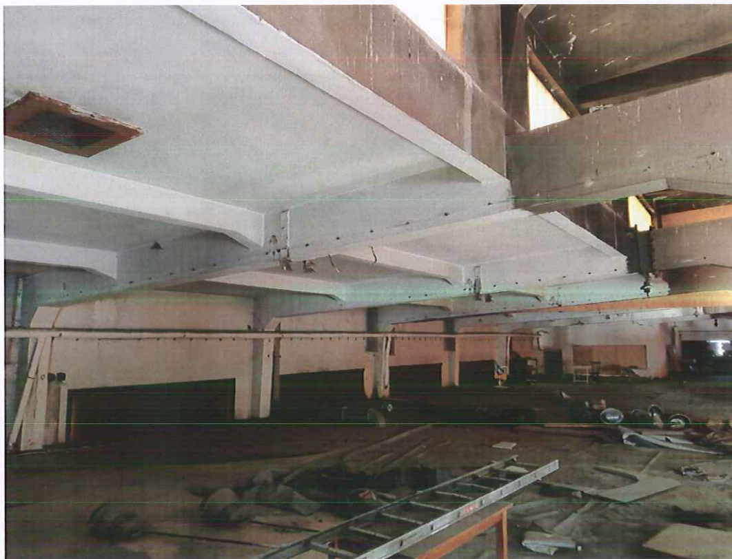
Fot.6. Widok ogólny na konstrukcję hali. Widoczne żebra oparte na ryglach.
