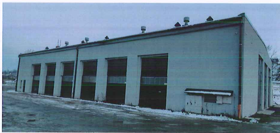
Fot.4. Elewacja boczna. Widoczne bramy do poszczególnych segmentów hali.
