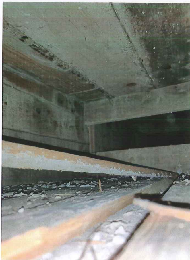
Fot.15. Odkrywka w stropie przybudówki – widoczny strop skrzynkowy.
