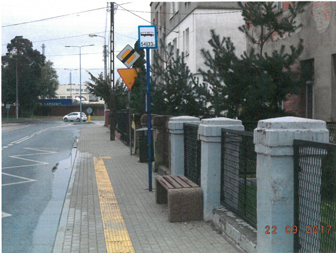
Saperów Ludwikowo kierunek Dworzec Główny, wiata bez ścian bocznych – wypełnionych PCV, kolor RAL 5003
