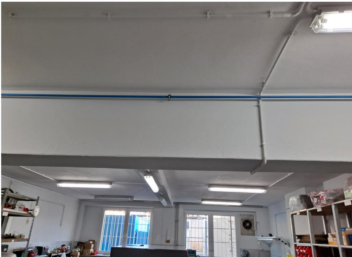
Wymiana oświetlenia podstawowego w pom. B2 ok. 10szt.
